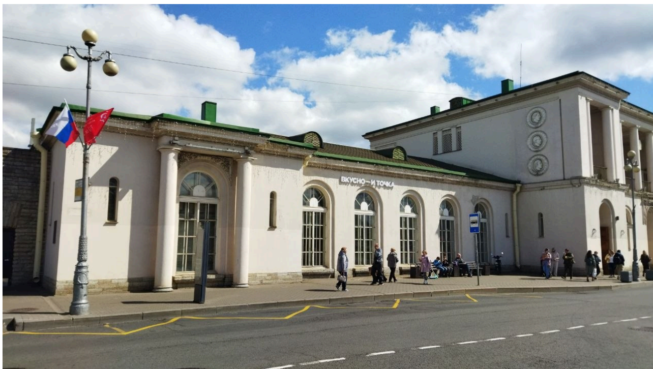
Фото 1. объект культурного наследия федерального значения «Главное здание», входящего в состав объекта культурного наследия федерального значения «Вокзал, 1948-1950 гг., арх. Левинсон Е.А., арх. Грушке А.А., ск. Манизер М.Г.» май 2026 г.
