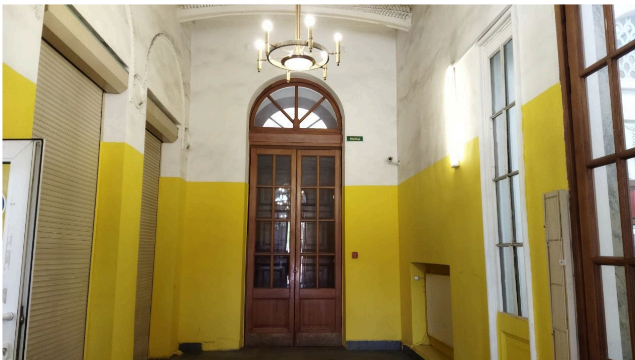
Фото 14. объект культурного наследия федерального значения «Главное здание», входящего в состав объекта культурного наследия федерального значения «Вокзал, 1948-1950 гг., арх. Левинсон Е.А., арх. Грушке А.А., ск. Манизер М.Г.» май 2026 г.
