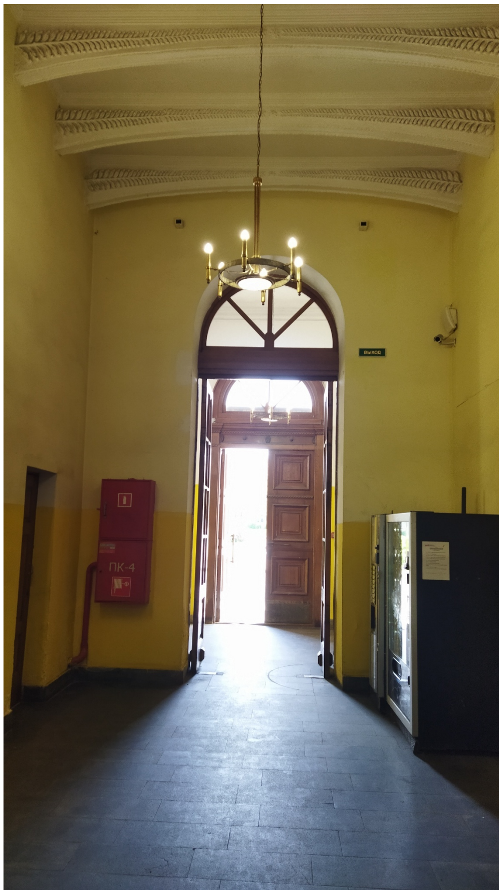
Фото 12. объект культурного наследия федерального значения «Главное здание», входящего в состав объекта культурного наследия федерального значения «Вокзал, 1948-1950 гг., арх. Левинсон Е.А., арх. Грушке А.А., ск. Манизер М.Г.» май 2026 г.
