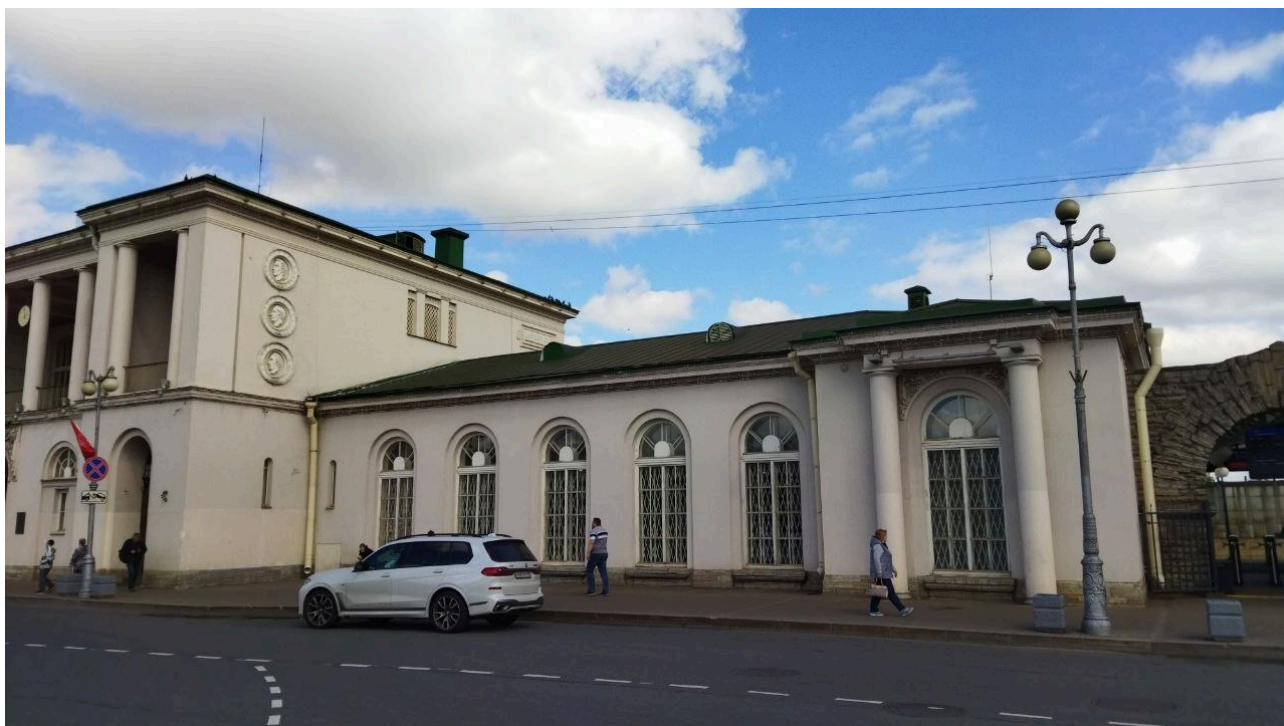
Фото 3. объект культурного наследия федерального значения «Главное здание», входящего в состав объекта культурного наследия федерального значения «Вокзал, 1948-1950 гг., арх. Левинсон Е.А., арх. Грушке А.А., ск. Манизер М.Г.» май 2026 г.
