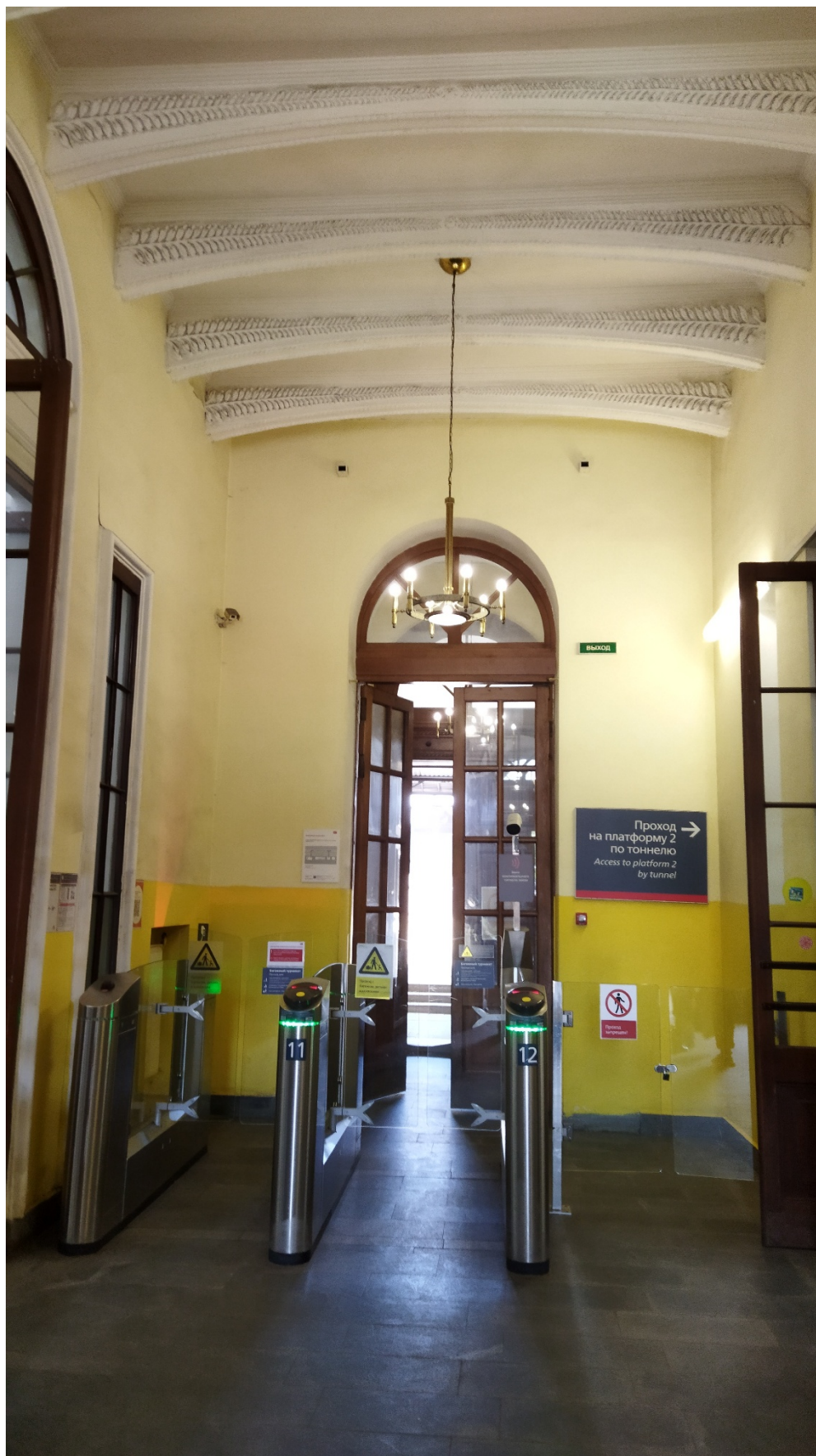
Фото 13. объект культурного наследия федерального значения «Главное здание», входящего в состав объекта культурного наследия федерального значения «Вокзал, 1948-1950 гг., арх. Левинсон Е.А., арх. Грушке А.А., ск. Манизер М.Г.» май 2026 г.
