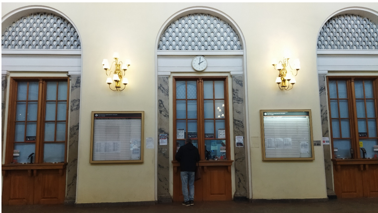
Фото 7. объект культурного наследия федерального значения «Главное здание», входящего в состав объекта культурного наследия федерального значения «Вокзал, 1948-1950 гг., арх. Левинсон Е.А., арх. Грушке А.А., ск. Манизер М.Г.» май 2026 г.
