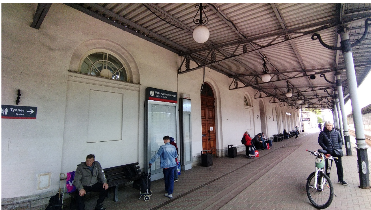
Фото 6. объект культурного наследия федерального значения «Главное здание», входящего в состав объекта культурного наследия федерального значения «Вокзал, 1948-1950 гг., арх. Левинсон Е.А., арх. Грушке А.А., ск. Манизер М.Г.» май 2026 г.
