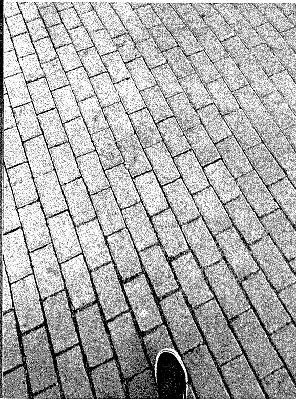
Фрагмент тротуарной плитки на территории объекта
