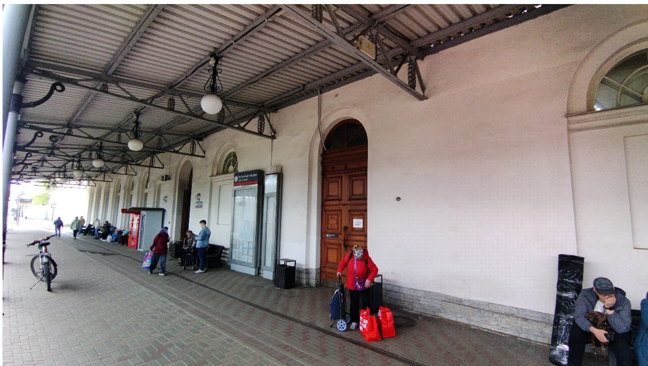
Фото 5. объект культурного наследия федерального значения «Главное здание», входящего в состав объекта культурного наследия федерального значения «Вокзал, 1948-1950 гг., арх. Левинсон Е.А., арх. Грушке А.А., ск. Манизер М.Г.» май 2026 г.
