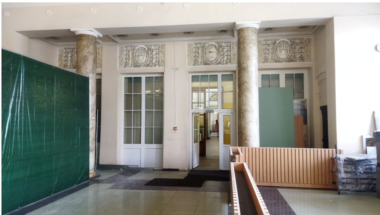
Фото 19. объект культурного наследия федерального значения «Главное здание», входящего в состав объекта культурного наследия федерального значения «Вокзал, 1948-1950 гг., арх. Левинсон Е.А., арх. Грушке А.А., ск. Манизер М.Г.» май 2026 г
