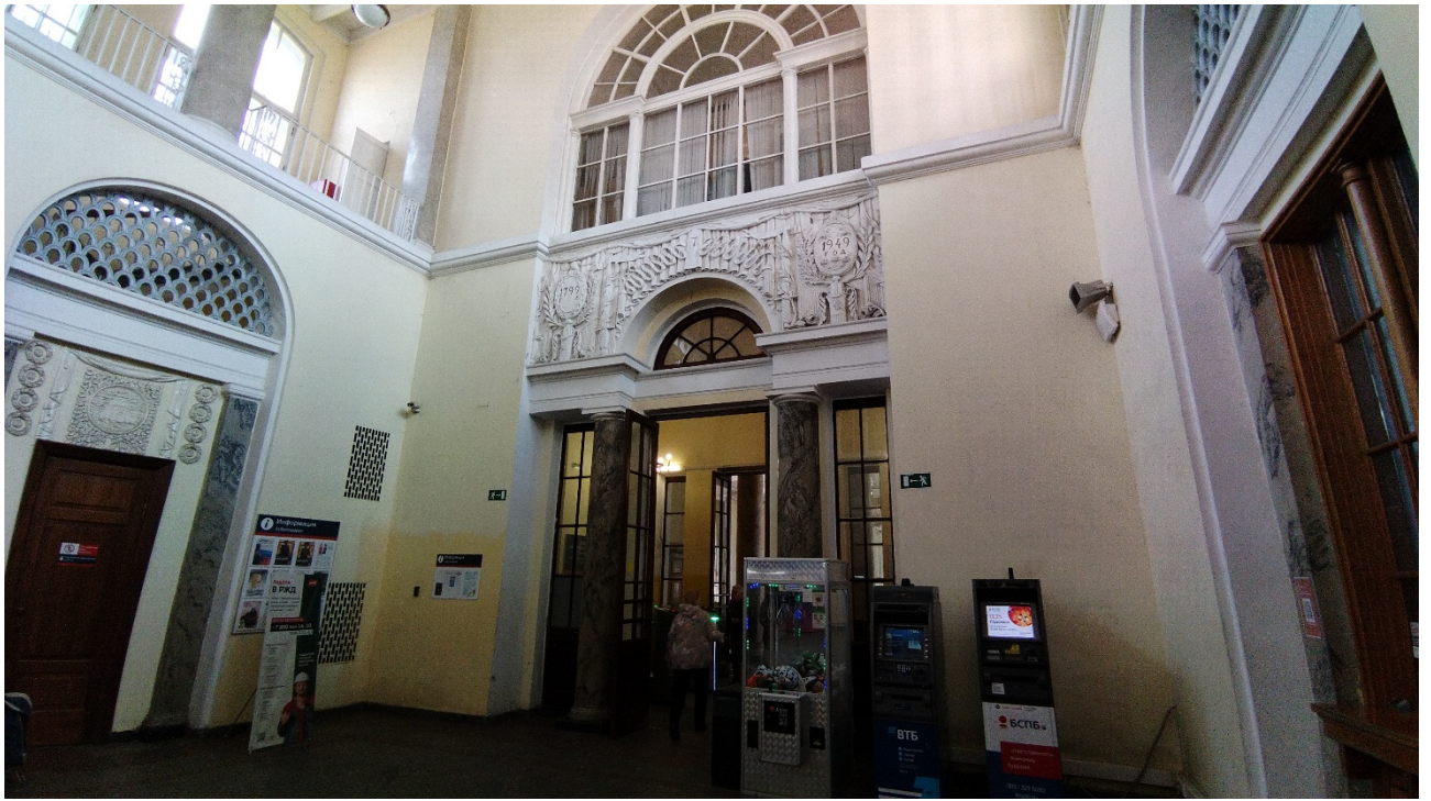
Фото 11. объект культурного наследия федерального значения «Главное здание», входящего в состав объекта культурного наследия федерального значения «Вокзал, 1948-1950 гг., арх. Левинсон Е.А., арх. Грушке А.А., ск. Манизер М.Г.» май 2026 г.
