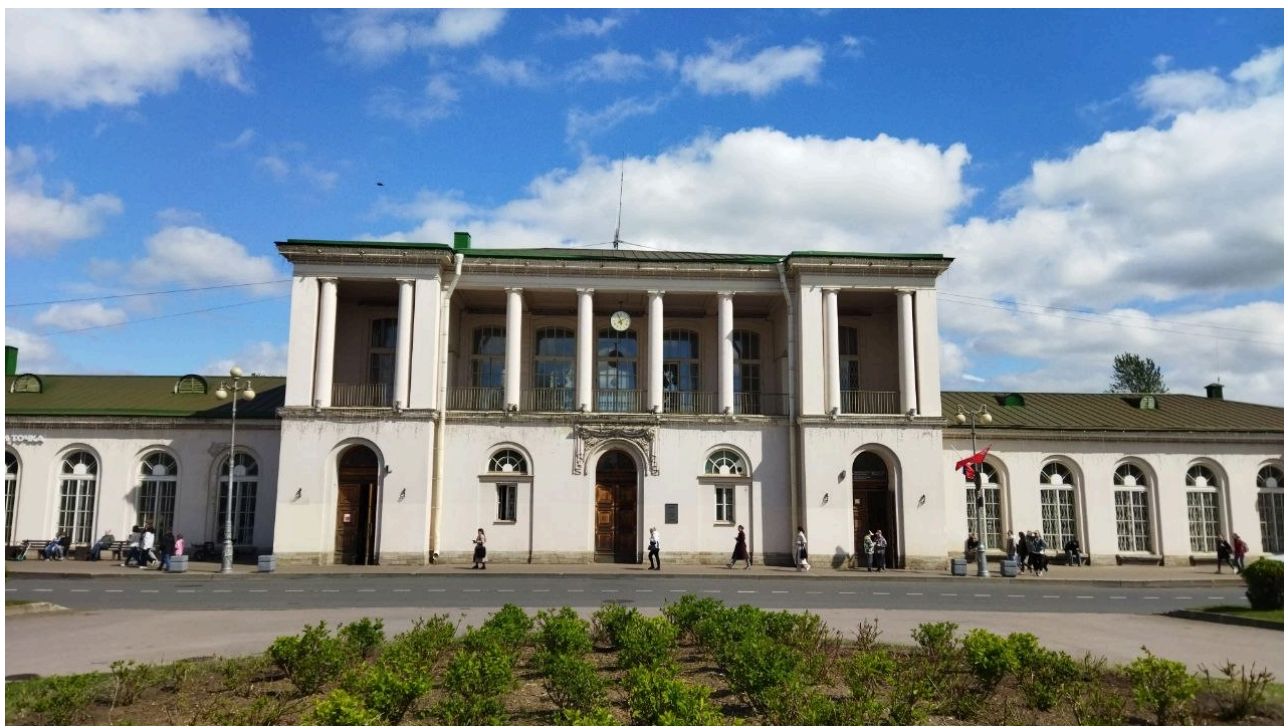
Фото 2. объект культурного наследия федерального значения «Главное здание», входящего в состав объекта культурного наследия федерального значения «Вокзал, 1948-1950 гг., арх. Левинсон Е.А., арх. Грушке А.А., ск. Манизер М.Г.» май 2026 г.
