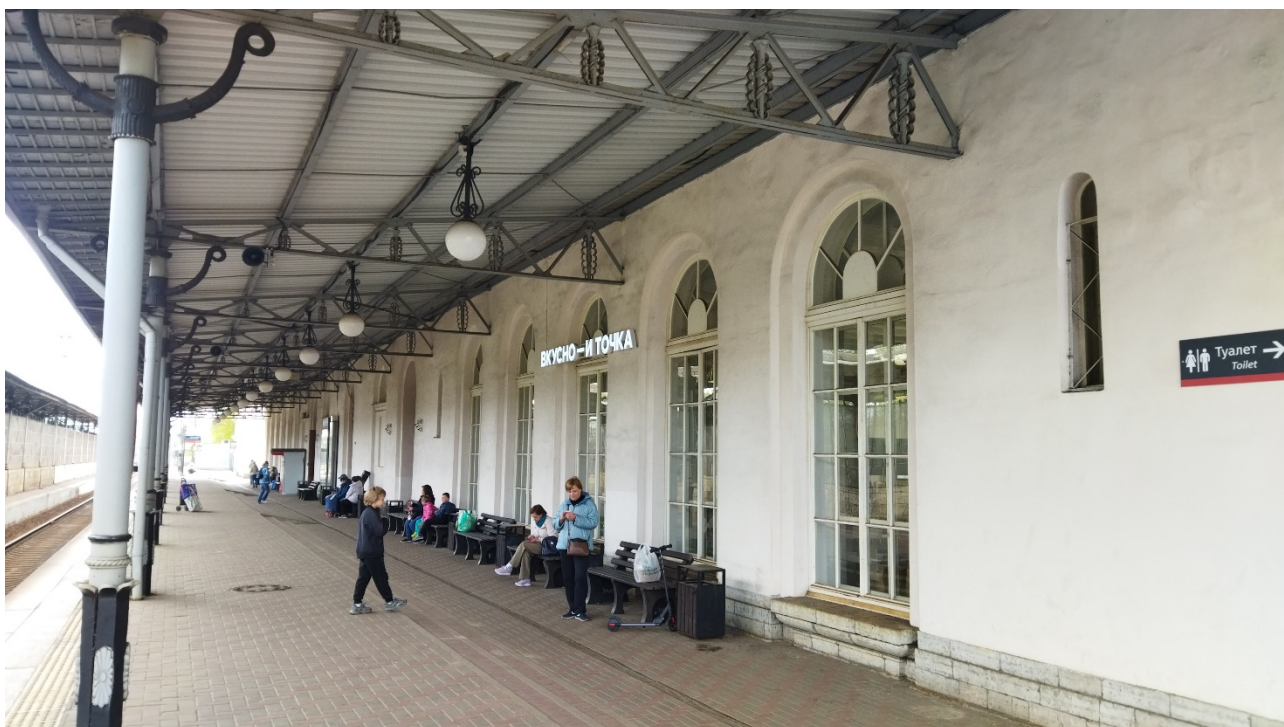
Фото 4. объект культурного наследия федерального значения «Главное здание», входящего в состав объекта культурного наследия федерального значения «Вокзал, 1948-1950 гг., арх. Левинсон Е.А., арх. Грушке А.А., ск. Манизер М.Г.» май 2026 г.
