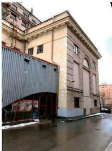
6. Фрагмент восточного фасада объекта объекта культурного наследия.
