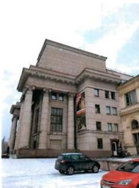
2. Западный фасад объекта культурного наследия.
