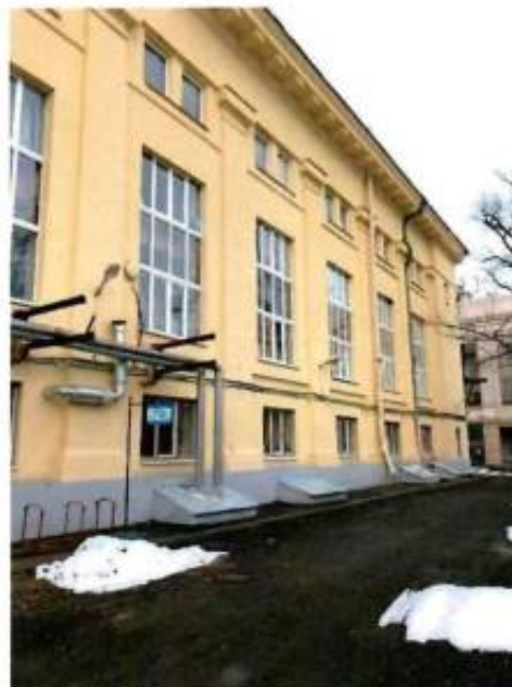
7. Фрагмент южного фасада объекта объекта культурного наследия.
