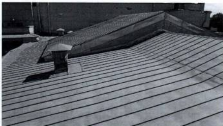
Фото 8. Крыша объекта культурного наследия
