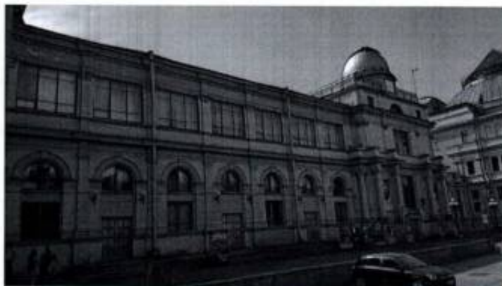
Фото 1. Северный фасад объекта культурного наследия
