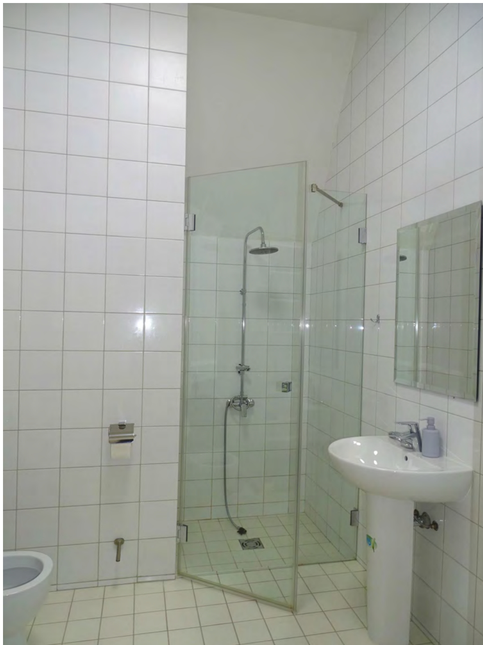
23. Помещение 2-го этажа. Санузел. Съемка 06.02.2026 г. Трушковский В.Э.
