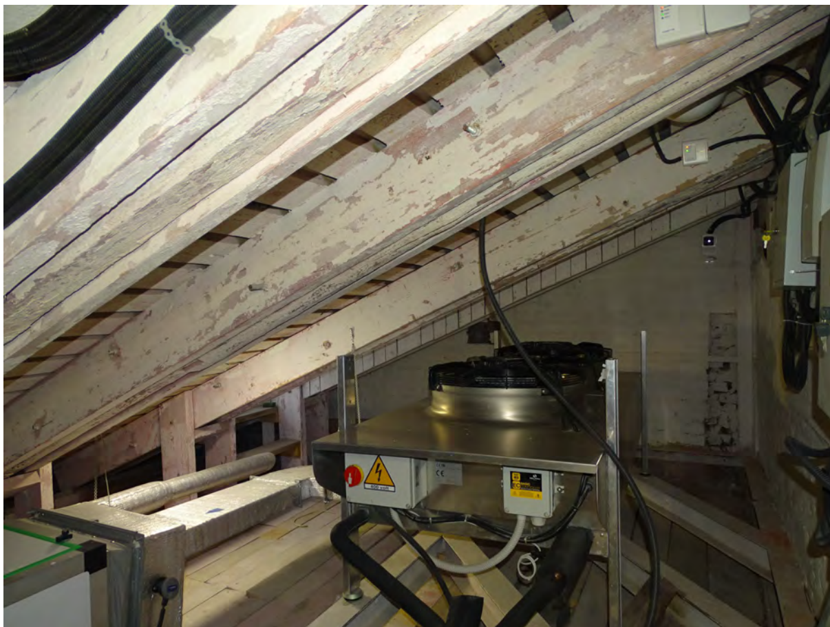
33. Чердак. Съемка 06.02.2026 г. Трушковский В.Э.
