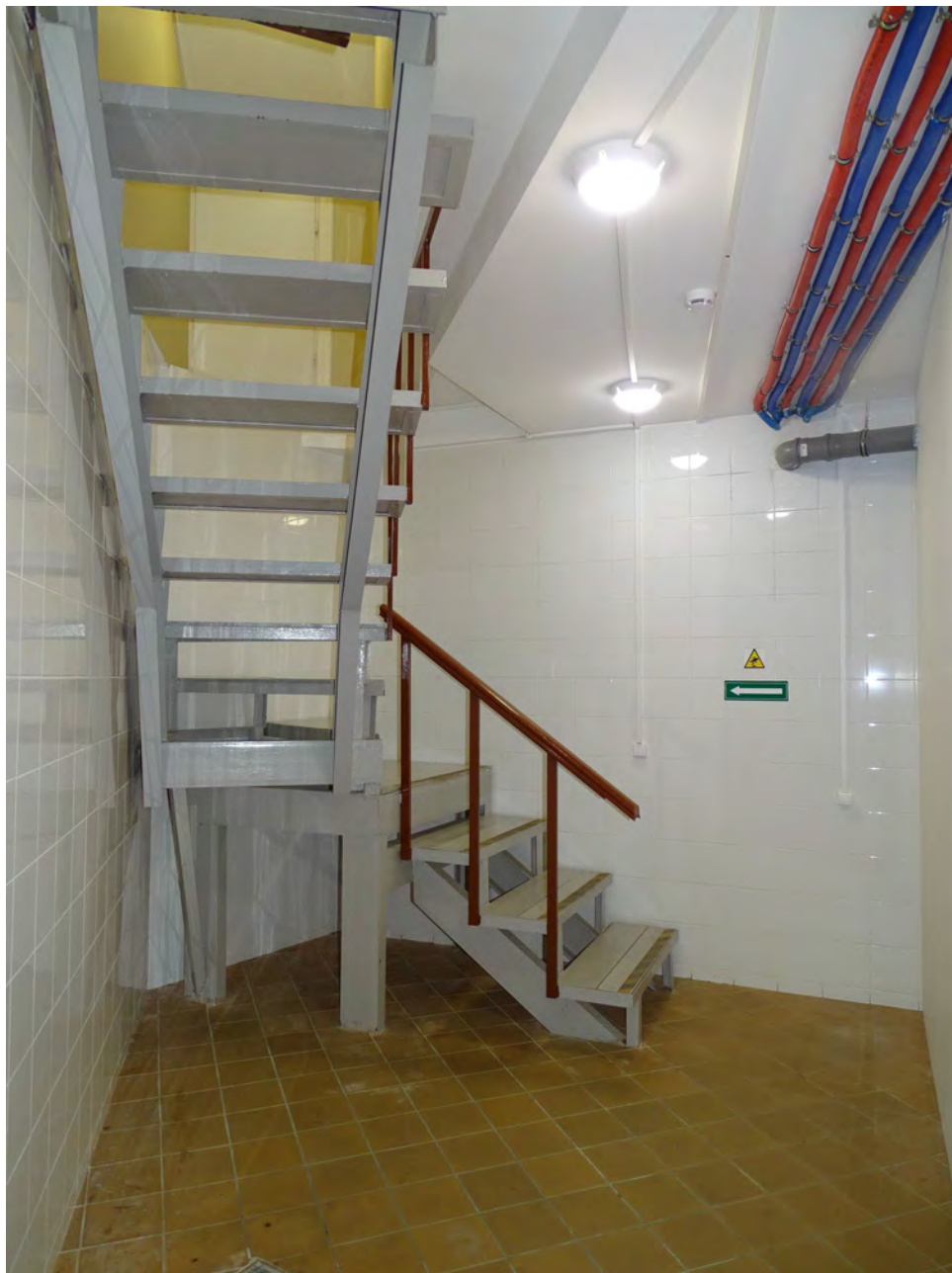
01. Помещение подвального этажа. Съемка 06.02.2026 г. Трушковский В.Э.
