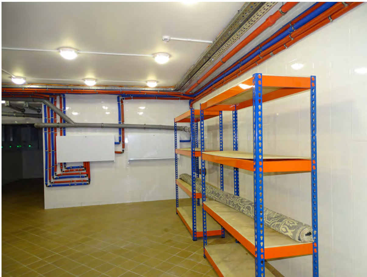
04. Помещение подвального этажа. Съемка 06.02.2026 г. Трушковский В.Э.
