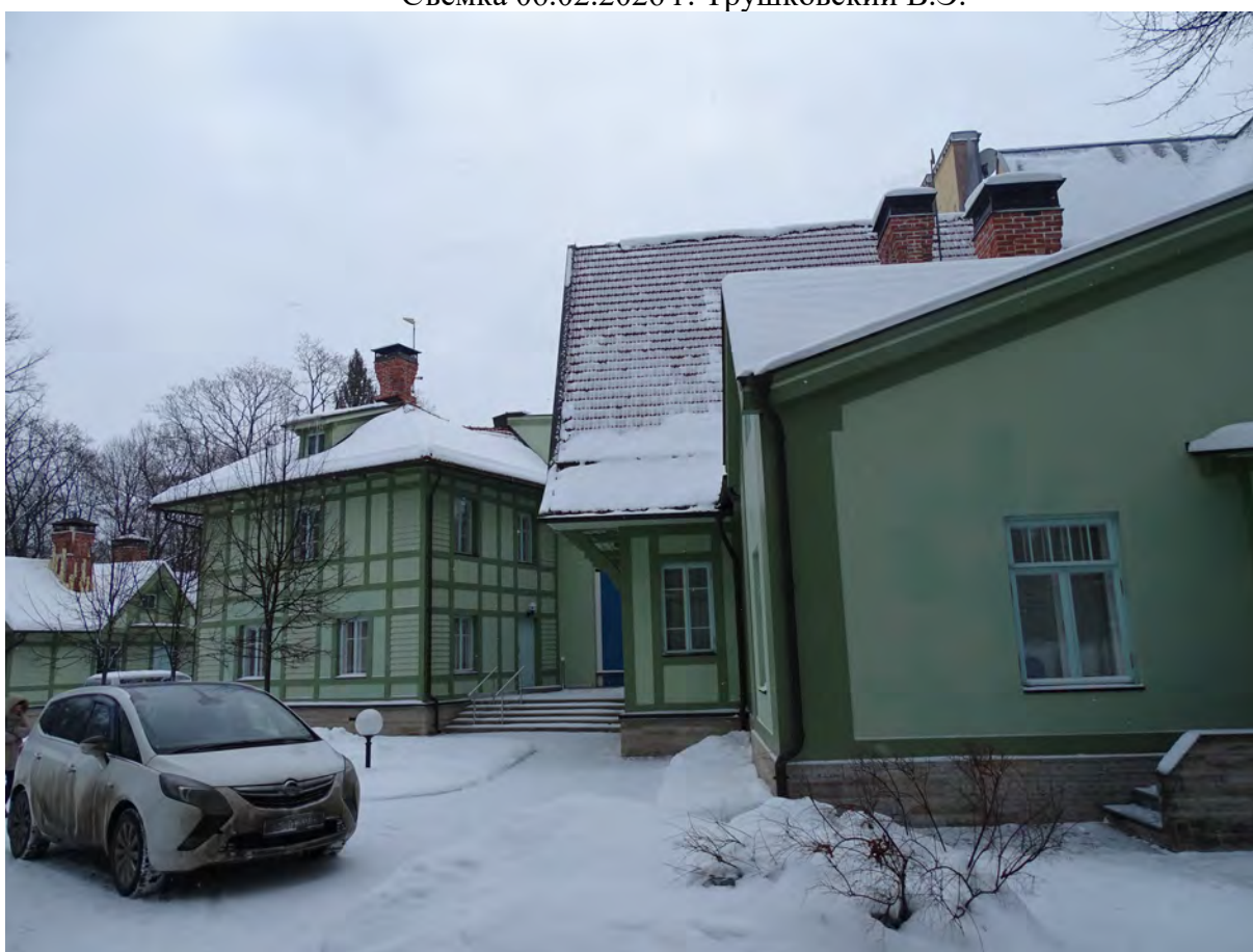
04. Служебный корпус. Вид с северо-западной стороны. Съемка 06.02.2026 г. Трушковский В.Э.
