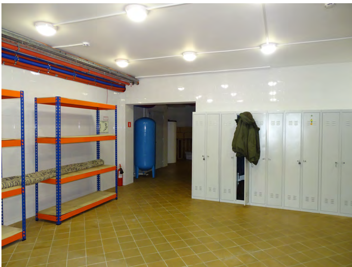
05. Помещение подвального этажа. Съемка 06.02.2026 г. Трушковский В.Э.
