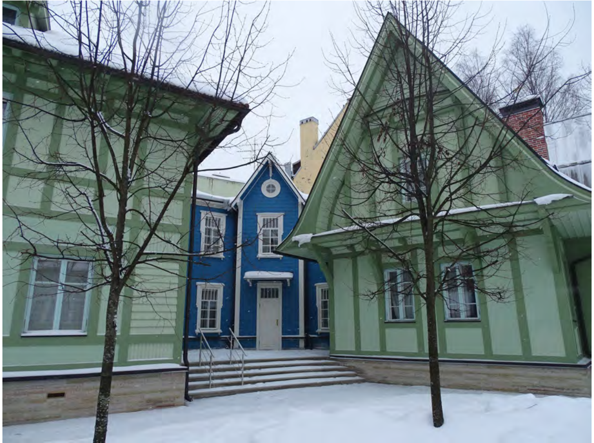
05. Служебный корпус. Вид с северной стороны. Центральная часть. Съемка 06.02.2026 г. Трушковский В.Э.
