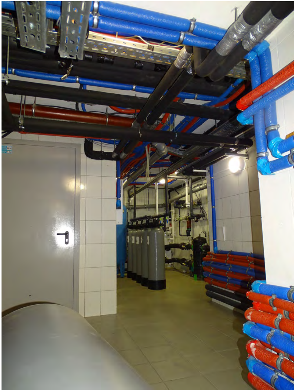
03. Помещение подвального этажа. Съемка 06.02.2026 г. Трушковский В.Э.
