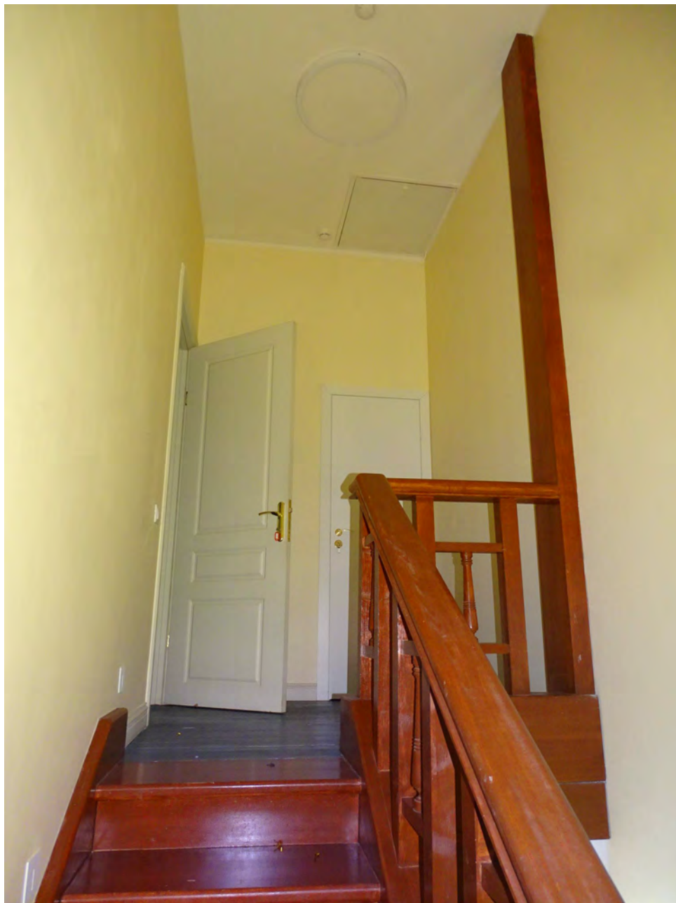
25. Помещение 2-го этажа. Западная лестница. Съемка 06.02.2026 г. Трушковский В.Э.
