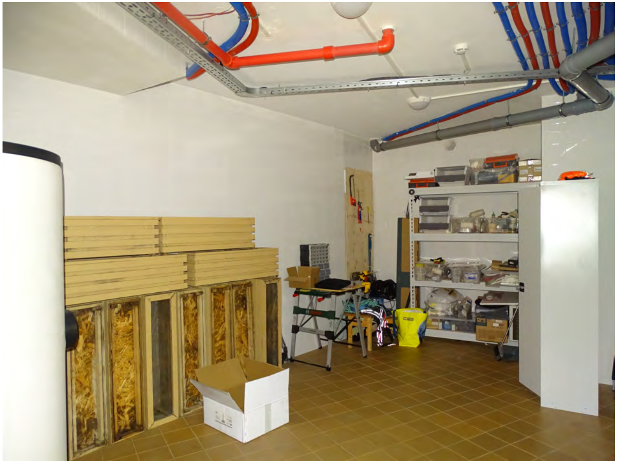
02. Помещение подвального этажа. Съемка 06.02.2026 г. Трушковский В.Э.
