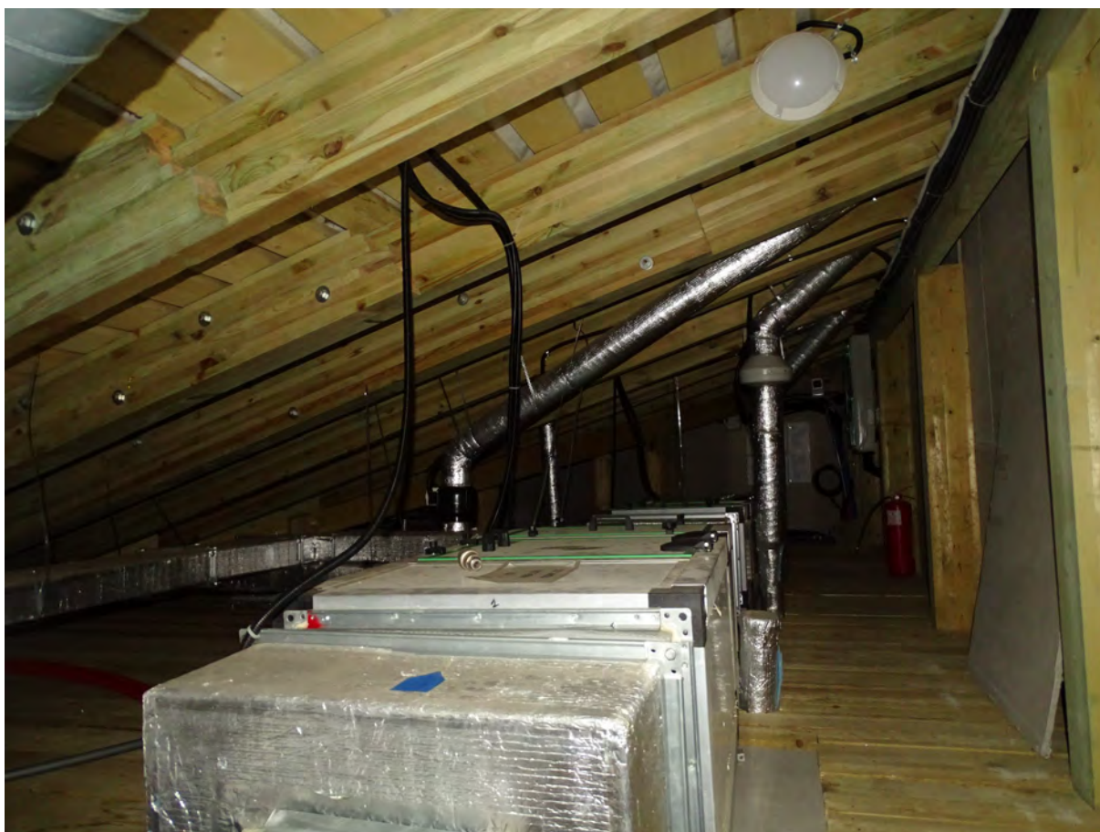
34. Чердак. Съемка 06.02.2026 г. Трушковский В.Э.
