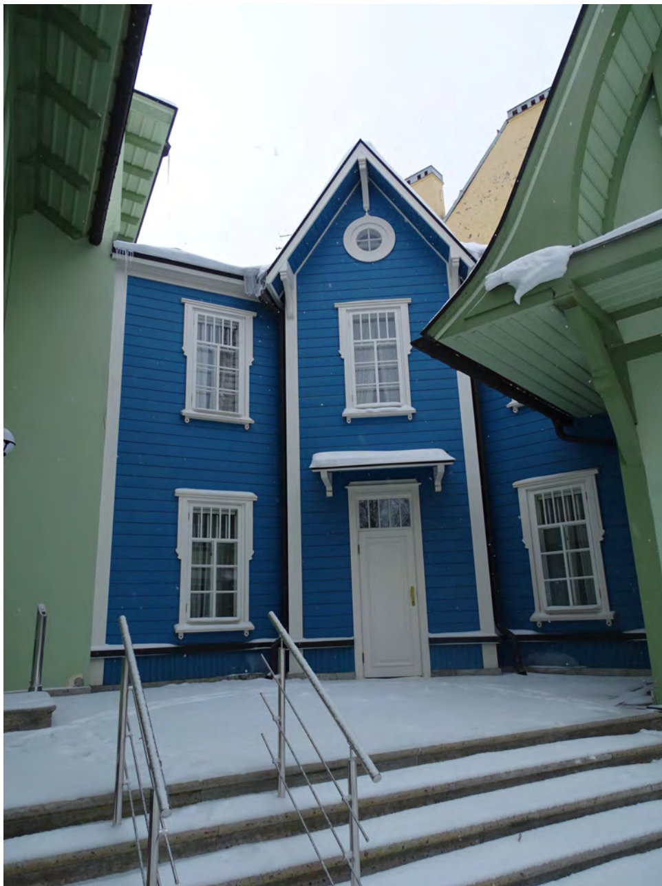
06. Служебный корпус. Вид с северной стороны. Центральная часть. Съемка 06.02.2026 г. Трушковский В.Э.
