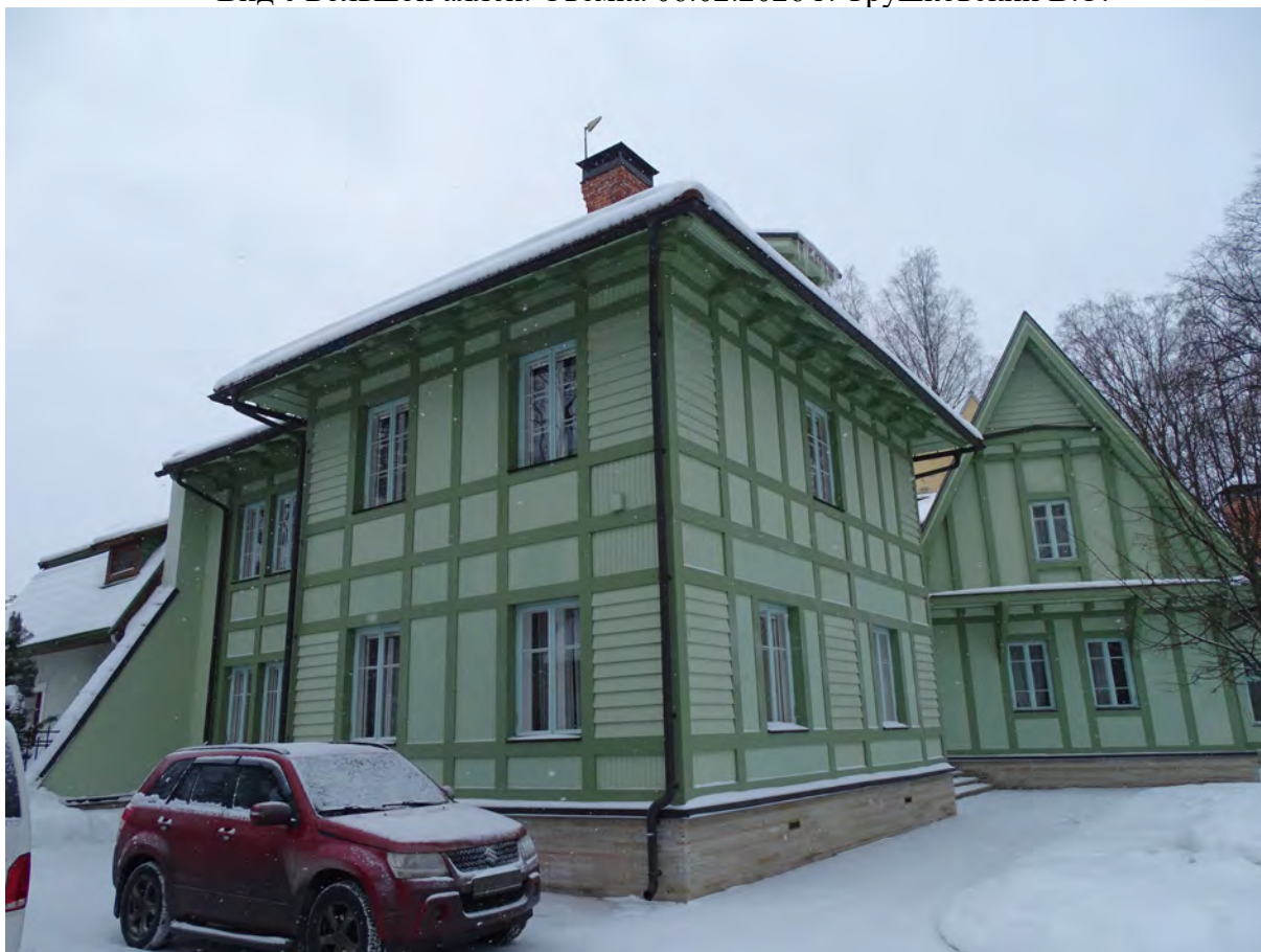
02. Служебный корпус. Вид с северо-восточной стороны. Съемка 06.02.2026 г. Трушковский В.Э.
