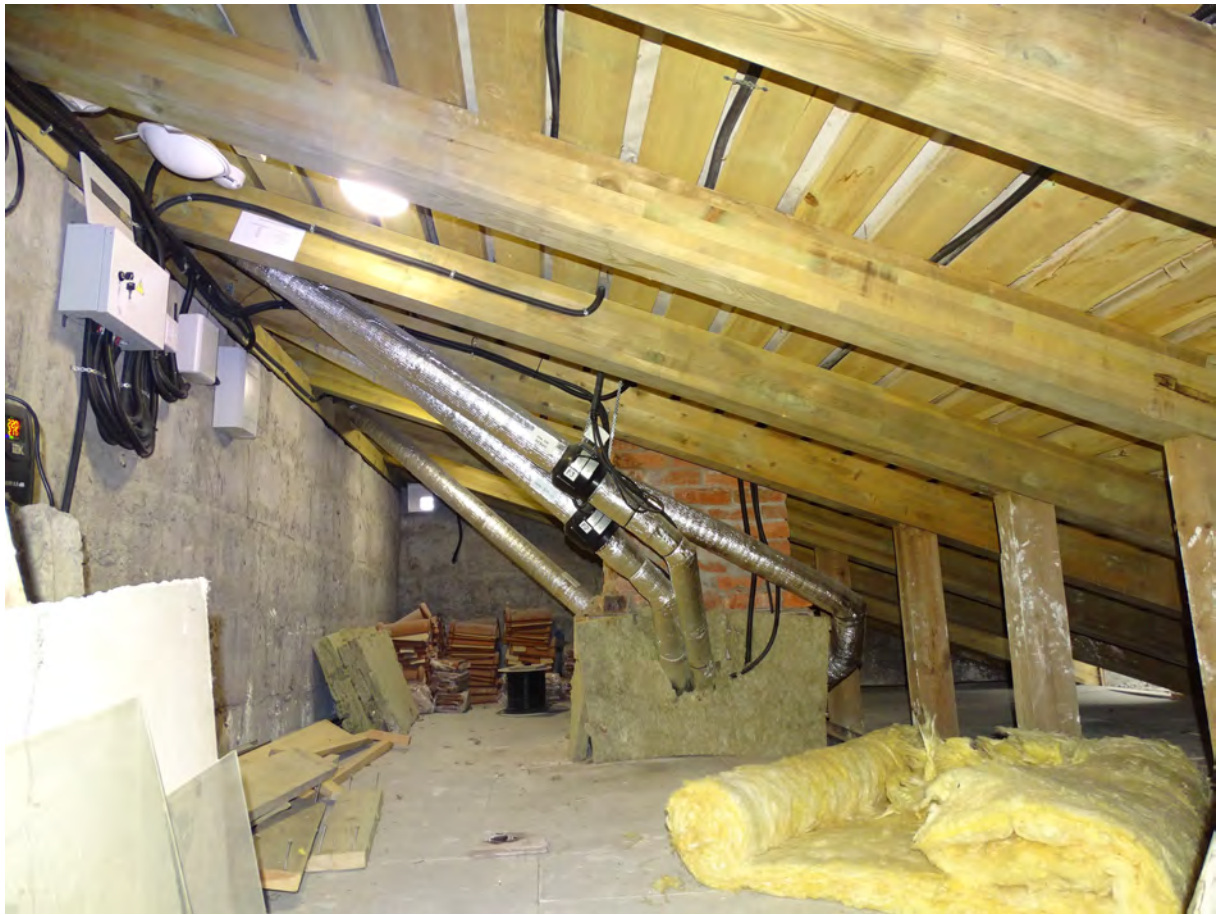
35. Чердак. Съемка 06.02.2026 г. Трушковский В.Э.
