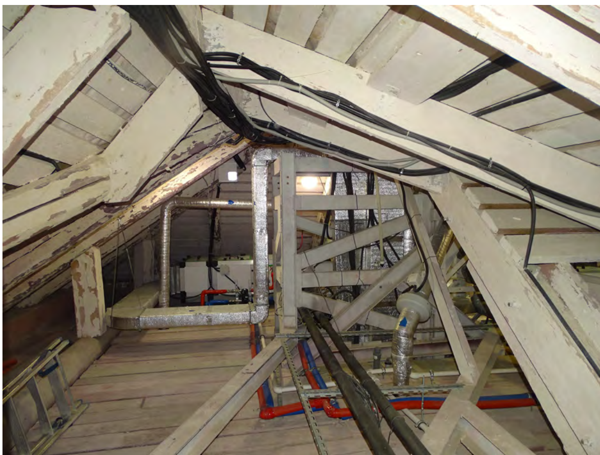
32. Чердак. Съемка 06.02.2026 г. Трушковский В.Э.
