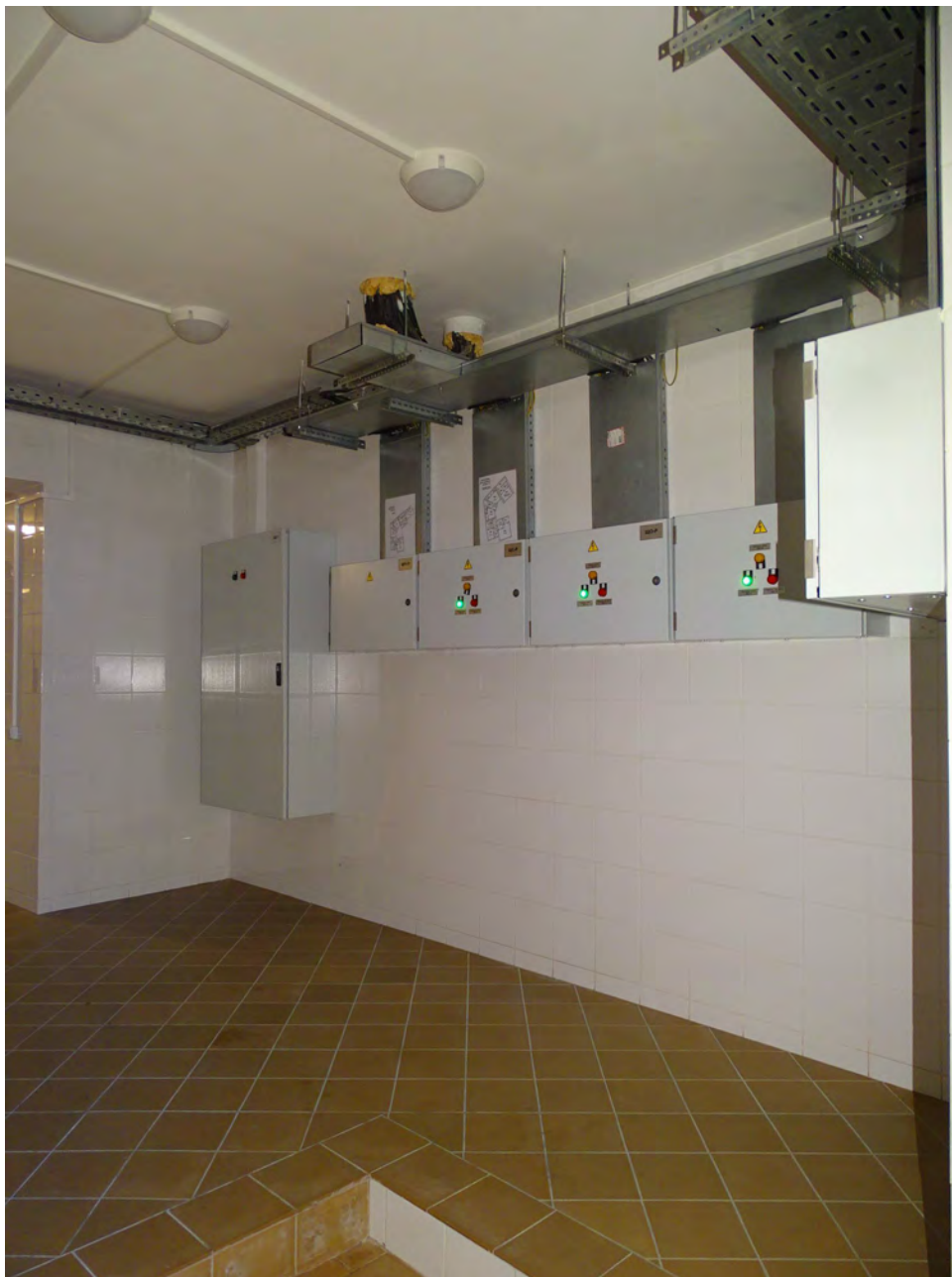
06. Помещение подвального этажа. Съемка 06.02.2026 г. Трушковский В.Э.
