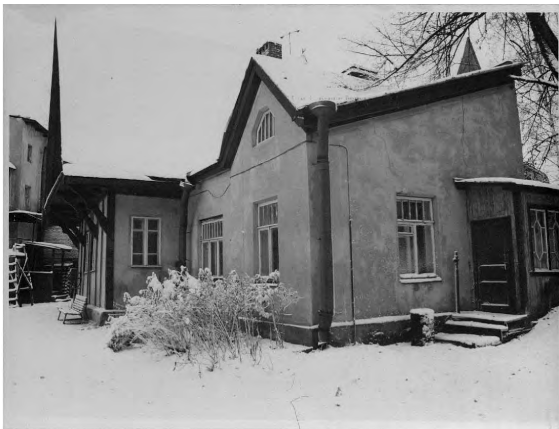
Илл. 28. Дача Гаусвальд. Служебный корпус (лит. Р). 2000 г. Паспорт КГИОП 404-10 инв. 1065П.
