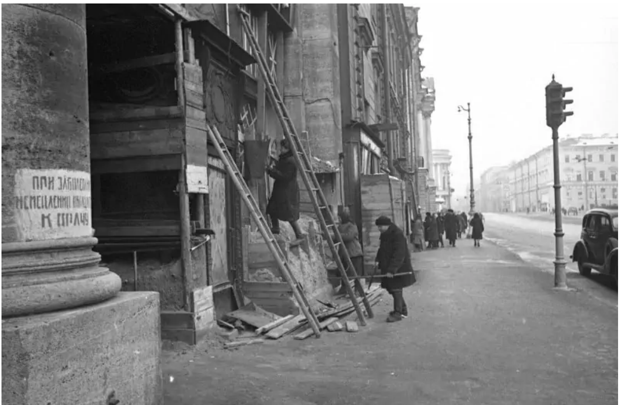
Илл. 68. Разборка укрытий витрины дома 21 по Невскому проспекту. 1944.
