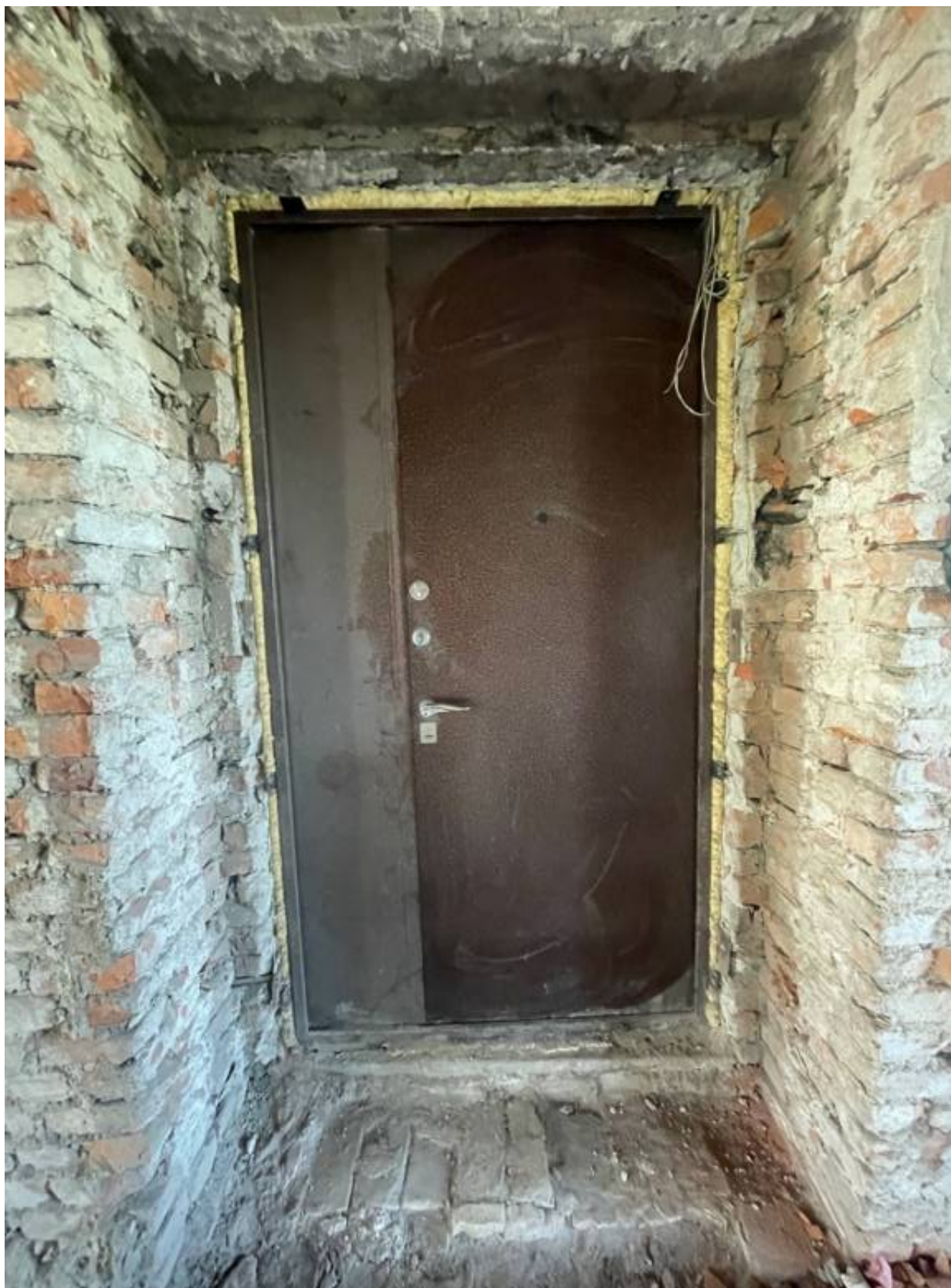
6. Входная дверь квартиры изнутри.
