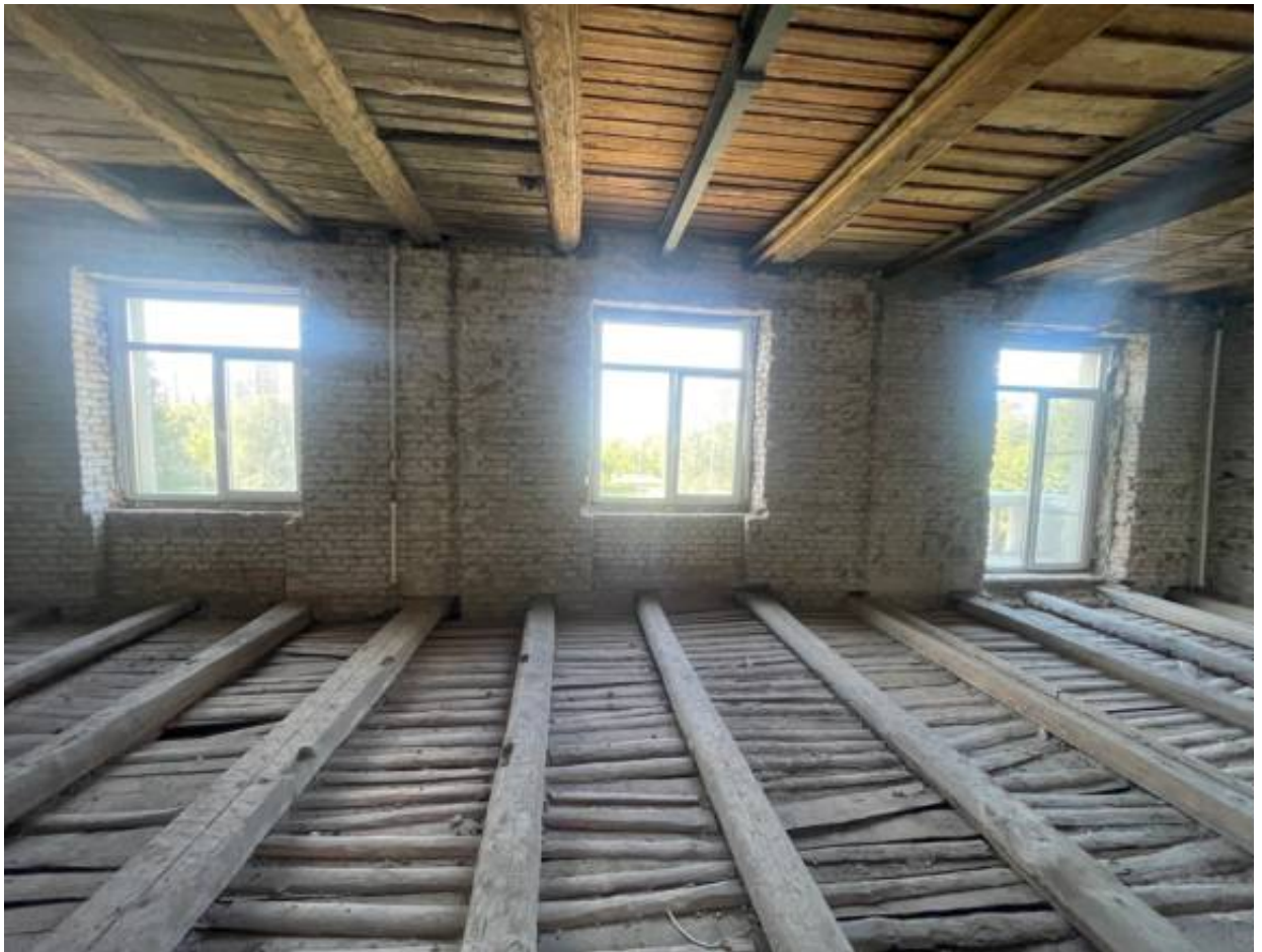
7. Помещение со стороны лицевого фасада.
