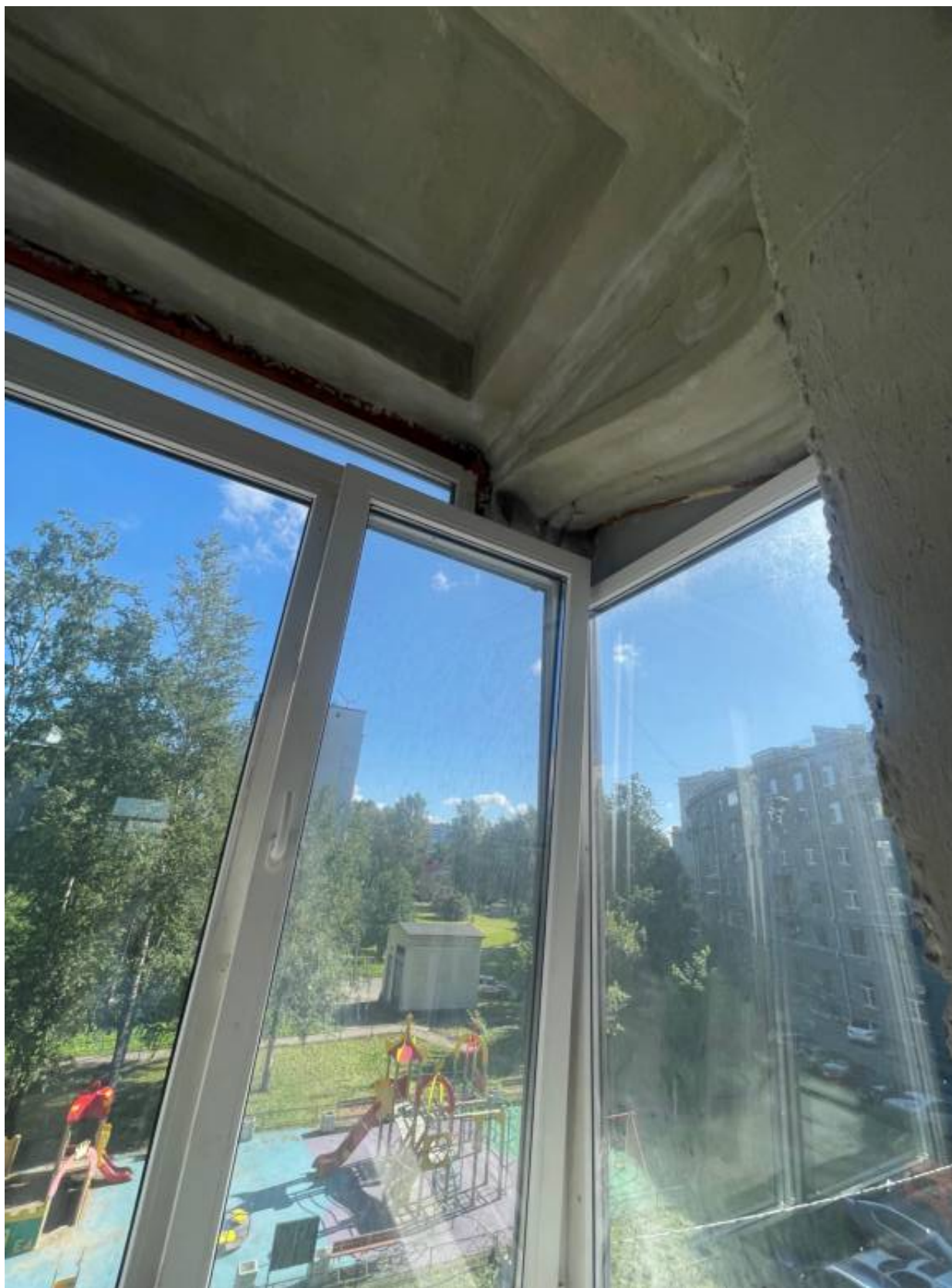
12. Балкон со стороны дворового фасада.
