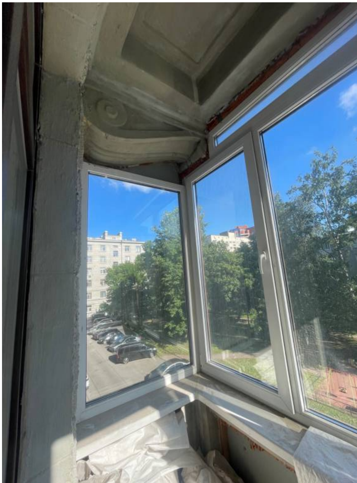
11. Балкон со стороны дворового фасада.
