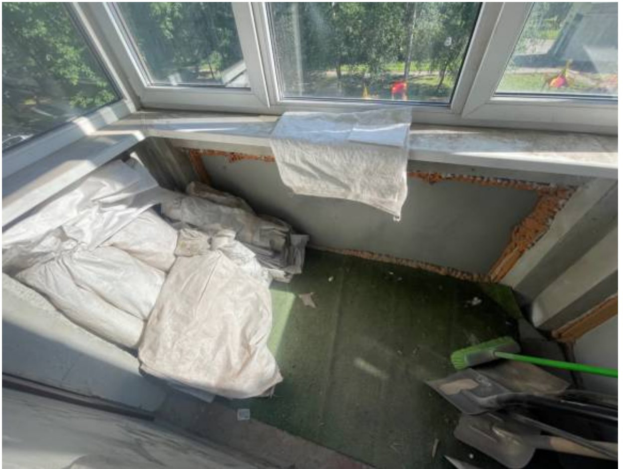
13. Балкон со стороны дворового фасада.
