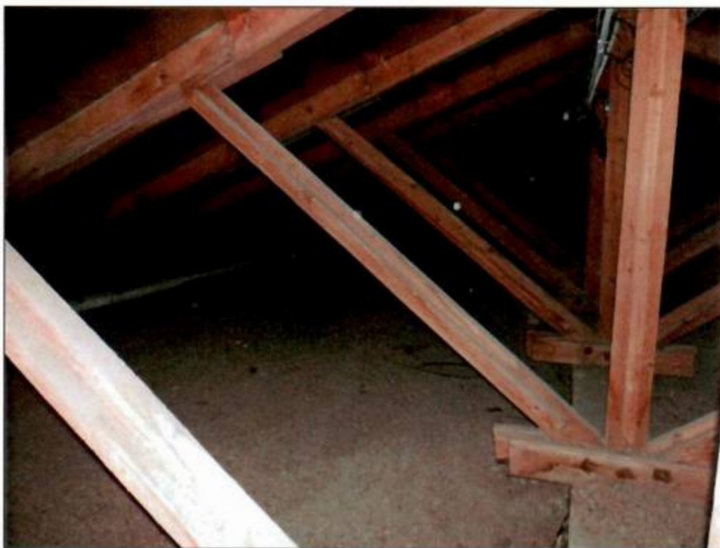
24. Стропильная система. Общий вид.
