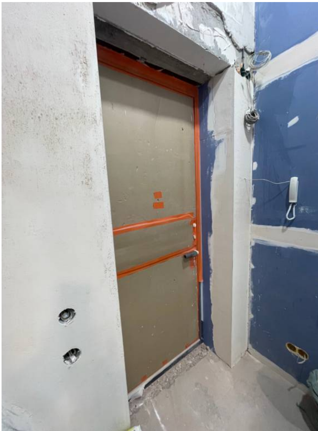
3. Входная дверь со стороны квартиры.
