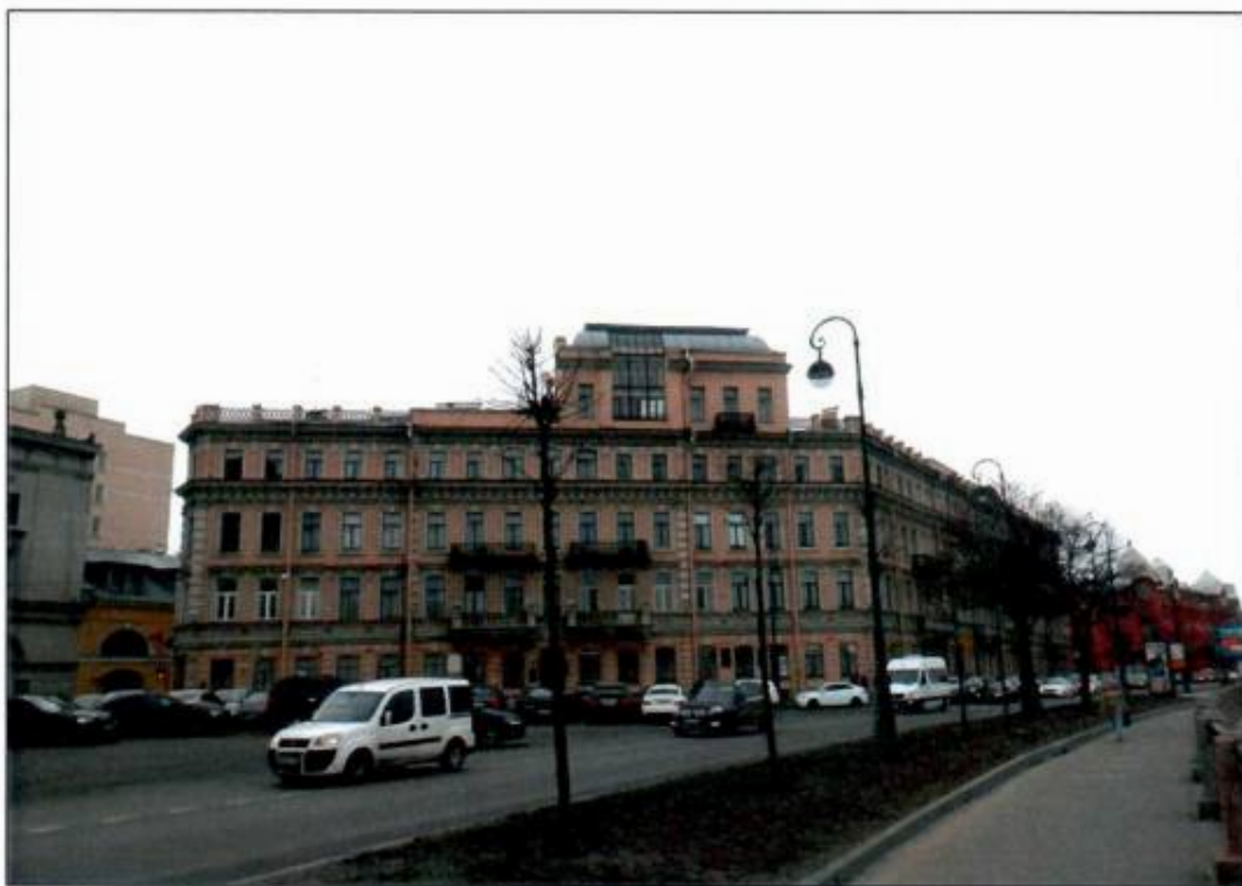
2. Общий вид с северо-востока.
