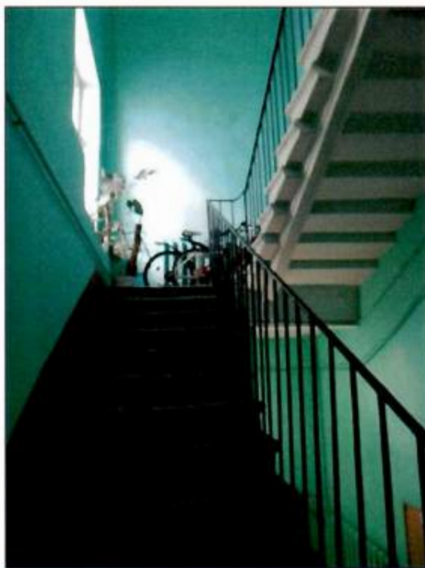
29. Подъезд № 2. Лестница. Общий вид.
