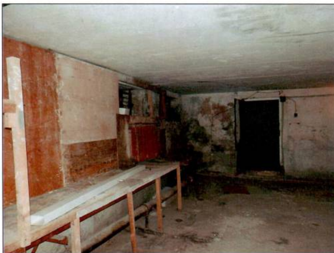
27. Помещение в уровне подвального этажа.
