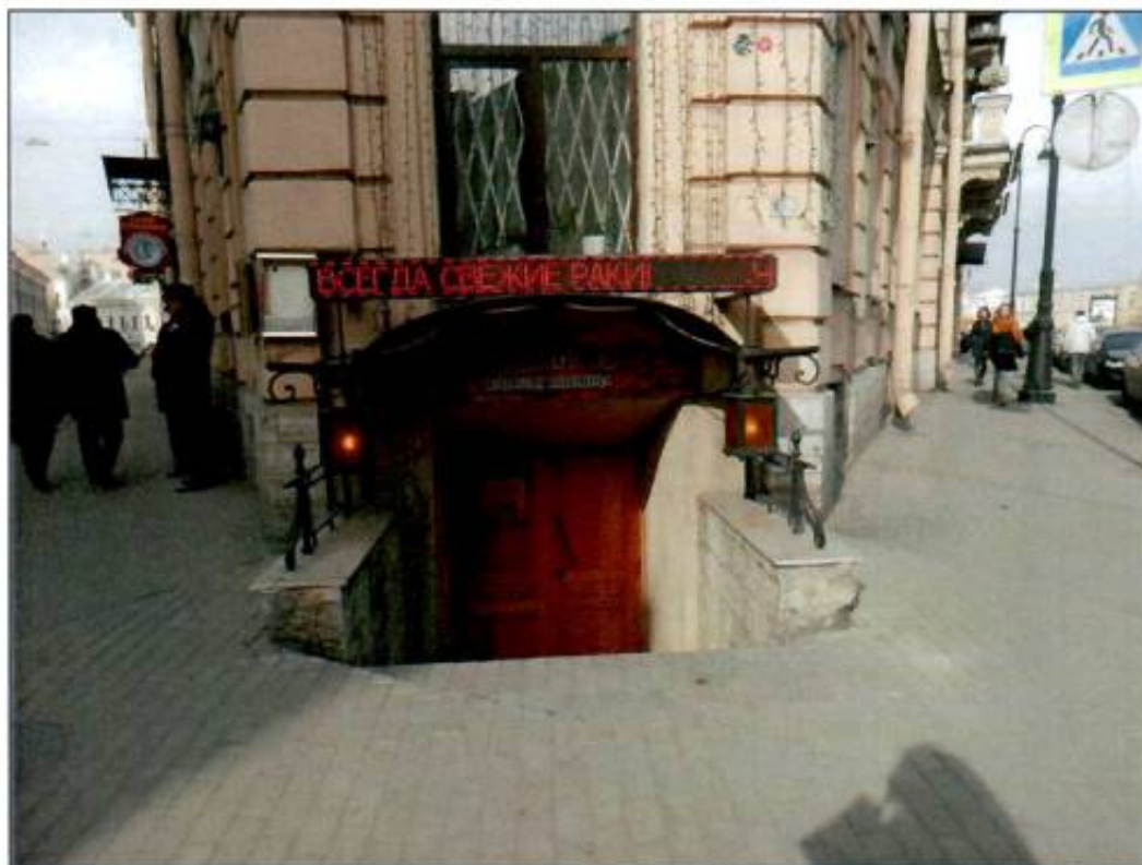
6. Восточный фасад. Прямо́к.
