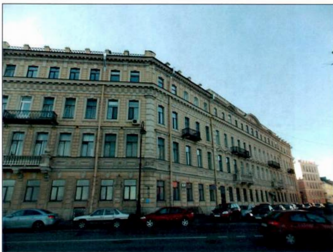
3. Общий вид с северо-запада.
