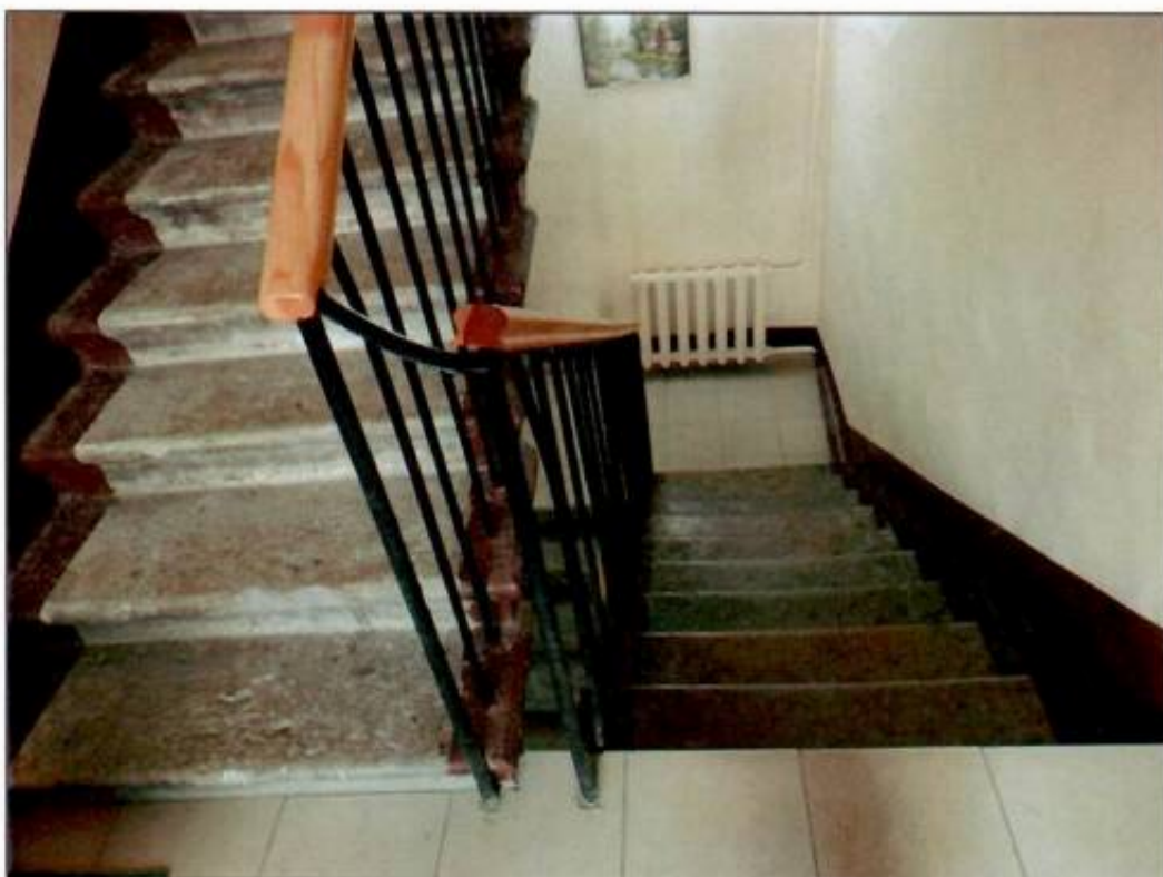
32. Подъезд № 5. Лестница. Общий вид.
