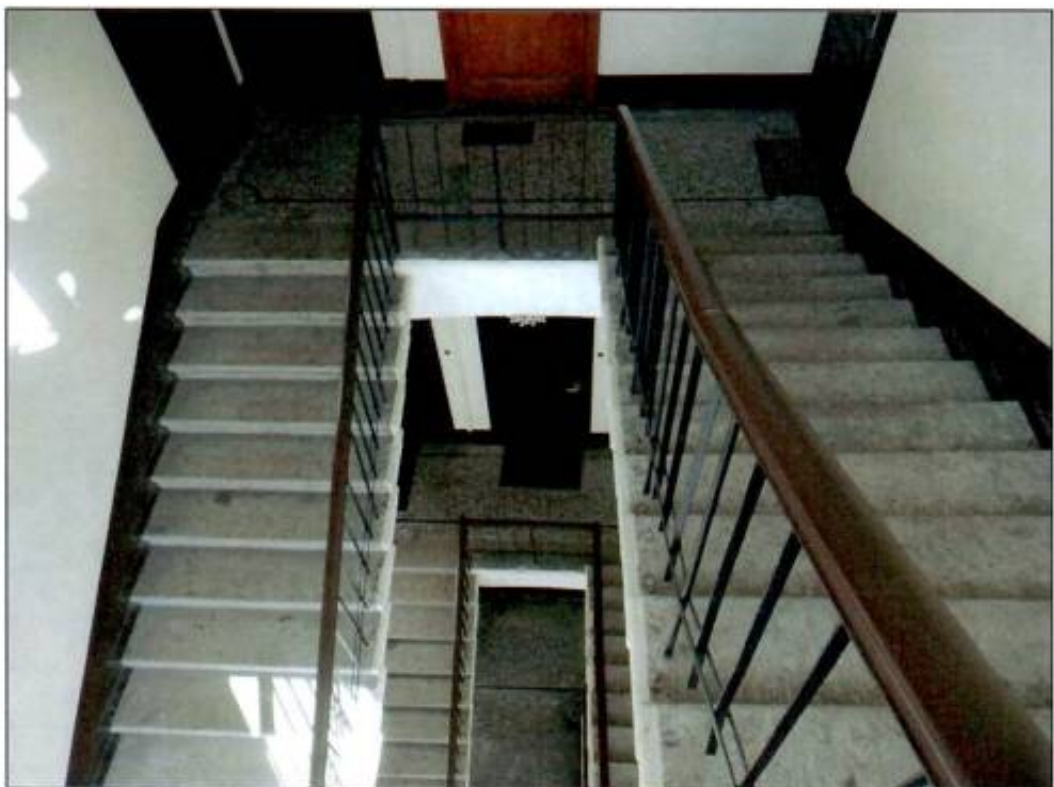
36. Подъезд № 8. Лестница. Общий вид.
