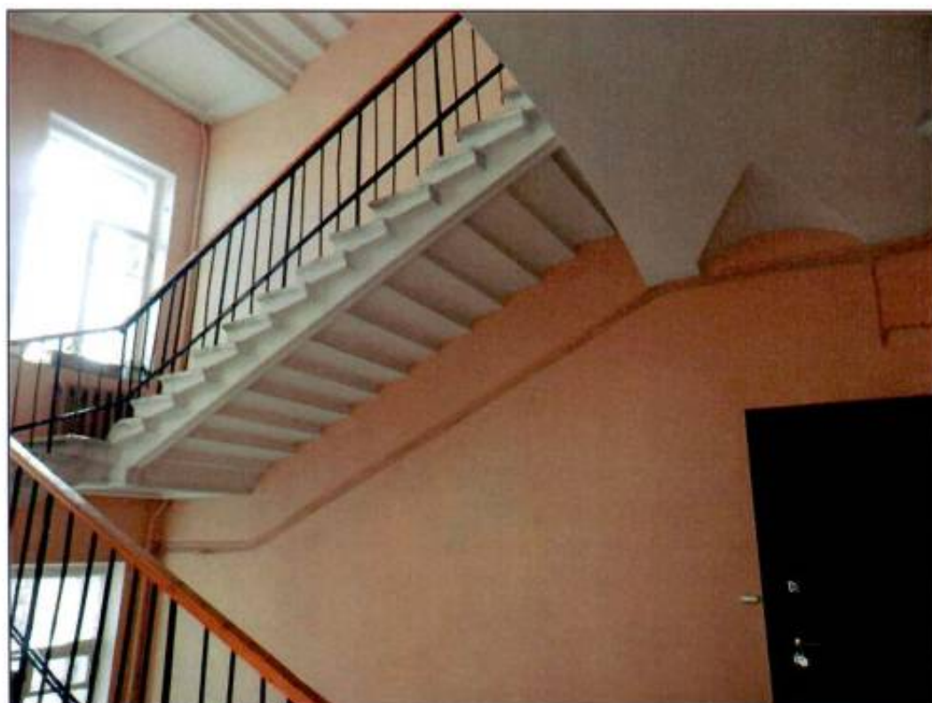
34. Подъезд № 7. Лестница. Общий вид.
