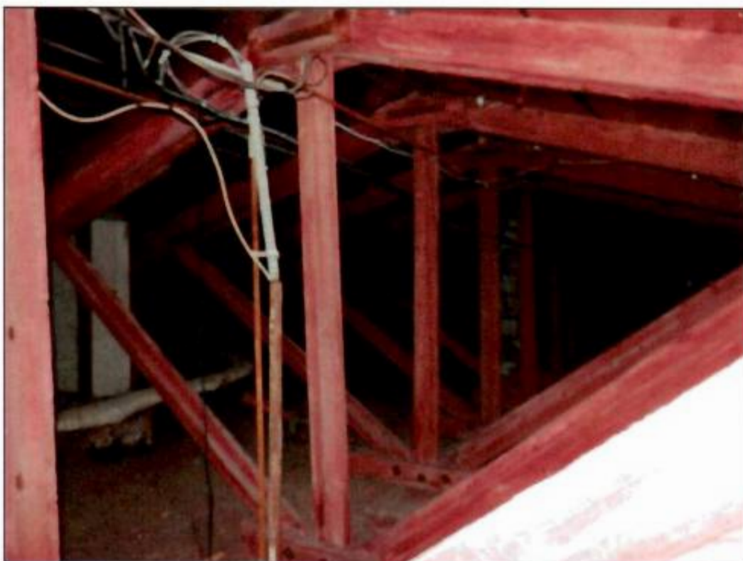
25. Стропильная система. Общий вид.
