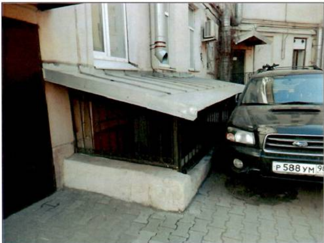
23. Внутренний двор. Северный фасад. Прямо́к.
