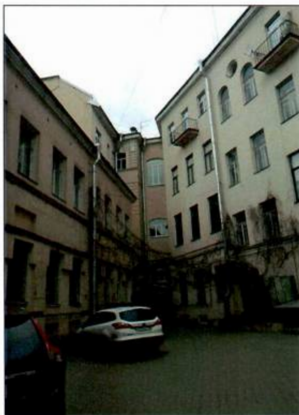
15. Внутренний двор. Вид с востока на запад.
