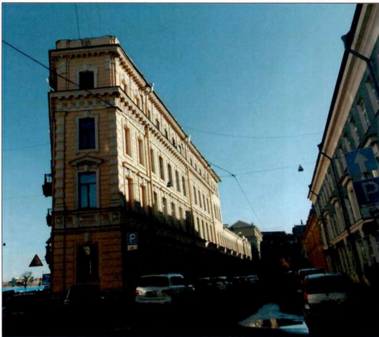
5. Общий вид с юго-запада.
