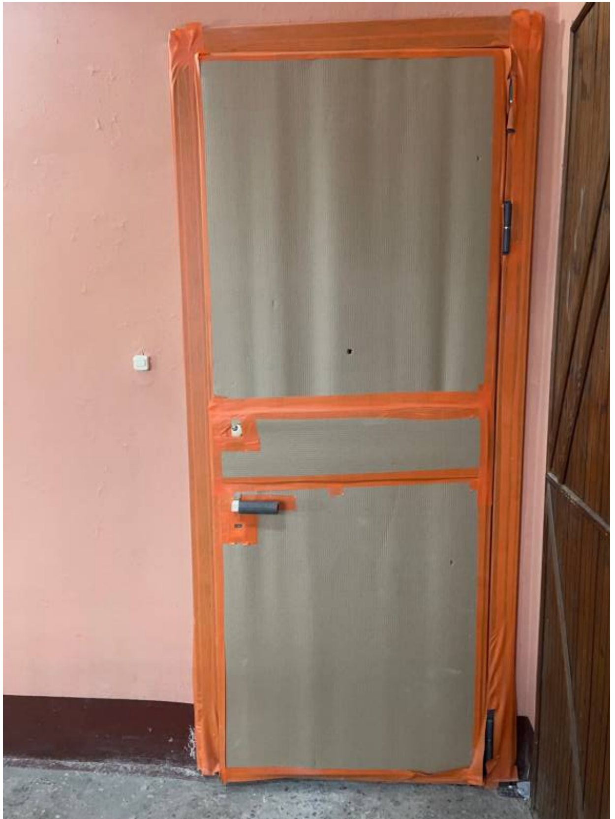
2. Вид входной двери в квартиру со стороны лестничной клетки.
