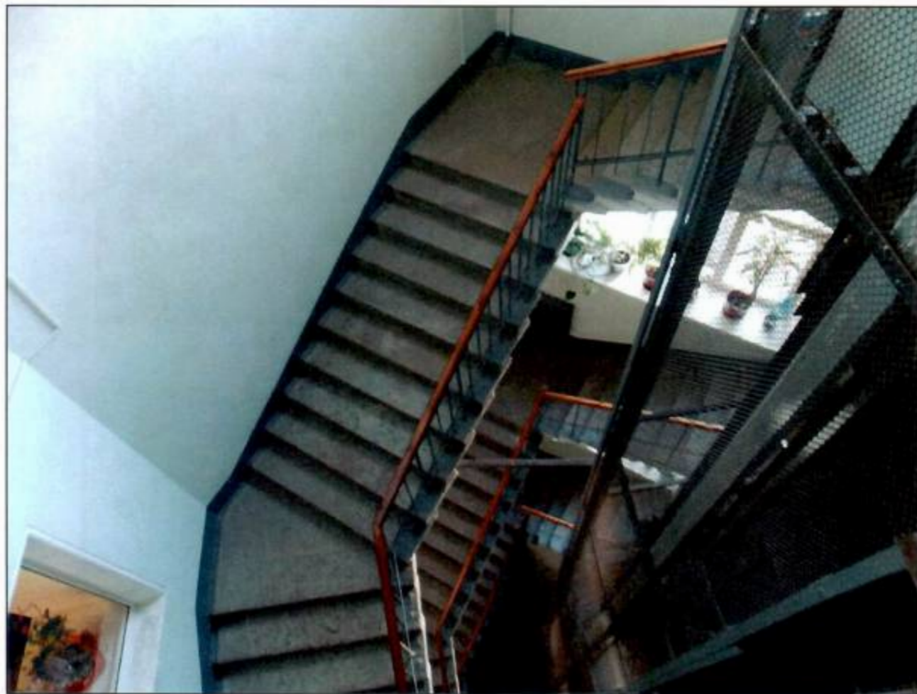
28. Подъезд № 1. Лестница. Общий вид.
