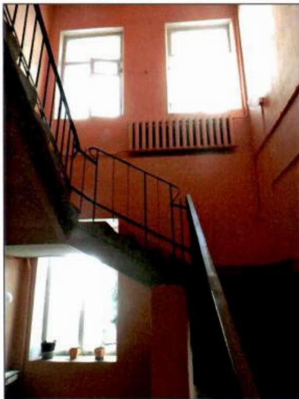
30. Подъезд № 3. Лестница. Общий вид.
