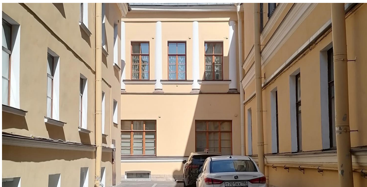
Фото 2. Дворовый фасад объекта культурного наследия регионального значения «Дома кн. Л.Д. Вяземского» по оси 2-5/Е. 08.09.2025г. Е.В. Каткова.
