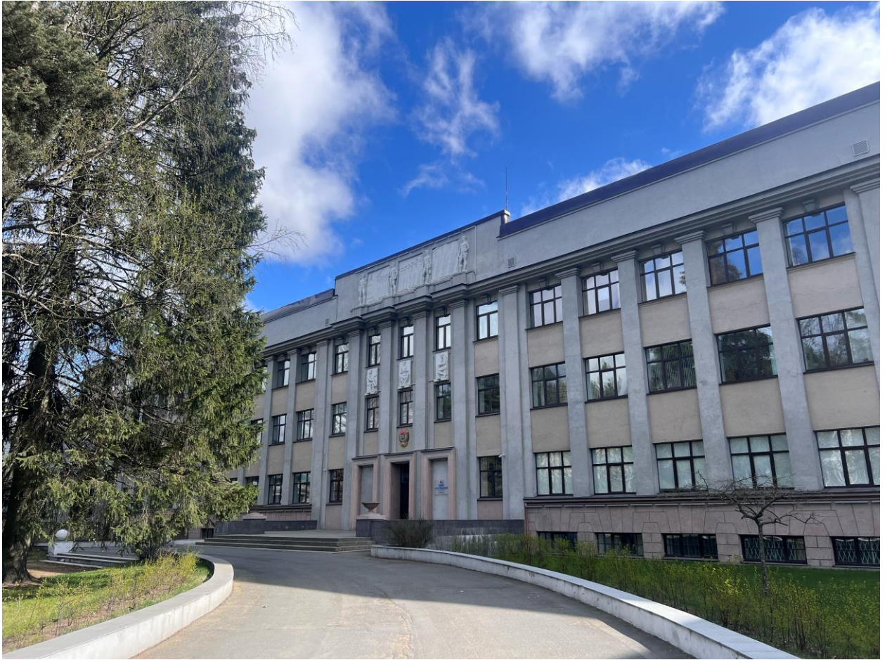
Фото 01. Объект культурного наследия регионального значения «Гидротехнический институт им. Б.Е. Веденеева (лицевой корпус с примыкающими дворовыми флигелями)», расположенный по адресу: г. Санкт Петербург, ул. Гжатская, д. 21, литера А. Общий вид лицевого фасада. Съёмка 27.04.2026 г.
