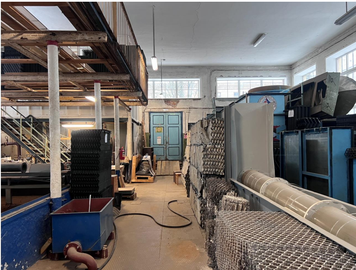
Фото 12. Объект культурного наследия регионального значения «Гидротехнический институт им. Б.Е. Веденеева (лицевой корпус с примыкающими дворовыми флигелями)», расположенный по адресу: г. Санкт Петербург, ул. Гжатская, д. 21, литера А. Помещение № 57. Фрагмент. Съёмка 27.04.2026 г.
