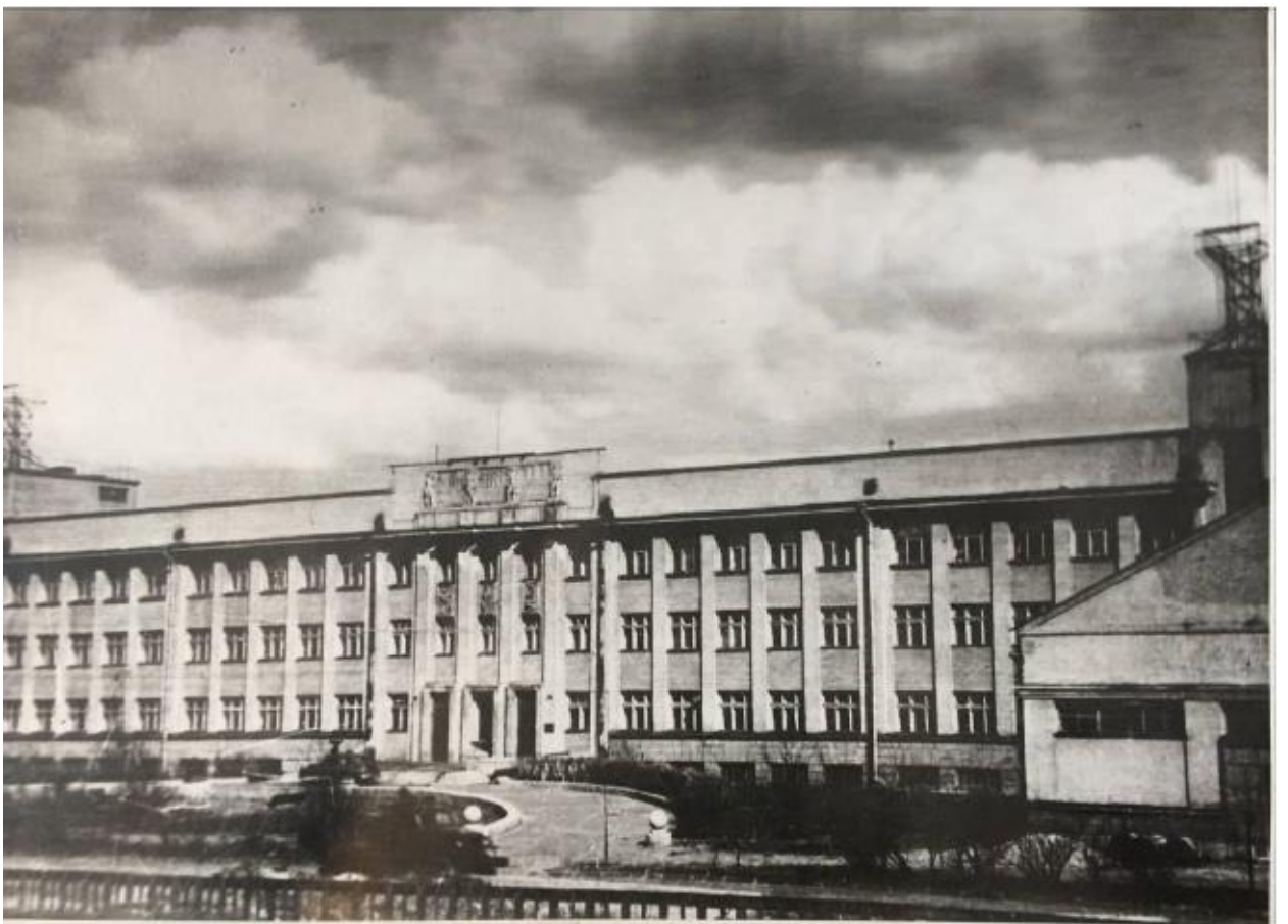
39. ВНИИГ им. Веденева. Лицевой корпус. Фото 1960-х.гг. По материалам музея ОАО ВНИИГ им. Б.Е. Веденева.
