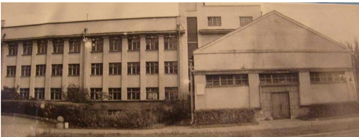
33. ВНИИГ им. Веденева. Лицевой корпус. Фото 1960-х.гг. По материалам музея ОАО ВНИИГ им. Б.Е. Веденева
