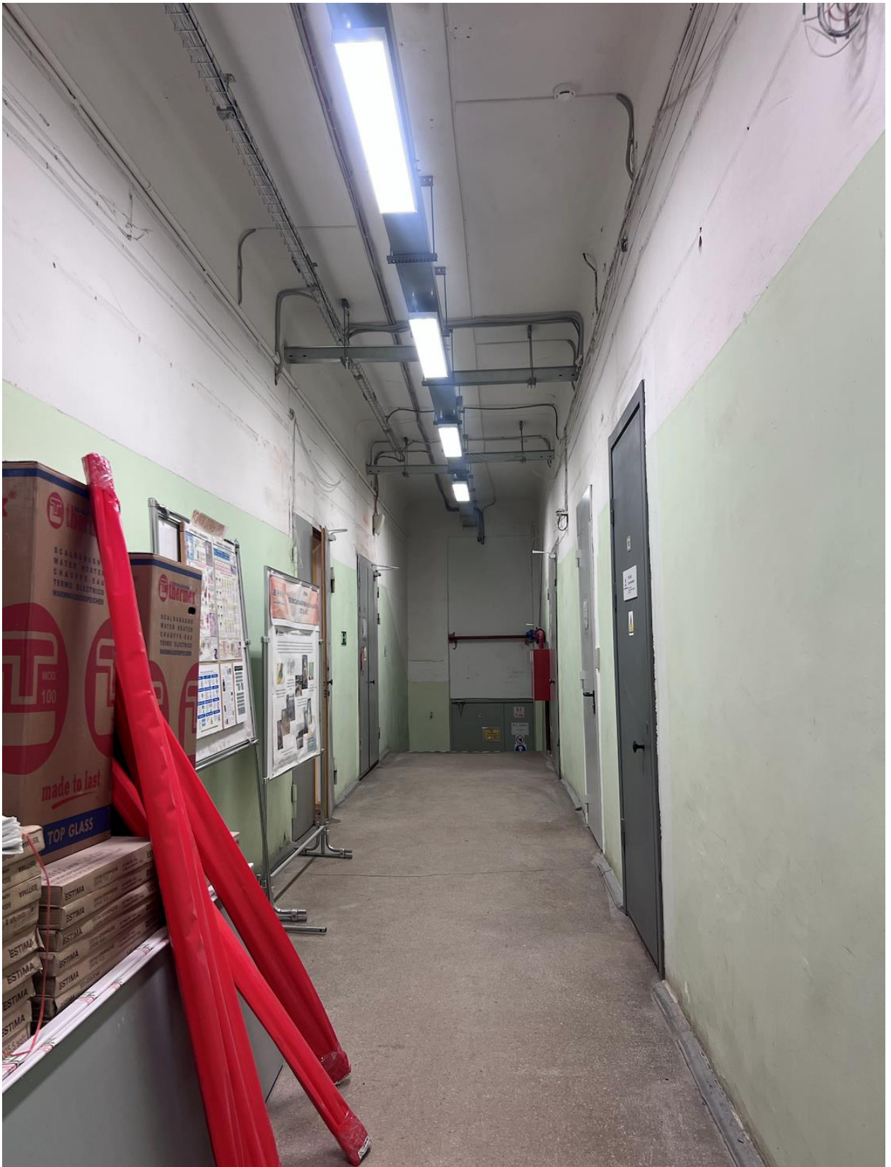
Фото 02. Объект культурного наследия регионального значения «Гидротехнический институт им. Б.Е. Веденеева (лицевой корпус с примыкающими дворовыми флигелями)», расположенный по адресу: г. Санкт Петербург, ул. Гжатская, д. 21, литера А. Помещение №47. Общий вид. Съёмка 27.04.2026 г.
