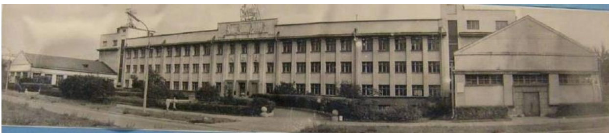
34. ВНИИГ им. Веденева. Лицевой корпус. Фото 1971 г. По материалам музея ОАО ВНИИГ им. Б.Е. Веденева
