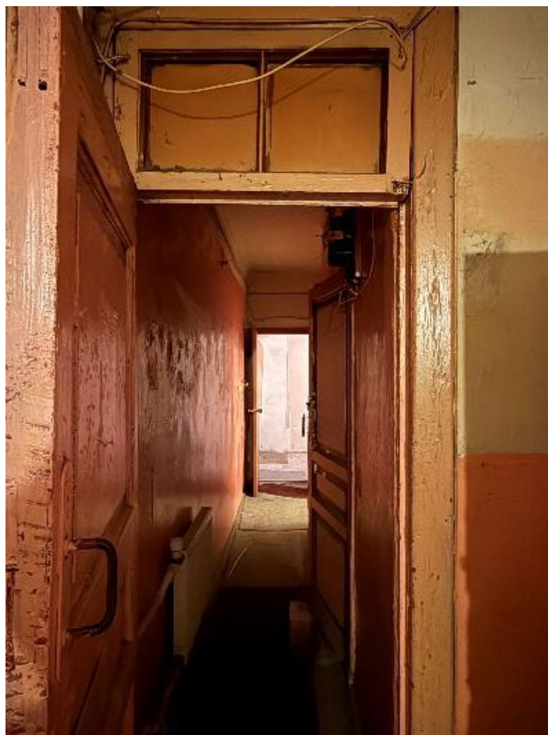
11. Выявленный ОКН «Дом С.В. Орлова-Давыдова» (г. Санкт-Петербург, Гороховая ул., д. 5. Помещение кв.№26
