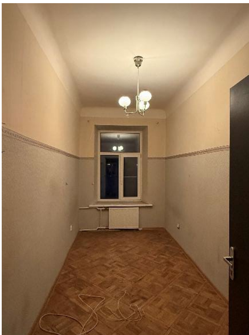
12. Выявленный ОКН «Дом С.В. Орлова-Давыдова» (г. Санкт-Петербург, Гороховая ул., д. 5. Помещение кв.№26
