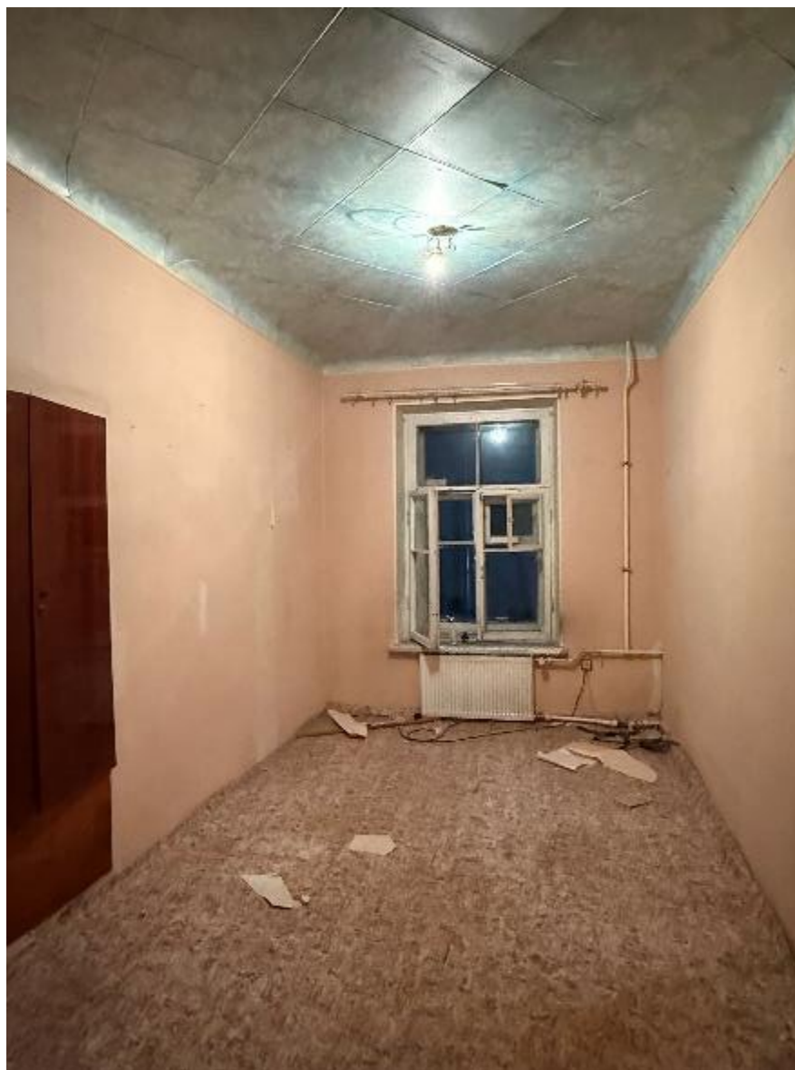
14. Выявленный ОКН «Дом С.В. Орлова-Давыдова» (г. Санкт-Петербург, Гороховая ул., д. 5. Помещение кв.№26
