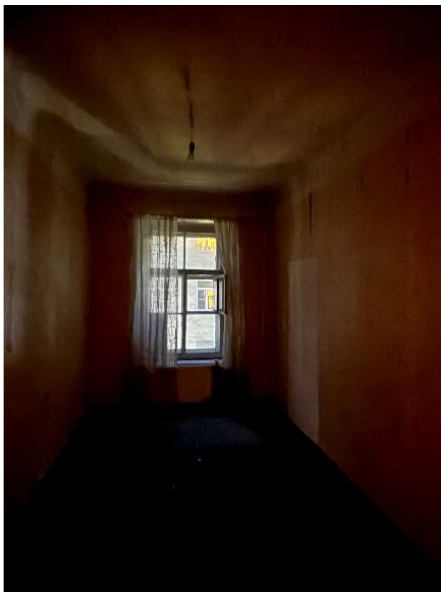
17. Выявленный ОКН «Дом С.В. Орлова-Давыдова» (г. Санкт-Петербург, Гороховая ул., д. 5. Помещение кв.№26
