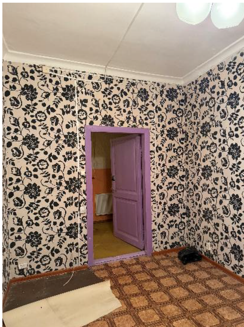
10. Выявленный ОКН «Дом С.В. Орлова-Давыдова» (г. Санкт-Петербург, Гороховая ул., д. 5. Помещение кв.№26.
