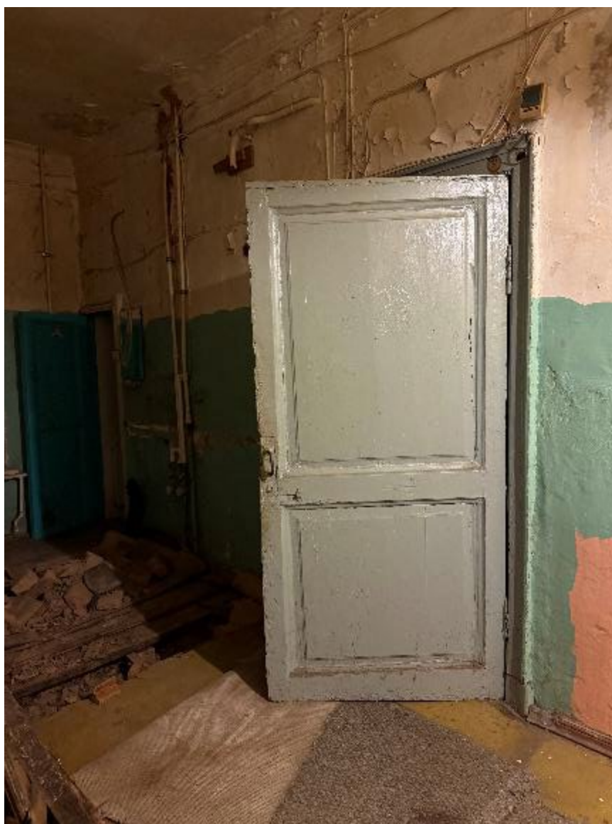
18. Выявленный ОКН «Дом С.В. Орлова-Давыдова» (г. Санкт-Петербург, Гороховая ул., д. 5. Помещение кв.№26
