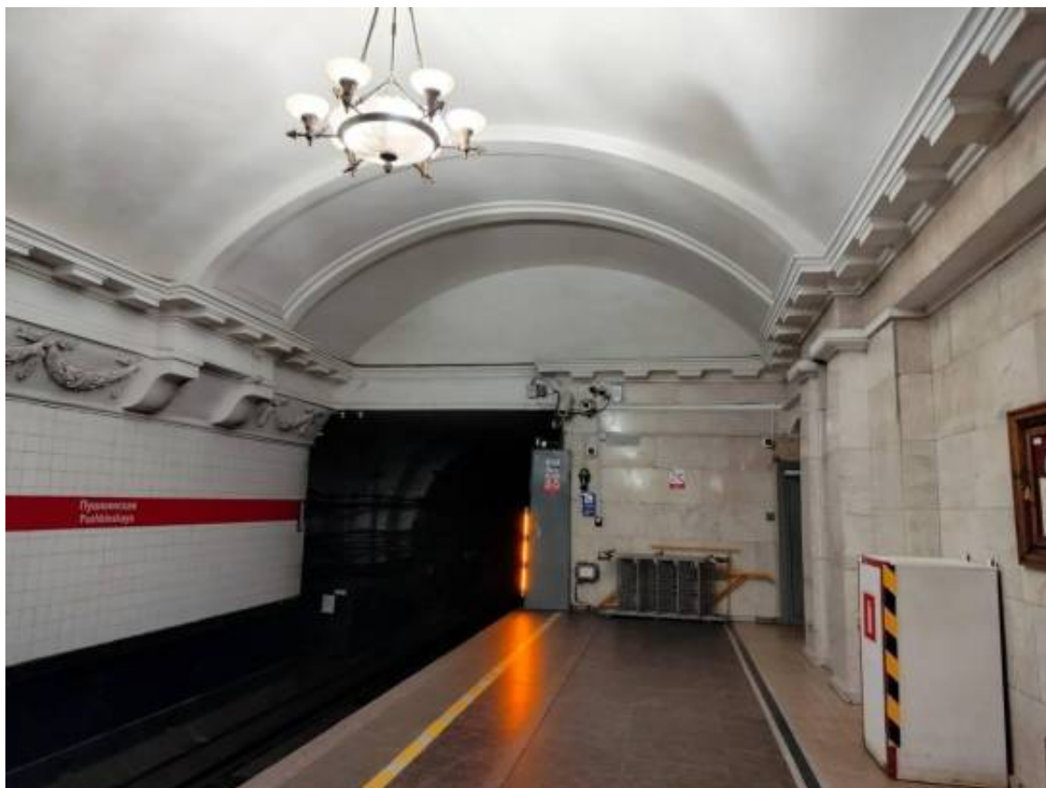
Фото 24. Интерьер перронного зала (2-го подземного этажа) объекта культурного наследия регионального значения «Станция метро «Пушкинская» (с перронным залом)»
