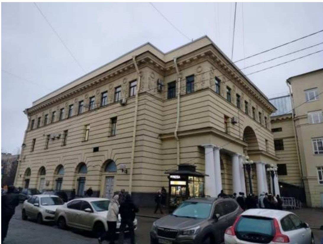
Фото 5. Фрагмент лицевого фасада объекта культурного наследия регионального значения «Станция метро «Пушкинская» (с перронным залом)»
