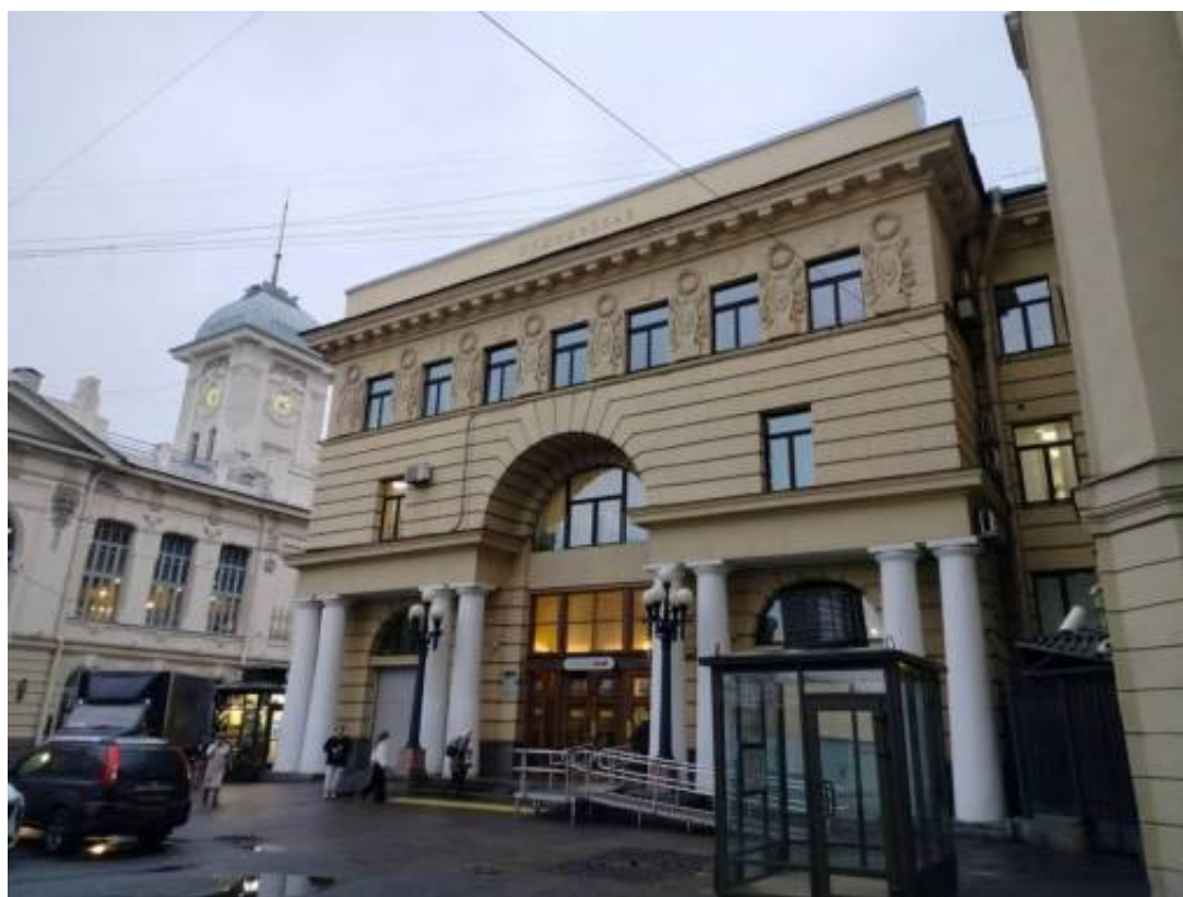
Фото 6. Фрагмент лицевого фасада объекта культурного наследия регионального значения «Станция метро «Пушкинская» (с перронным залом)»
