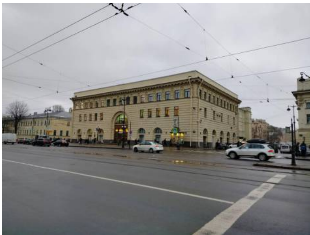
Фото 3. Фрагмент лицевого фасада объекта культурного наследия регионального значения «Станция метро «Пушкинская» (с перронным залом)»
