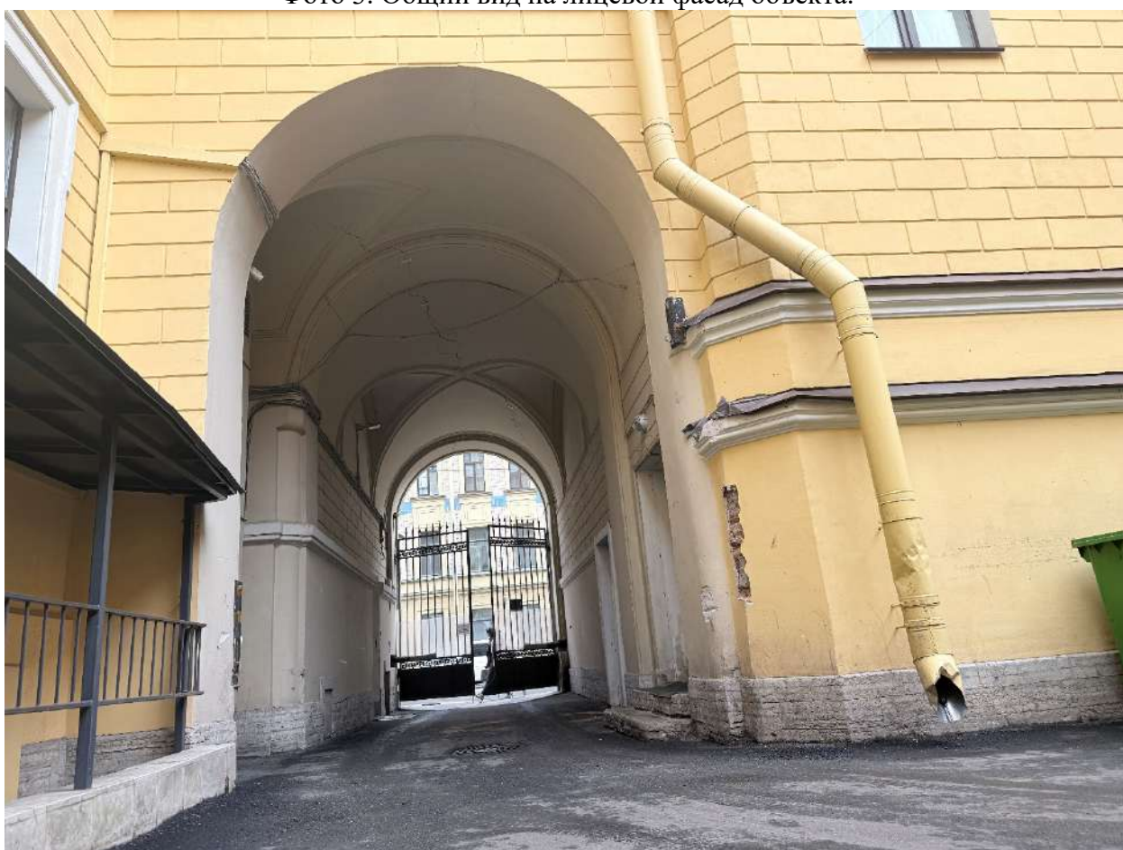
Фото 4. Общий вид на арочный проезд.
