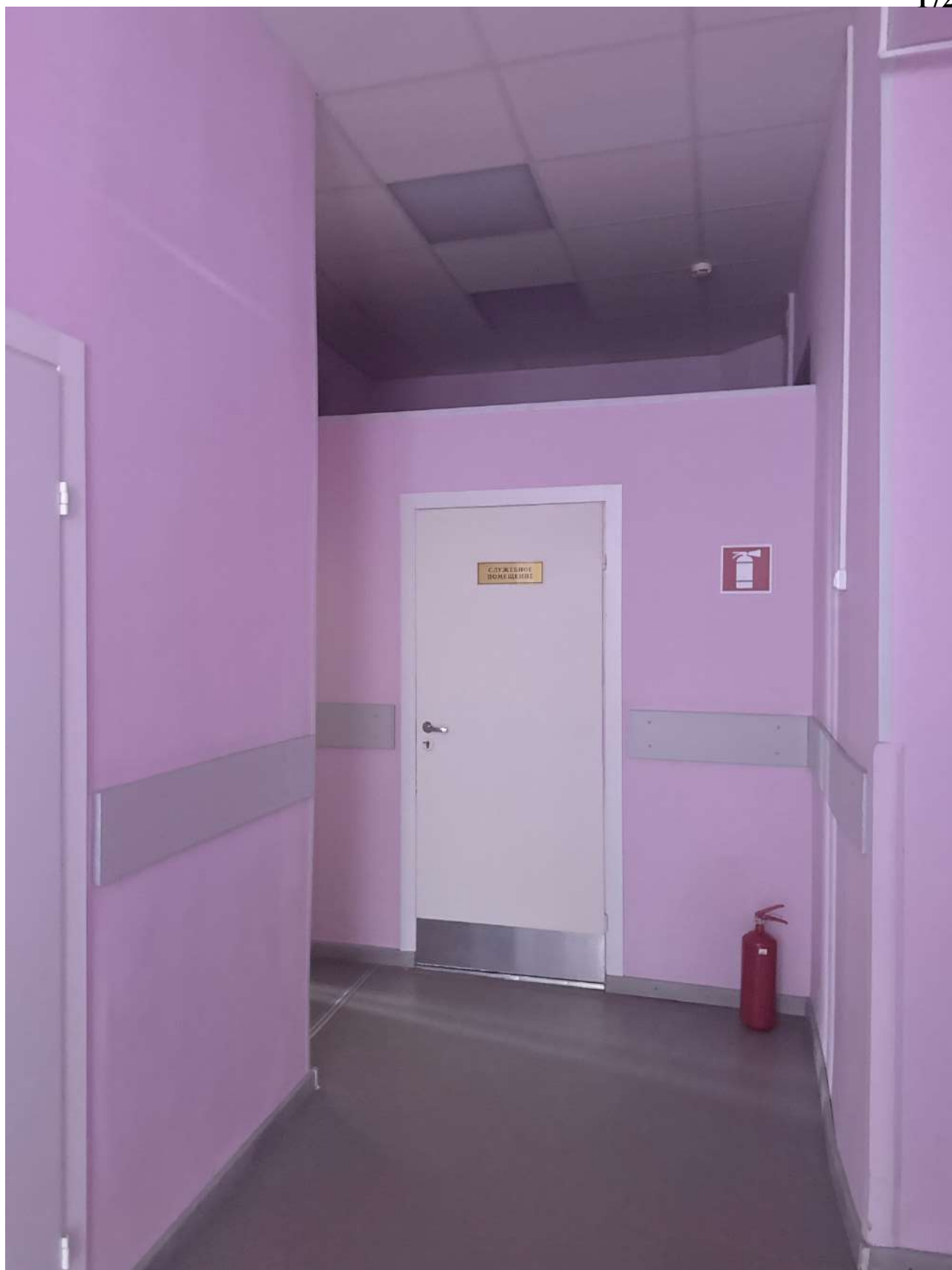
Фото 37. Общий вид на часть помещений в границе проектирования.
