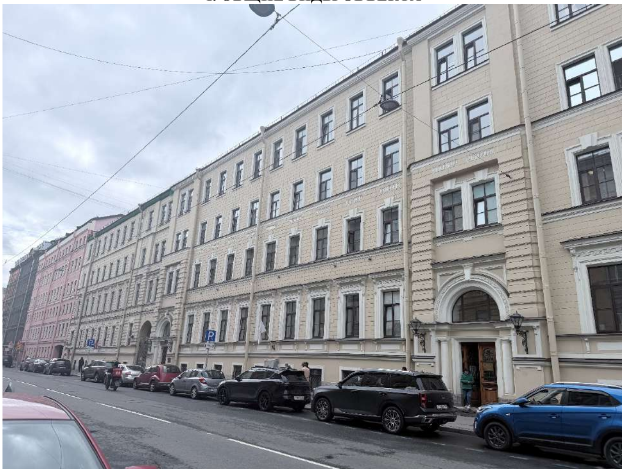
Фото 1. Общий вид на лицевой фасад объекта.
