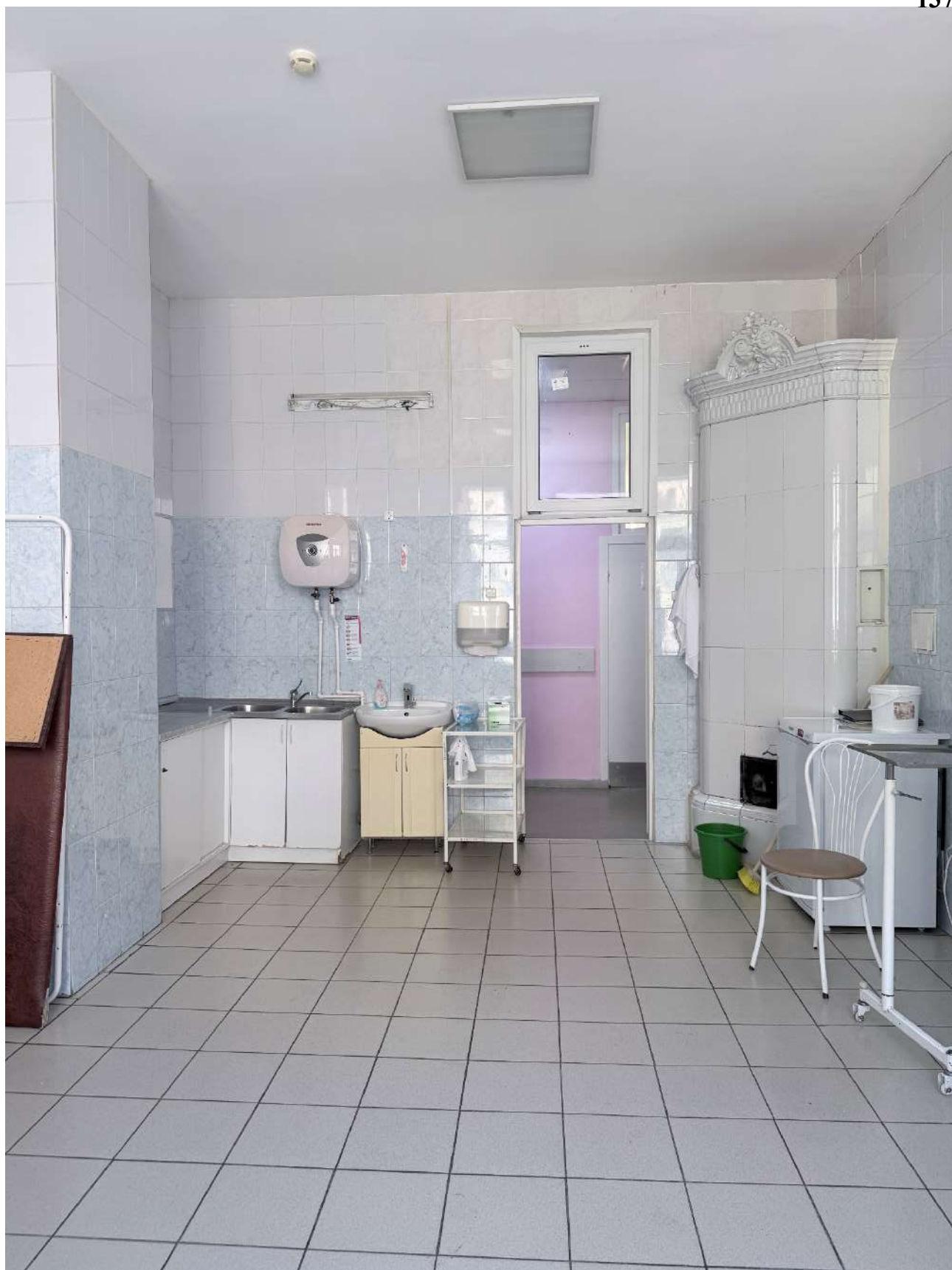
Фото 2. Общий вид на часть помещений в границе проектирования.
