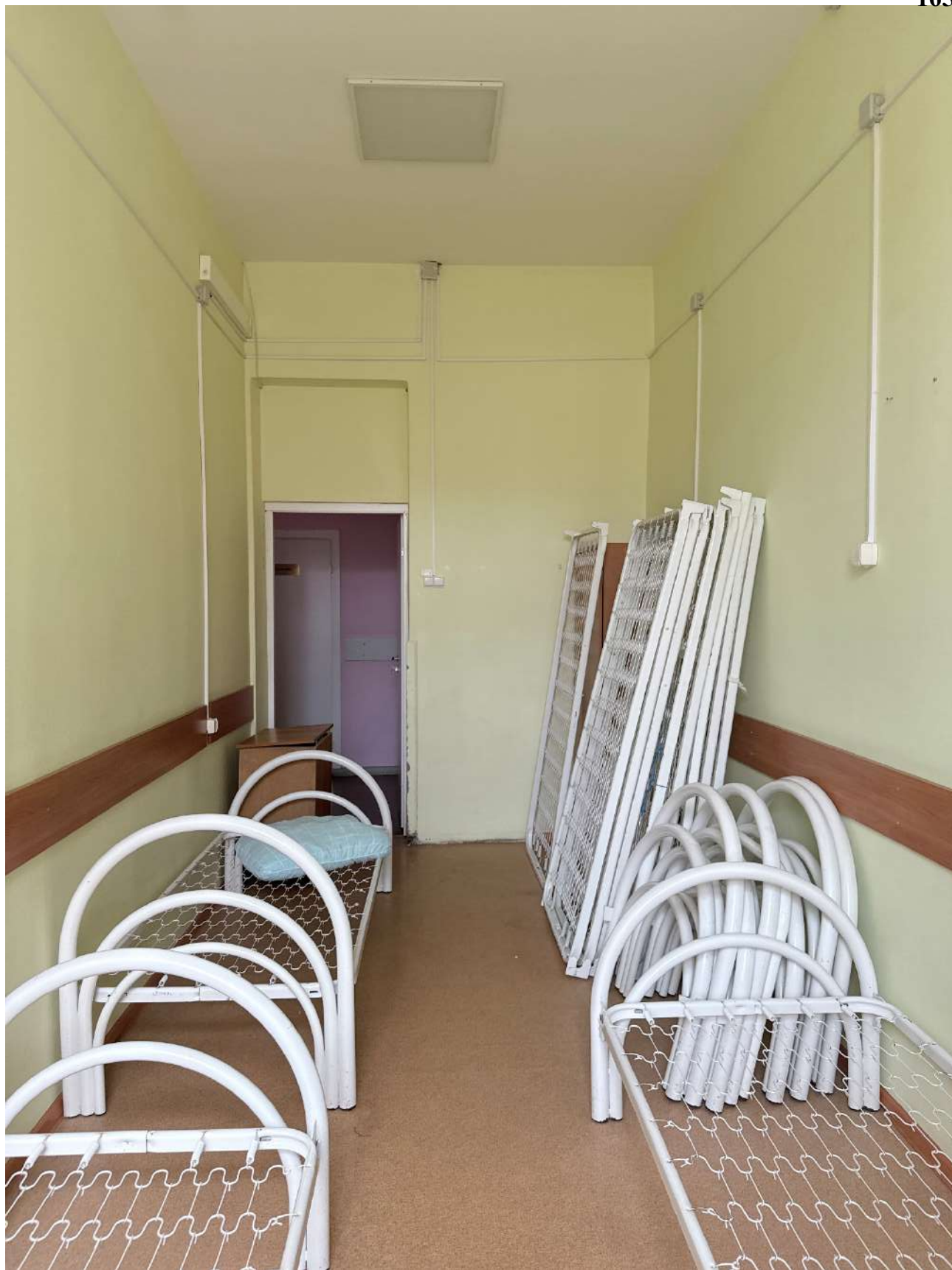
Фото 30. Общий вид на часть помещений в границе проектирования.
