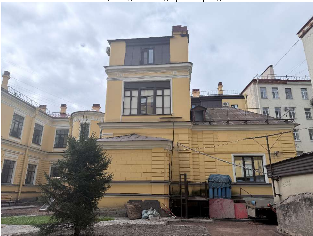
Фото 12. Общий вид на часть дворового фасада объекта.
