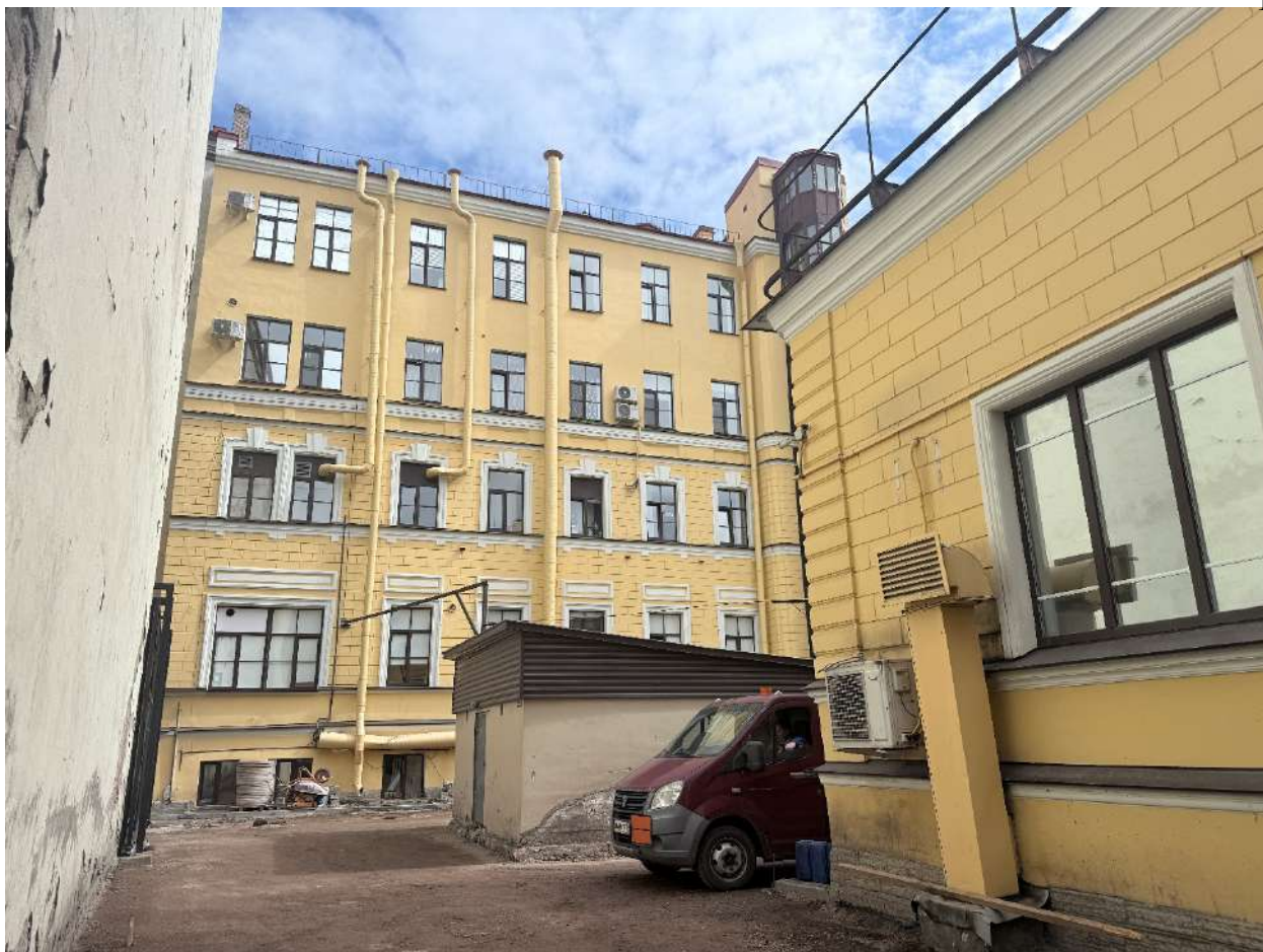
Фото 11. Общий вид на часть дворового фасада объекта.
