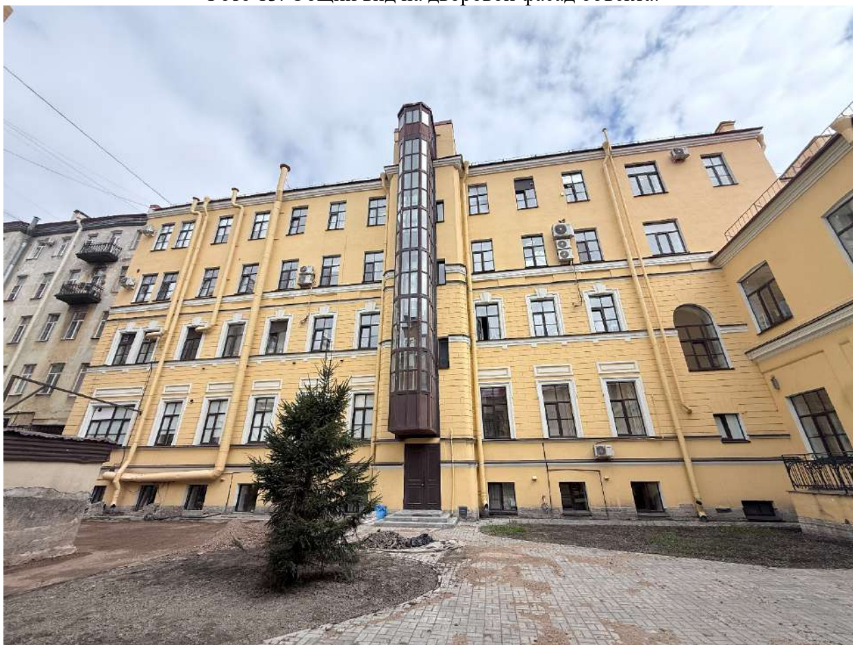
Фото 14. Общий вид на часть дворового фасада объекта.
