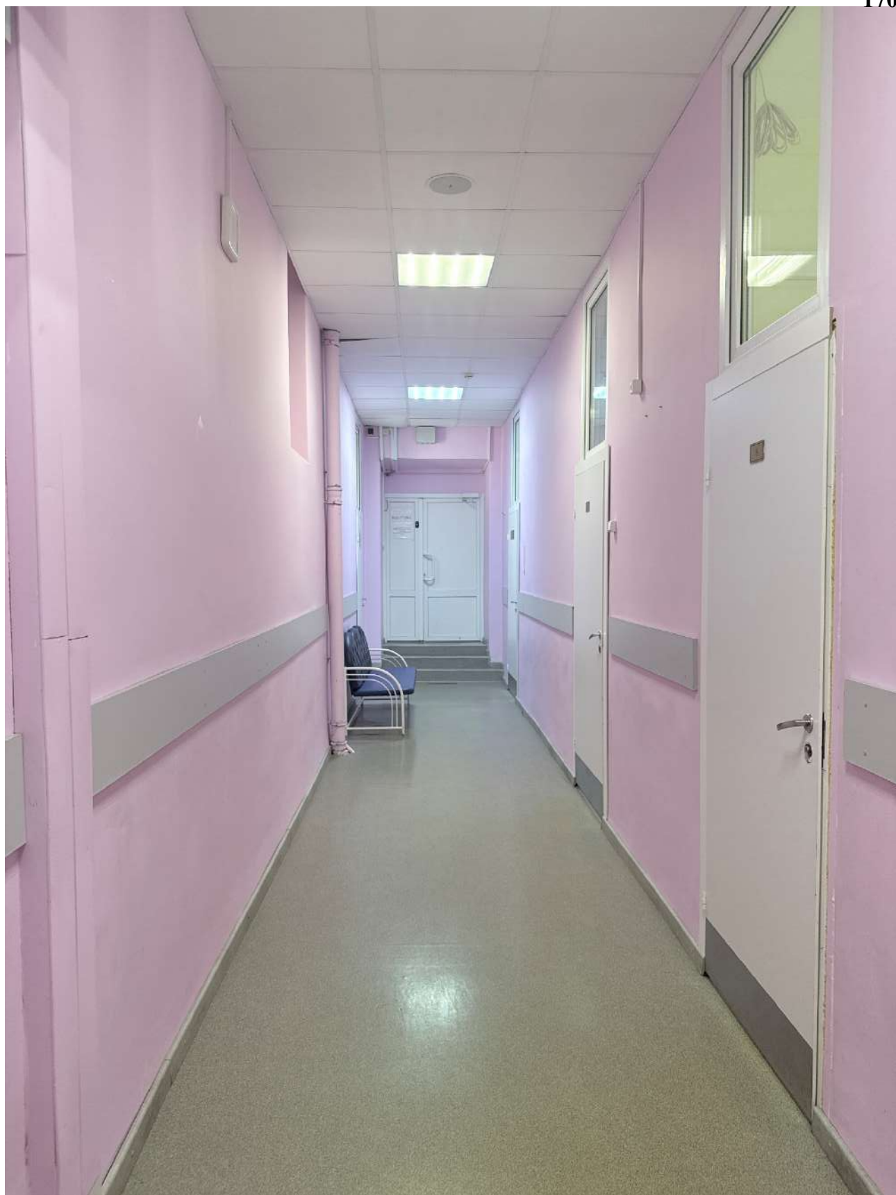
Фото 35. Общий вид на часть помещений в границе проектирования.
