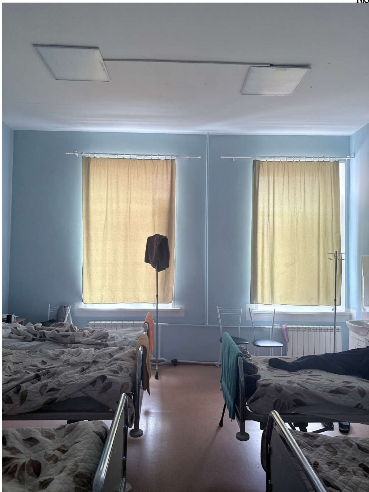
Фото 28. Общий вид на часть помещений в границе проектирования.
