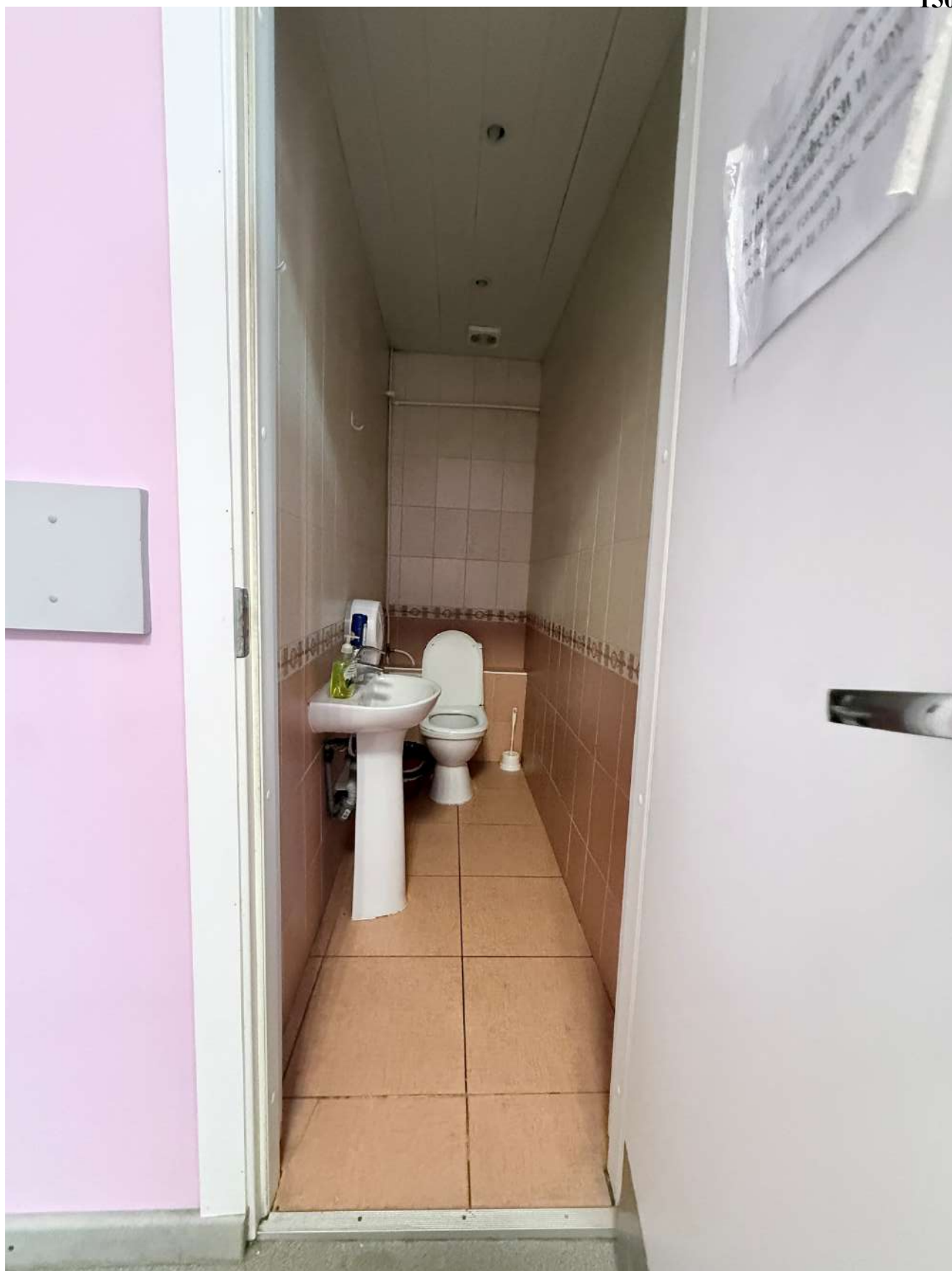
Фото 15. Общий вид на часть помещений в границе проектирования.
