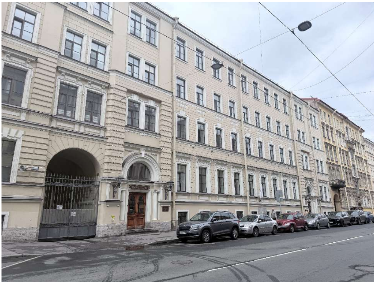
Фото 3. Общий вид на лицевой фасад объекта.
