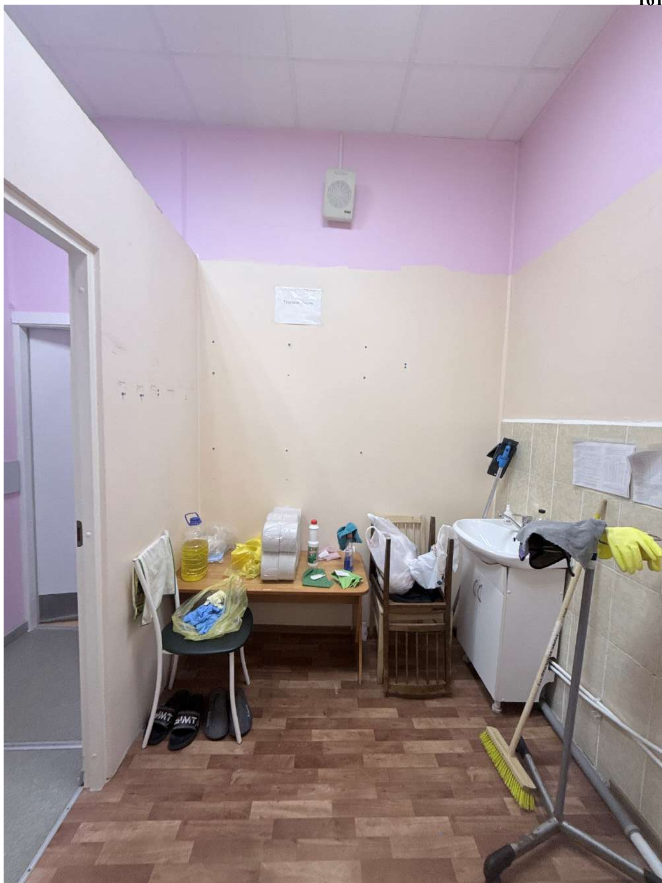
Фото 26. Общий вид на часть помещений в границе проектирования.
