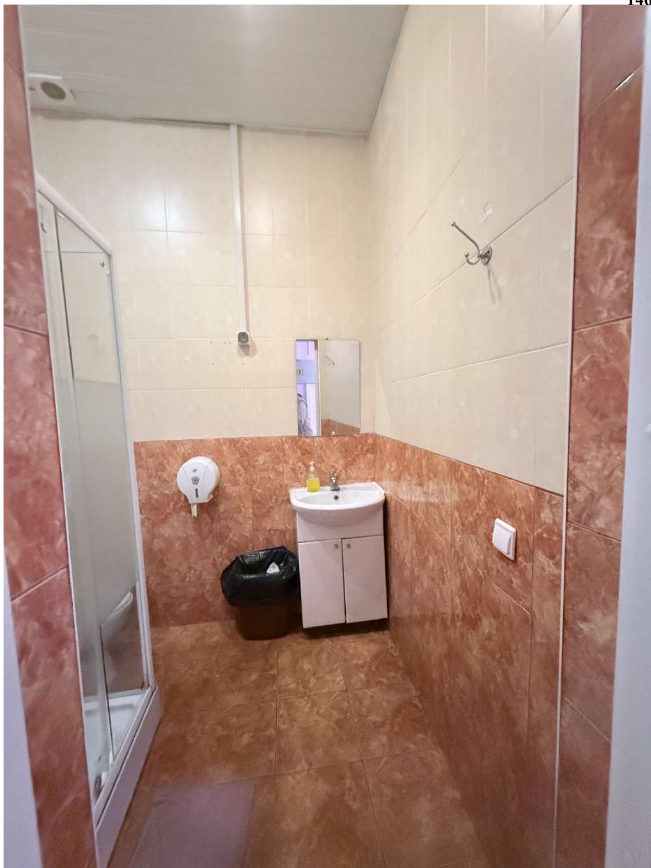
Фото 11. Общий вид на часть помещений в границе проектирования.
