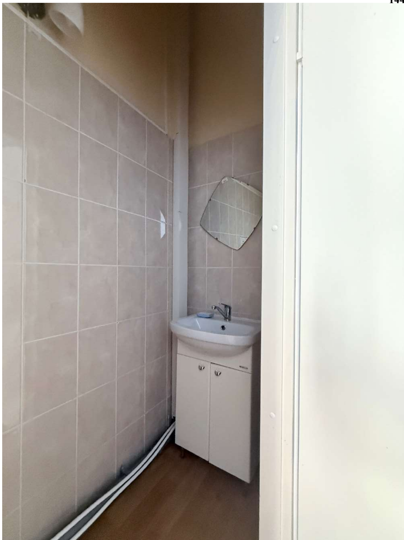
Фото 9. Общий вид на часть помещений в границе проектирования.
