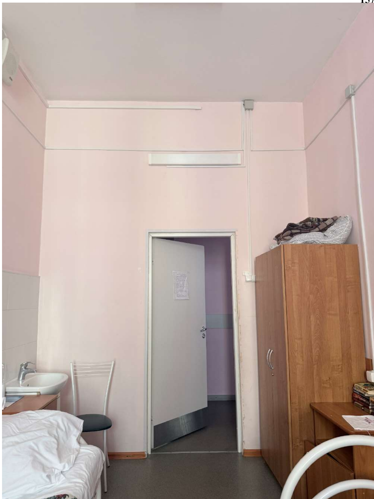
Фото 22. Общий вид на часть помещений в границе проектирования.
