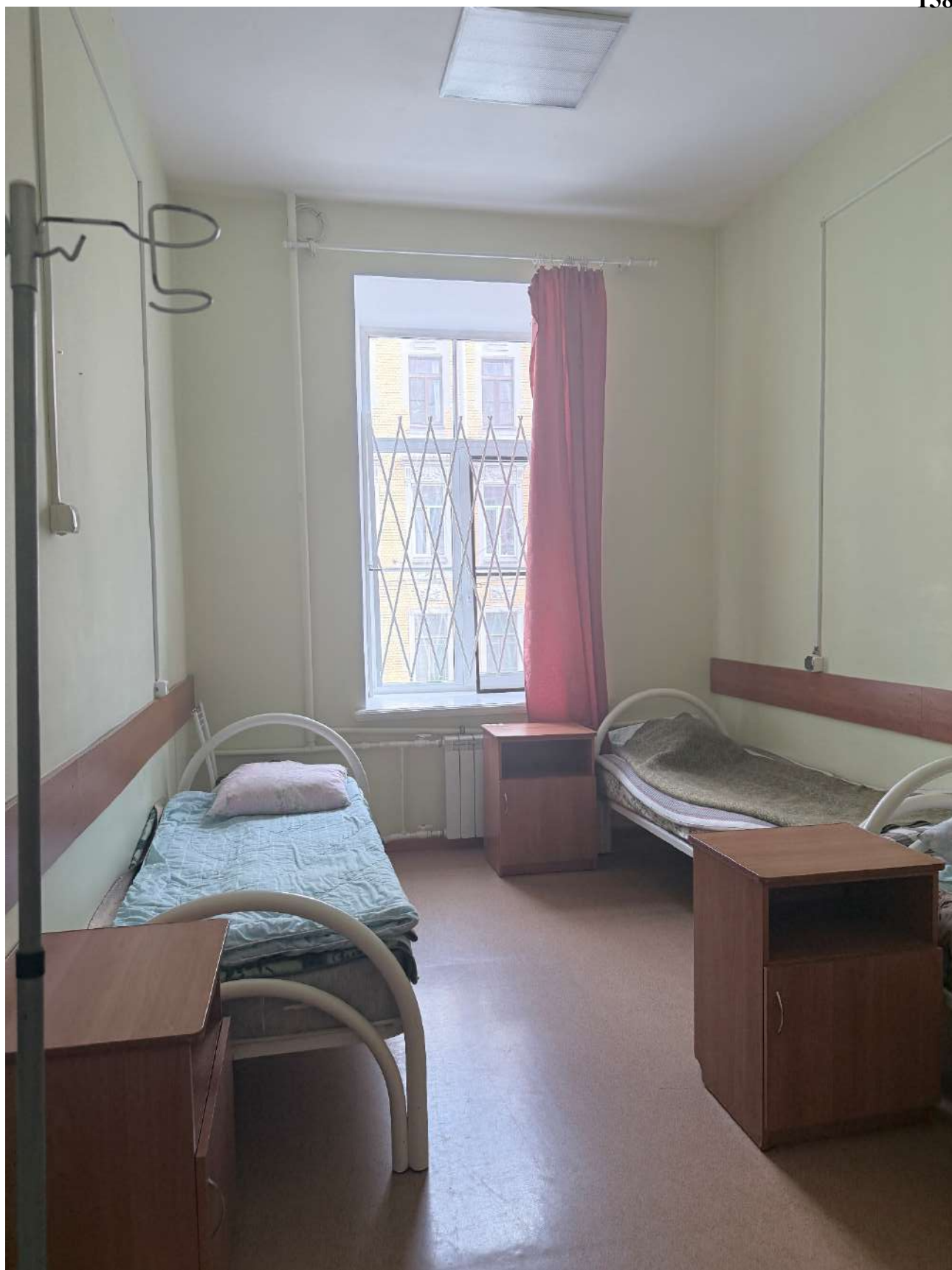
Фото 23. Общий вид на часть помещений в границе проектирования.
