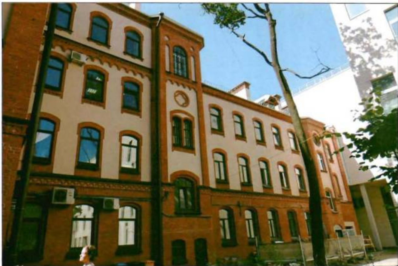
2. Дворовый фасад. Фрагмент.
