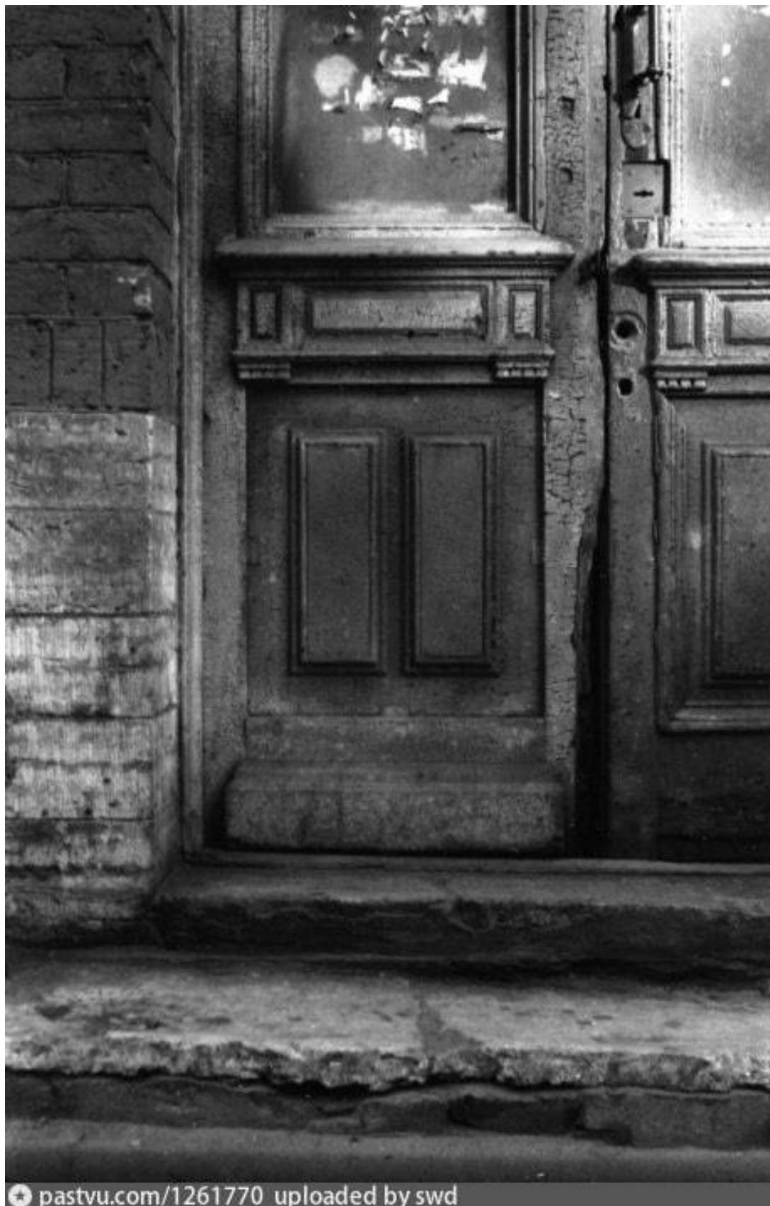
6. 1999 г. Дверное заполнение со стороны ул. Лизы Чайкиной.
