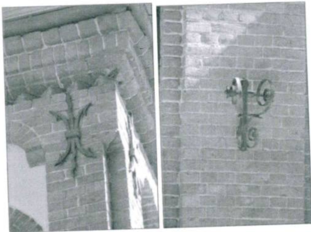
3-4. Главный фасад. Фрагмент. Металлодекор.
