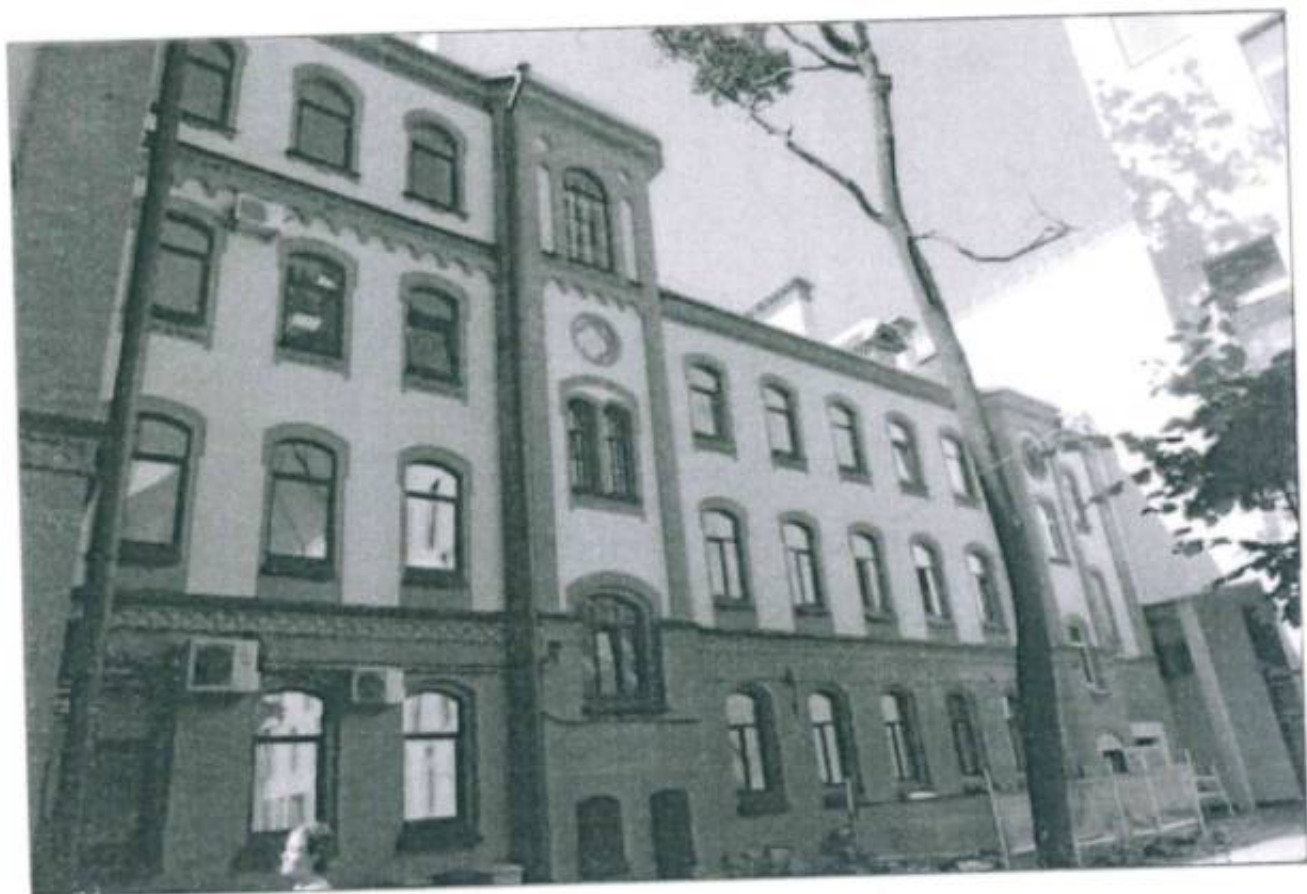
2. Дворовый фасад. Фрагмент.
