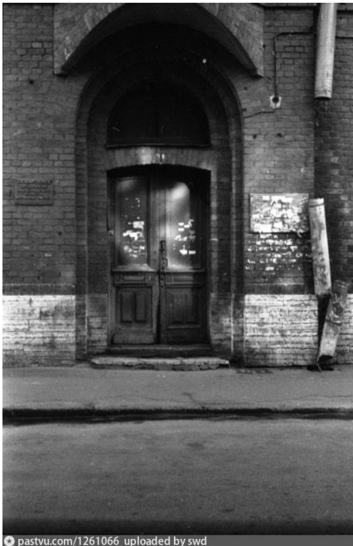
5. 1999 г. Дверное заполнение со стороны ул. Лизы Чайкиной.
