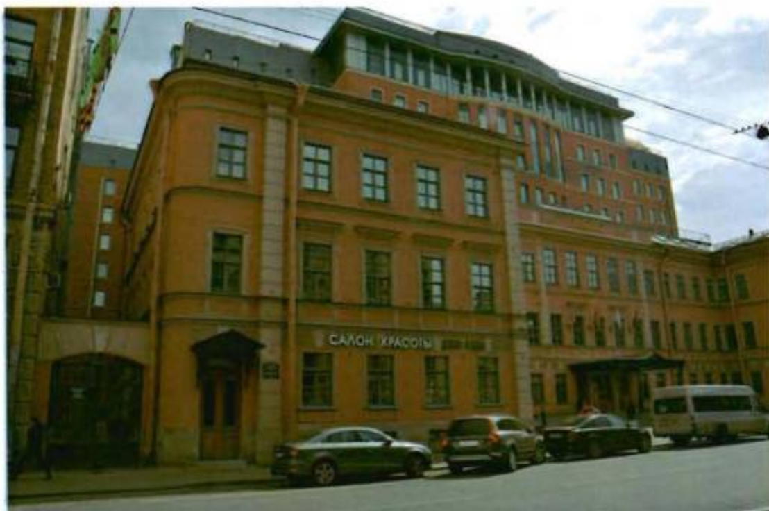
2. Северо-восточный флигель. Вид с севера.
