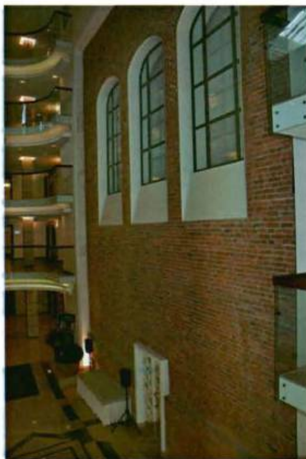
4. Западная стена дворового флигеля (находится внутри современного интерьера).
