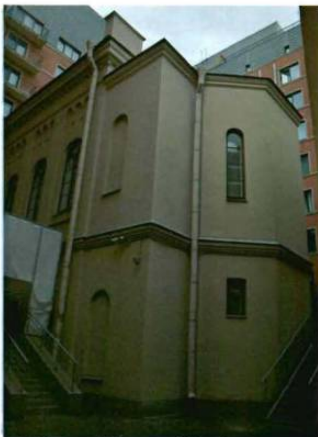
3. Дворовый флигель. Общий вид с юга.
