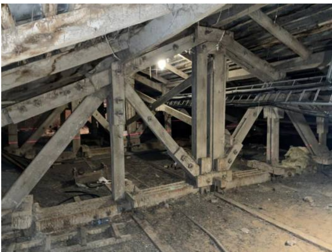
Фото 16. Общий вид стропильной системы крыши.
