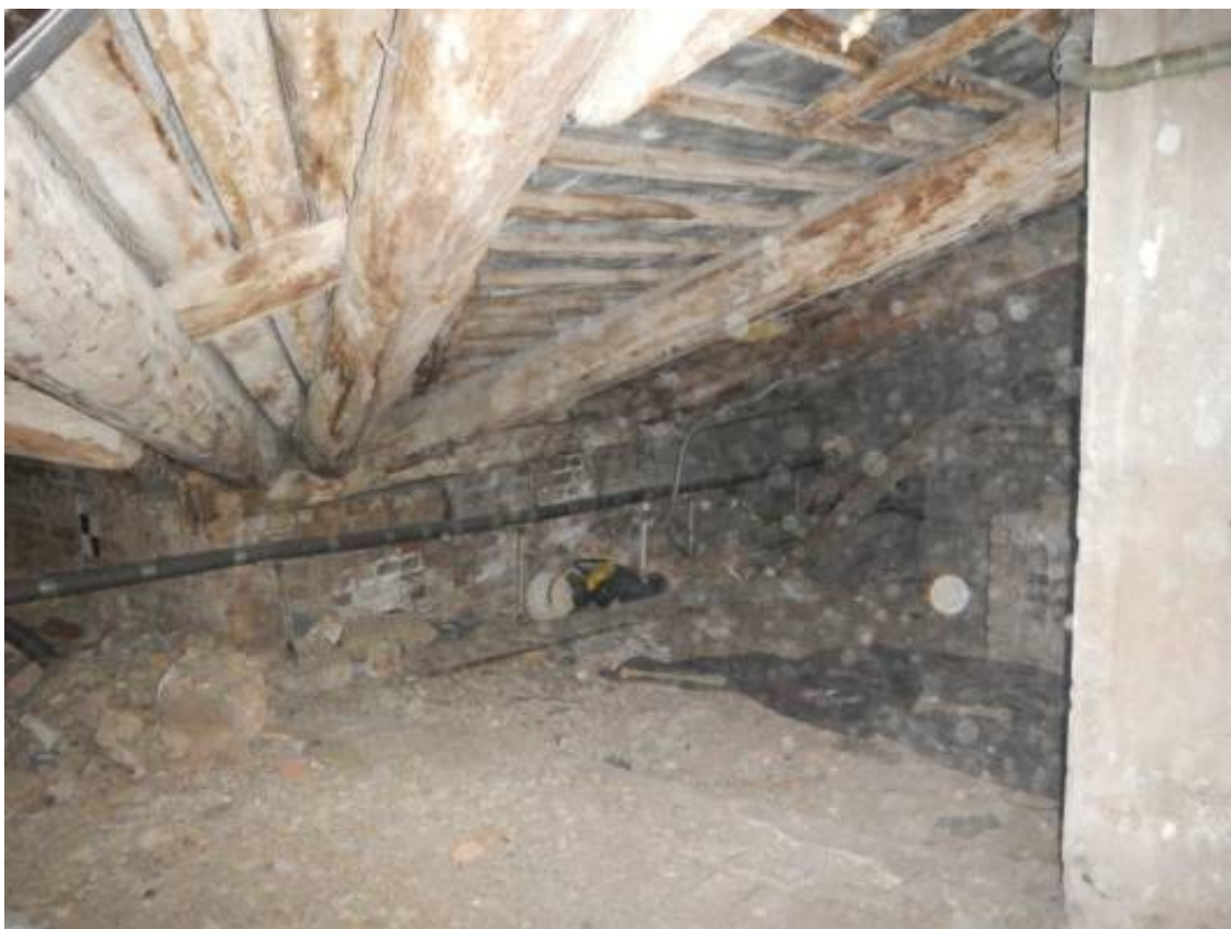
Фото 18. Устройство ендовы крыши.
