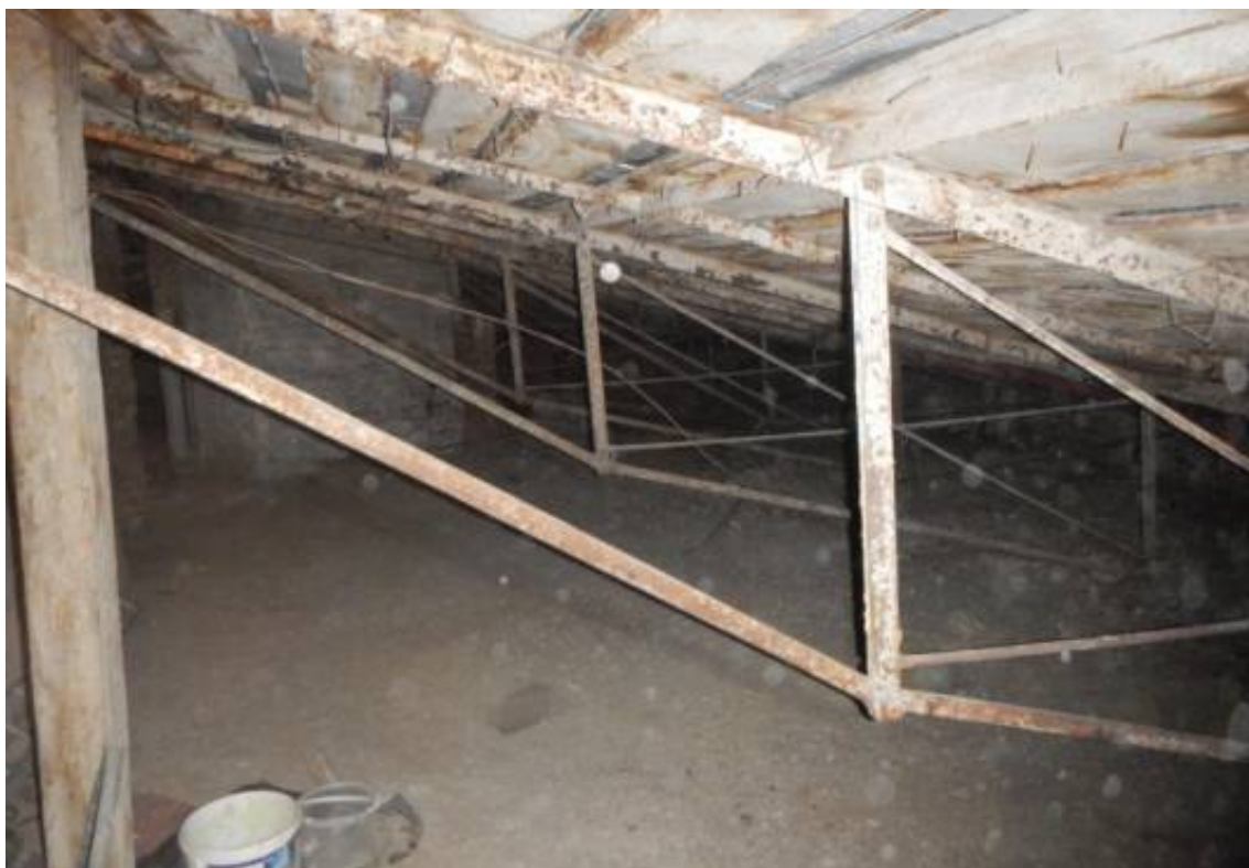
Фото 1. Общий вид стропильных конструкции крыши.
