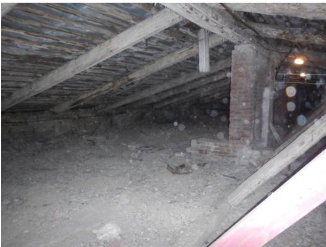
Фото 12. Общий вид чердачного помещения
