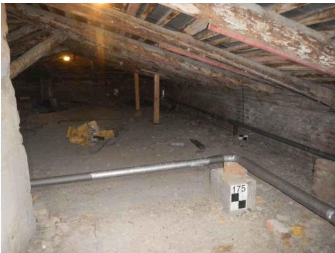
Фото 8. Общий вид чердачного помещения.
