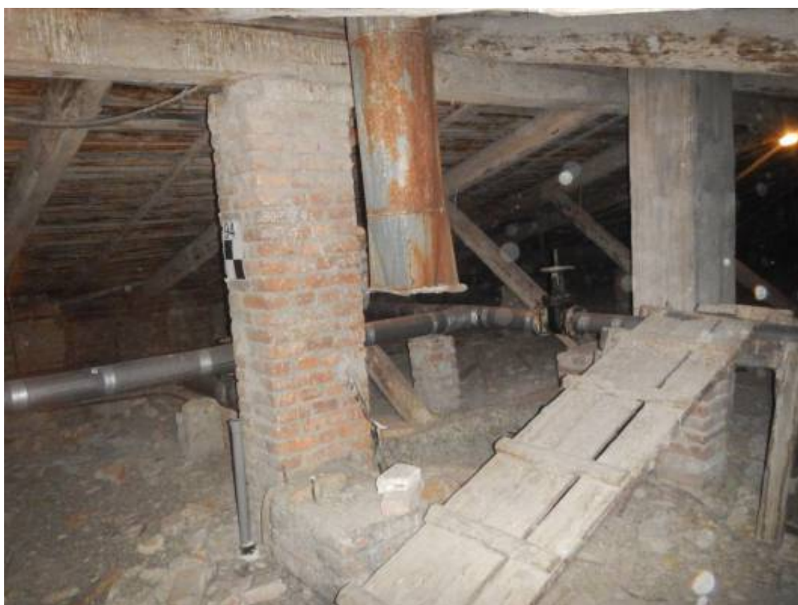
Фото 4. Общий вид чердачного помещения в осях «10-11//И/12-К/12».
