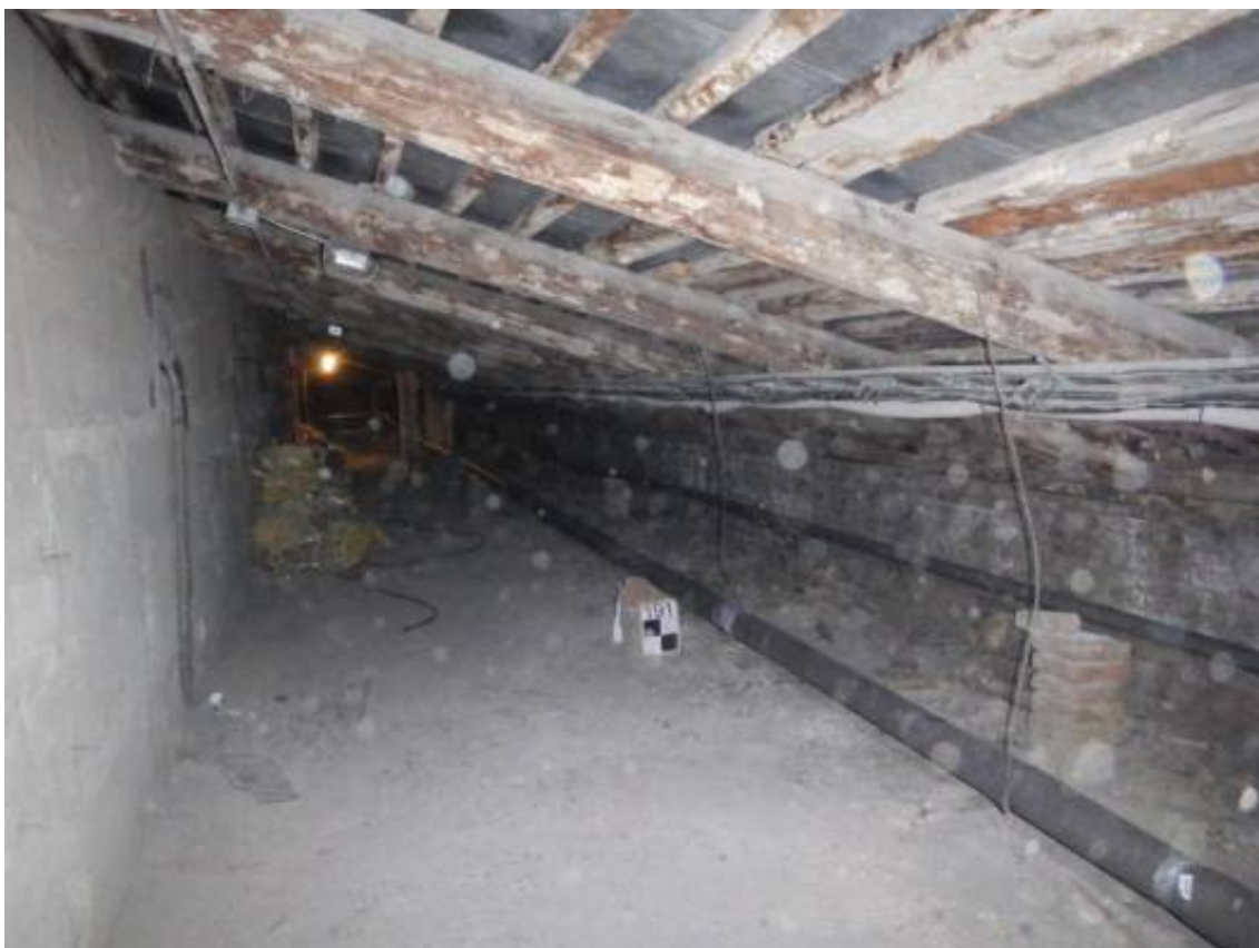
Фото 7. Общий вид чердачного помещения.
