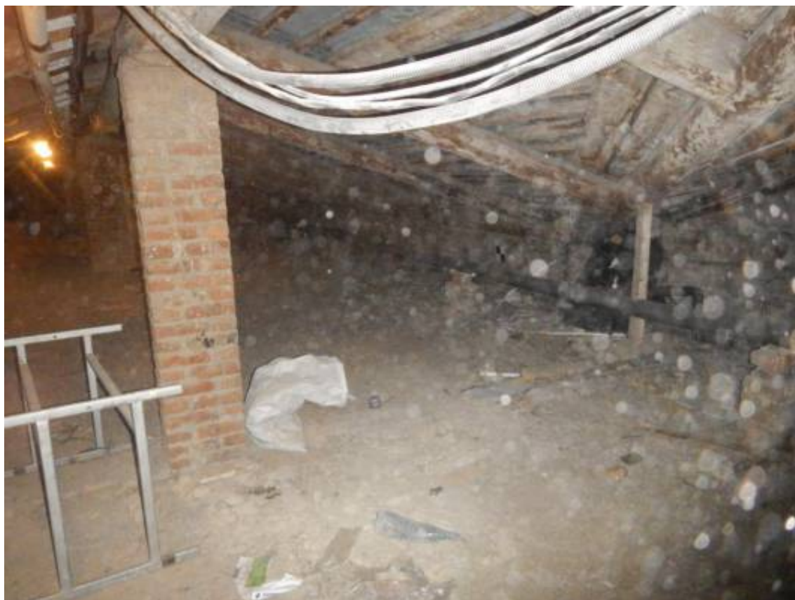
Фото 20. Фрагмент чердачного помещения.
