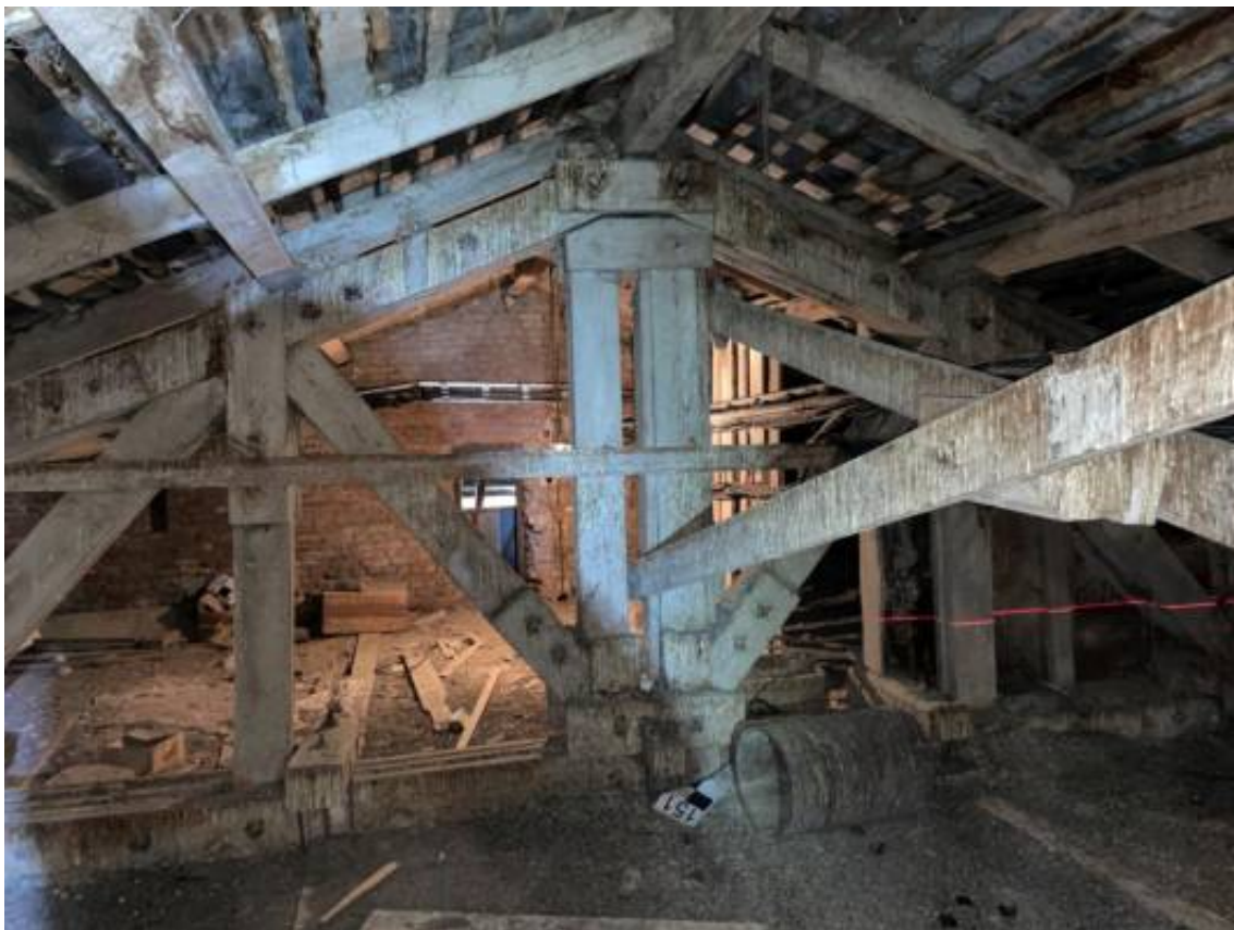
Фото 17. Общий вид стропильной системы крыши.
