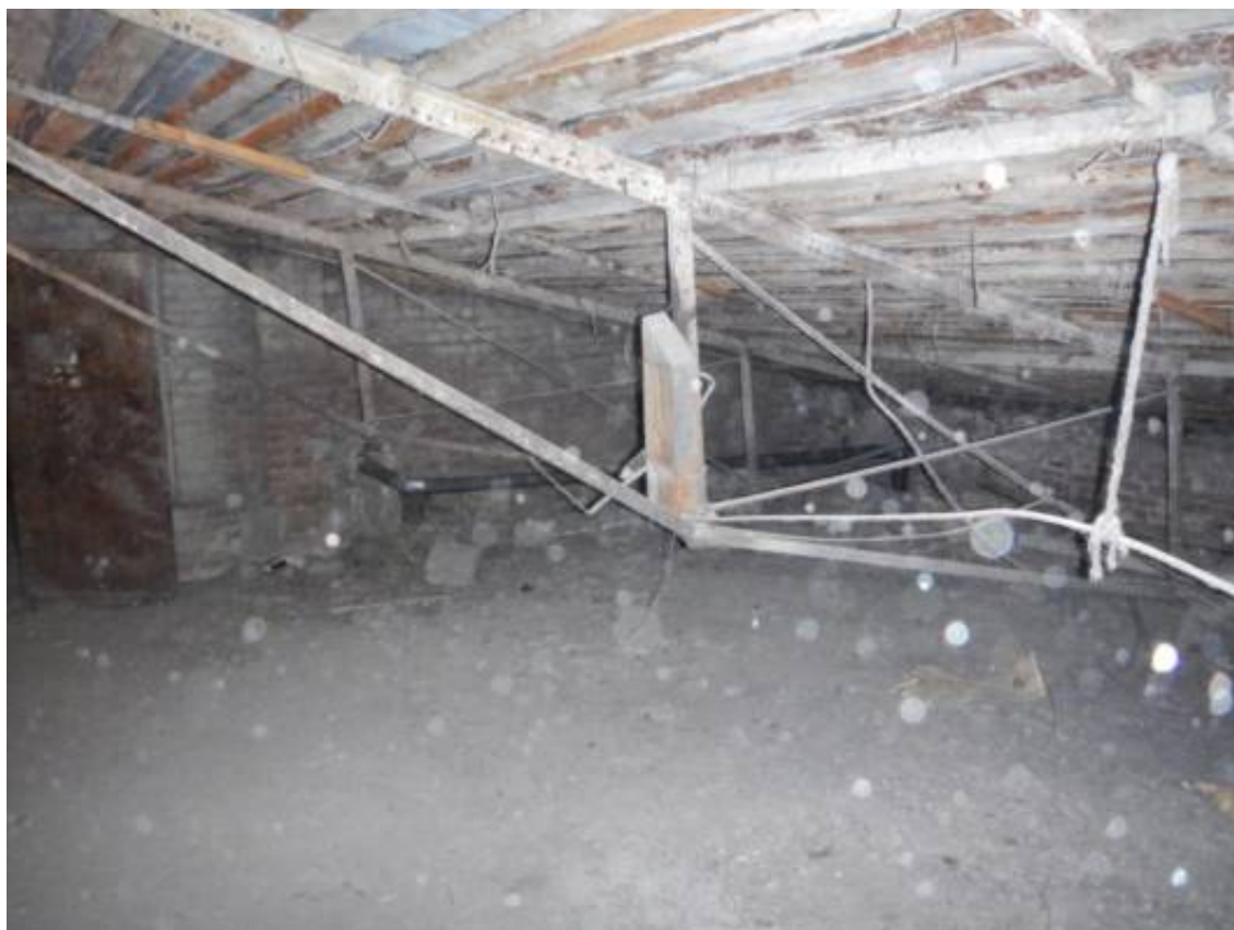
Фото 3. Общий вид стропильных конструкции крыши.
