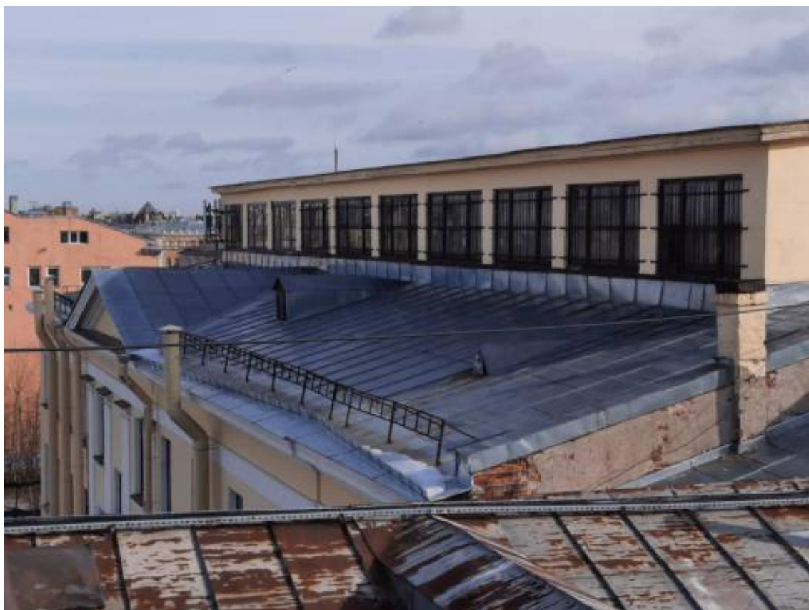
Фото 8. Общий вид кровли.
