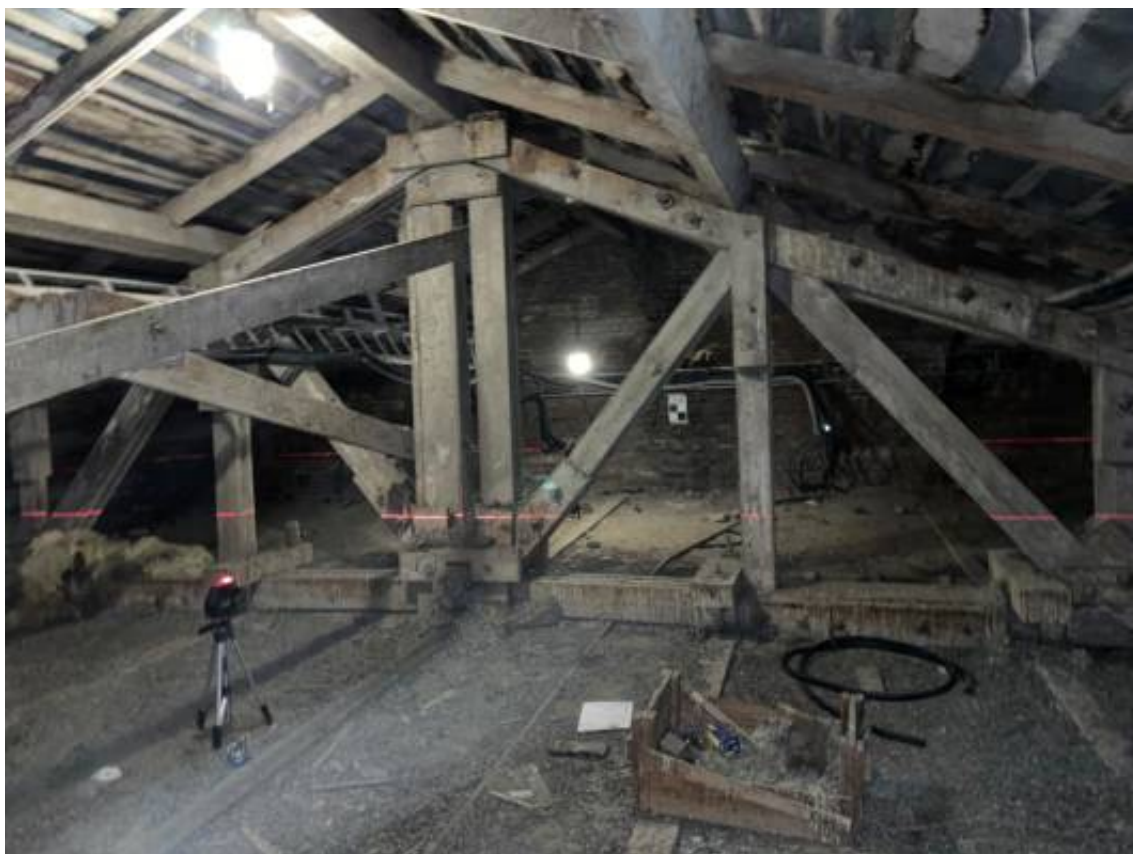
Фото 15. Общий вид стропильной системы крыши.
