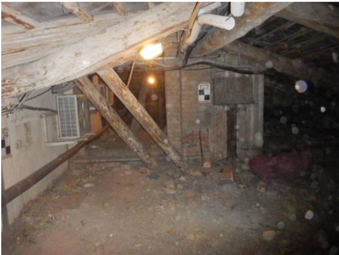
Фото 19. Устройство подкосов стропильной системы.
