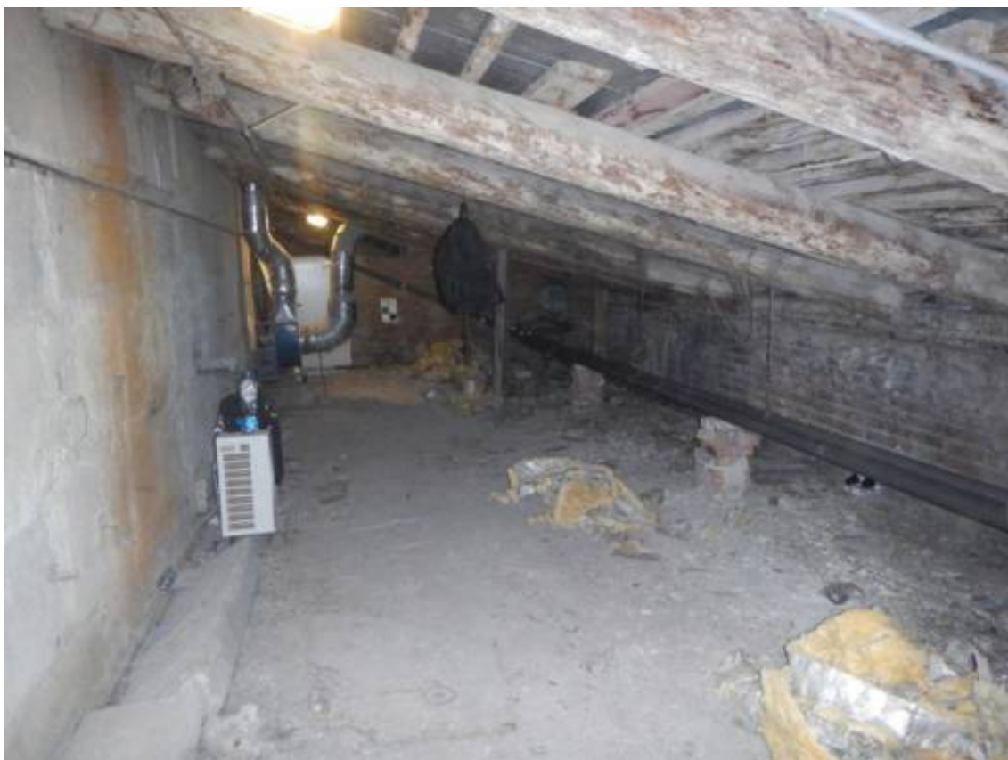
Фото 10. Общий вид чердачного помещения.
