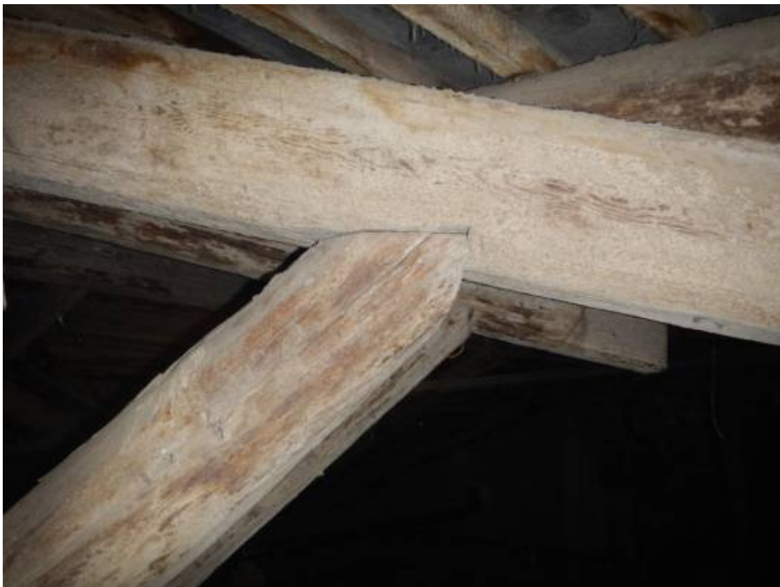
Фото 5. Общий вид сопряжения подкоса и стропильной ноги.
