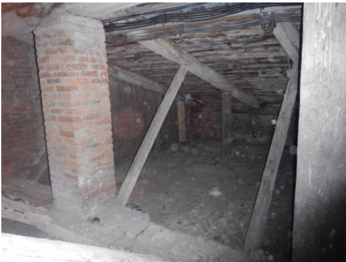
Фото 11. Общий вид стропильной системы крыши
