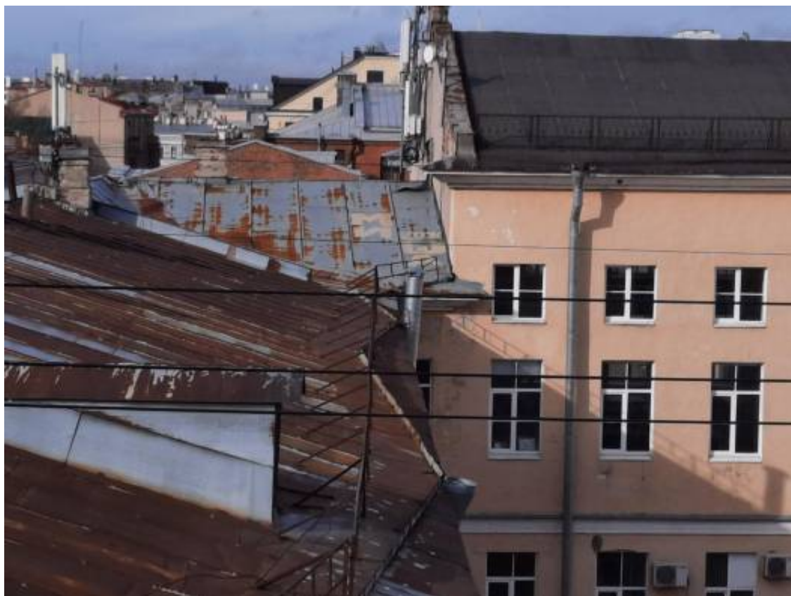
Фото 4. Общий вид кровли.
