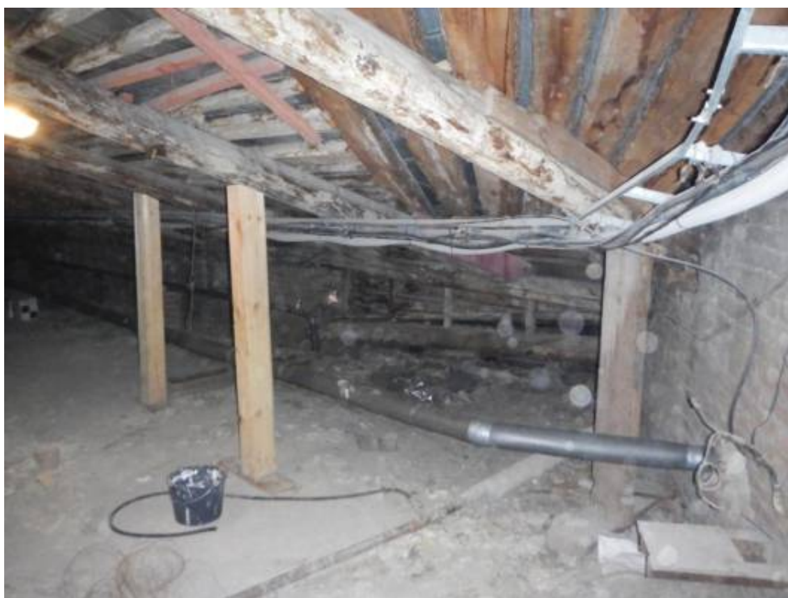
Фото 6. Общий вид чердачного помещения
