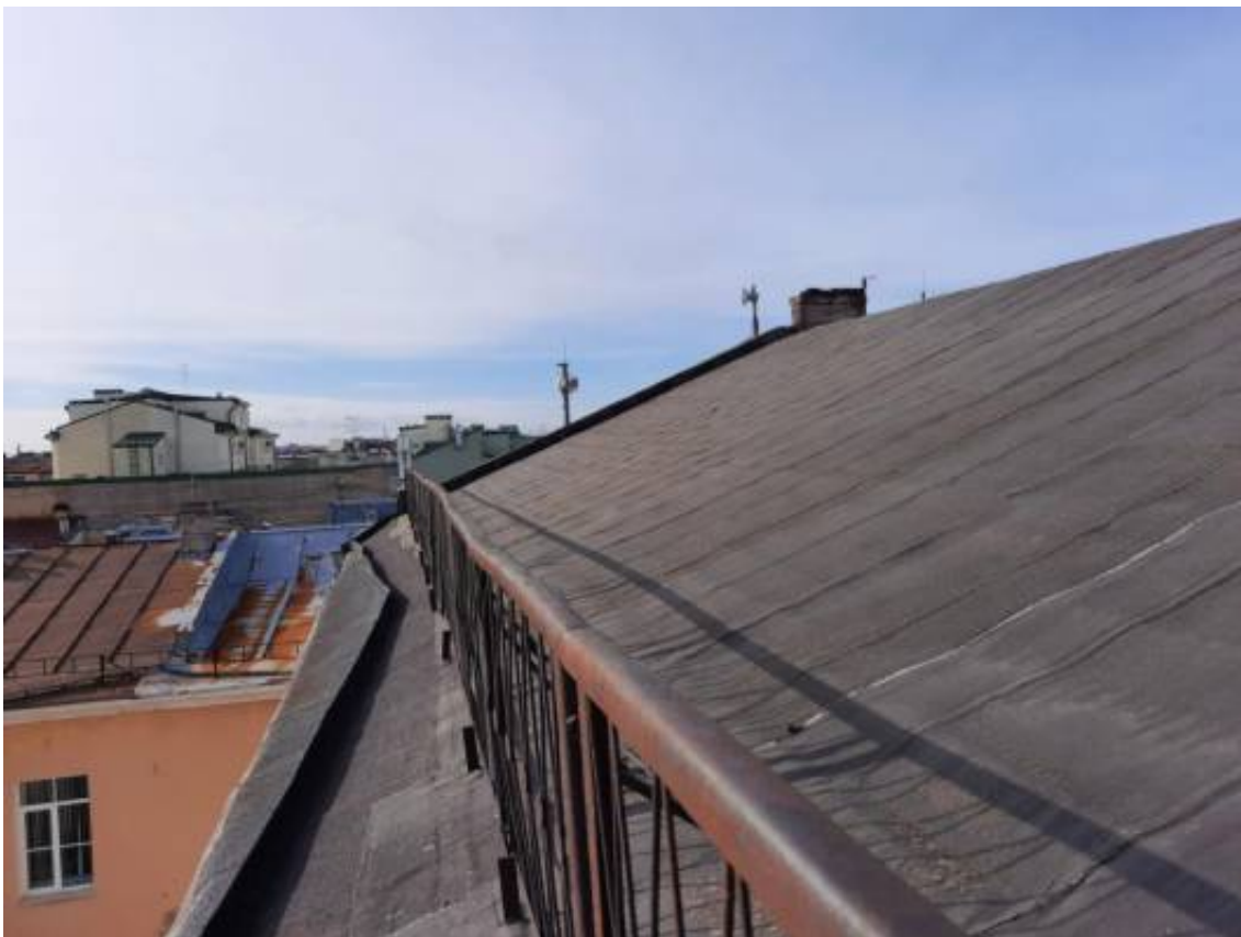
Фото 3. Общий вид кровли.
