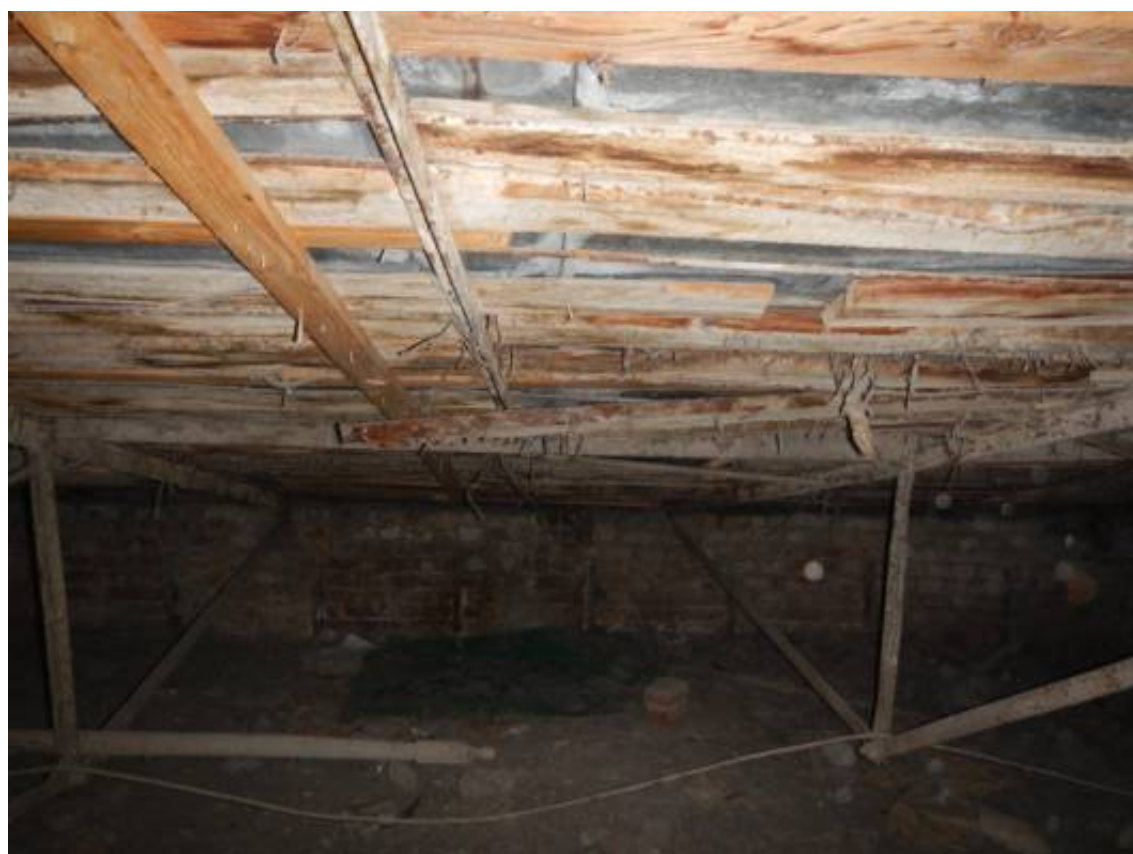
Фото 2. Общий вид стропильных конструкции крыши.
