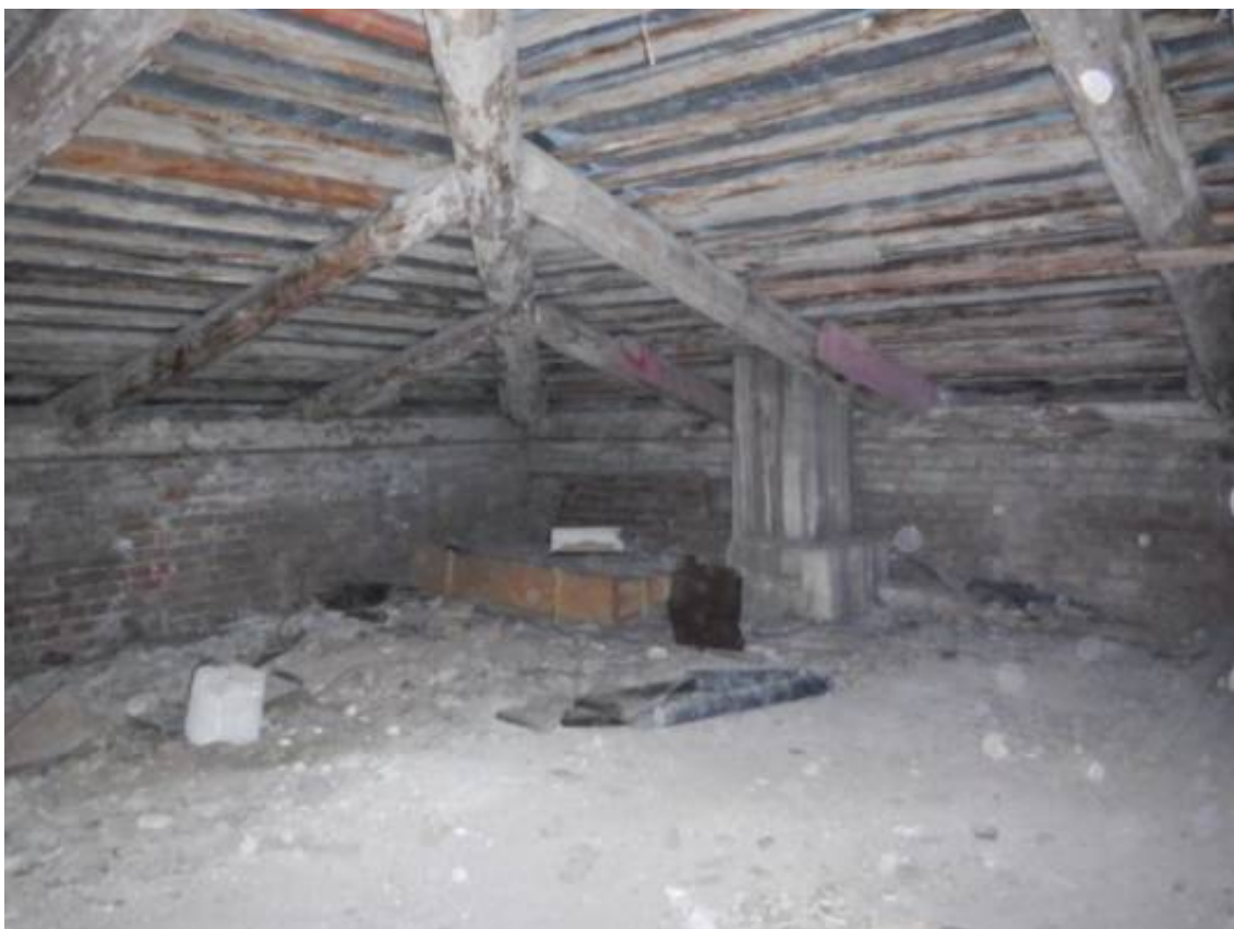
Фото 9. Общий вид чердачного помещения.
