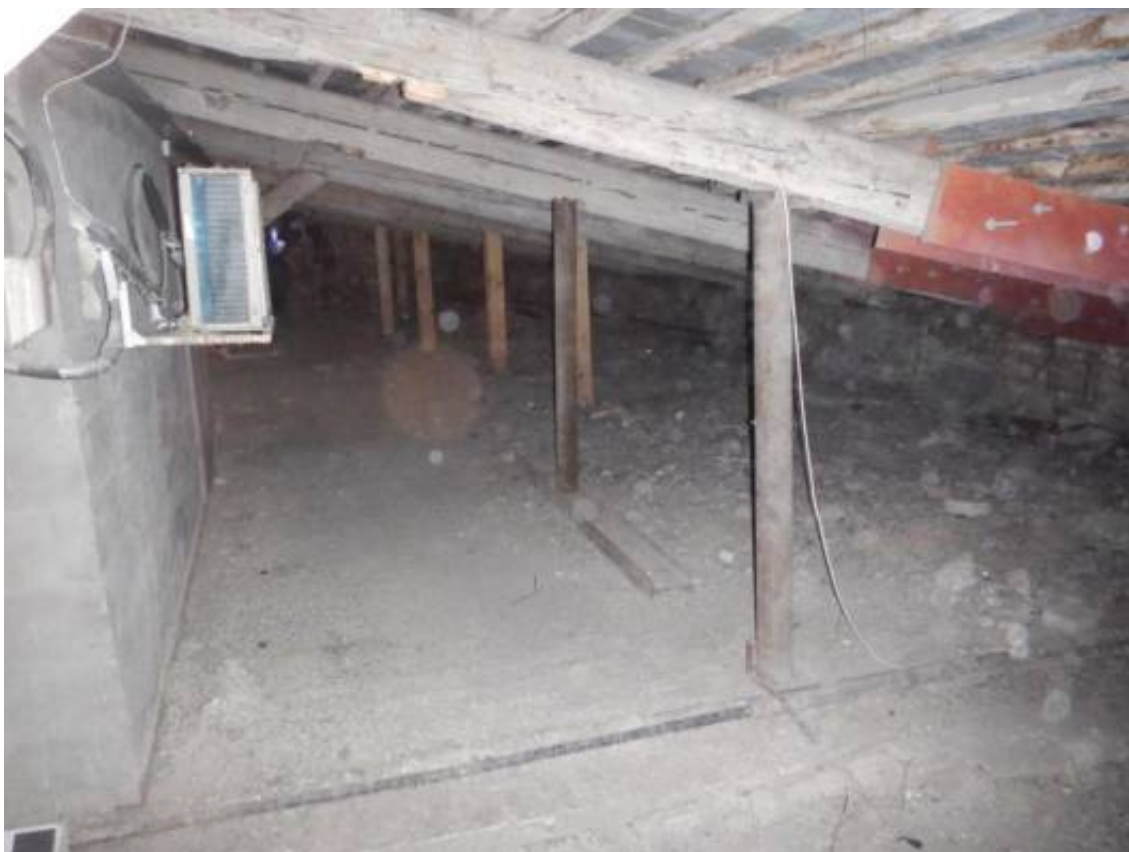
Фото 13. Общий вид стропильной системы крыши
