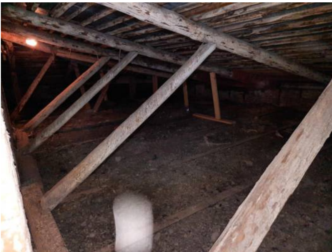
Фото 14. Общий вид стропильной системы крыши.
