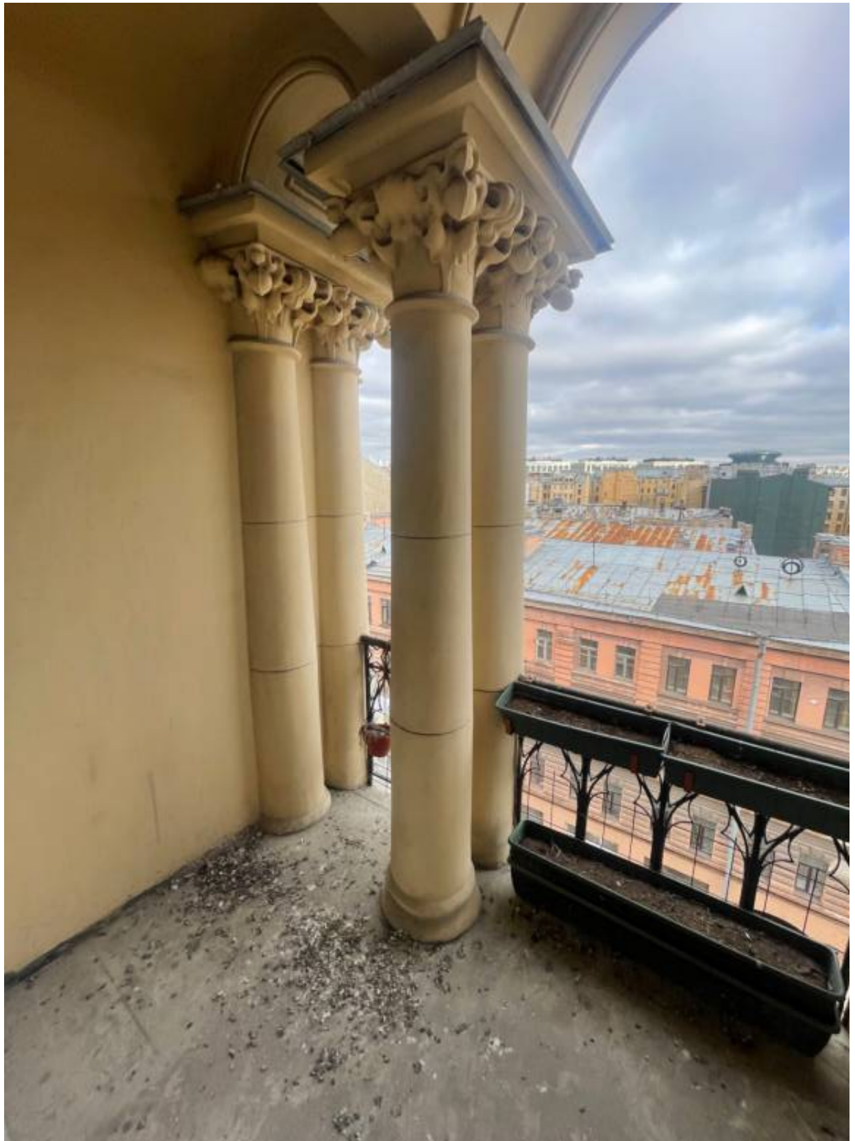
7. Терраса со стороны лицевого фасада.
