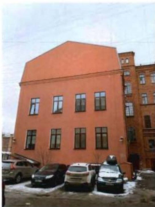
4, 5. Вид на юго-восточный и северо-западный фасады.
