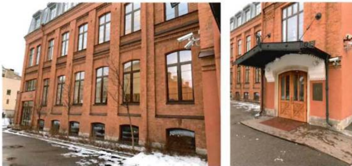
6, 7. Фрагмент. Юго-западный фасад. Главный вход.
