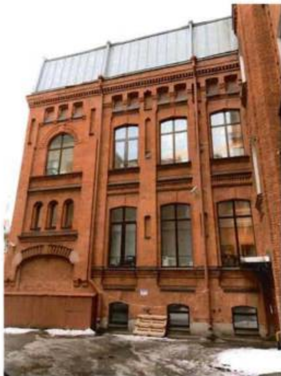
2, 3. Вид на северо-восточные фасады.
