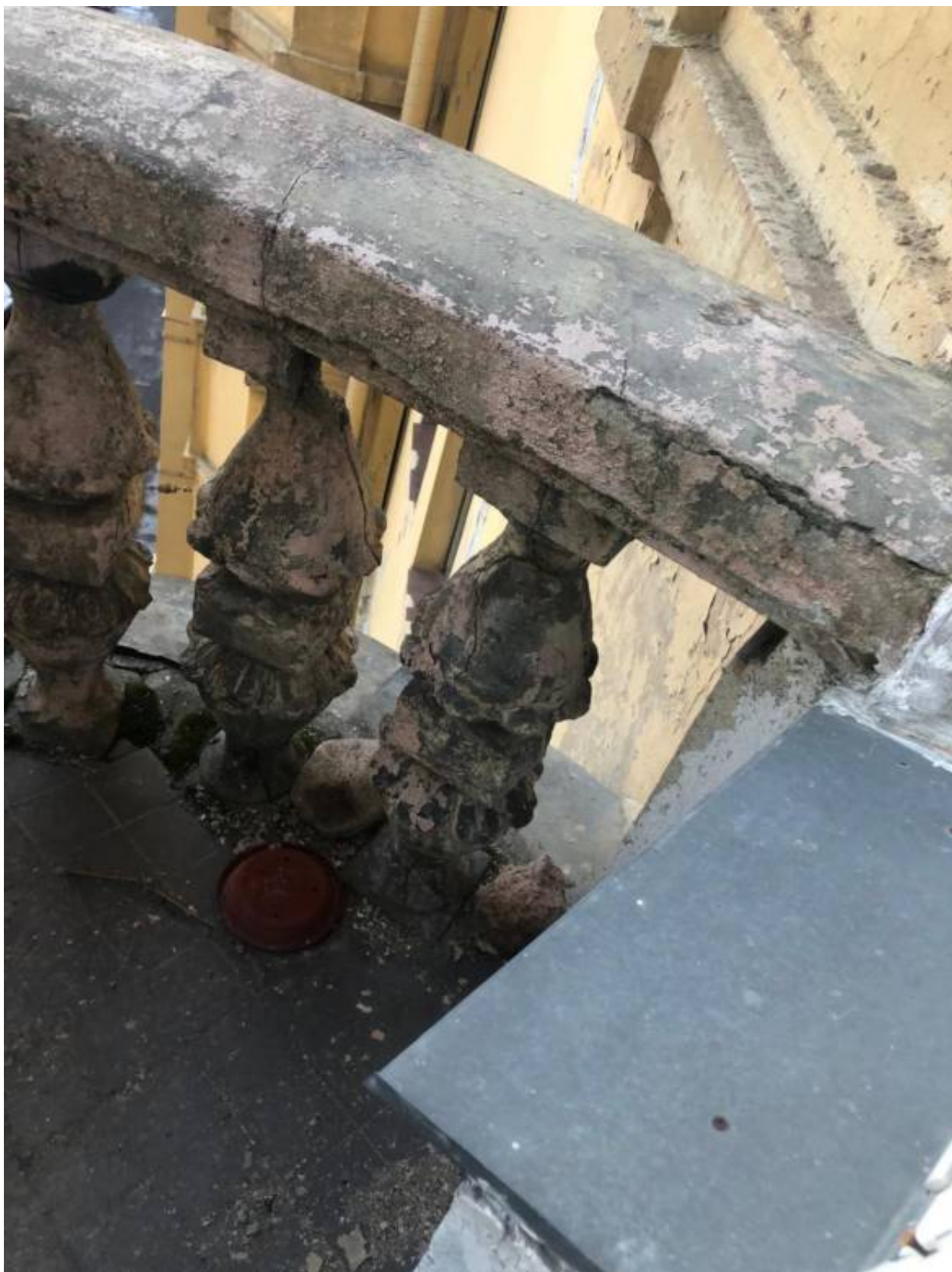
23.Балкон со стороны двора.
