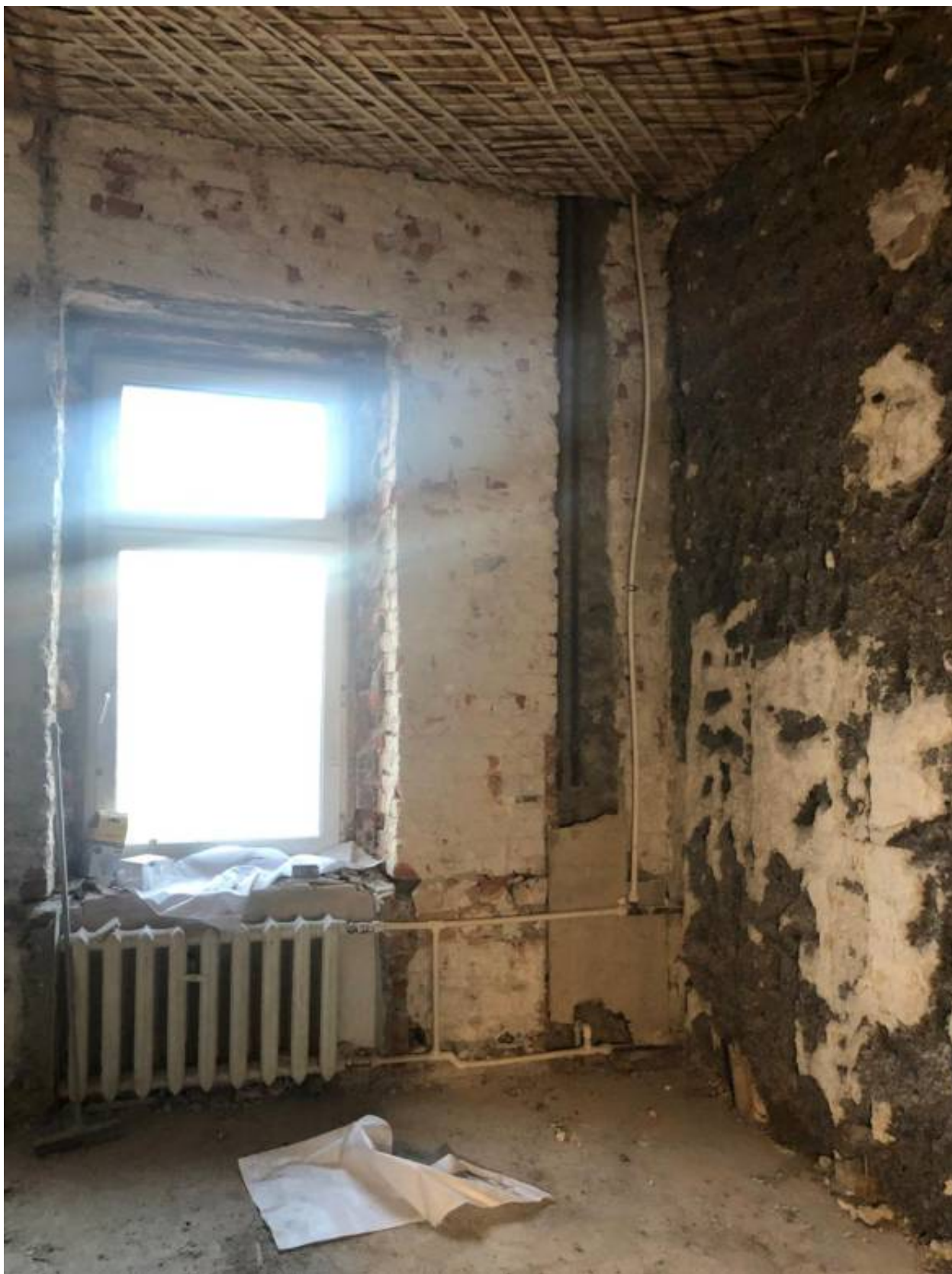
20. Помещение 6 (согласно техническому паспорту).
