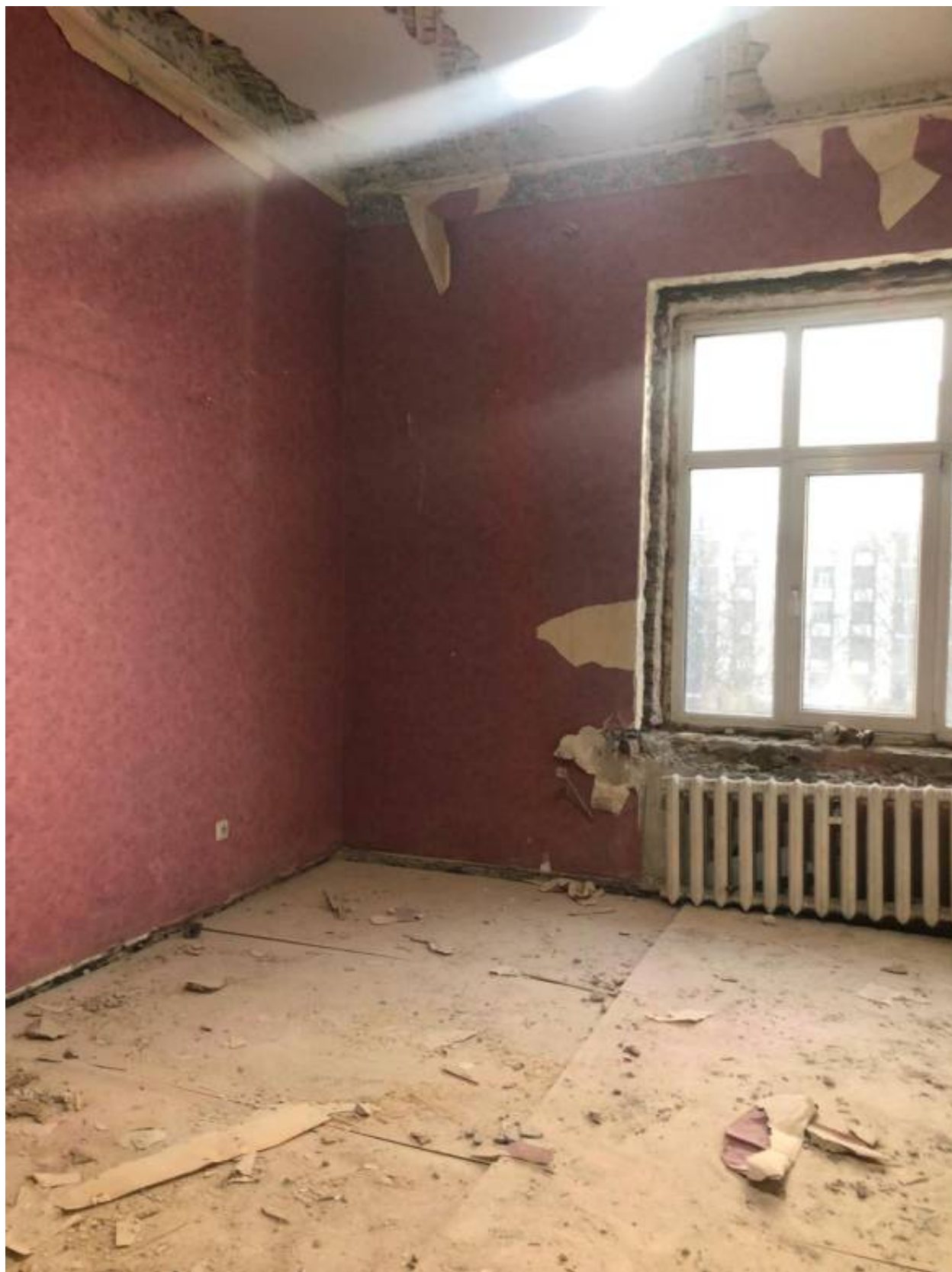
14. Помещение 3 (согласно техническому паспорту).
