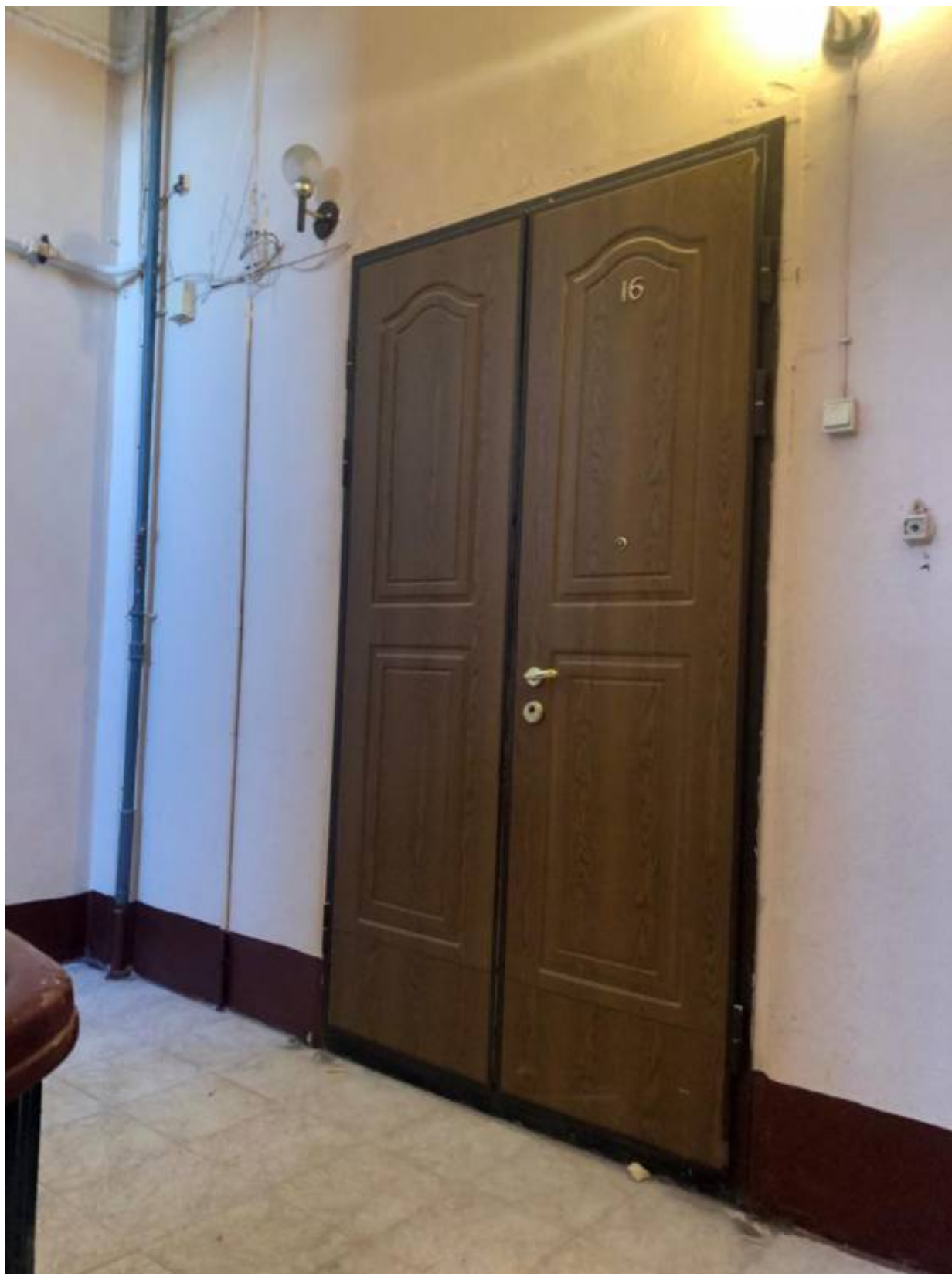
4. Входная дверь в квартиру №16.
