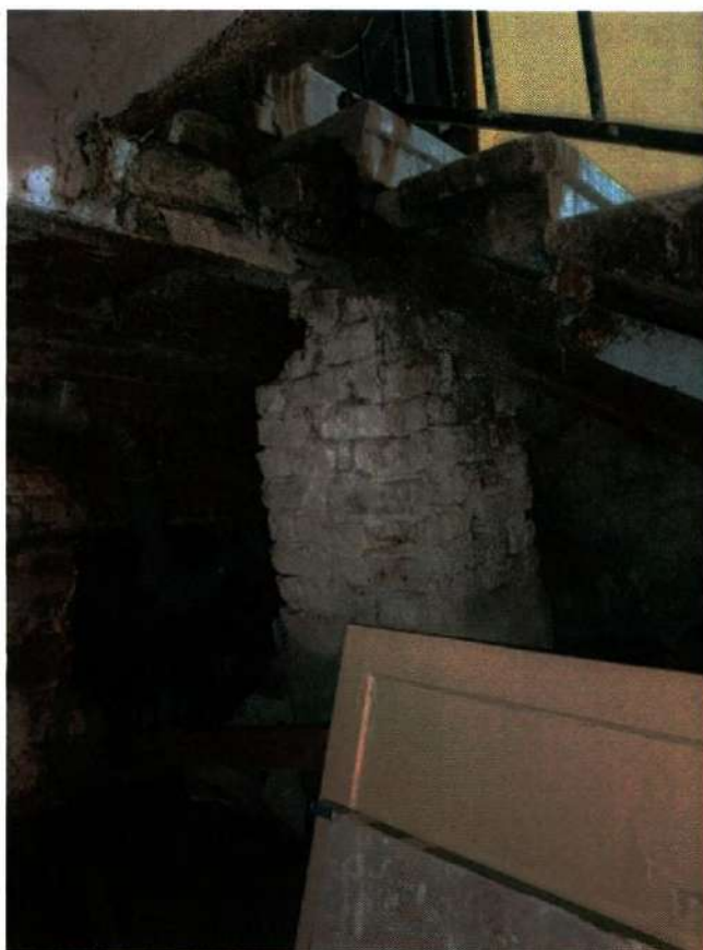
Фото 51. Лестничная клетка 19ЛК (дата съемки 13.03.2025).
