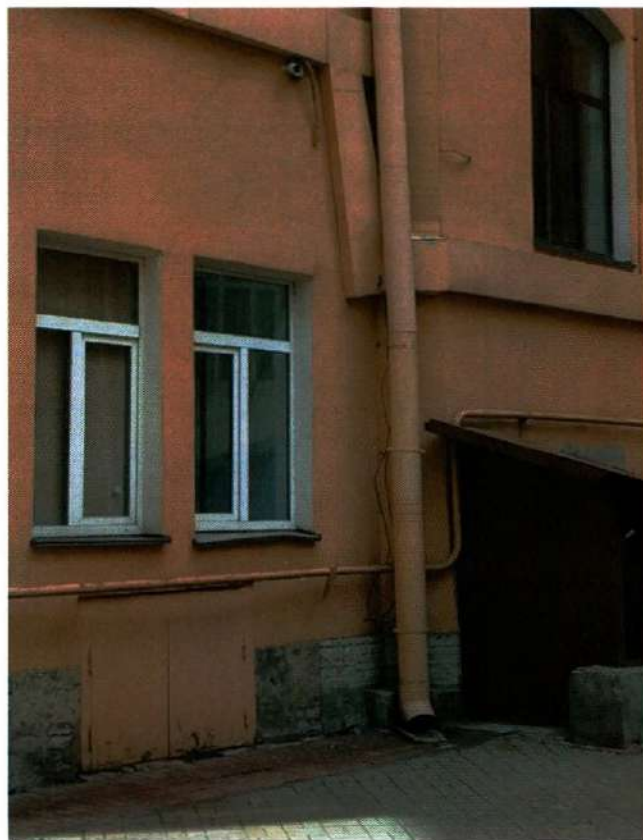
Фото 15. Фрагмент южного фасада западного внутреннего двора (дата съемки 27.03.2025).
