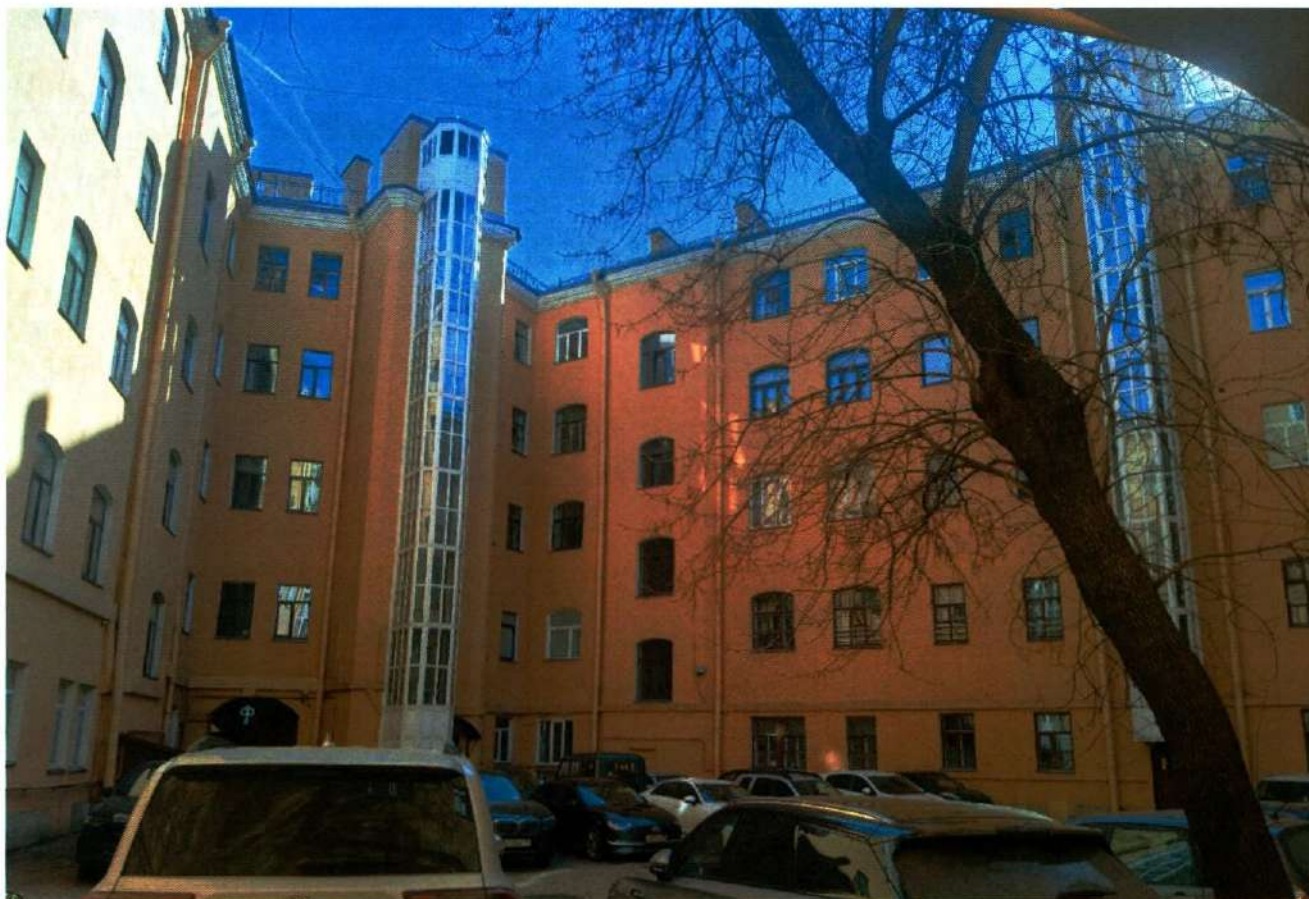
Фото 6. Вид на западный и северный фасады западного внутреннего двора объекта культурного наследия (дата съемки 27.03.2025).
