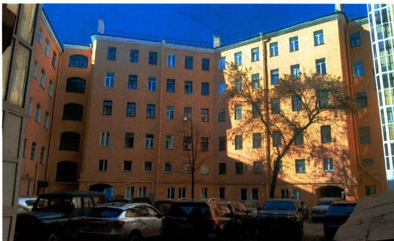
Фото 7. Восточный фасад западного внутреннего двора объекта культурного наследия (дата съемки 27.03.2025).
