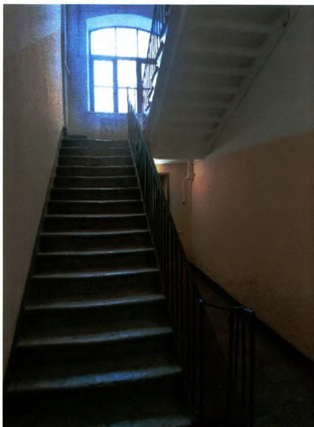
Фото 45. Лестничная клетка 12ЛК (дата съемки 27.03.2025).
