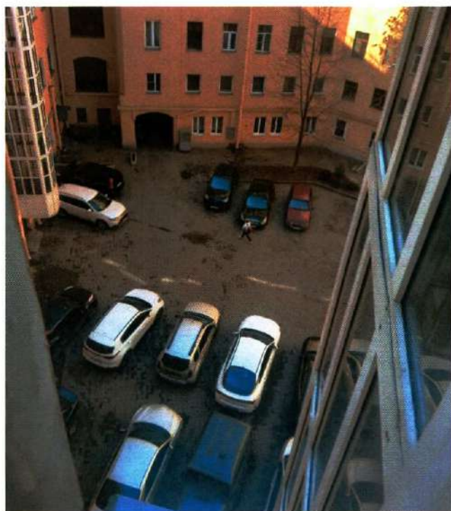
Фото 56. Фрагмент северной части территории западного внутреннего двора объекта культурного наследия (дата съемки 20.05.2025).
