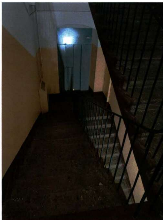
Фото 17. Лестничная клетка 19ЛК объекта культурного наследия (дата съемки 27.03.2025).
