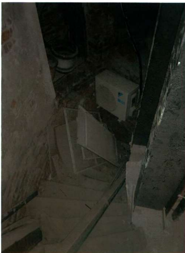
Фото 37. Общий вид помещения 34-Н (ч.п. 1) (дата съемки 27.03.2025).
