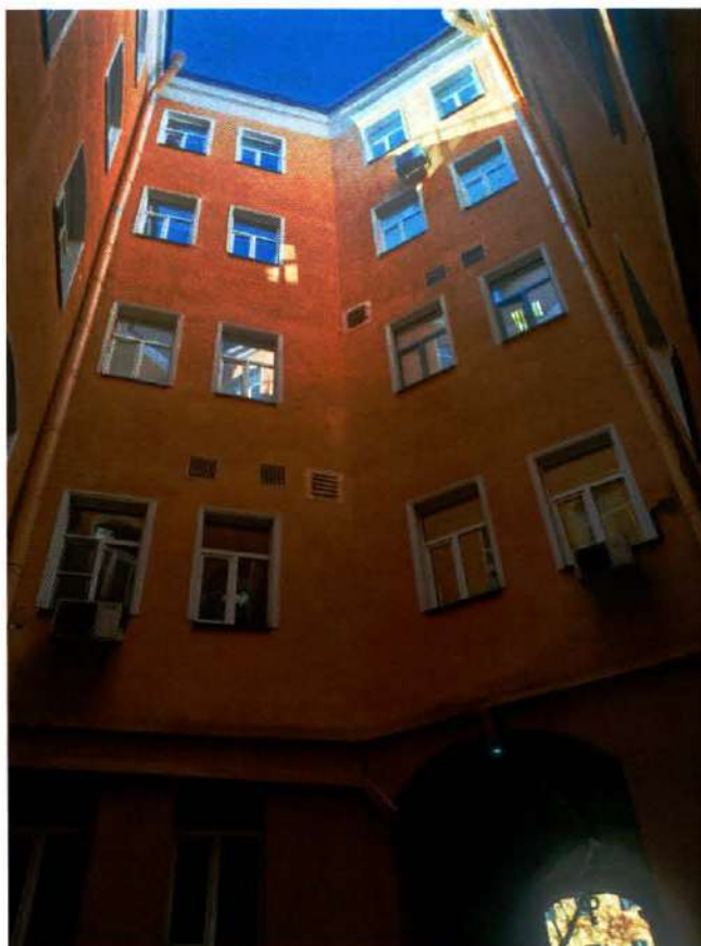
Фото 6. Восточный фасада восточного внутреннего двора объекта культурного наследия (дата съемки 27.03.2025).
