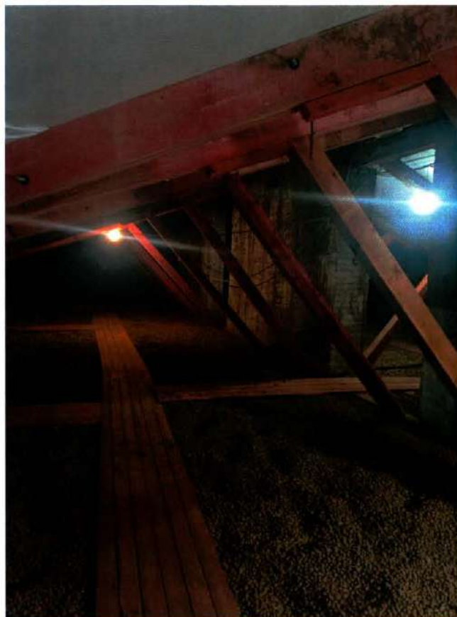
Фото 19. Конструкция крыши (дата съемки 27.03.2025).
