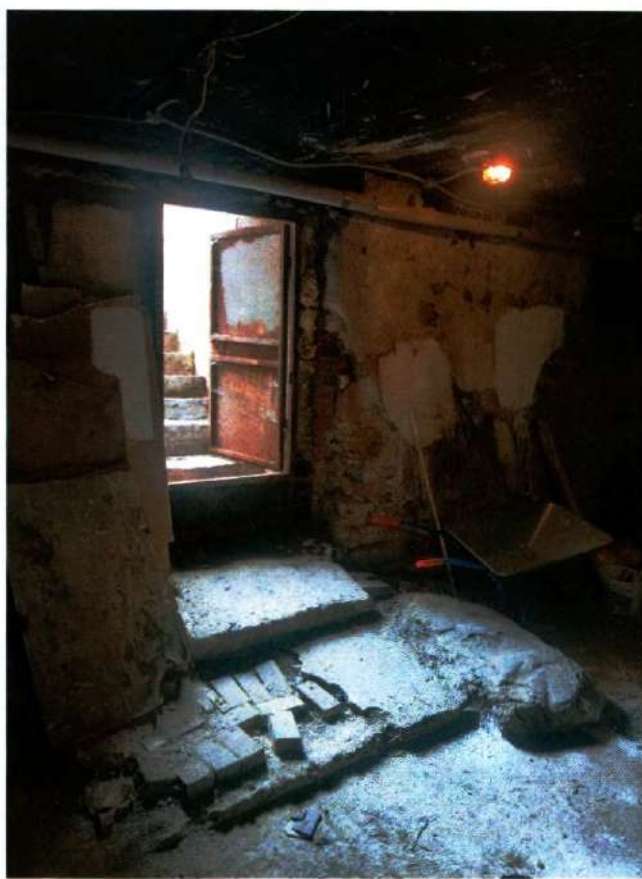
Фото 38. Общий вид помещения 40-Н (ч.п. 1) (дата съемки 27.03.2025).
