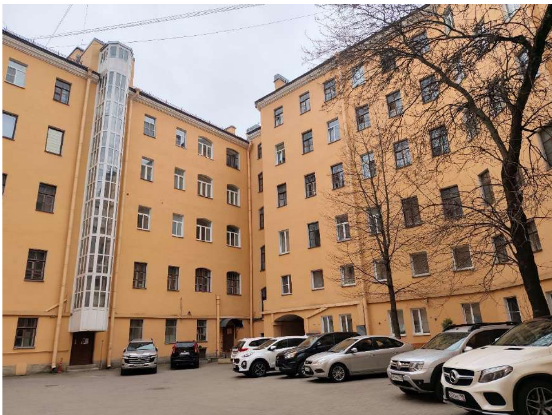
Фото 7. Вид на дворовые фасады западного внутреннего двора объекта культурного наследия регионального значения «Дом по 2-й Советской ул. с дворовым флигелем».
