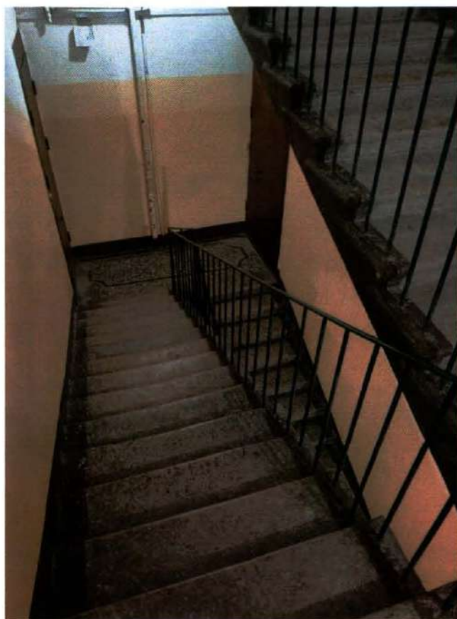
Фото 14. Лестничная клетка 14ЛК объекта культурного наследия (дата съемки 27.03.2025).
