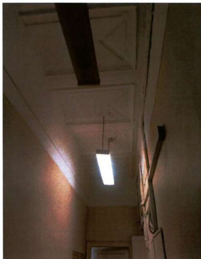
Фото 19. Общий вид помещения 15-Н (ч.п. 8). Прусские своды (дата съемки 13.03.2025).
