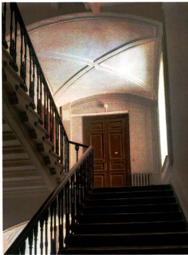
Фото 7. Лестничная клетка 1ЛК объекта культурного наследия (дата съемки 23.05.2025).
