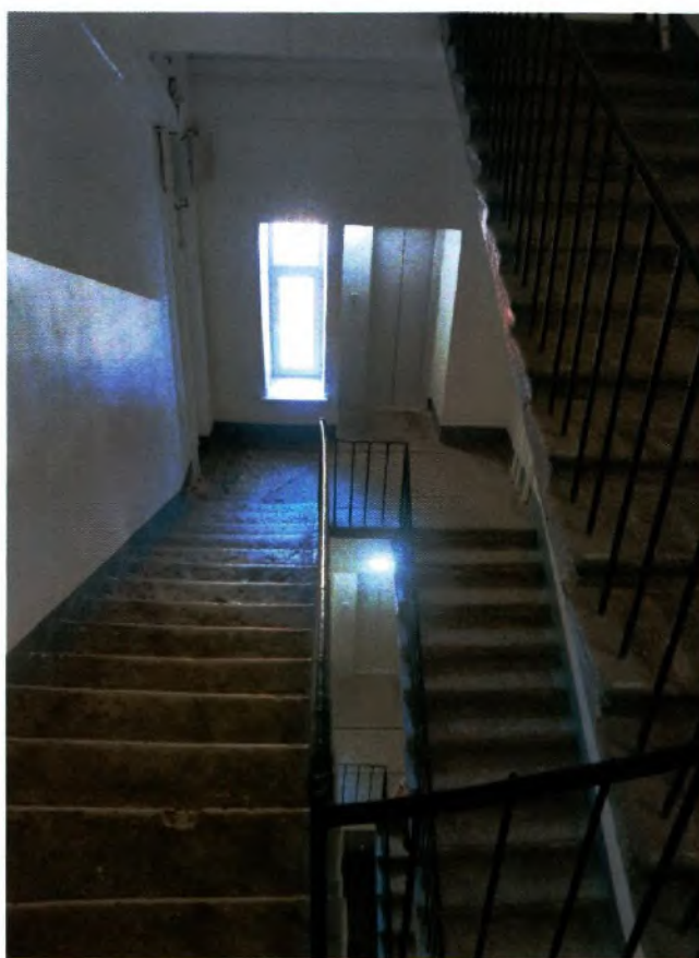
Фото 46. Лестничная клетка 13ЛК (дата съемки 27.03.2025).
