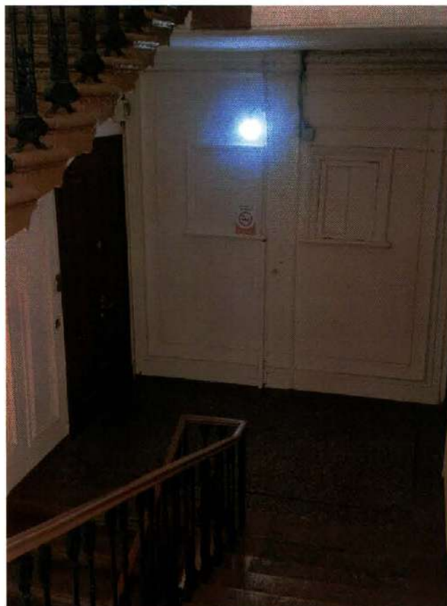
Фото 11. Лестничная клетка 5ЛК объекта культурного наследия (дата съемки 23.05.2025).
