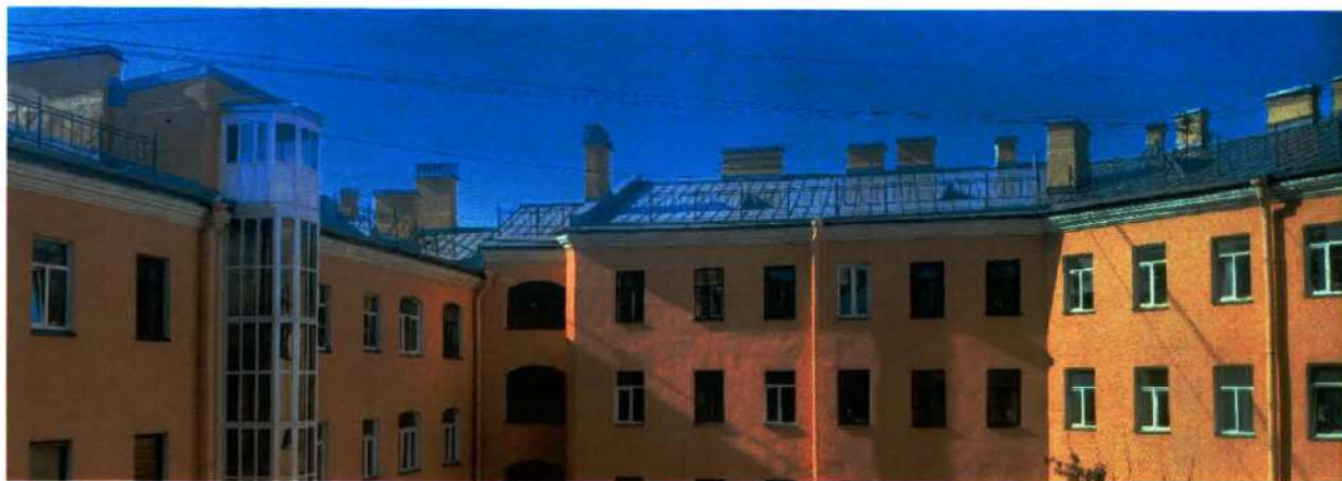
Фото 20. Вид на кровлю объекта культурного наследия (дата съемки 27.03.2025).
