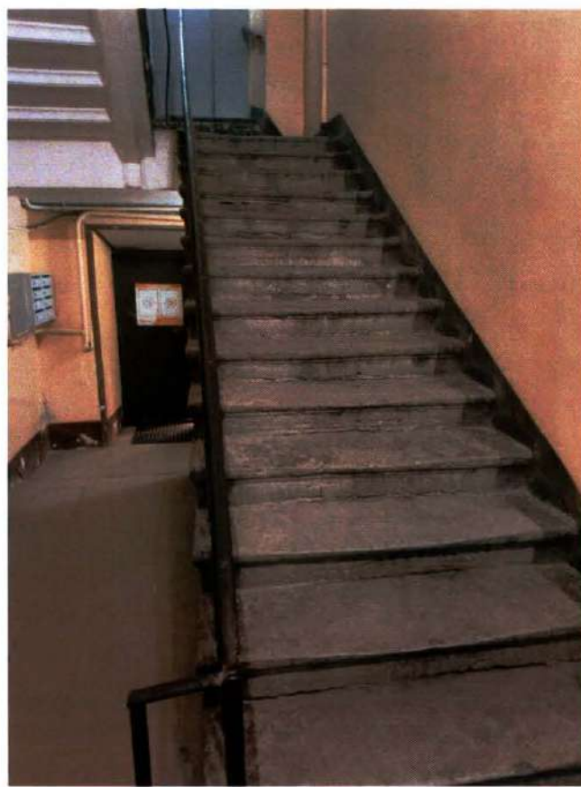
Фото 15. Лестничная клетка 15ЛК объекта культурного наследия (дата съемки 27.03.2025).
