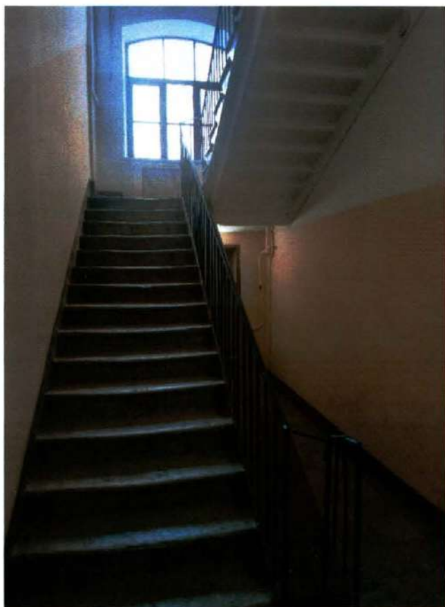
Фото 12. Лестничная клетка 12ЛК объекта культурного наследия (дата съемки 27.03.2025).
