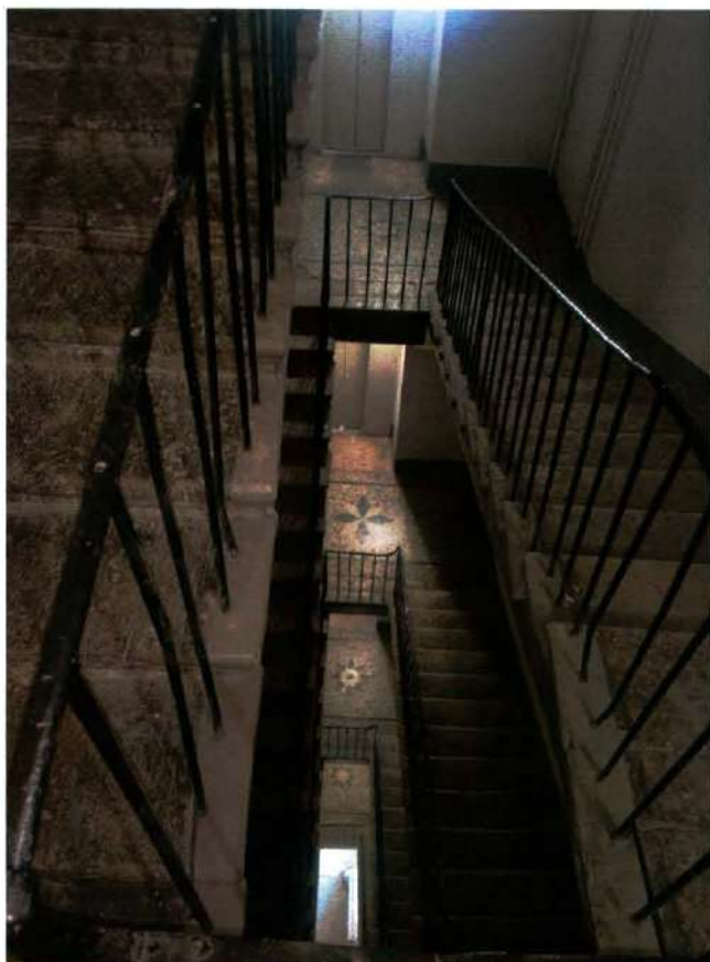
Фото 16. Лестничная клетка 16ЛК объекта культурного наследия (дата съемки 27.03.2025).
