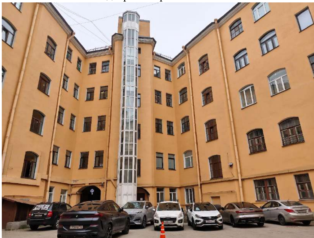
Фото 8. Вид на дворовые фасады западного внутреннего двора объекта культурного наследия регионального значения «Дом по 2-й Советской ул. с дворовым флигелем».
