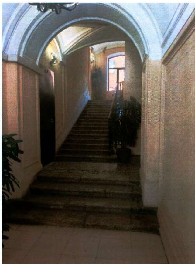
Фото 40. Лестничная клетка 2ЛК (дата съемки 27.03.2025).
