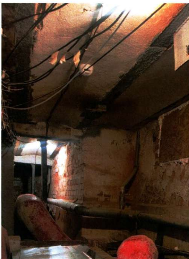
Фото 26. Общий вид помещения 22-Н (ч.п. 34) (дата съемки 20.05.2025).
