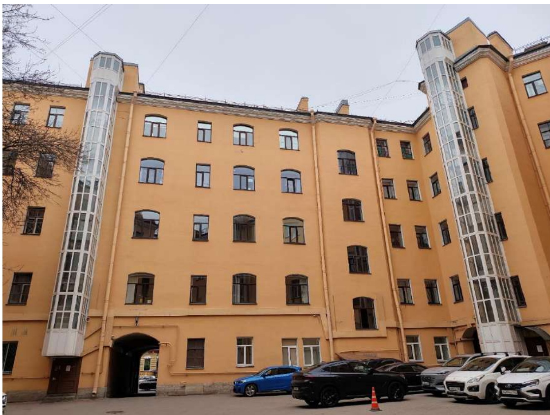
Фото 9. Вид на дворовые фасады западного внутреннего двора объекта культурного наследия регионального значения «Дом по 2-й Советской ул. с дворовым флигелем».
