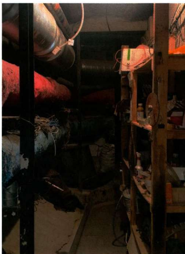
Фото 27. Общий вид помещения 22-Н (ч.п. 45) (дата съемки 20.05.2025).
