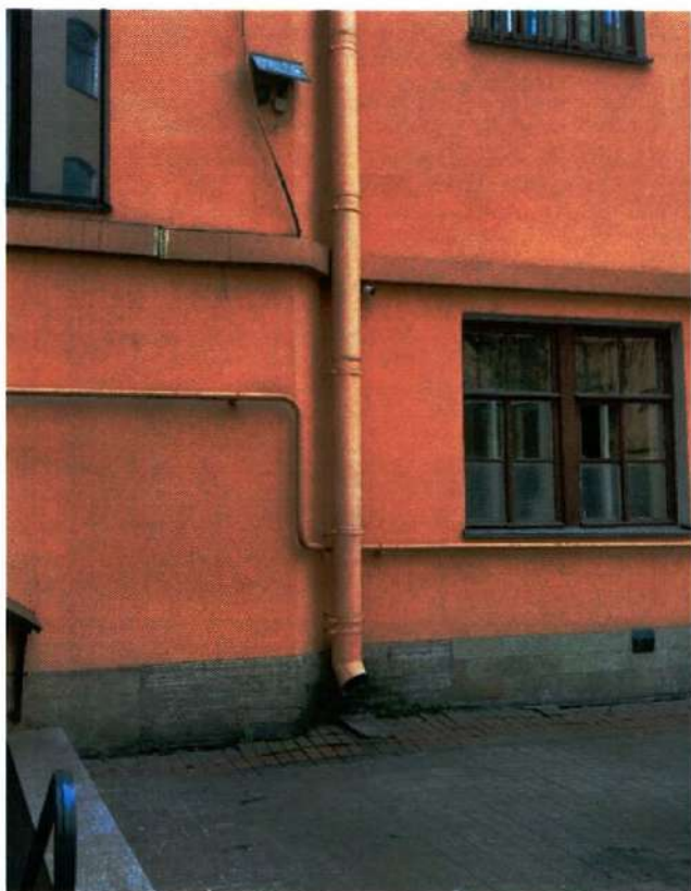
Фото 16. Фрагмент северного фасада западного внутреннего двора (дата съемки 27.03.2025).
