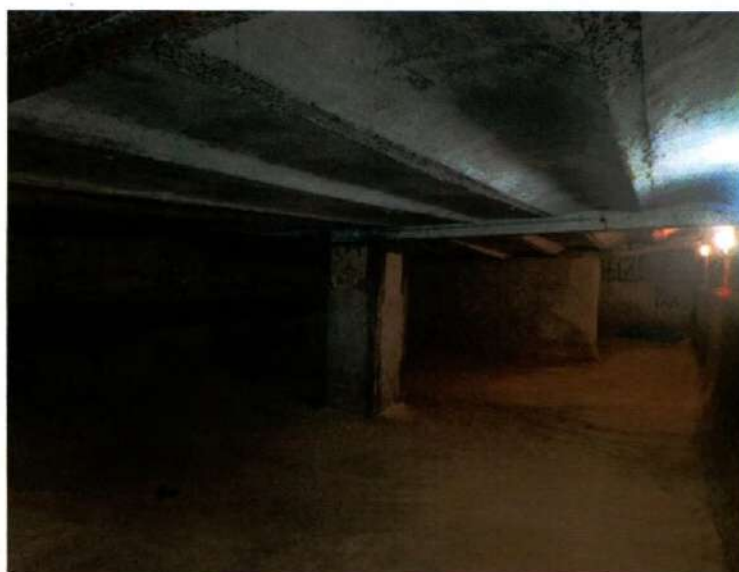
Фото 31. Общий вид помещения 25-Н (ч.п. 2). Прусские своды (дата съемки 27.03.2025).
