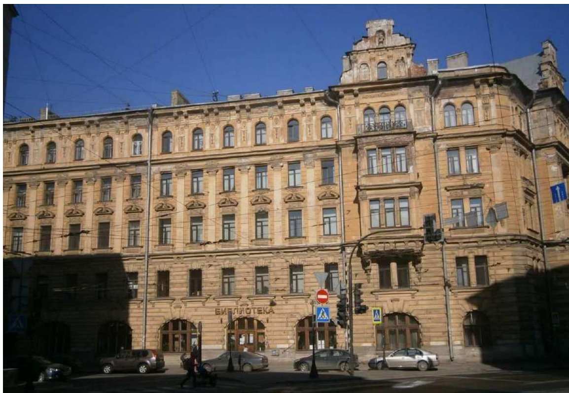
Илл. 56. 2-ая Советская ул., 27. Фрагмент лицевого фасада по пр. Бакунина. Фото 2011. (источник: http://www.citywalls.ru/house25774.html ).
