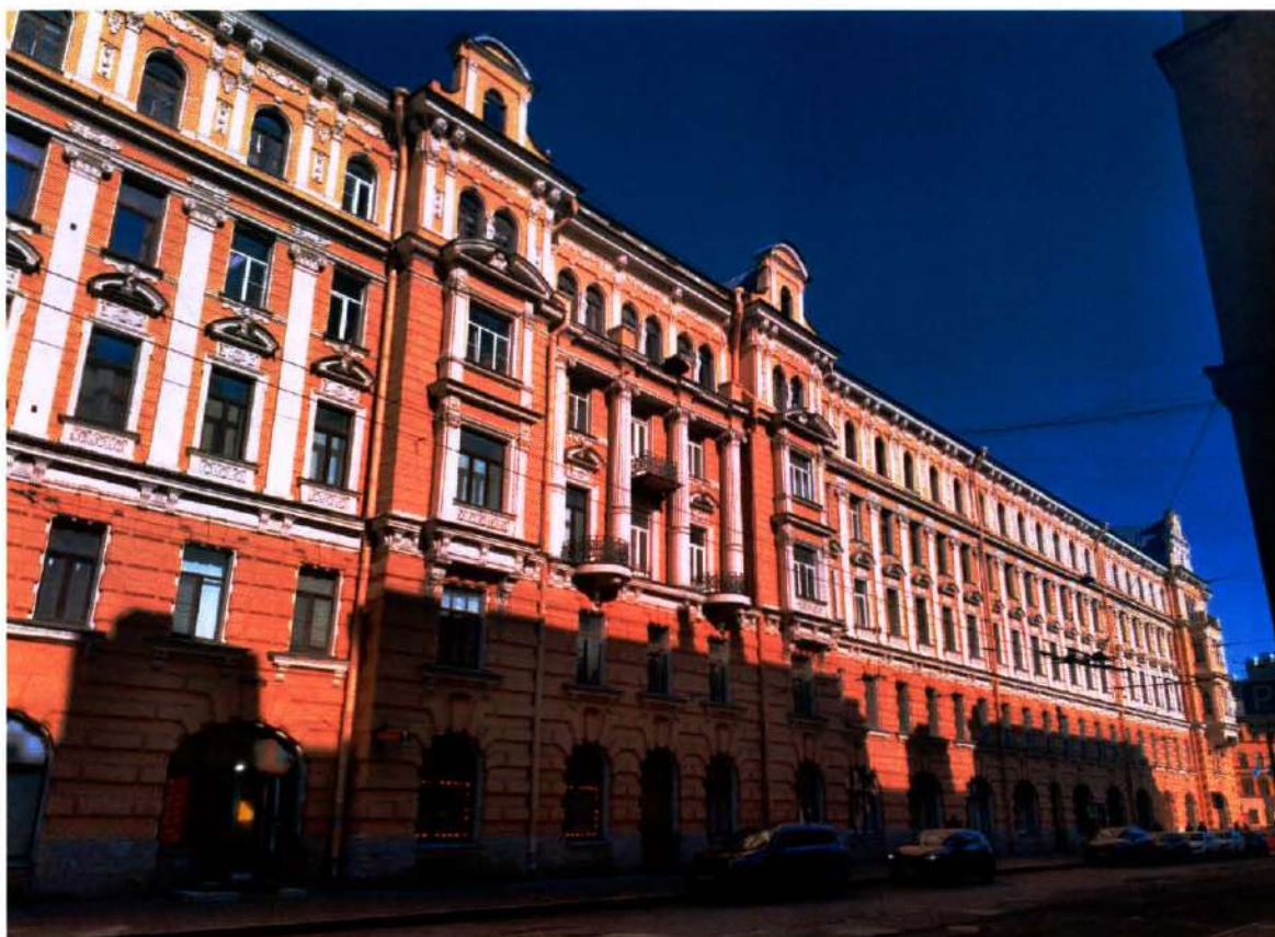
Фото 2. Южный лицевой фасад объекта культурного наследия (дата съемки 27.03.2025).
