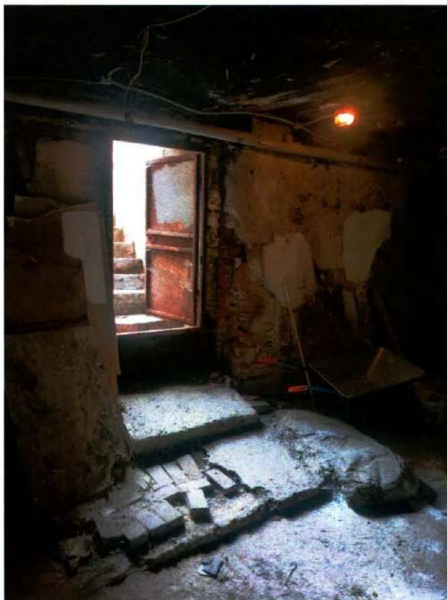
Фото 18. Подвальное пространство объекта культурного наследия, помещение 40-Н (ч.п. 1) (дата съемки 27.03.2025).
