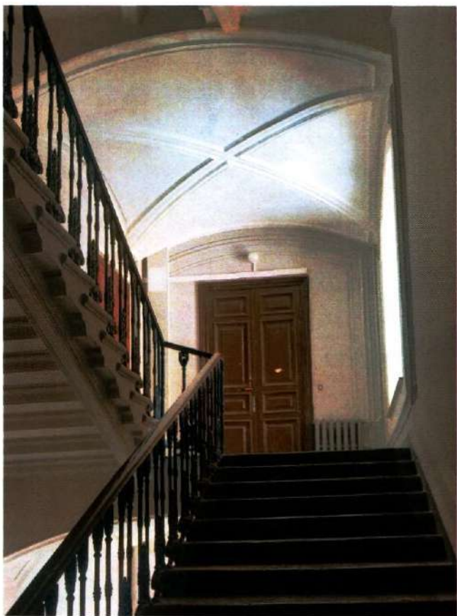
Фото 39. Лестничная клетка 1ЛК (дата съемки 23.05.2025).
