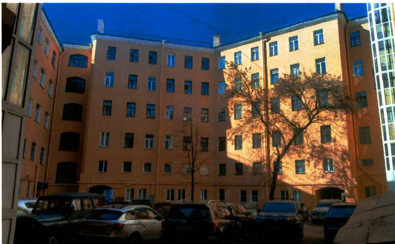
Фото 5. Восточный фасад западного внутреннего двора объекта культурного наследия (дата съемки 27.03.2025).
