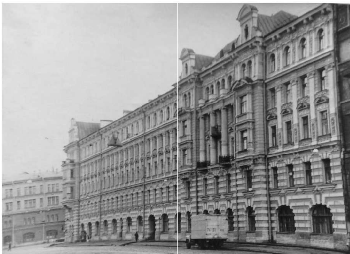
Илл. 55. 2-ая Советская ул., 27. Лицевой фасад. Фото 1978 г. Паспорт памятника истории «Дом, в котором у В.Д. Бонч-Бруевича бывал В.И. Ленин». (источник: архив КГИОП. Инв. № 777).
