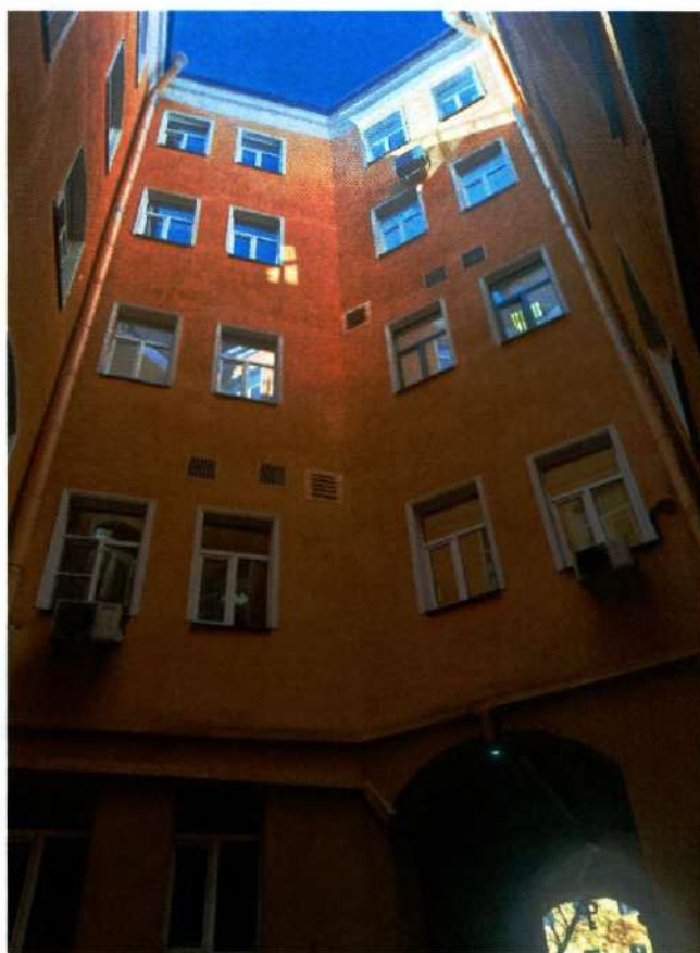
Фото 9. Восточный фасада восточного внутреннего двора объекта культурного наследия (дата съемки 27.03.2025).
