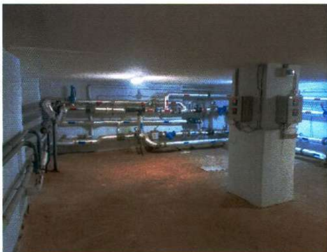
Фото 33. Общий вид помещения 30-Н (ч.п. 2) (дата съемки 27.03.2025).
