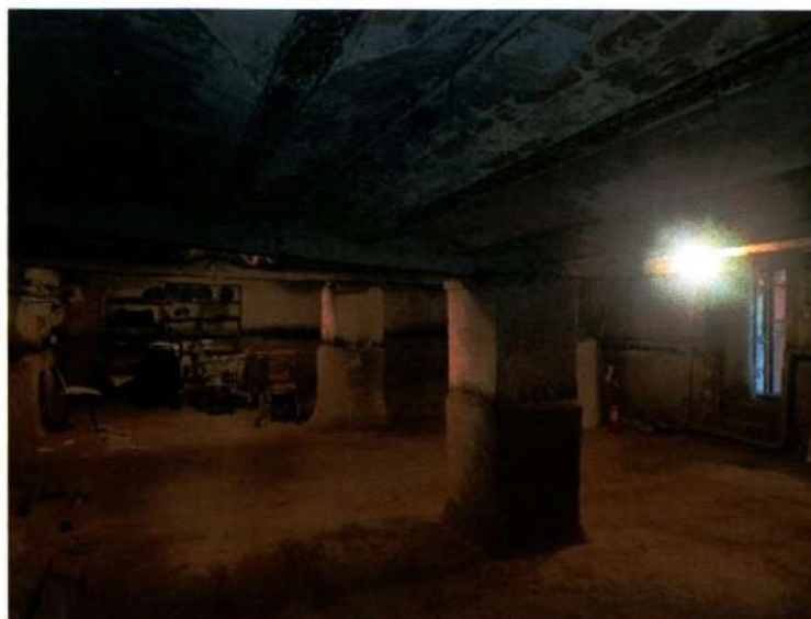
Фото 32. Общий вид помещения 25-Н (ч.п. 1). Прусские своды (дата съемки 27.03.2025).
