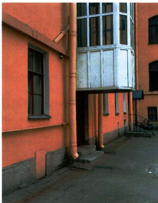
Фото 17. Фрагмент северного фасада западного внутреннего двора (дата съемки 27.03.2025).
