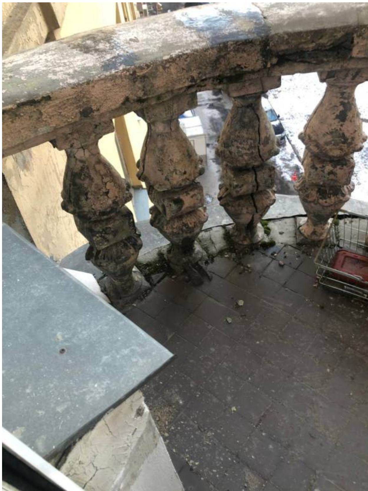
22. Балкон со стороны двора.
