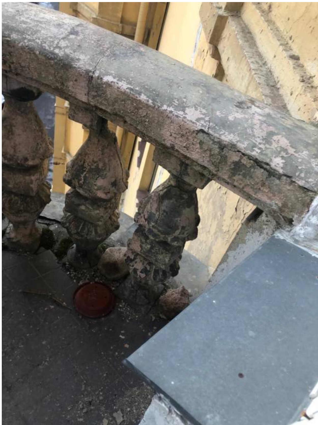
23.Балкон со стороны двора.
