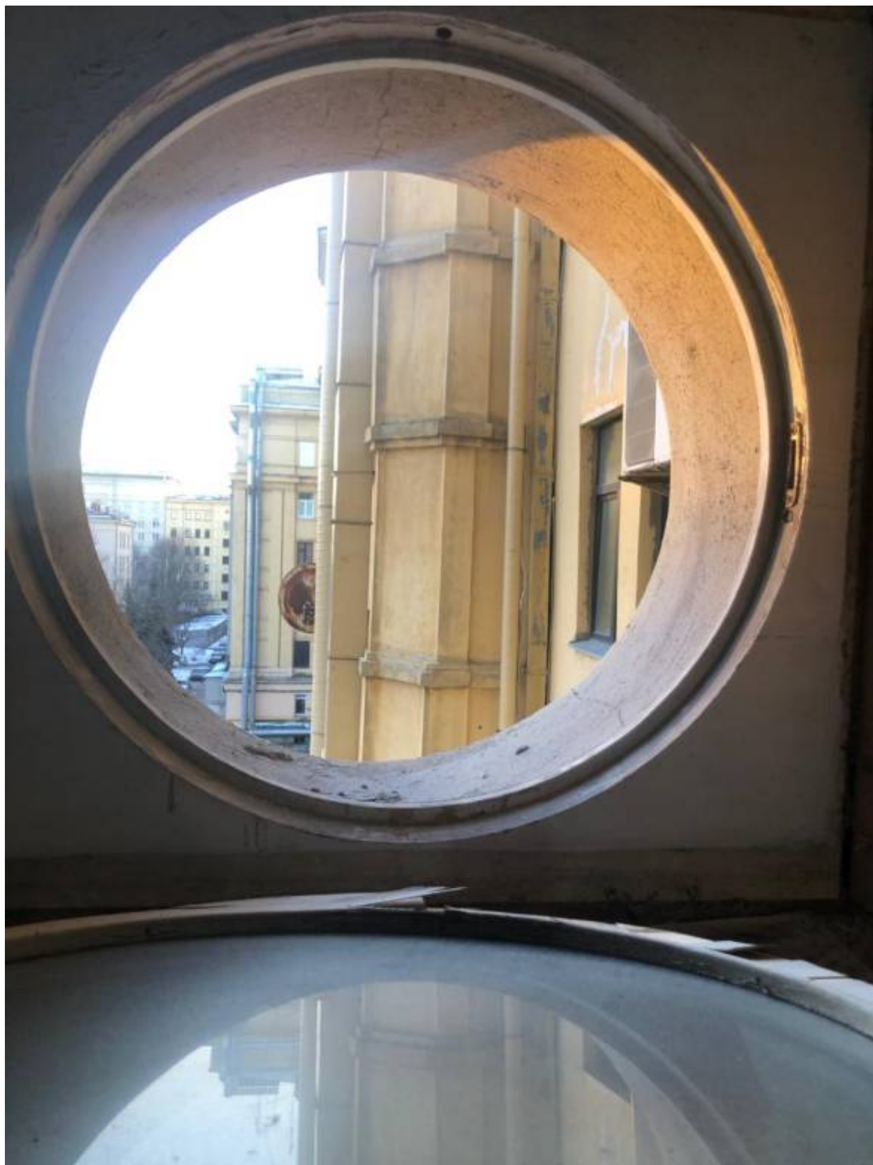
19. Помещение 8 (согласно техническому паспорту). Оконный проем.
