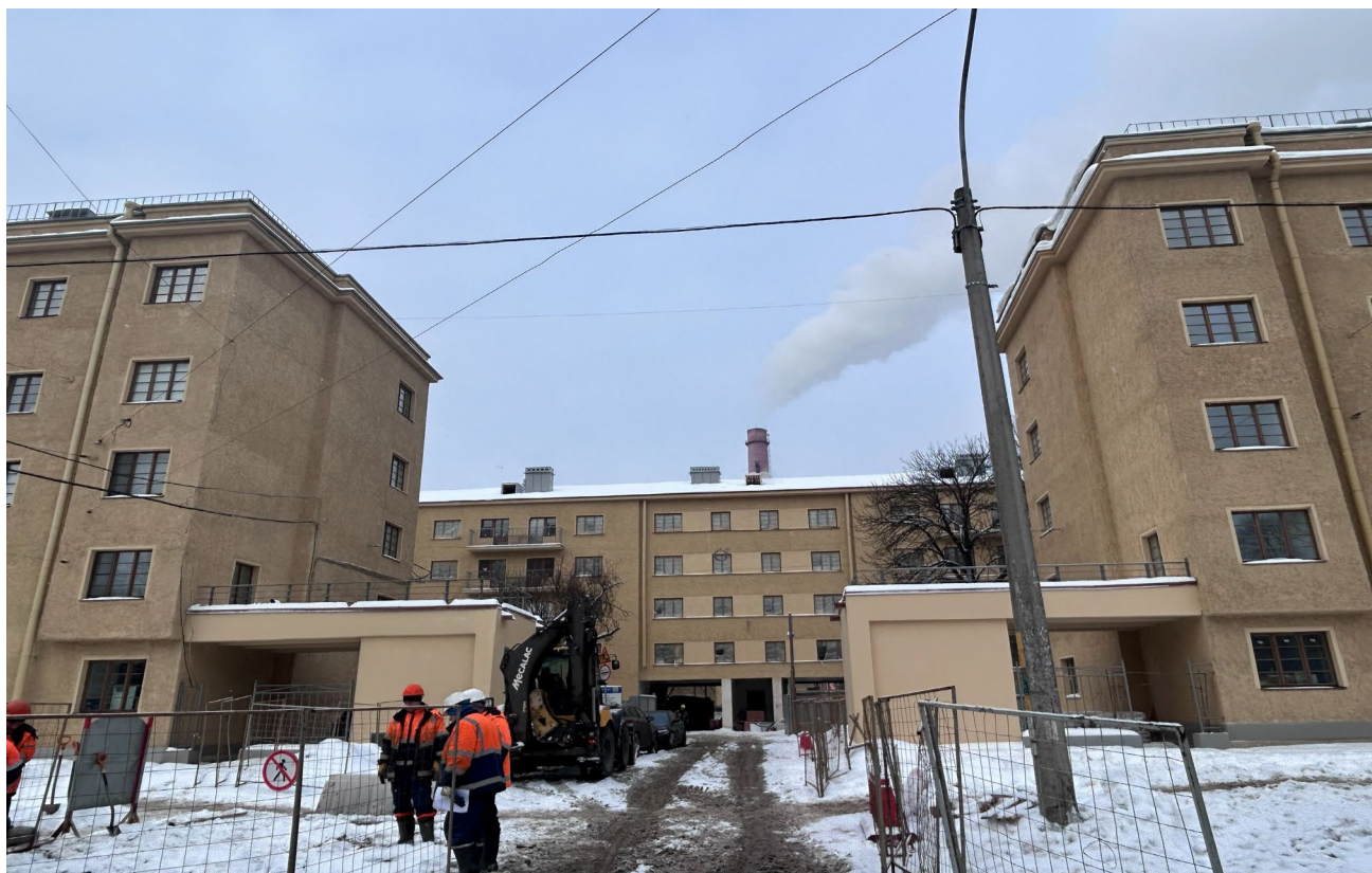
Фото 3. Кондратьевский пр.40 корпус 1литера А и корпус 10 литеры А вид с улицы
