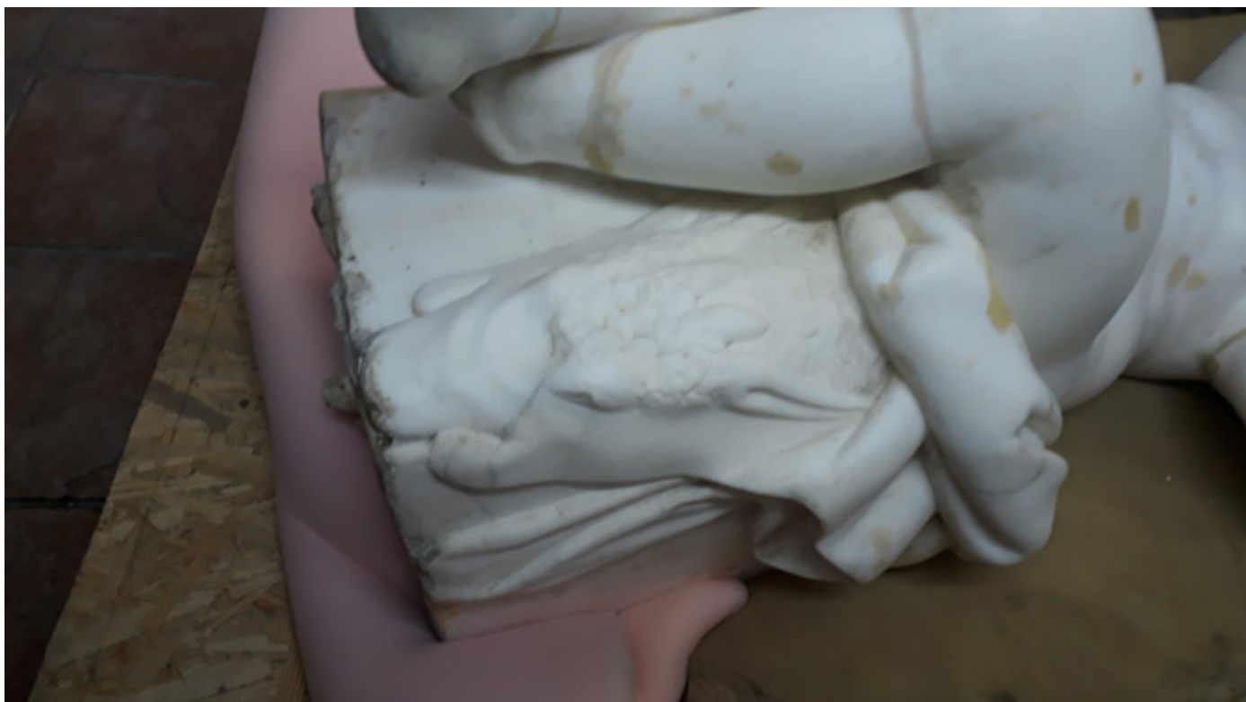
Фото 6. Объекты культурного наследия (Статуя «Амур с театральной маской» и Фонтанные фигуры «Дельфин») (шесть) в составе объекта культурного наследия федерального значения «Пруд с фонтаном «Дубовый»», «Верхнего сада» «Дворцово-паркового ансамбля Петродворца», расположенных по адресу: Санкт-Петербург, г. Петергоф, Санкт-Петербургский проспект, д 47, сооружение 4, лит. ФД.
