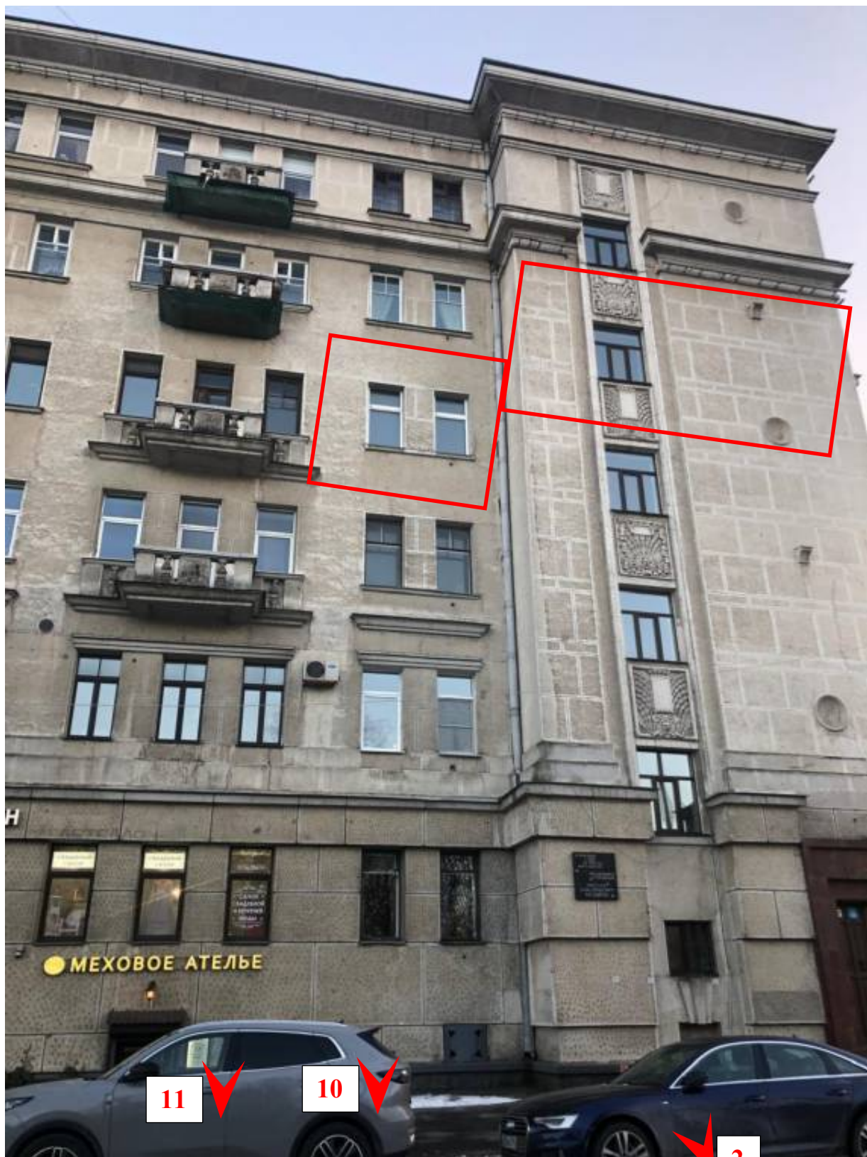
1. Фрагмент лицевого фасада со стороны улицы Гастелло. Красной линией оконные проемы квартиры №16.
