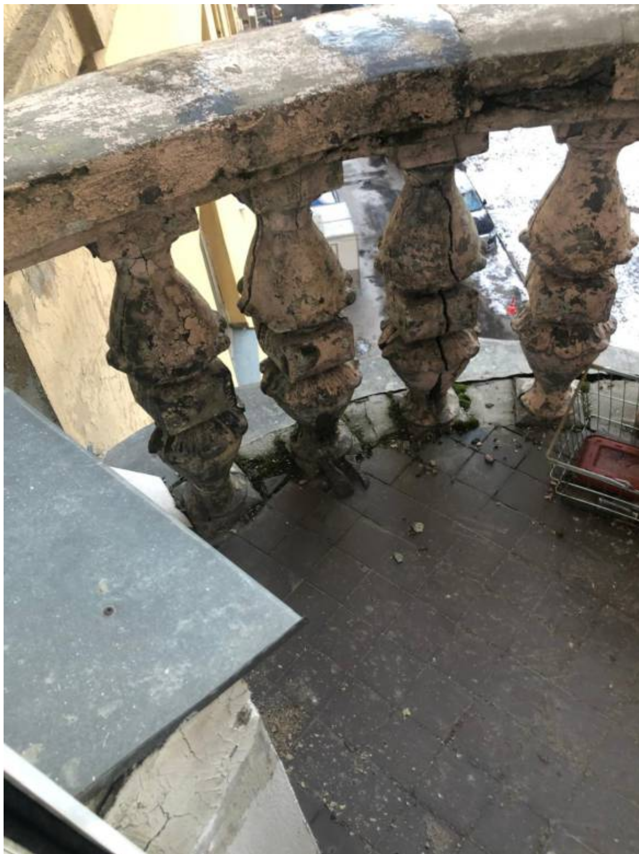
22. Балкон со стороны двора.
