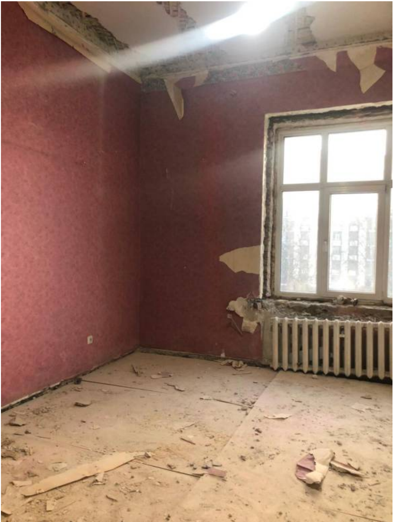
14. Помещение 3 (согласно техническому паспорту).
