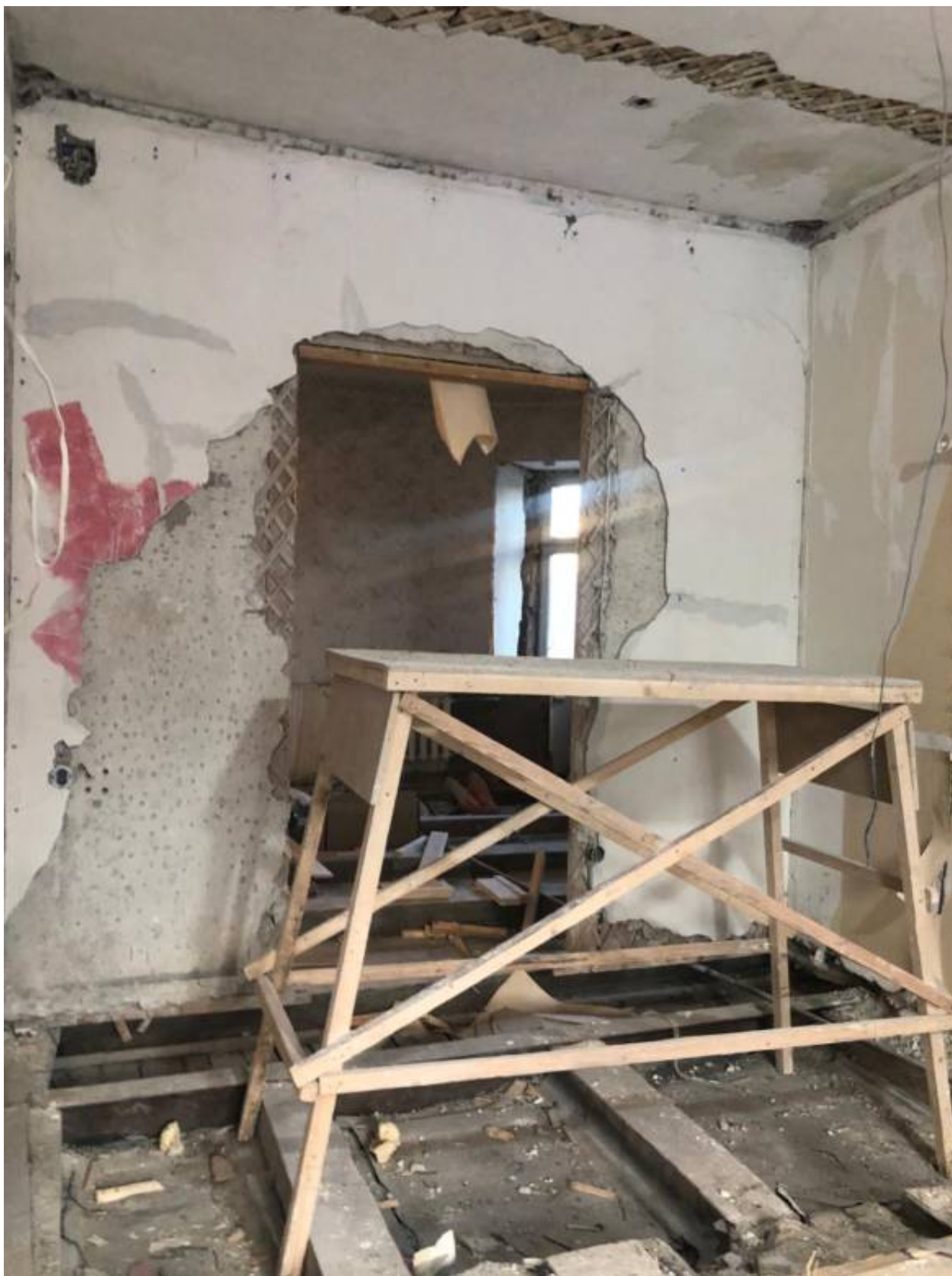
17. Помещение 3 (согласно техническому паспорту).
