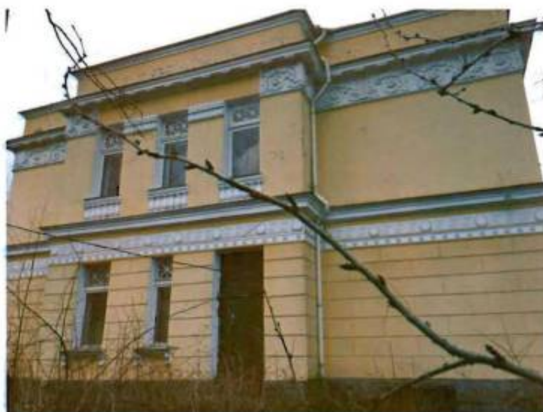
3. Северо-западный фасад здания.
