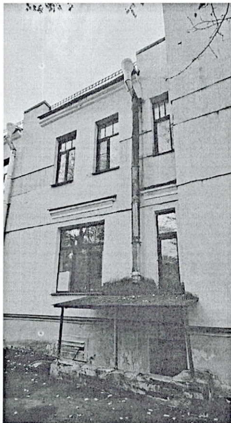
11. Северный фасад. Фрагмент.
