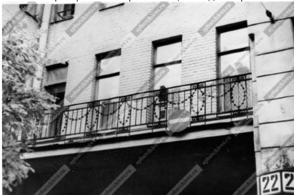
16. Вид балконных ограждений центрального фасада жилого дома №22 по улице Скороходова. 06 октября 1985 г. // ЦГАКФФД СПб Ар 225268
