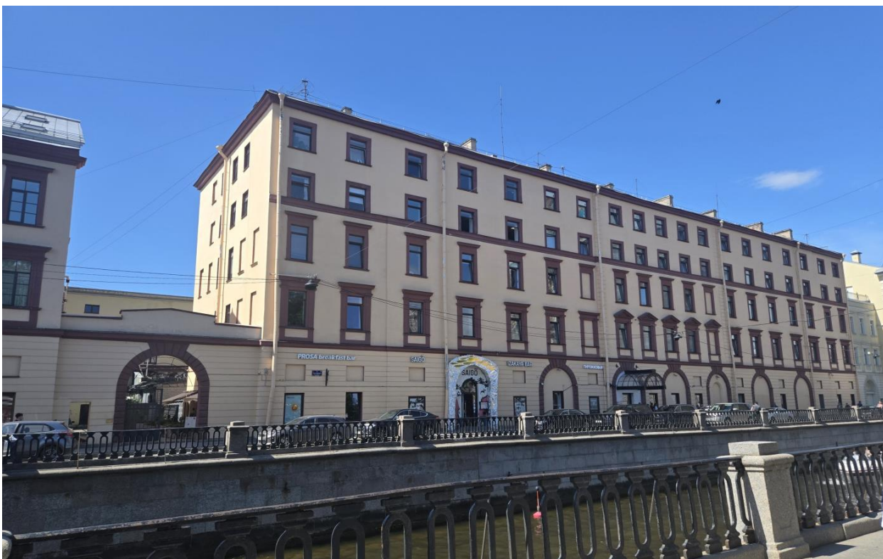
Илл. 2. Выявленный объект культурного наследия «Служебный корпус (с каменной оградой и проездом)», по адресу: Санкт-Петербург, Грибоедова кан. наб., 5, входящий в состав выявленного объекта культурного наследия «Комплекс построек Придворно-конюшенного ведомства». Общий вид с набережной канала Грибоедова.
