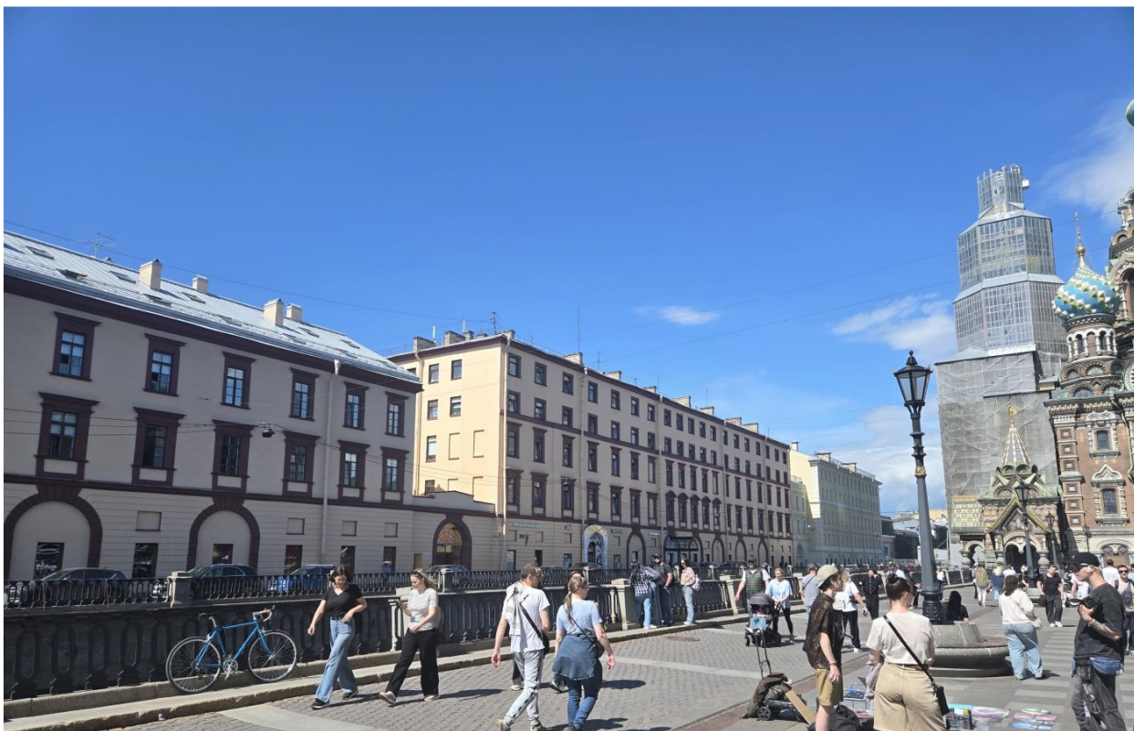
Илл. 1. Выявленный объект культурного наследия «Служебный корпус (с каменной оградой и проездом)», по адресу: Санкт-Петербург, Грибоедова кан. наб., 5, входящий в состав выявленного объекта культурного наследия «Комплекс построек Придворно-конюшенного ведомства». Общий вид с набережной канала Грибоедова.
