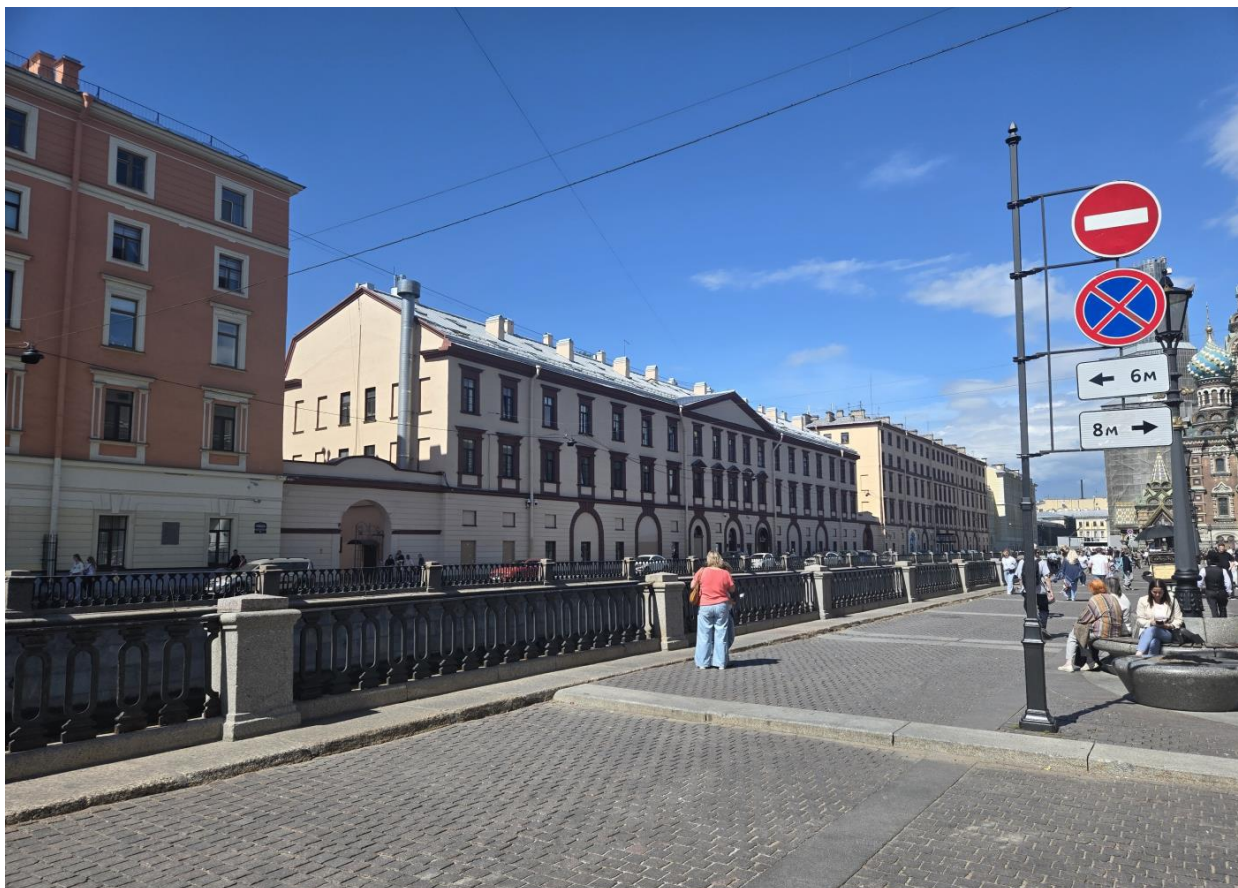
Илл. 1. Выявленный объект культурного наследия «Служебный корпус (с каменной оградой и проездом)», по адресу: Санкт-Петербург, Грибоедова кан. наб., 7, входящий в состав выявленного объекта культурного наследия «Комплекс построек Придворно-конюшенного ведомства». Общий вид с набережной канала Грибоедова.
