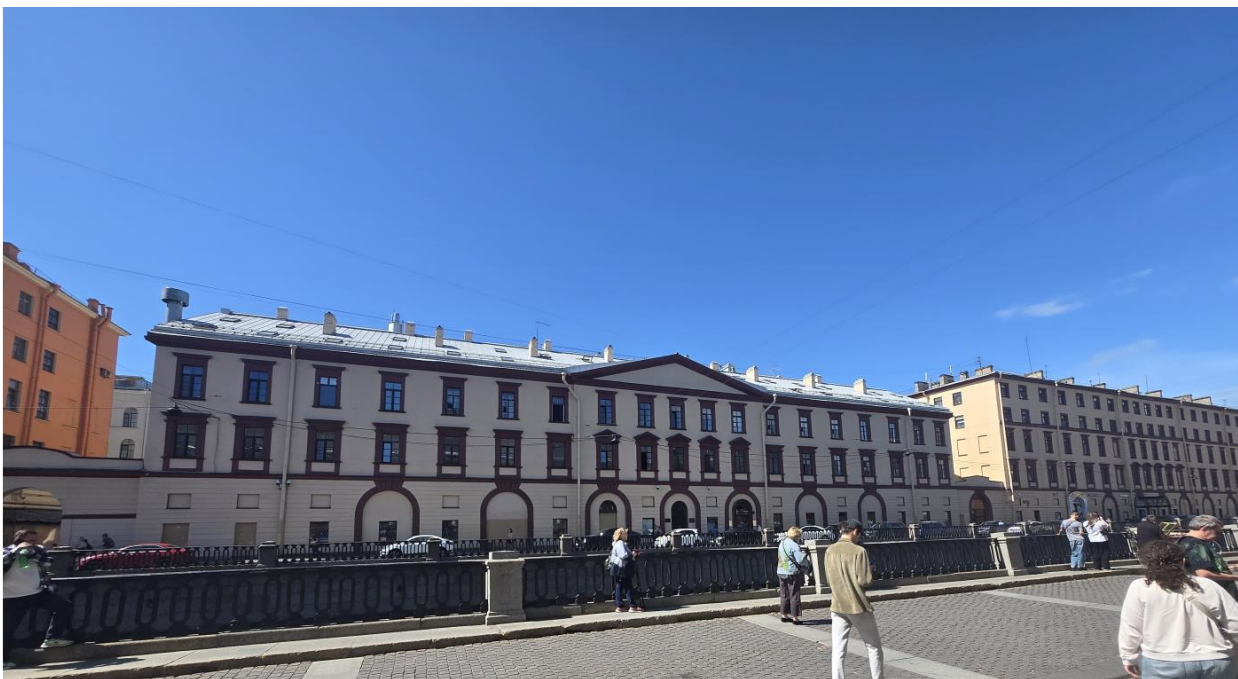
Илл. 2. Выявленный объект культурного наследия «Служебный корпус (с каменной оградой и проездом)», по адресу: Санкт-Петербург, Грибоедова кан. наб., 7, входящий в состав выявленного объекта культурного наследия «Комплекс построек Придворно-конюшенного ведомства». Общий вид с набережной канала Грибоедова.
