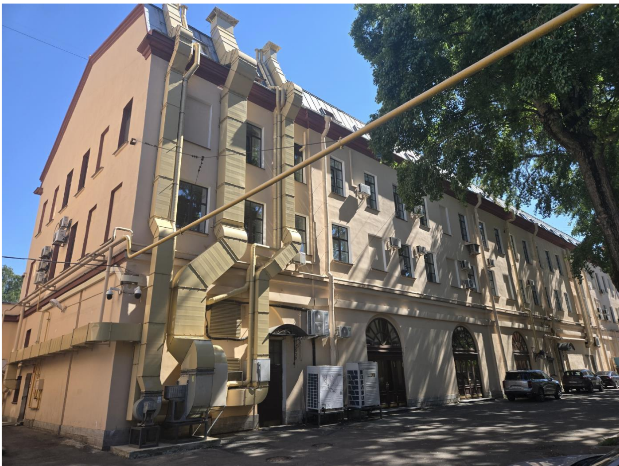
Илл. 5. Выявленный объект культурного наследия «Служебный корпус (с каменной оградой и проездом)», по адресу: Санкт-Петербург, Грибоедова кан. наб., 7, входящий в состав выявленного объекта культурного наследия «Комплекс построек Придворно-конюшенного ведомства». Фрагмент фасада.
