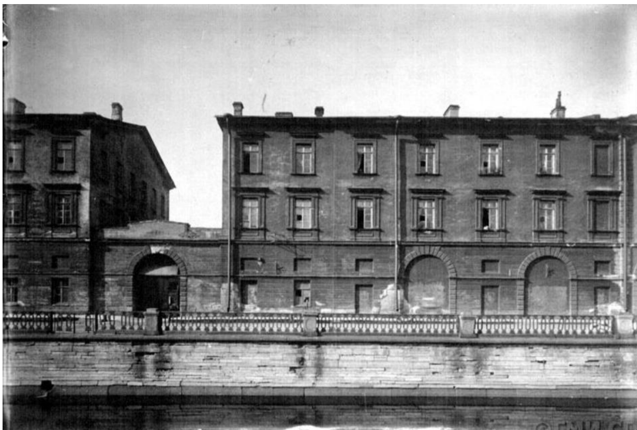
Илл. 12. Объекты культурного наследия «Служебный корпус (с каменной оградой и проездом)». Фасады по набережной канала Грибоедова, дом 5-7. Фото 1926 г. Источник: https://pastvu.com/p/2465662
