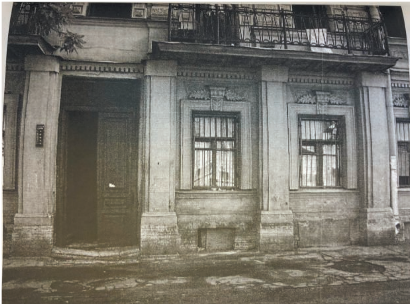
22. Фрагмент лицевого фасада здания по 12 линии В.О., дом 27. 2004. // Источник: Архив КГИОП. П. 1500-Л. Ин.1194. Проект реконструкции помещений по адресу: СПб, 12-я линия В.О., д. 27. Архитектурная мастерская «Группа А». 2004.
