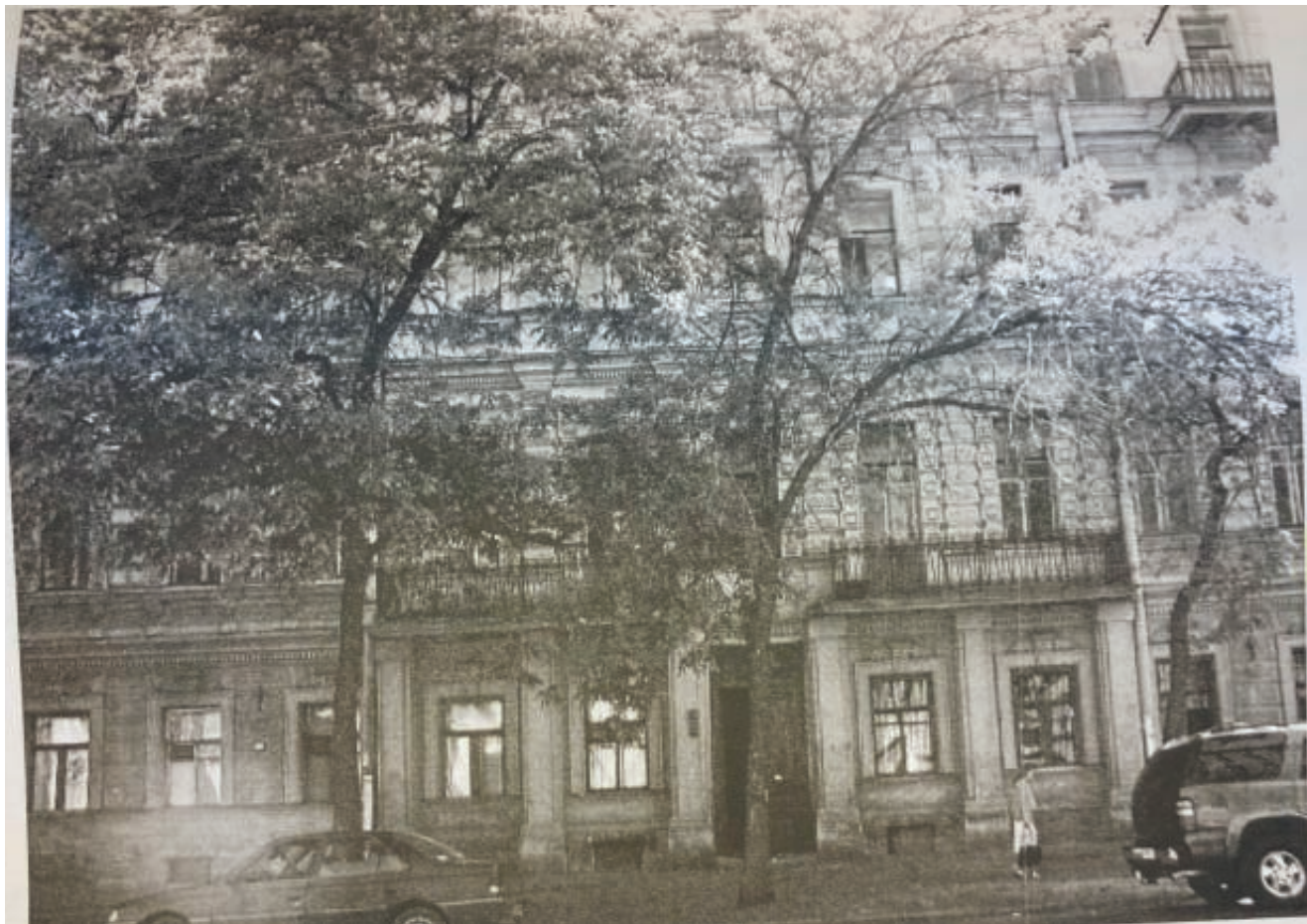
21. Фрагмент лицевого фасада здания по 12 линии В.О., дом 27. 2004. // Источник: Архив КГИОП. П. 1500-Л. Ин.1194. Проект реконструкции помещений по адресу: СПб, 12-я линия В.О., д. 27. Архитектурная мастерская «Группа А». 2004.
