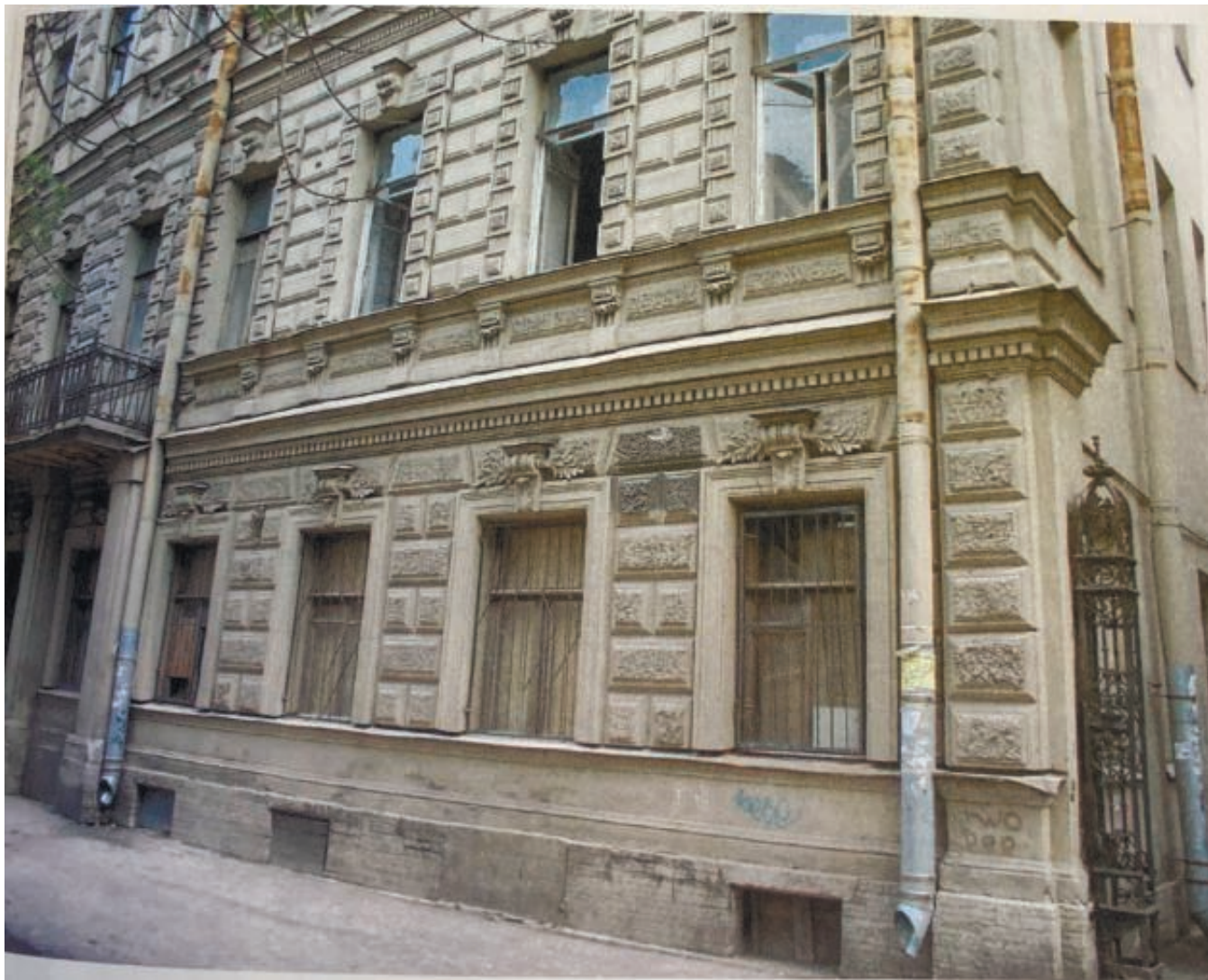
20. Фрагмент лицевого здания по 12 линии В.О., дом 27. 2003. // Источник: Архив КГИОП. П. 1500-Л. Ин. 1193. Концепция устройства отдельного входа. Санкт-Петербург, 12ая Линия В.О. Д. 27. Архитектурная мастерская «Группа А». 2003.
