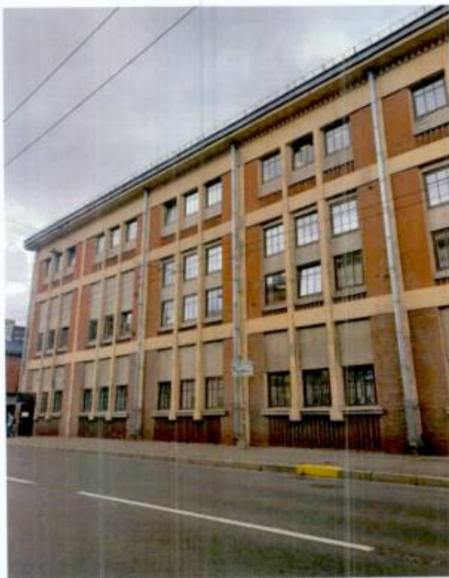
3. Фрагмент объекта культурного наследия с восточной стороны.
