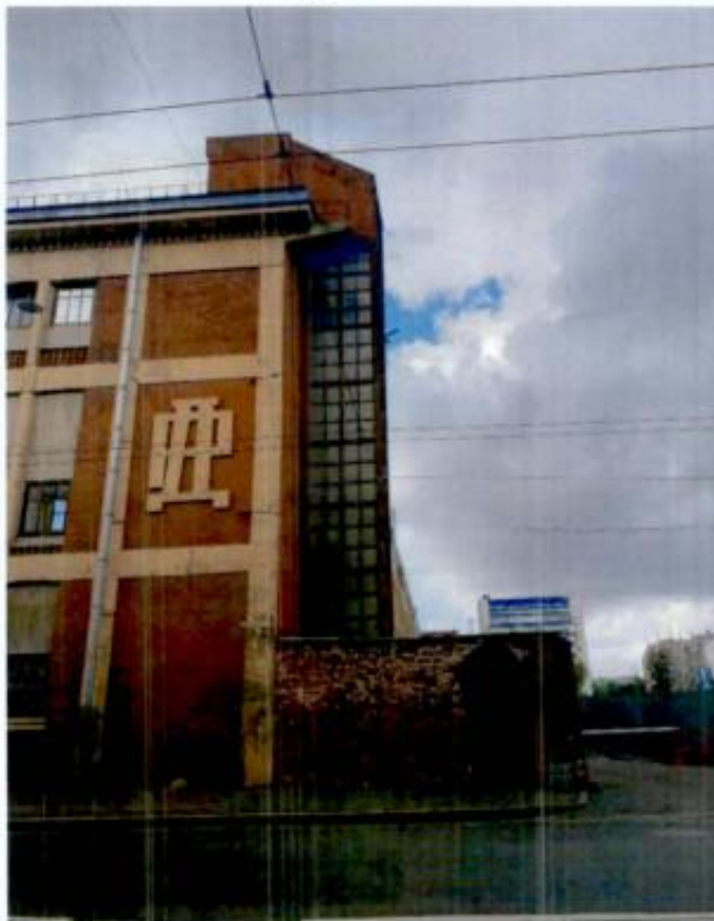
2. Фрагмент объекта культурного наследия с восточной стороны.
