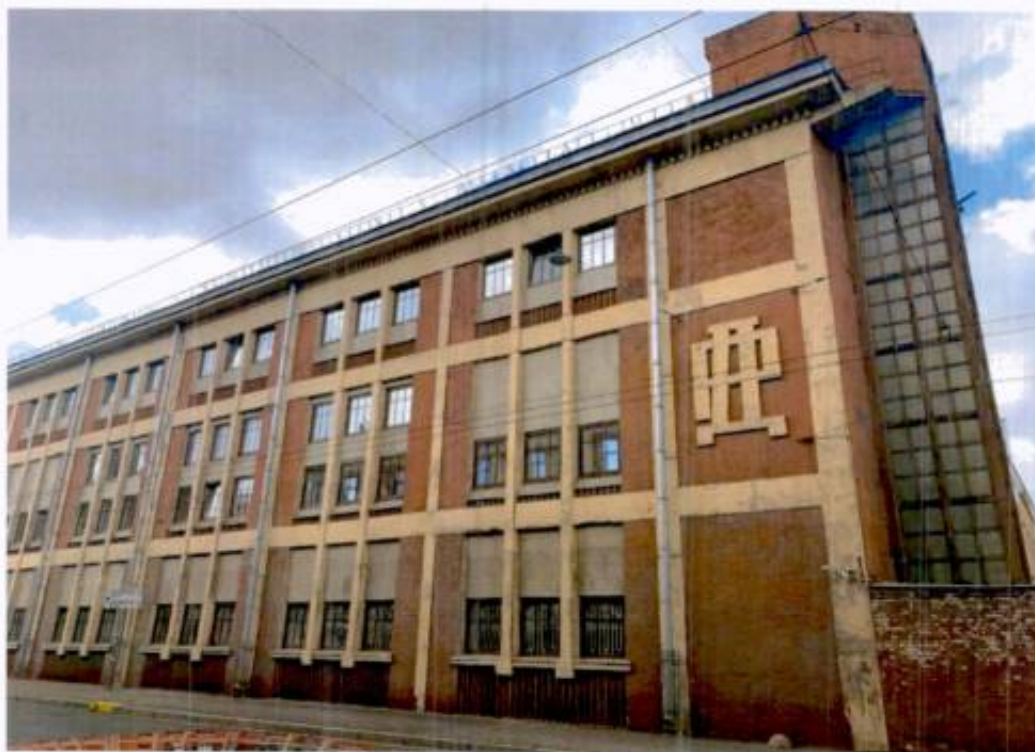
1. Фрагмент объекта культурного наследия с восточной стороны.
