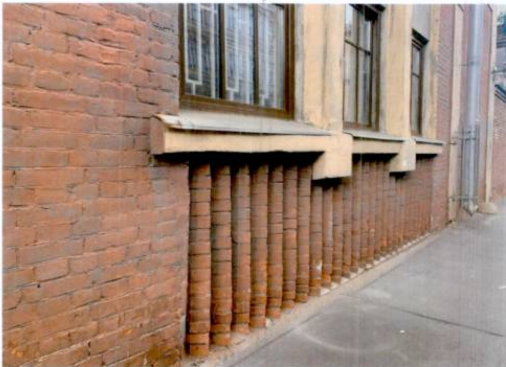
4. Фрагмент объекта культурного наследия с восточной стороны.
