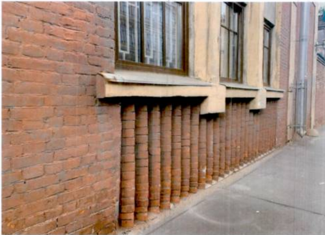
4. Фрагмент объекта культурного наследия с восточной стороны.
