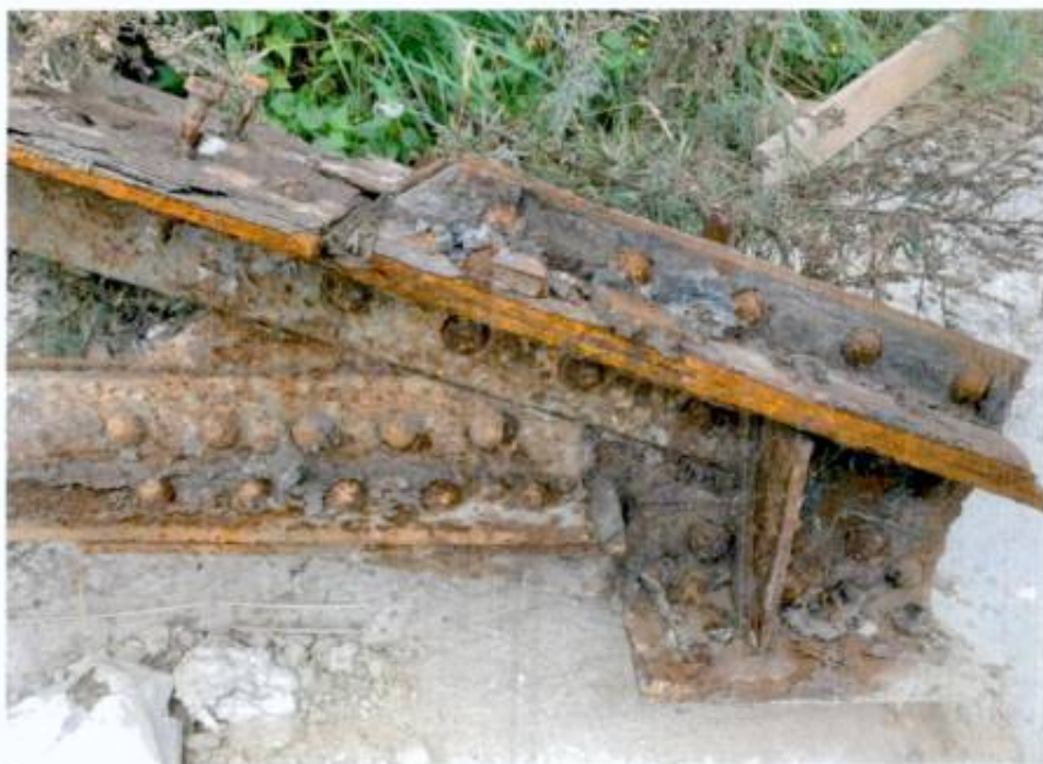
8. Фрагмент клепанной фермы, расположенной по адресу: Санкт-Петербург, Петергофское шоссе, дом 75, корпус 46 (фото от 26.09.2024)
