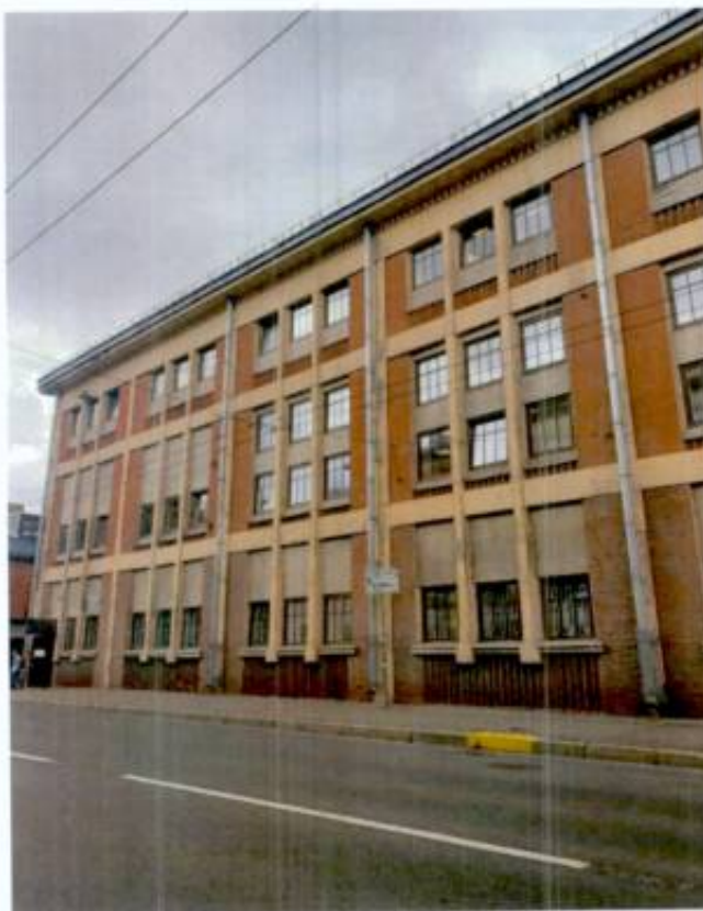
3. Фрагмент объекта культурного наследия с восточной стороны.
