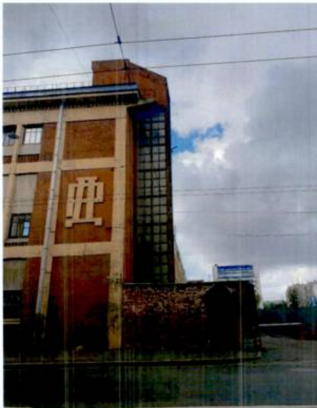
2. Фрагмент объекта культурного наследия с восточной стороны.
