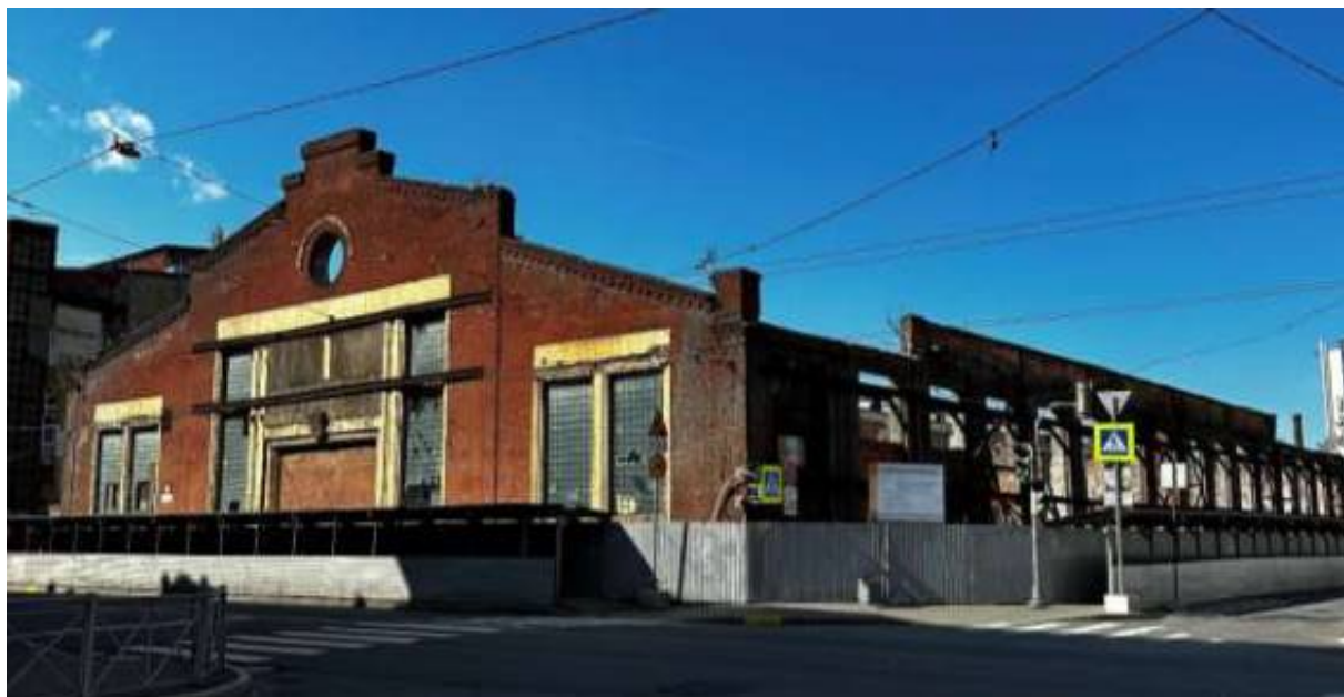
1. Чугунолитейный цех (Большой Сампсониевский пр., д. 30, корп. 2, лит. Б). Общий вид.
