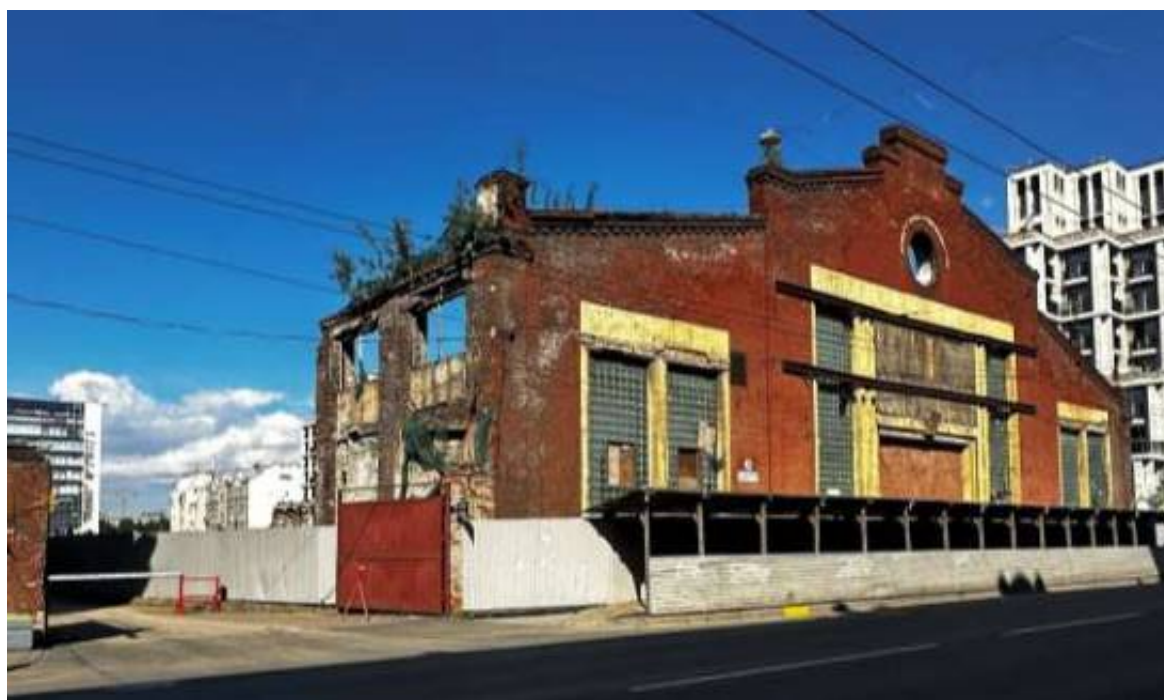
2. Чугунолитейный цех (Большой Сампсониевский пр., д. 30, корп. 2, лит. Б). Вид с Большого Сампсониевского пр.
