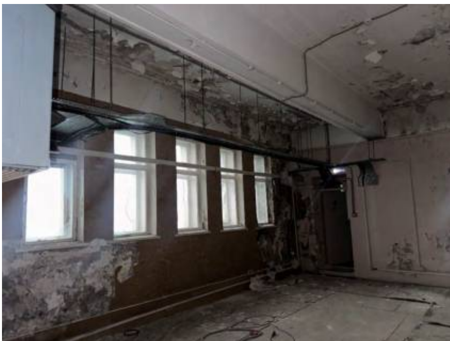
Фотография 116. Выявленный объект культурного наследия. Дом культуры работников связи (быв. Немецкая реформатская церковь). Дата съемки: 01.02.2026
