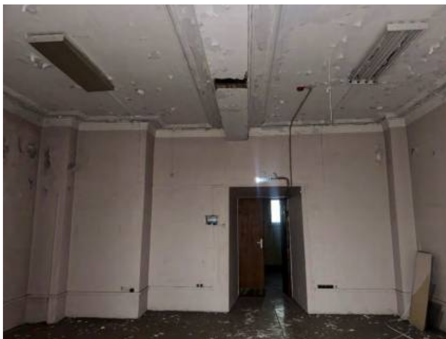
Фотография 108. Выявленный объект культурного наследия. Дом культуры работников связи (быв. Немецкая реформатская церковь). Дата съемки: 01.02.2026
