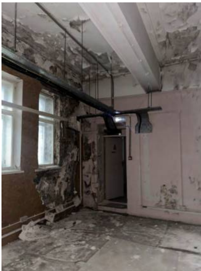
Фотография 114. Выявленный объект культурного наследия. Дом культуры работников связи (быв. Немецкая реформатская церковь). Дата съемки: 01.02.2026
