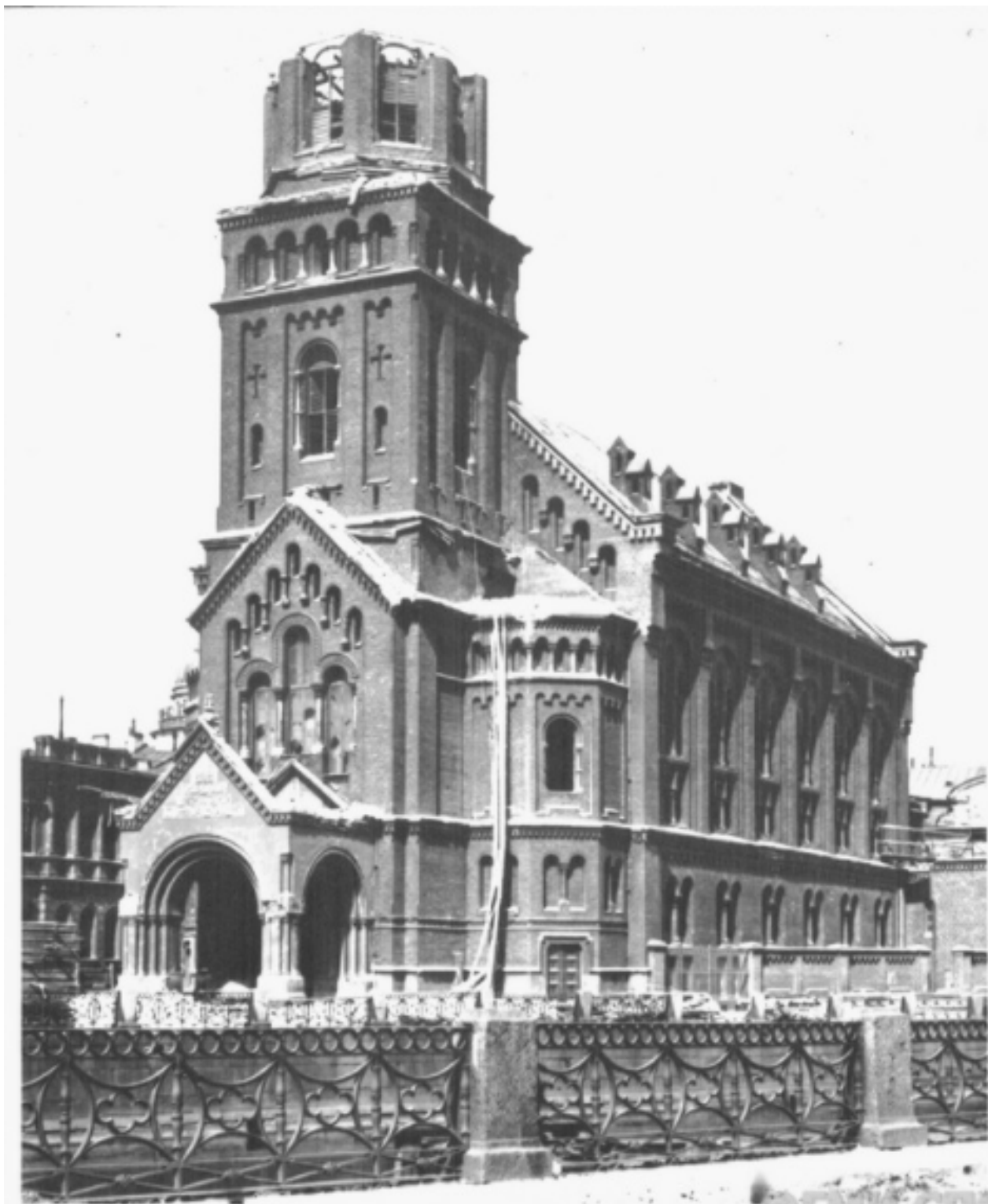
8. Конец 1920-х годов. Немецкая реформатская церковь на набережной Мойки. Процесс перестройки.
