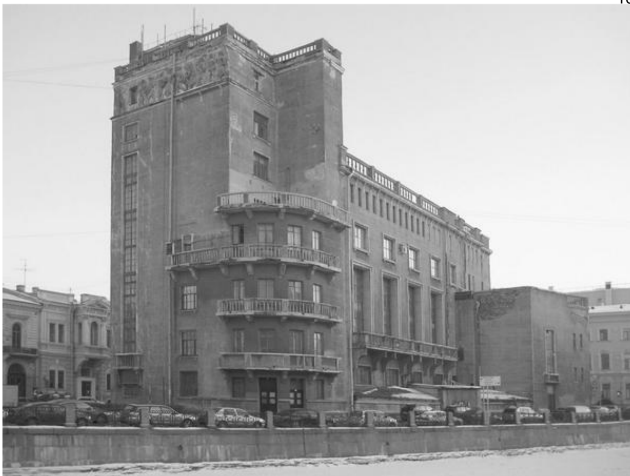
53. 2012. Дворец культуры работников связи. Фасад по улице Герцена. https://storage.yandexcloud.net/wr4img/307706_94_i_086.jpg
