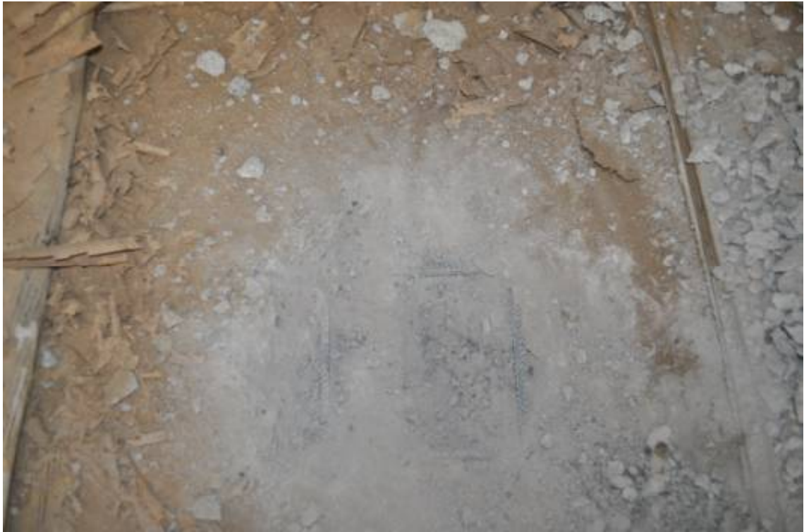
Фото 35. Вскрытие №4 (со стороны пола 2 этажа)
