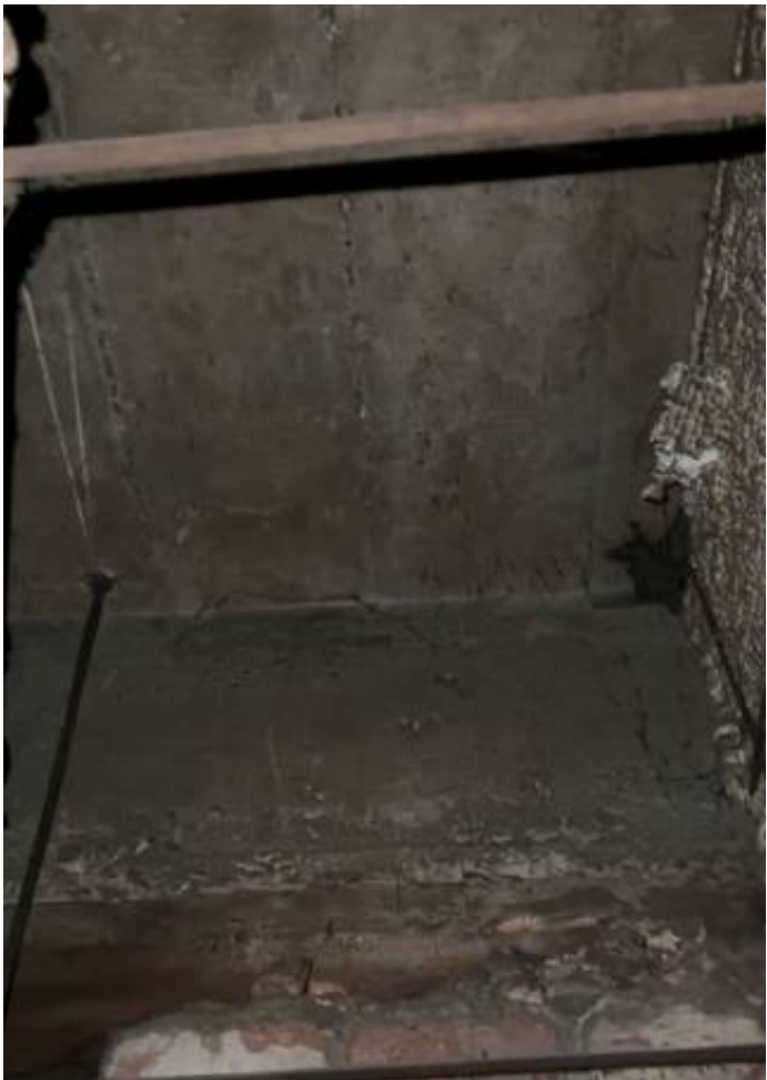
Фото 34. Вскрытие №4 (со стороны помещения 1 этажа).
