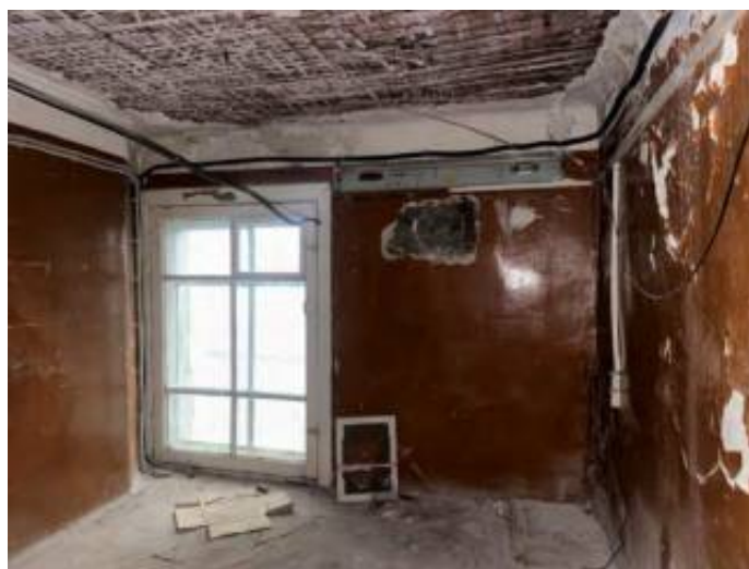
Фотография 112. Выявленный объект культурного наследия. Дом культуры работников связи (быв. Немецкая реформатская церковь). Дата съемки: 01.02.2026
