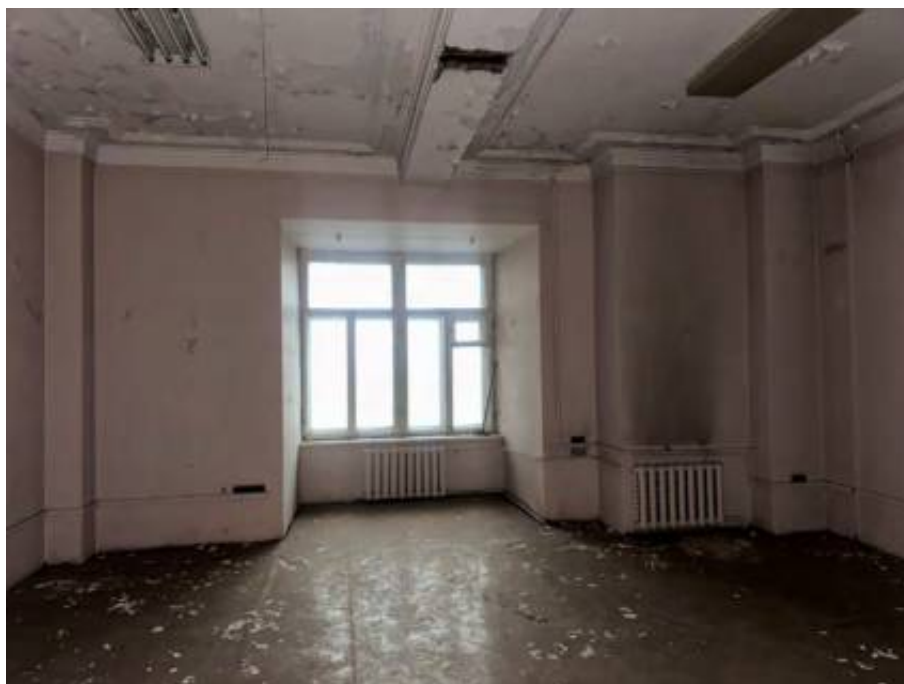
Фотография 109. Выявленный объект культурного наследия. Дом культуры работников связи (быв. Немецкая реформатская церковь). Дата съемки: 01.02.2026
