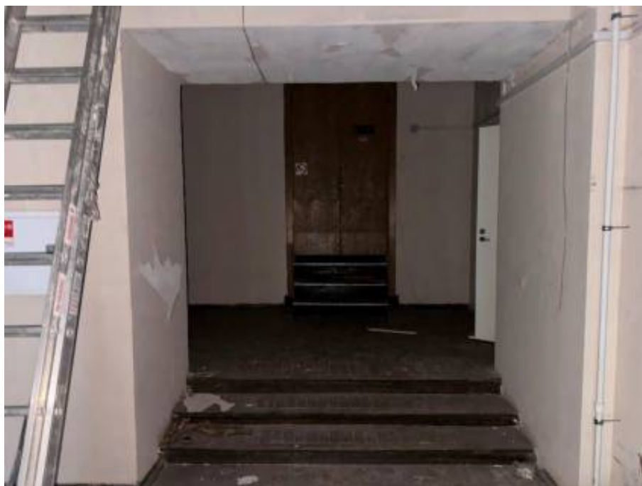
Фотография 48 Выявленный объект культурного наследия. Дом культуры работников связи (быв. Немецкая реформатская церковь) . Дата съемки: 01.02.2026
