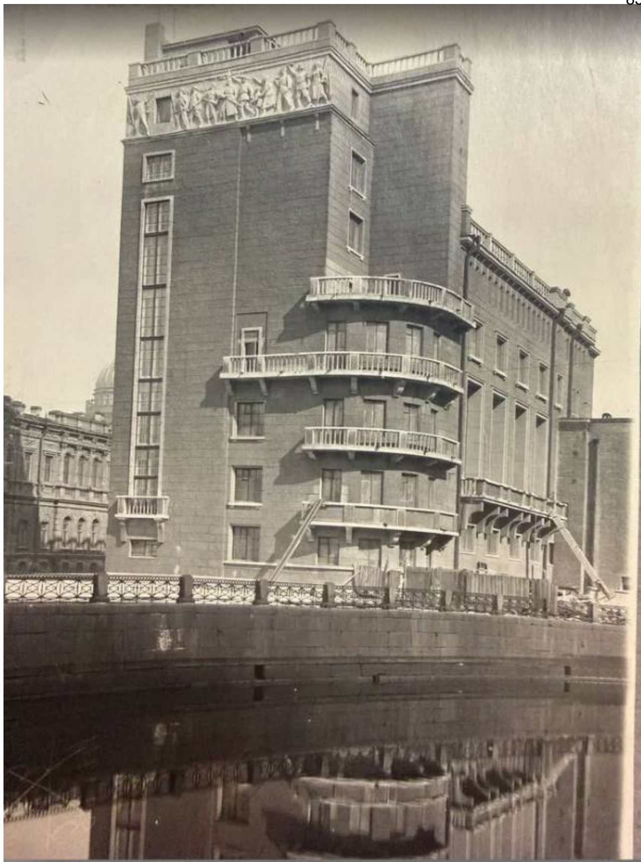
23. 1936. Фото. Внешний вид боковой части здания Клуба работников связи. ЦГАКФФД Гр 59153
