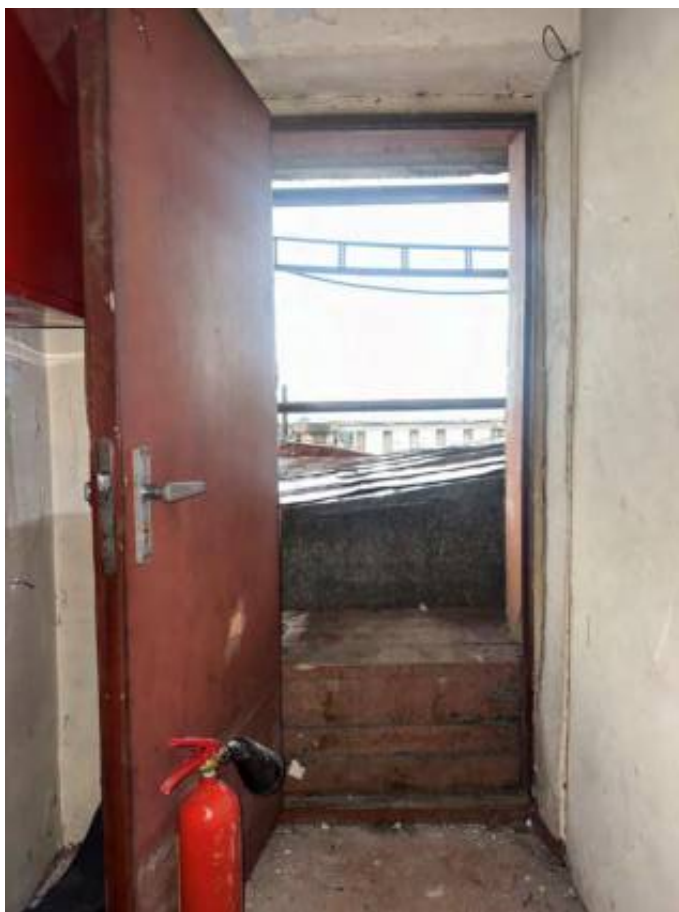
Фотография 110. Выявленный объект культурного наследия. Дом культуры работников связи (быв. Немецкая реформатская церковь). Дата съемки: 01.02.2026
