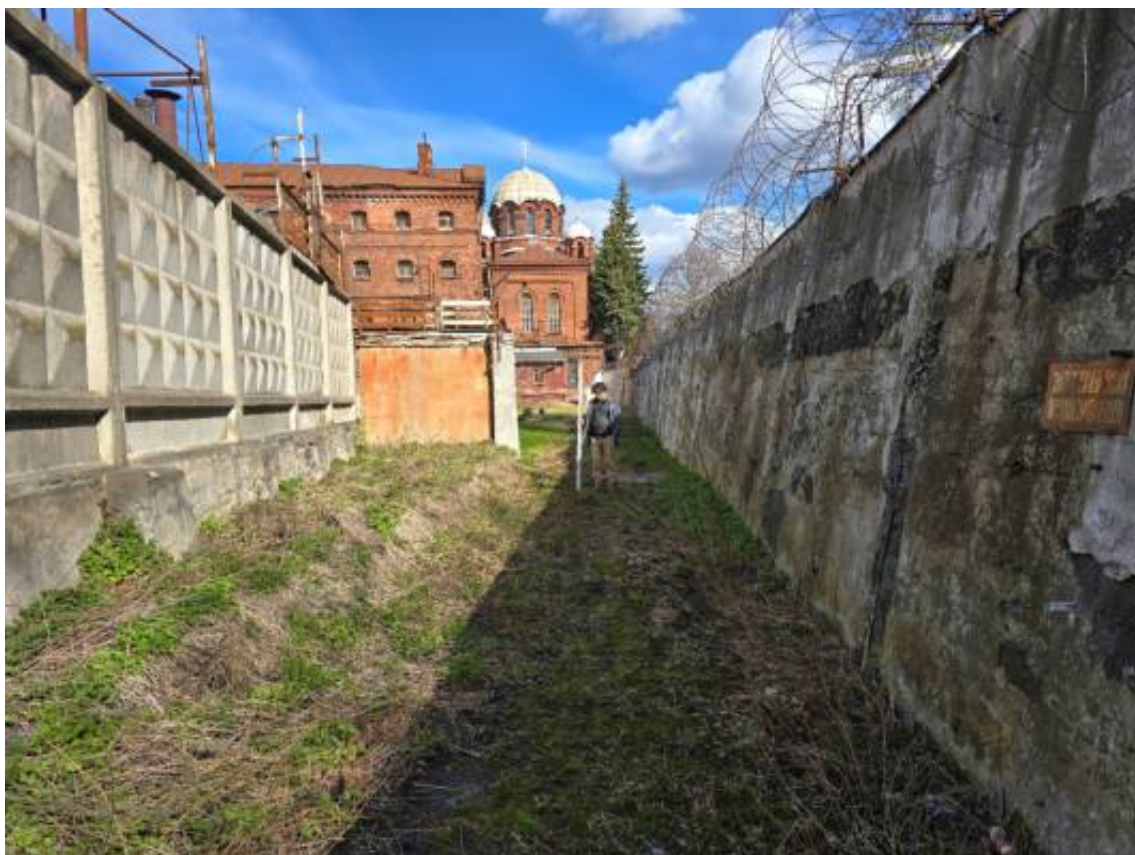
Илл. 60. Санкт-Петербург, Арсенальная набережная, дом 7. Точка фотофиксации № 29. Вид с запада.
