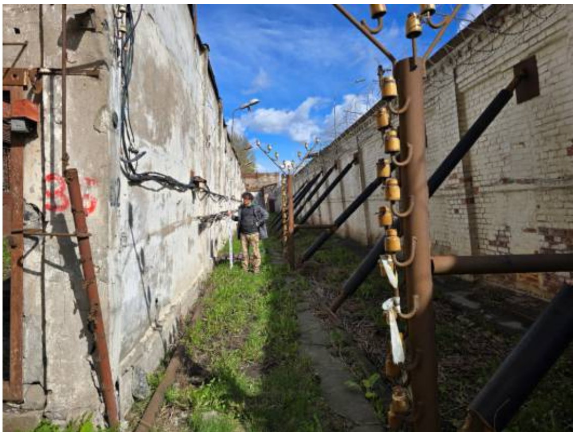
Илл. 40. Санкт-Петербург, Арсенальная набережная, дом 7. Точка фотофиксации № 9. Вид с запада.
