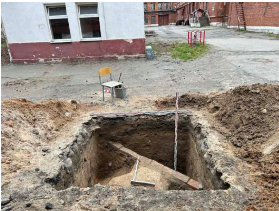
Илл. 112. Санкт-Петербург, Арсенальная набережная, дом 7. Шурф 3 по завершении работ. Общий вид с юга.
