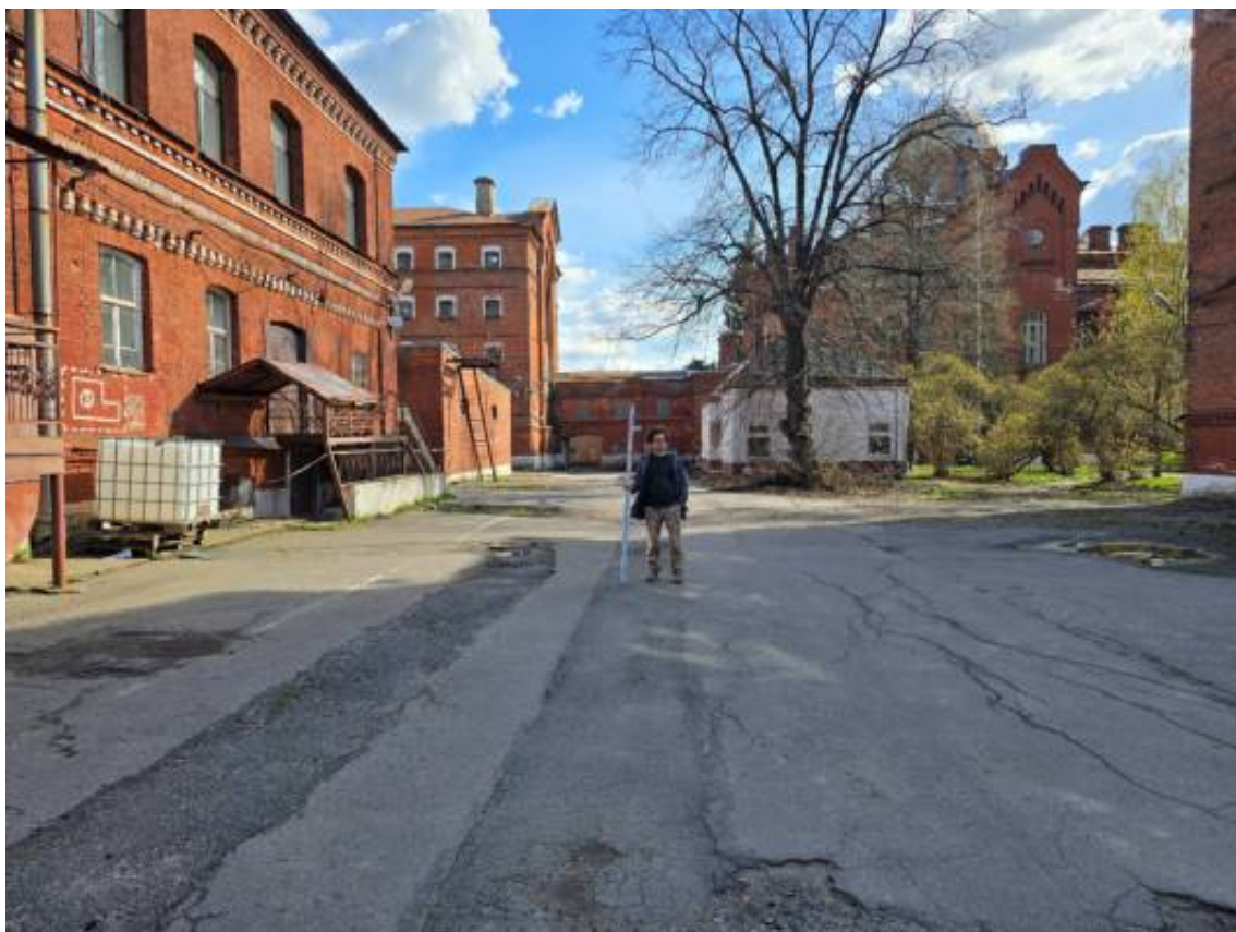
Илл. 52. Санкт-Петербург, Арсенальная набережная, дом 7. Точка фотофиксации № 21. Вид с севера.
