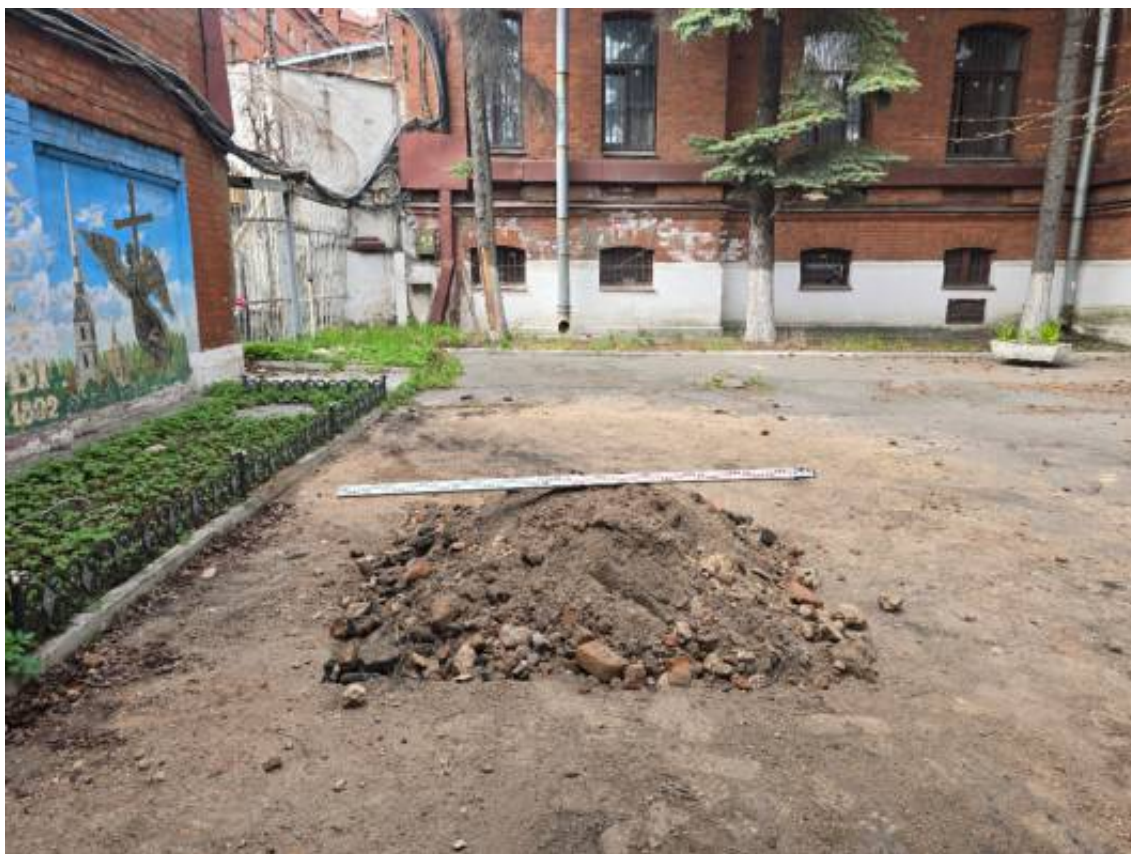
Илл.79. Санкт-Петербург, Арсенальная набережная, дом 7. Шурф 1 после рекультивации. Вид с юга.
