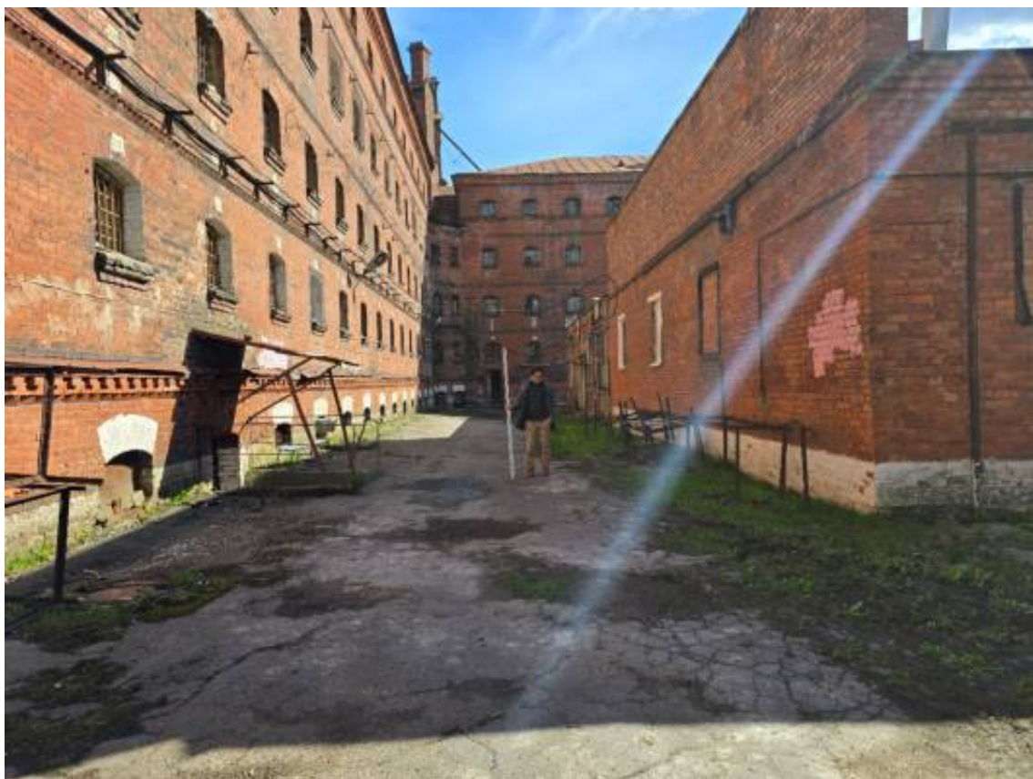
Илл. 56. Санкт-Петербург, Арсенальная набережная, дом 7. Точка фотофиксации № 25. Вид с севера.
