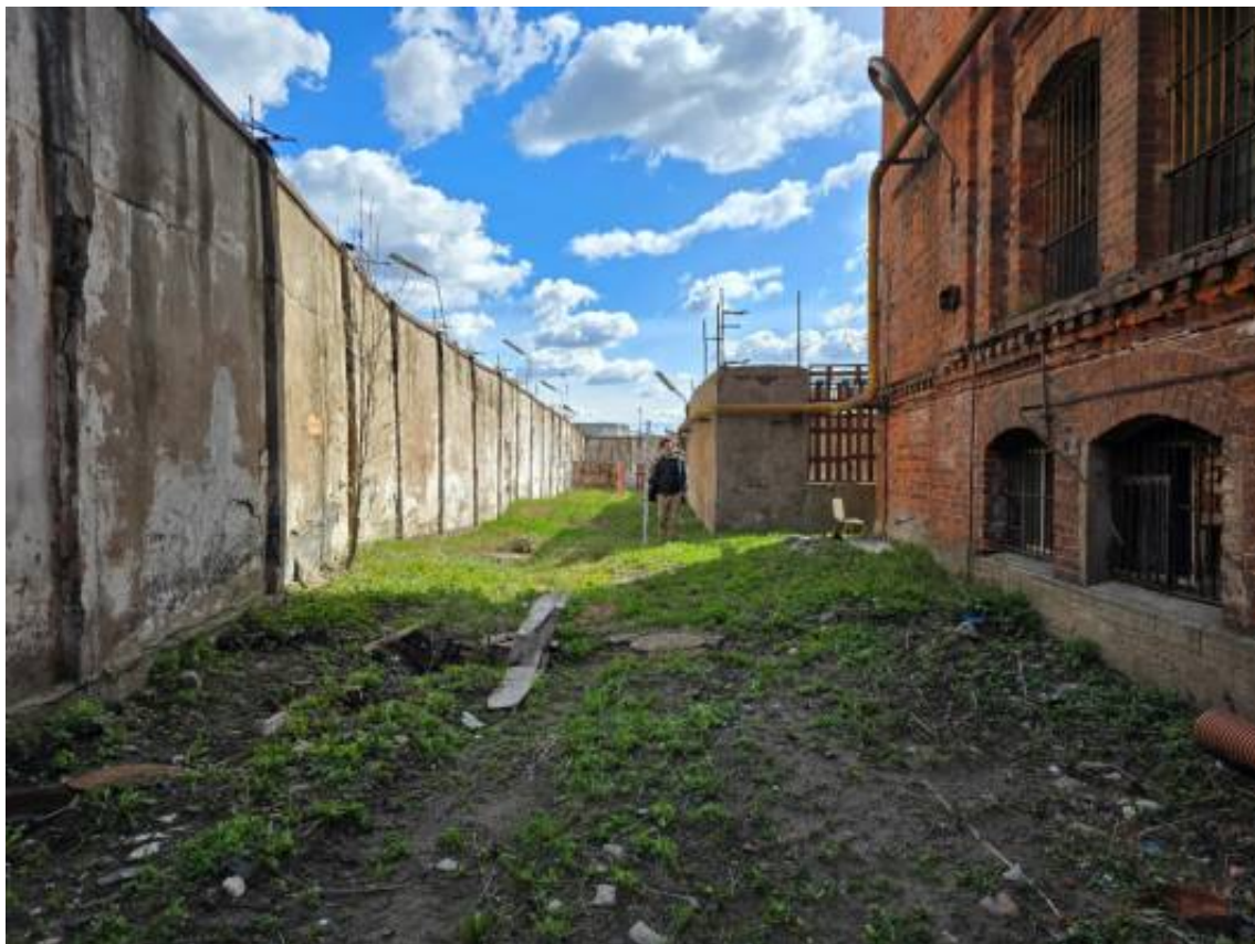
Илл. 37. Санкт-Петербург, Арсенальная набережная, дом 7. Точка фотофиксации № 6. Вид с севера.
