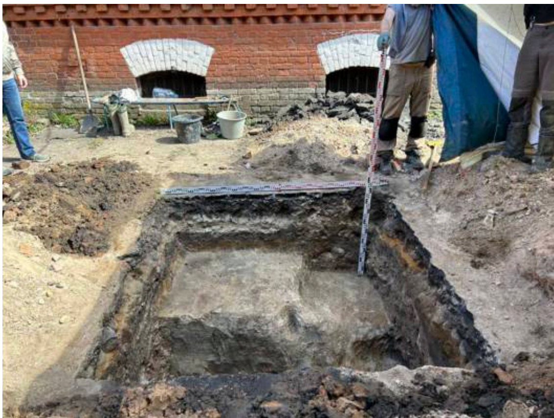
Илл. 122. Санкт-Петербург, Арсенальная набережная, дом 7. Шурф 4 по завершении работ. Общий вид с запада.
