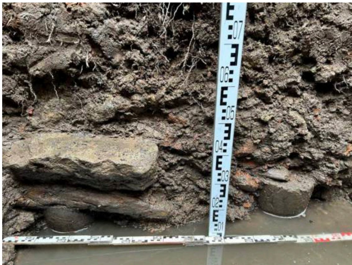
Илл. 71. Санкт-Петербург, Арсенальная набережная, дом 7. Шурф 1. Деревянные сваи с остатками лаг в основании известняковой кладки, разрушенной перекопом. Деталь. Вид с запада.
