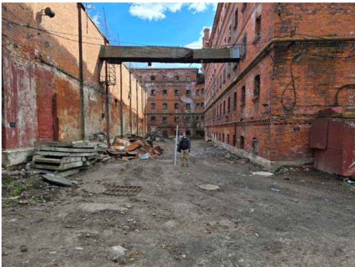
Илл. 34. Санкт-Петербург, Арсенальная набережная, дом 7. Точка фотофиксации № 3. Вид с севера.
