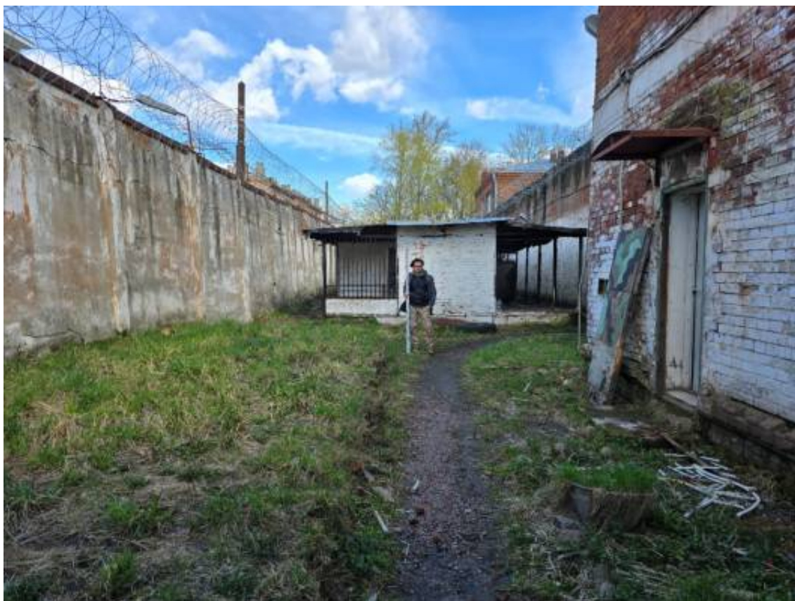
Илл. 50. Санкт-Петербург, Арсенальная набережная, дом 7. Точка фотофиксации № 19. Вид с запада.
