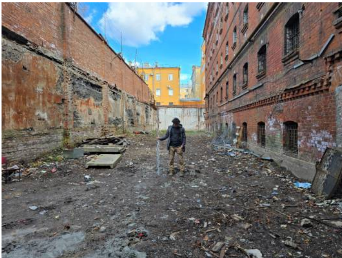
Илл. 36. Санкт-Петербург, Арсенальная набережная, дом 7. Точка фотофиксации № 5. Вид с запада.
