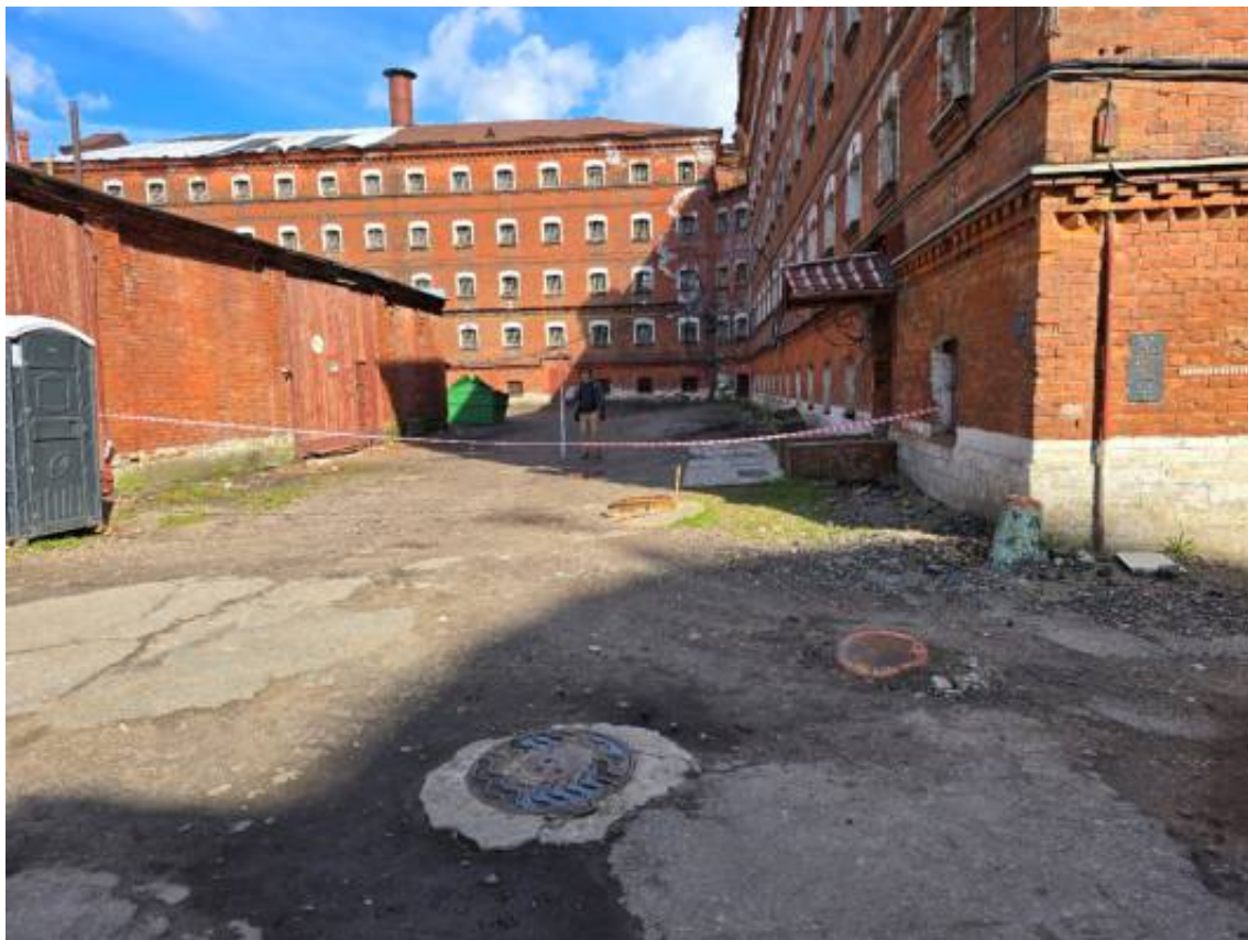
Илл. 47. Санкт-Петербург, Арсенальная набережная, дом 7. Точка фотофиксации № 16. Вид с запада.
