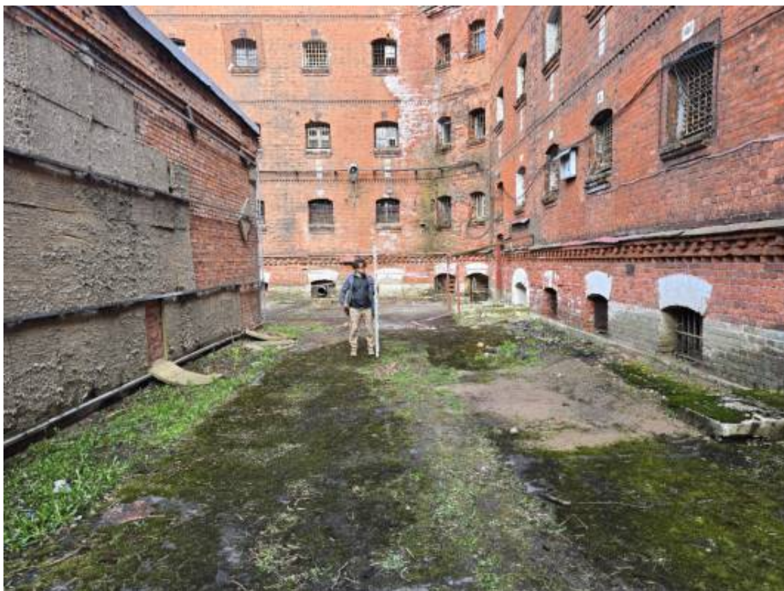
Илл. 62. Санкт-Петербург, Арсенальная набережная, дом 7. Точка фотофиксации № 31. Вид с запада.
