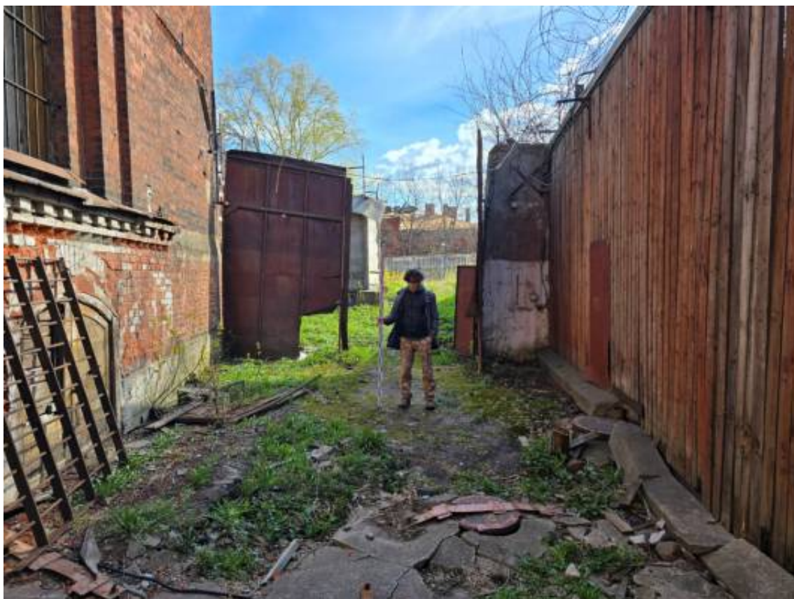
Илл. 58. Санкт-Петербург, Арсенальная набережная, дом 7. Точка фотофиксации № 27. Вид с севера.
