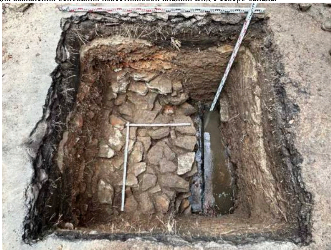
Илл. 68. Санкт-Петербург, Арсенальная набережная, дом 7. Шурф 1. Зачистка по уровню известняковой кладки и дна траншеи, углубленной в материк. Общий вид с юга.
