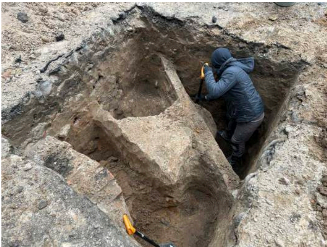
Илл. 110. Санкт-Петербург, Арсенальная набережная, дом 7. Шурф 3. Рабочий момент выборки заполнения перекопов. Вид с юго-востока.
