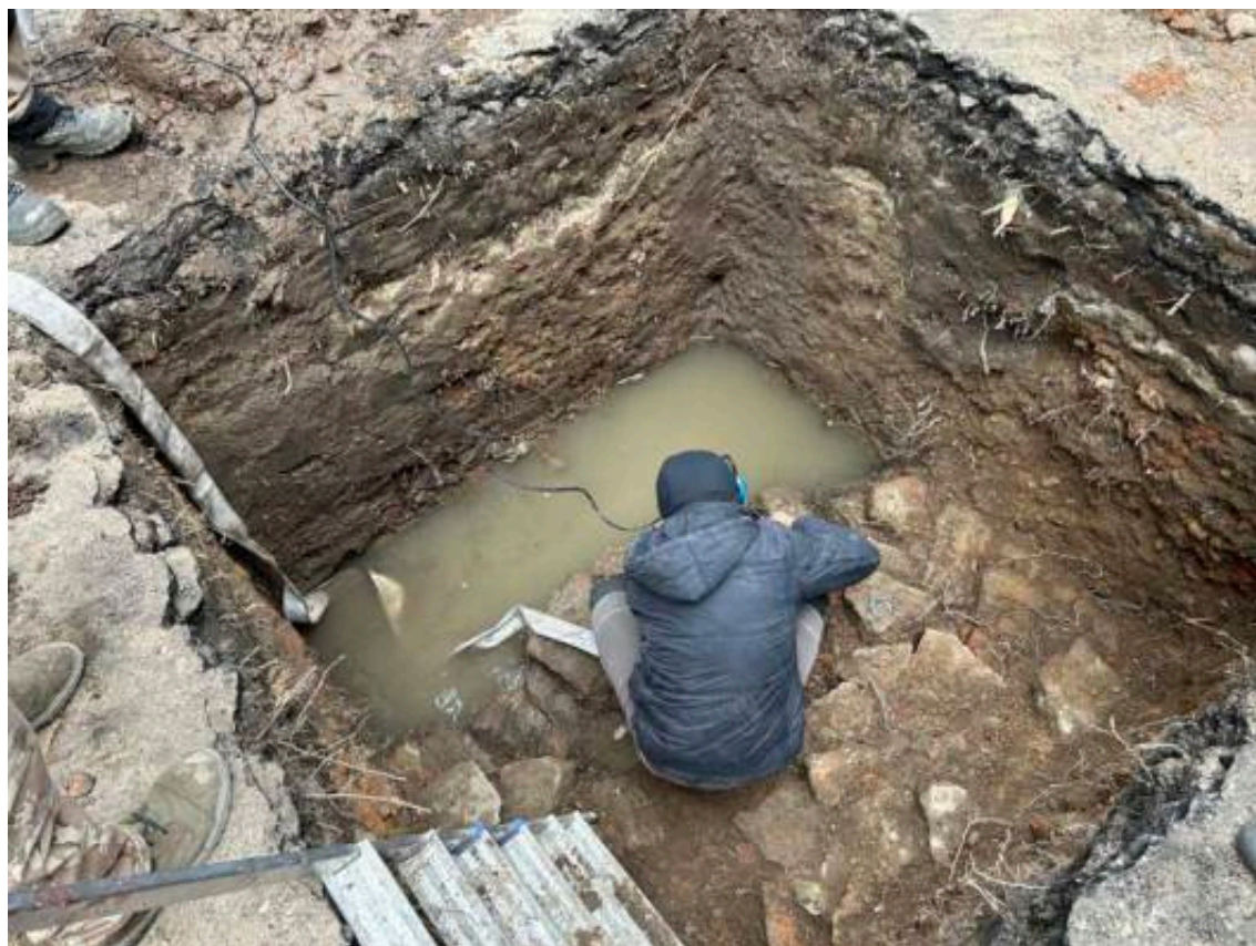
Илл. 67. Санкт-Петербург, Арсенальная набережная, дом 7. Шурф 1. Рабочий момент. Откачка воды для выявления основания известняковой кладки. Вид с северо-запада.
