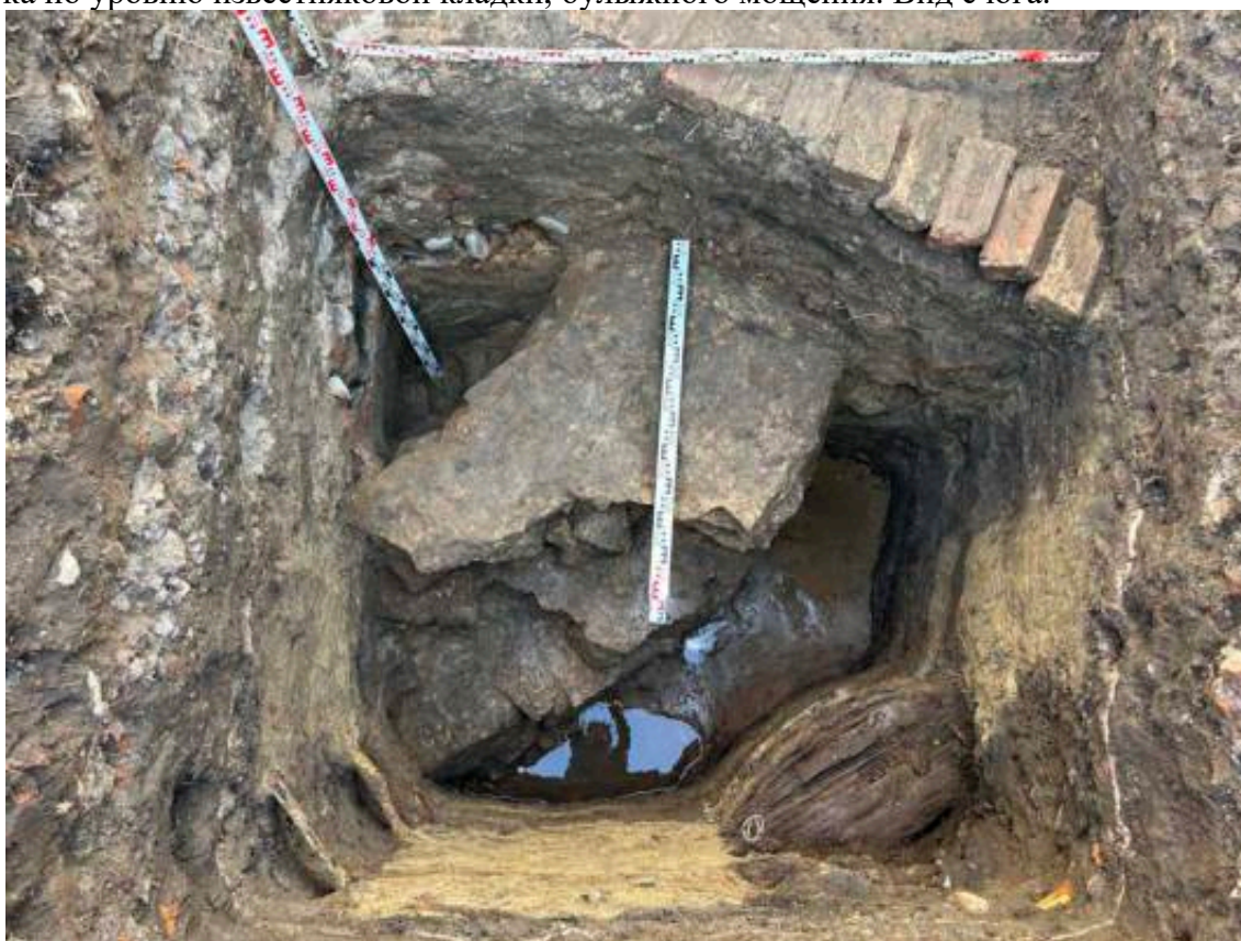
Илл. 82. Санкт-Петербург, Арсенальная набережная, дом 7. Шурф перед расширением. Зачистка по матерiku Вид с юга.
