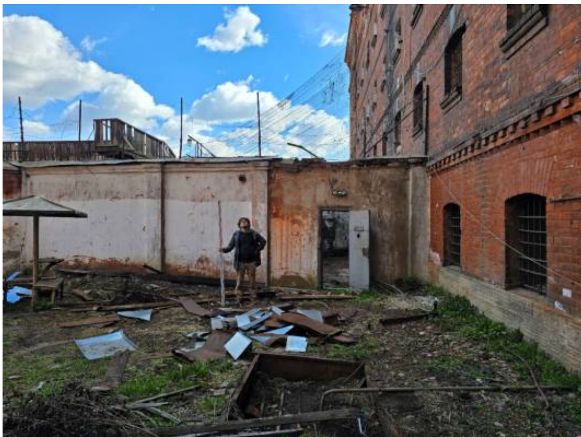
Илл. 38. Санкт-Петербург, Арсенальная набережная, дом 7. Точка фотофиксации № 7. Вид с севера.
