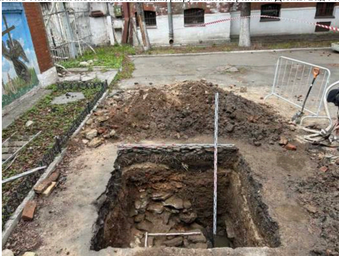
Илл. 72. Санкт-Петербург, Арсенальная набережная, дом 7. Шурф 1 по завершении работ. Общий вид с юга.
