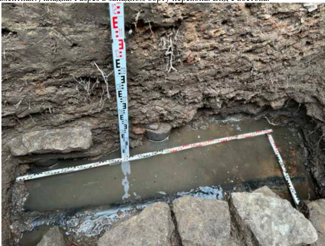
Илл. 70. Санкт-Петербург, Арсенальная набережная, дом 7. Шурф 1. Дно перекопа с канализационной трубой. Деревянные сваи в восточном борту шурфа. Вид с запада.
