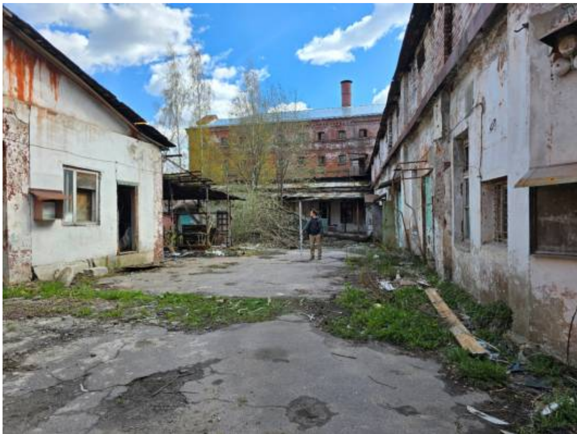
Илл. 35. Санкт-Петербург, Арсенальная набережная, дом 7. Точка фотофиксации № 4. Вид с севера.
