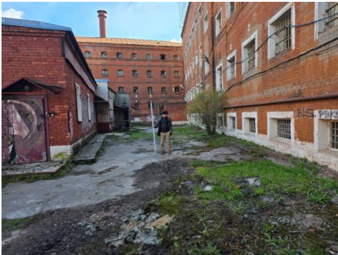
Илл. 57. Санкт-Петербург, Арсенальная набережная, дом 7. Точка фотофиксации № 26. Вид с севера.
