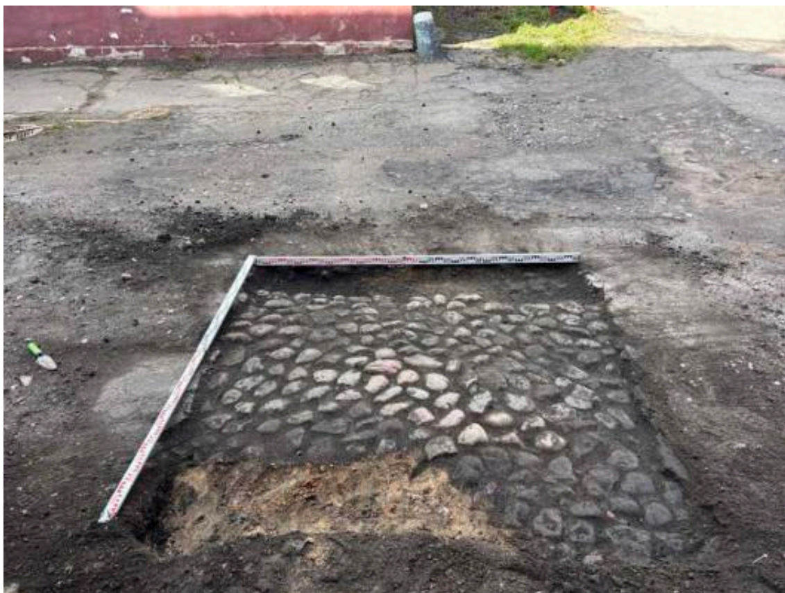
Илл. 108. Санкт-Петербург, Арсенальная набережная, дом 7. Шурф 3. Зачистка по уровню булыжного мощения. Общий вид с юга.
