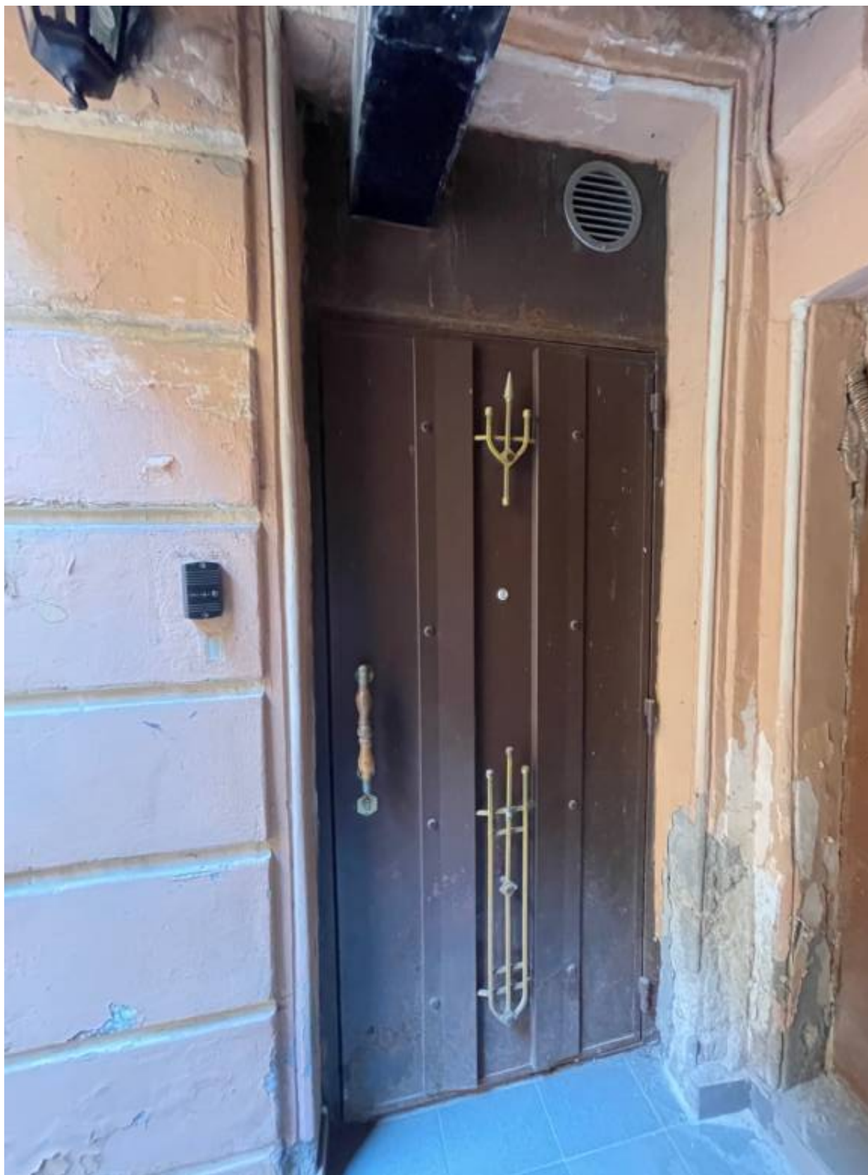
5. Входная дверь в помещение 1-Н со стороны двора.
