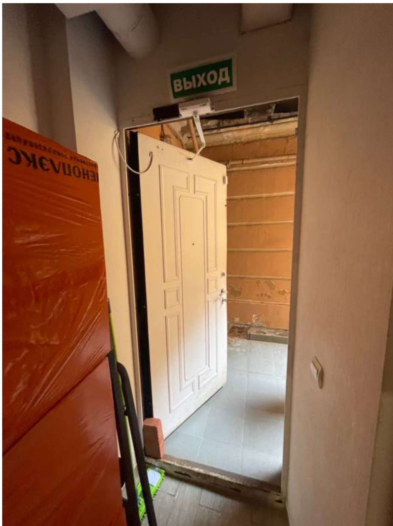
19. Вид входной двери со стороны двора изнутри.
