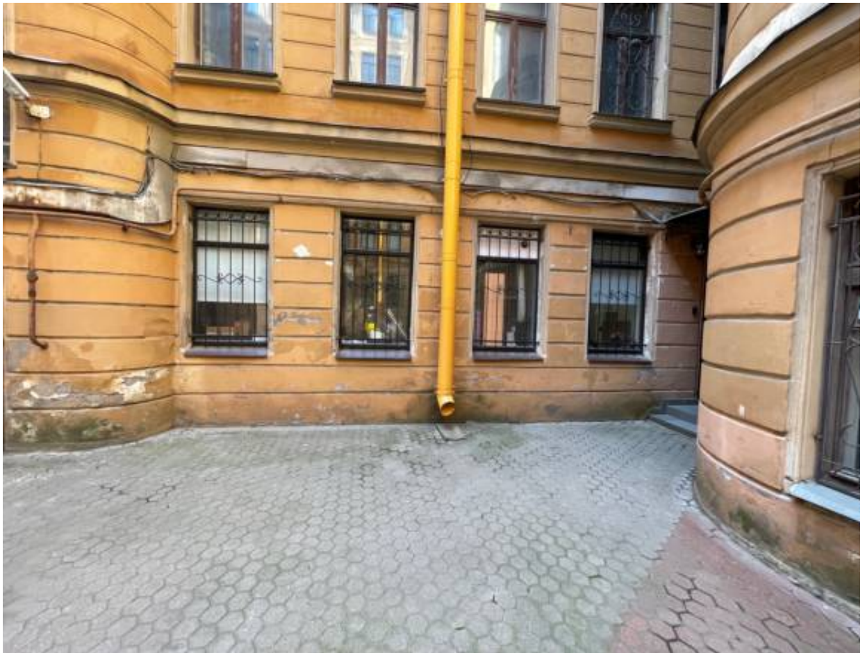
4. Фрагмент дворового фасада. Оконные проемы помещения 1-Н.
