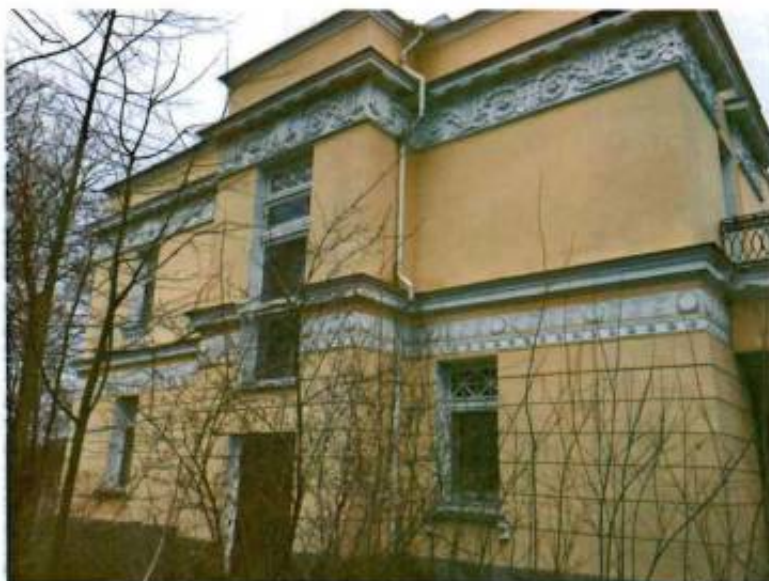
4. Юго-восточный фасад здания.
