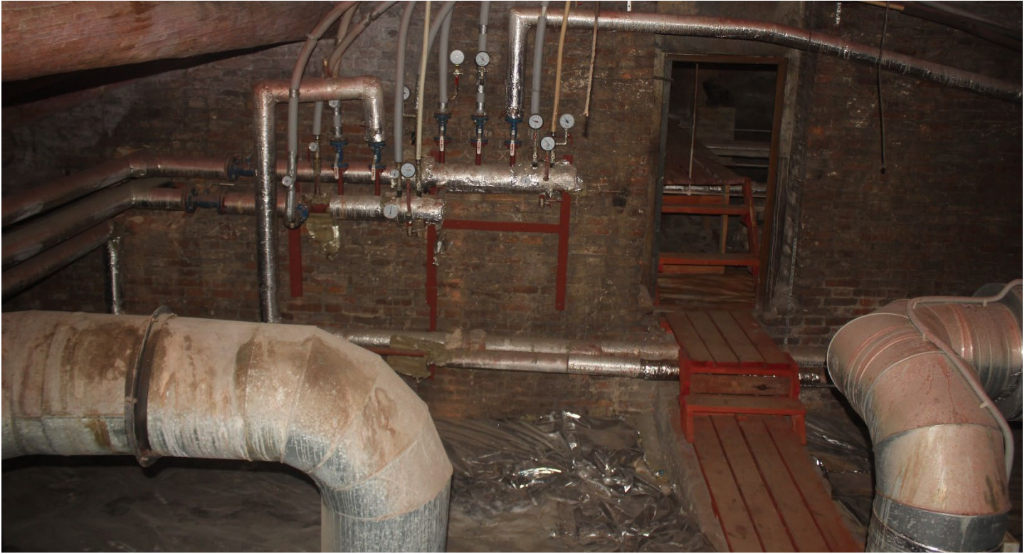
Фото 24. 6-ой корпус. Объем чердака. Фрагмент. Дата фотофиксации: 02.06.26
