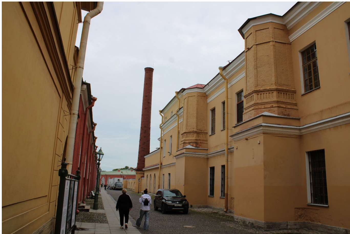
Фото 7. 7-ой корпус. Западный фасад. Фрагмент. Дата фотофиксации: 02.06.26
