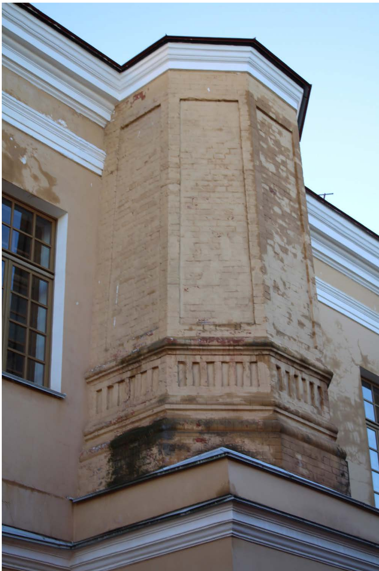
34.Монетный двор. Корпус 7. Основание трубы. 2025.
