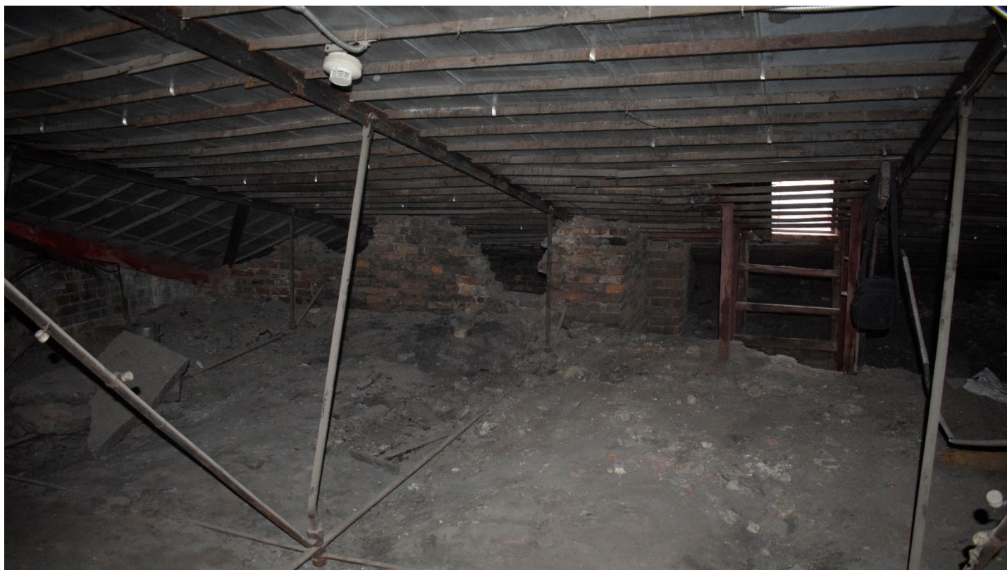
Фото 20. 6-ой корпус. Объем чердака. Фрагмент. Дата фотофиксации: 02.06.26
