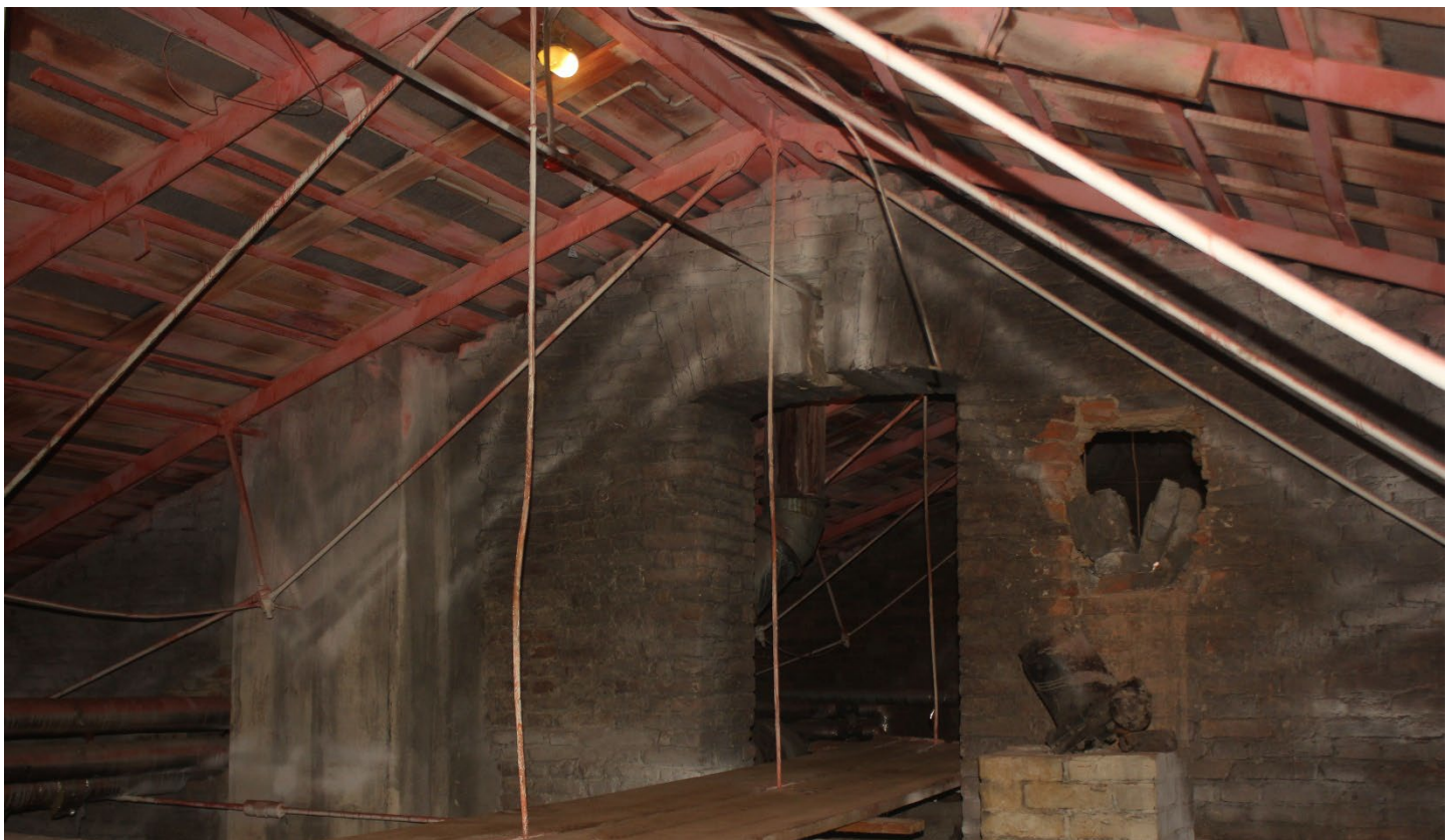
Фото 23. 6-ой корпус. Объем чердака. Фрагмент. Дата фотофиксации: 02.06.26
