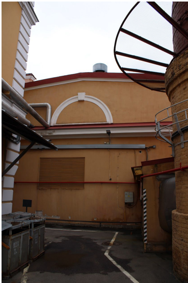
Фото 19. Северный фасад, 7-ой корпус. Фрагмент. Дата фотофиксации: 02.06.26
