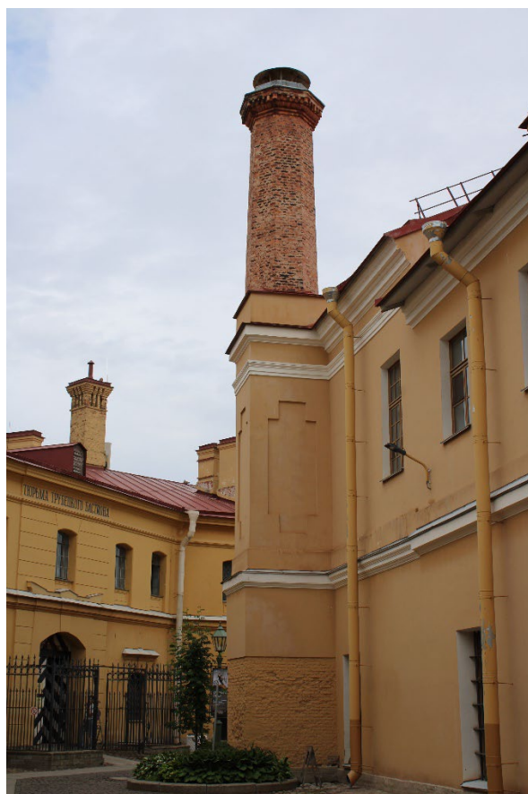
Фото 4. Дымоход. Южный фасад. Общий вид. Дата фотофиксации: 02.06.26
