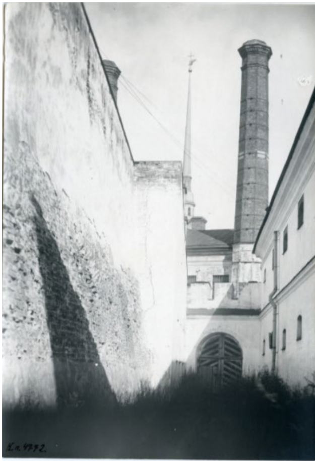
43. Петропавловская крепость. Трубецкой бастион. Нач. XX в. ? ГЦМСИР ГИК №4772/326
