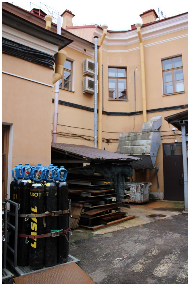
Фото 15. 7-ой корпус. Дворовый (восточный) фасад. Фрагмент. Дата фотофиксации: 02.06.26
