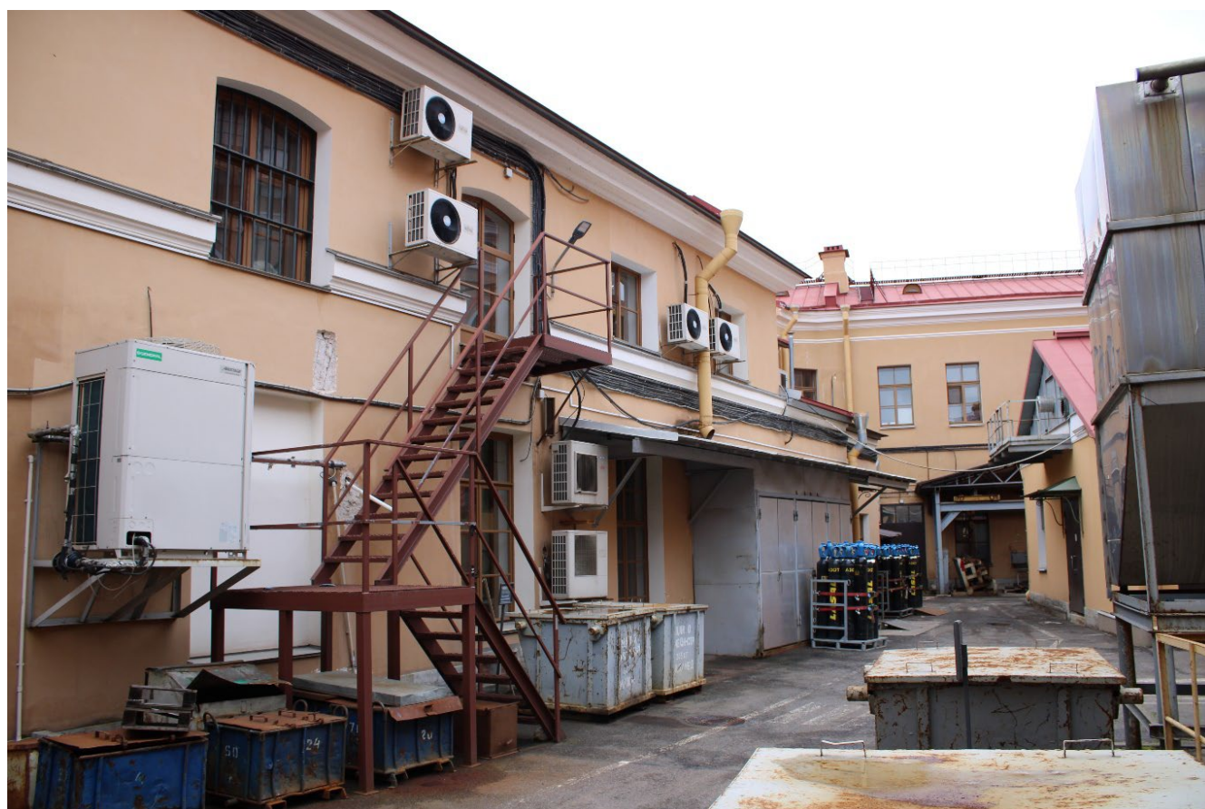
Фото 14. 6-ой корпус. Дворовый (восточный) фасад. Фрагмент. Дата фотофиксации: 02.06.26
