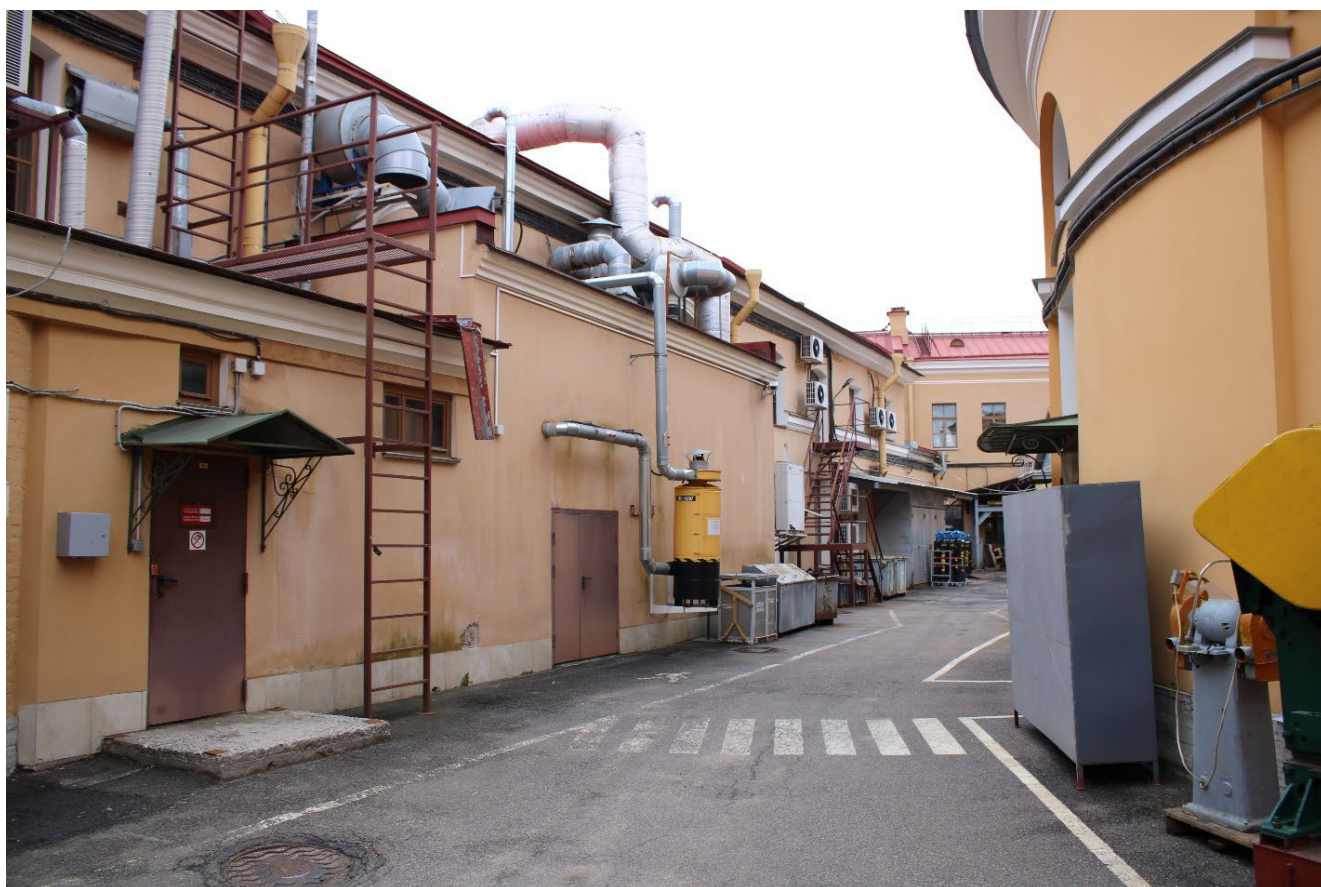
Фото 10. Дворовый (северный) фасад, 6-ой корпус. Фрагмент. Дата фотофиксации: 02.06.26
