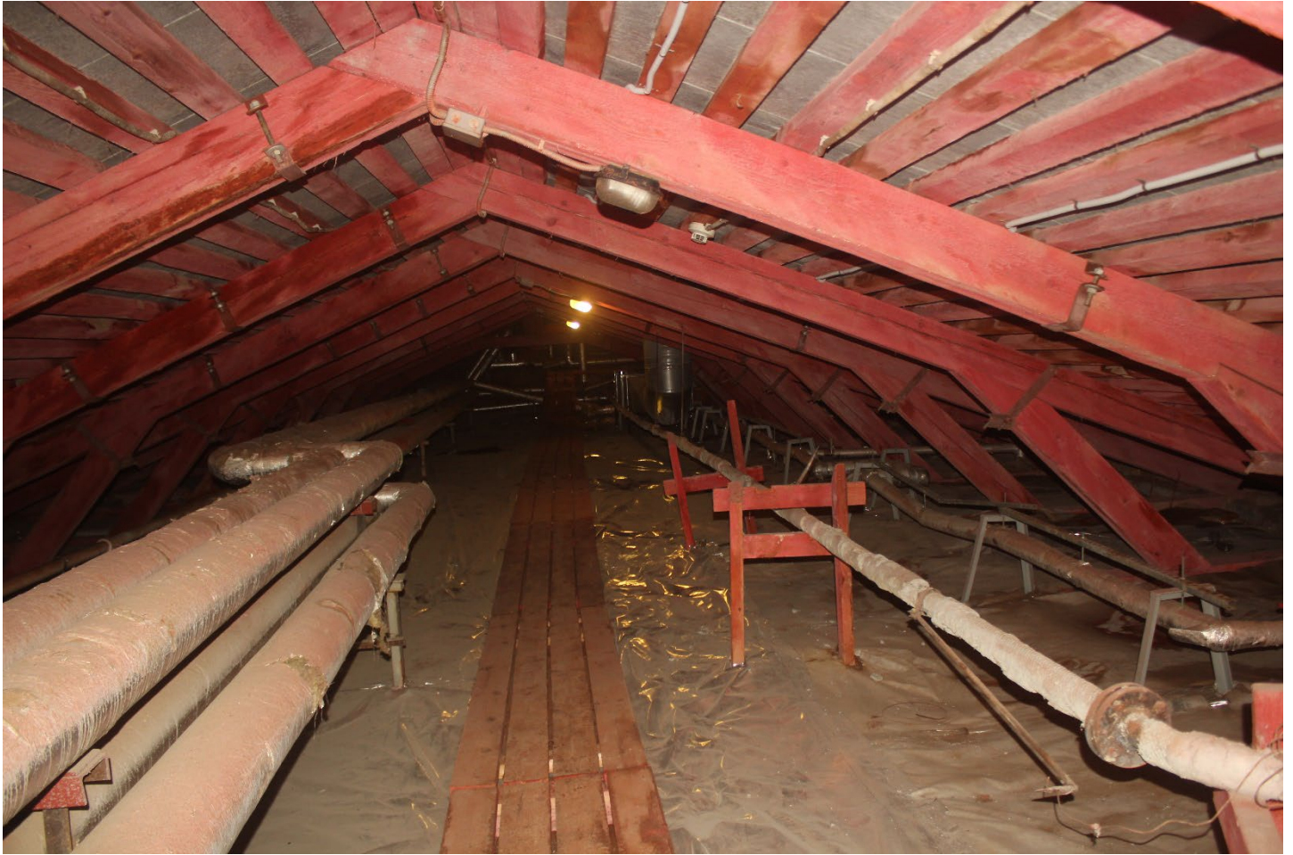
Фото 27. 7-ой корпус. Объем чердака. Фрагмент. Дата фотофиксации: 02.06.26
