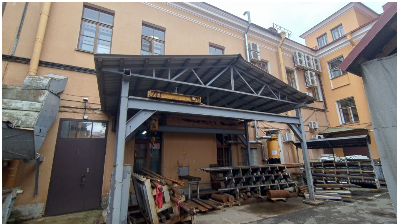
Фото 13. 6-ой корпус. Дворовый (северный) фасад. Фрагмент. Дата фотофиксации: 02.06.26
