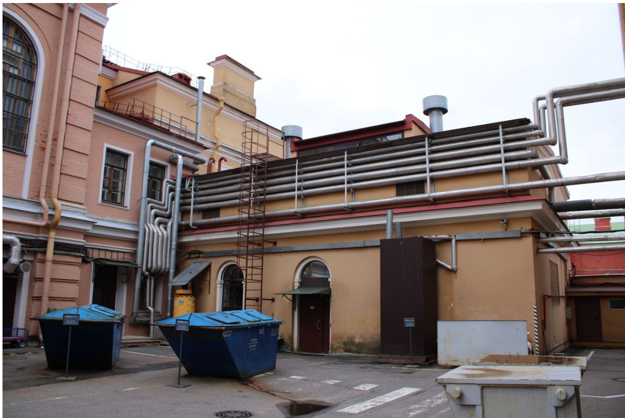
Фото 17. 7-ой корпус. Северо-восточный фасад. Фрагмент. Дата фотофиксации: 02.06.26
