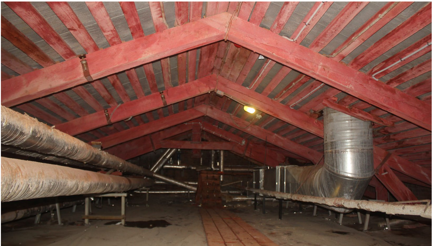
Фото 28. 7-ой корпус. Объем чердака. Фрагмент. Дата фотофиксации: 02.06.26
