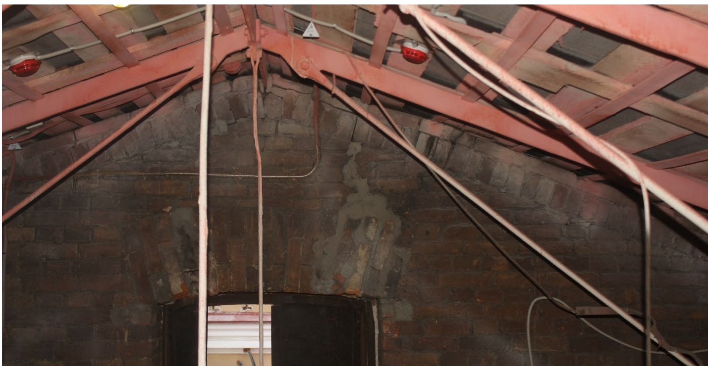
Фото 21. 6-ой корпус. Объем чердака. Фрагмент. Дата фотофиксации: 02.06.26
