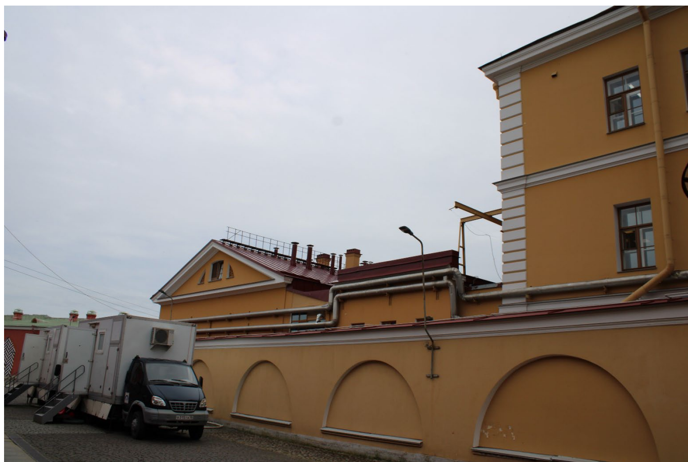
Фото 8. Западный фасад. 7-ой корпус. Фрагмент. Дата фотофиксации: 02.06.26
