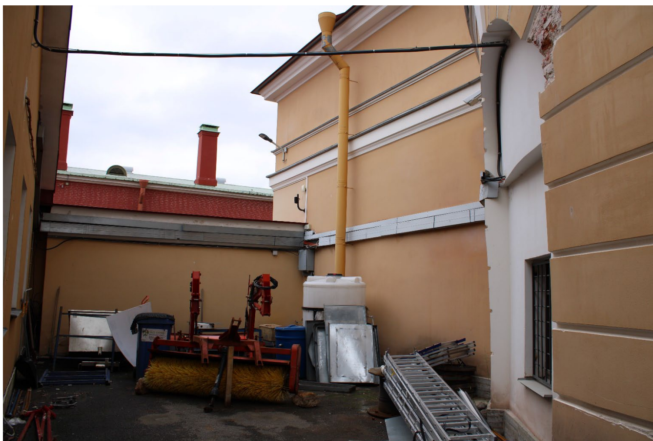
Фото 12. 6-ой корпус. Восточный фасад. Общий вид. Дата фотофиксации: 02.06.26
