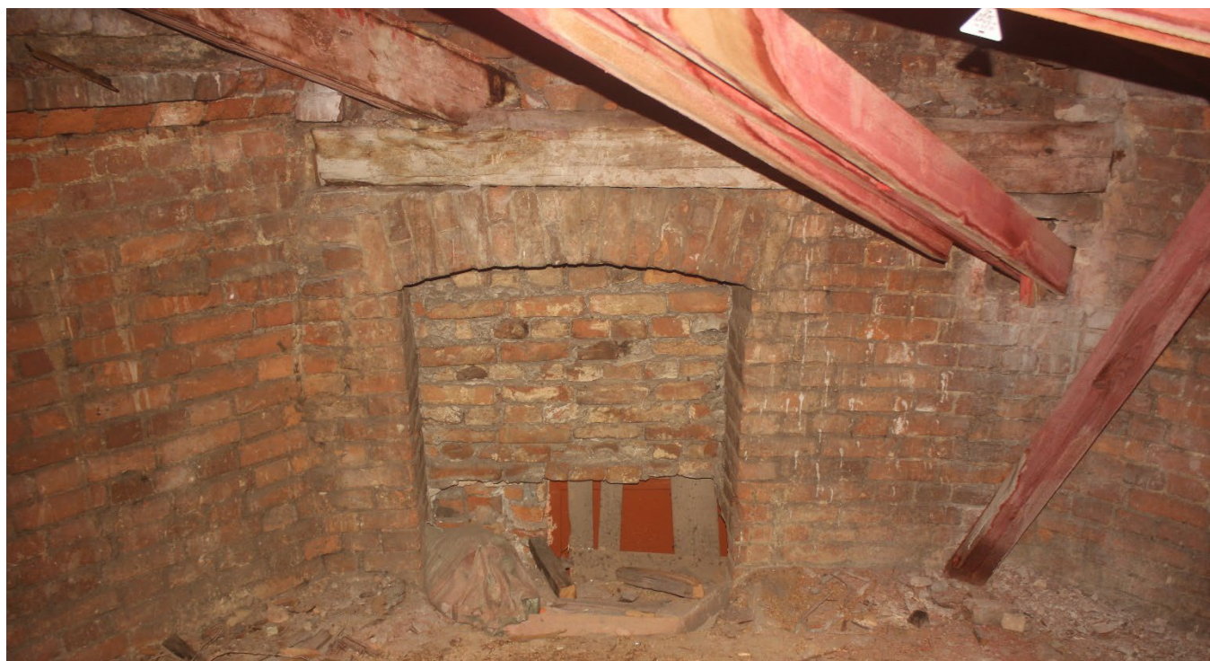
Фото 26. 7-ой корпус. Объем чердака. Заложенный портал. Фрагмент. Дата фотофиксации: 02.06.26
