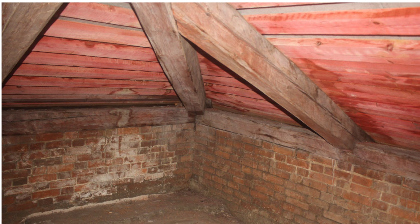
Фото 25. 7-ой корпус. Объем чердака. Деревянные стропила. Фрагмент. Дата фотофиксации: 02.06.26
