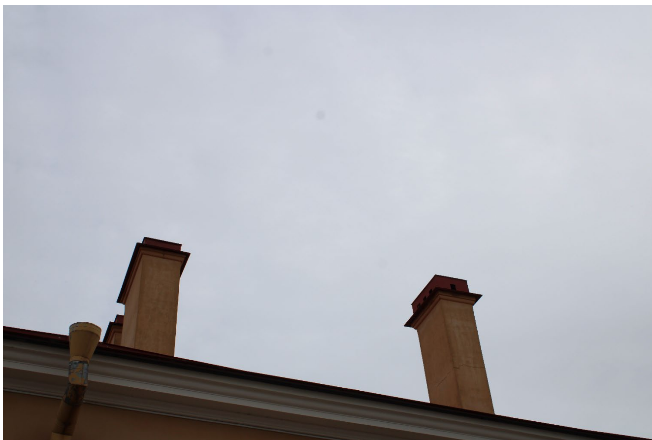
Фото 2. Дымоходы. 6-ой корпус. Южный фасад. Дата фотофиксации: 02.06.26
