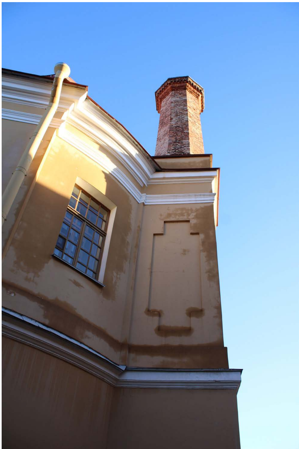
35.Монетный двор. Корпус 7. Труба в угловой части.2025.
