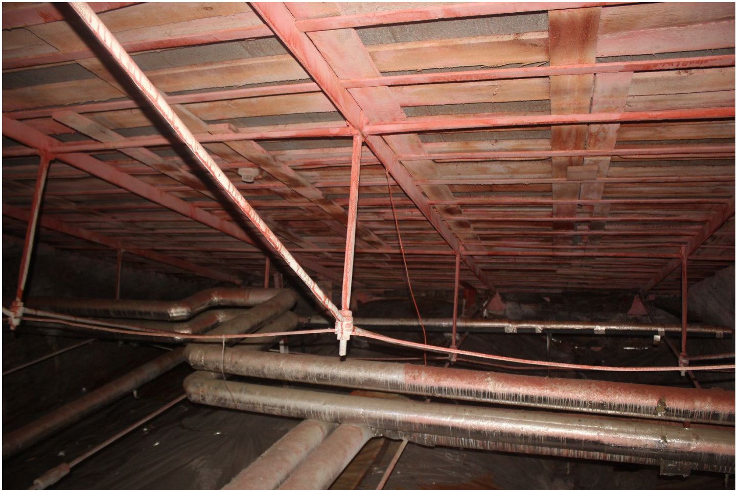
Фото 22. 6-ой корпус. Объем чердака. Фрагмент. Дата фотофиксации: 02.06.26
