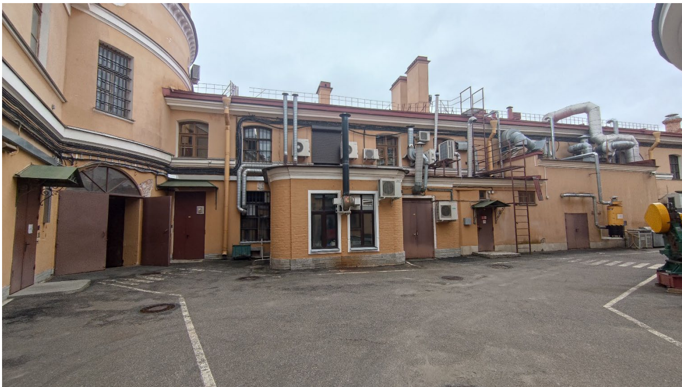
Фото 9. Дворовый (северный) фасад, 6-ой корпус. Фрагмент. Дата фотофиксации: 02.06.26
