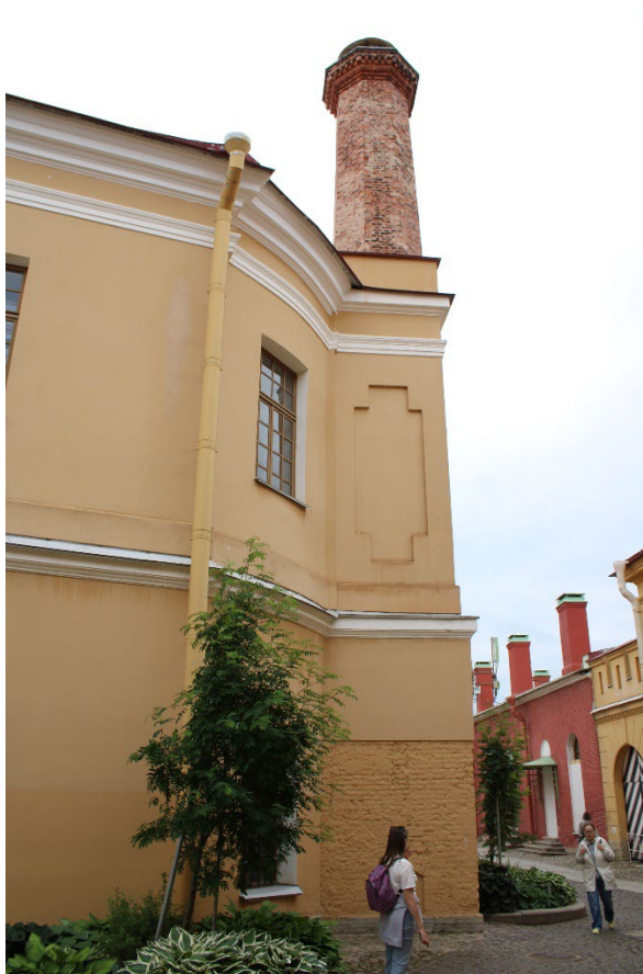
Фото 5. Дымоход. Южный фасад. Общий вид. Дата фотофиксации: 02.06.26
