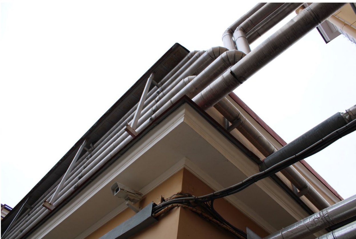
Фото 18. Межэтажный карниз. 7-ой корпус, северо-восточный фасад. Фрагмент. Дата фотофиксации: 02.06.26
