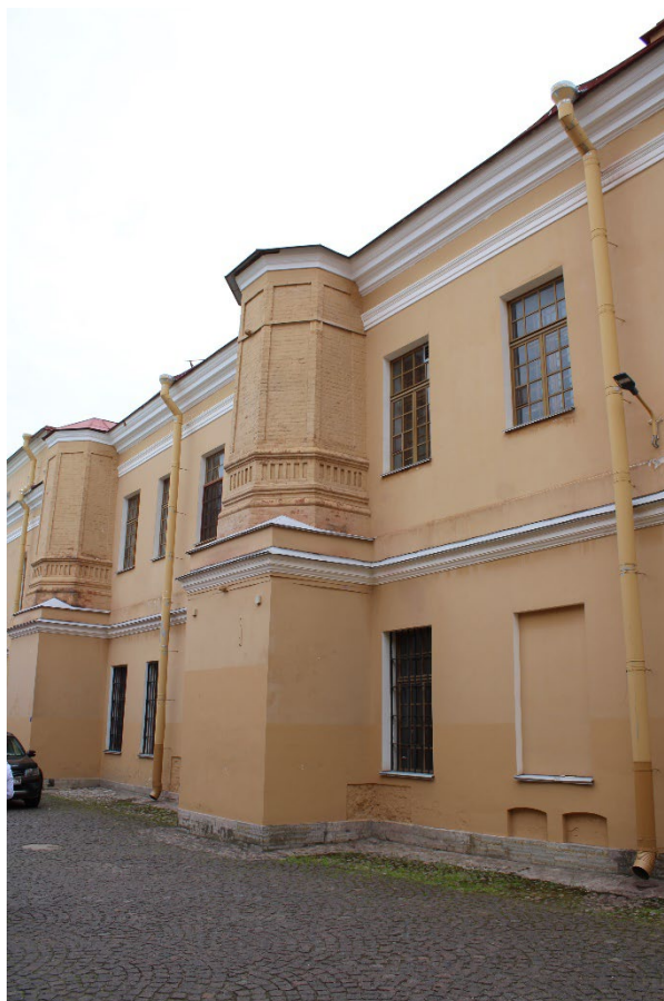
Фото 6. Основания дымовых труб. 7-ой корпус, западный фасад. Фрагмент. Дата фотофиксации: 02.06.26
