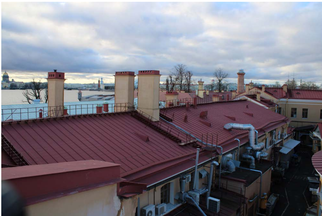
36.Монетныйдвор. Корпуса 6,7. Кровли.2025.
