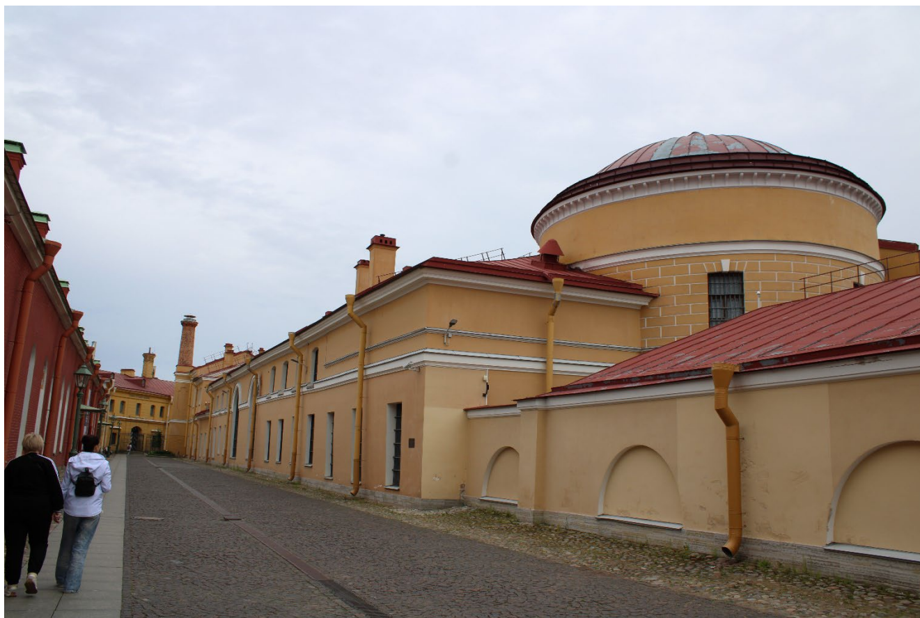
Фото 1. 6-ой корпус. Южный фасад. Общий вид. Дата фотофиксации: 02.06.26
