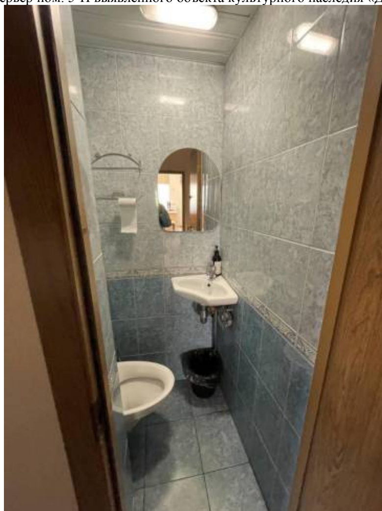
Фото 46. Интерьер пом. 5-Н выявленного объекта культурного наследия «Дом П. Панова»
