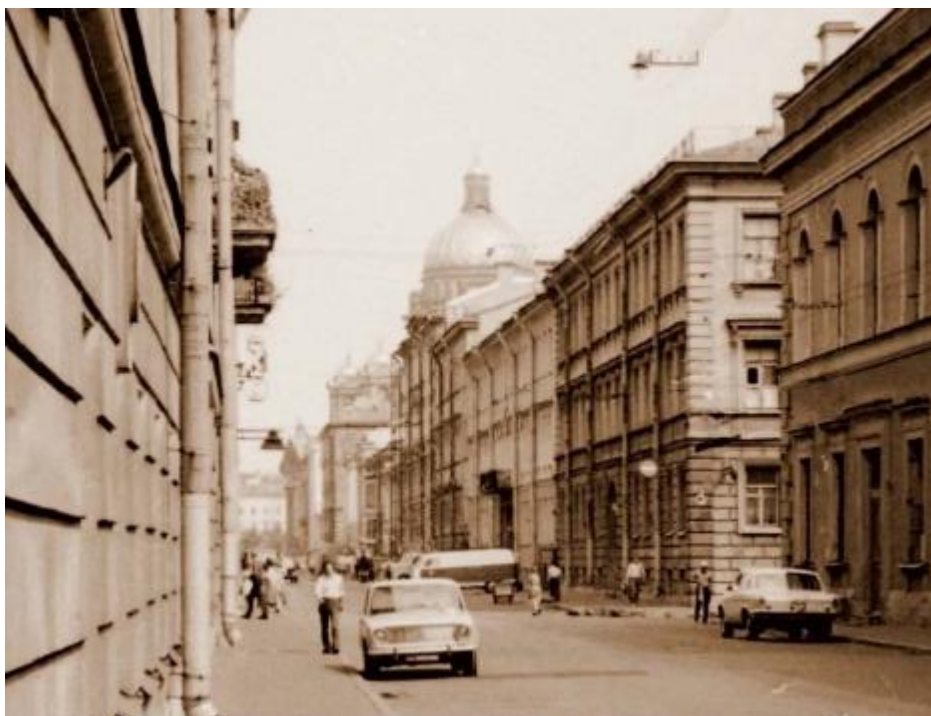
15. Улица Якубовича. 1958 г. — Дом Тампера // Citywalls.ru – архитектурный сайт Петербурга [Электронный ресурс]. URL: https://www.citywalls.ru/house744.html .
