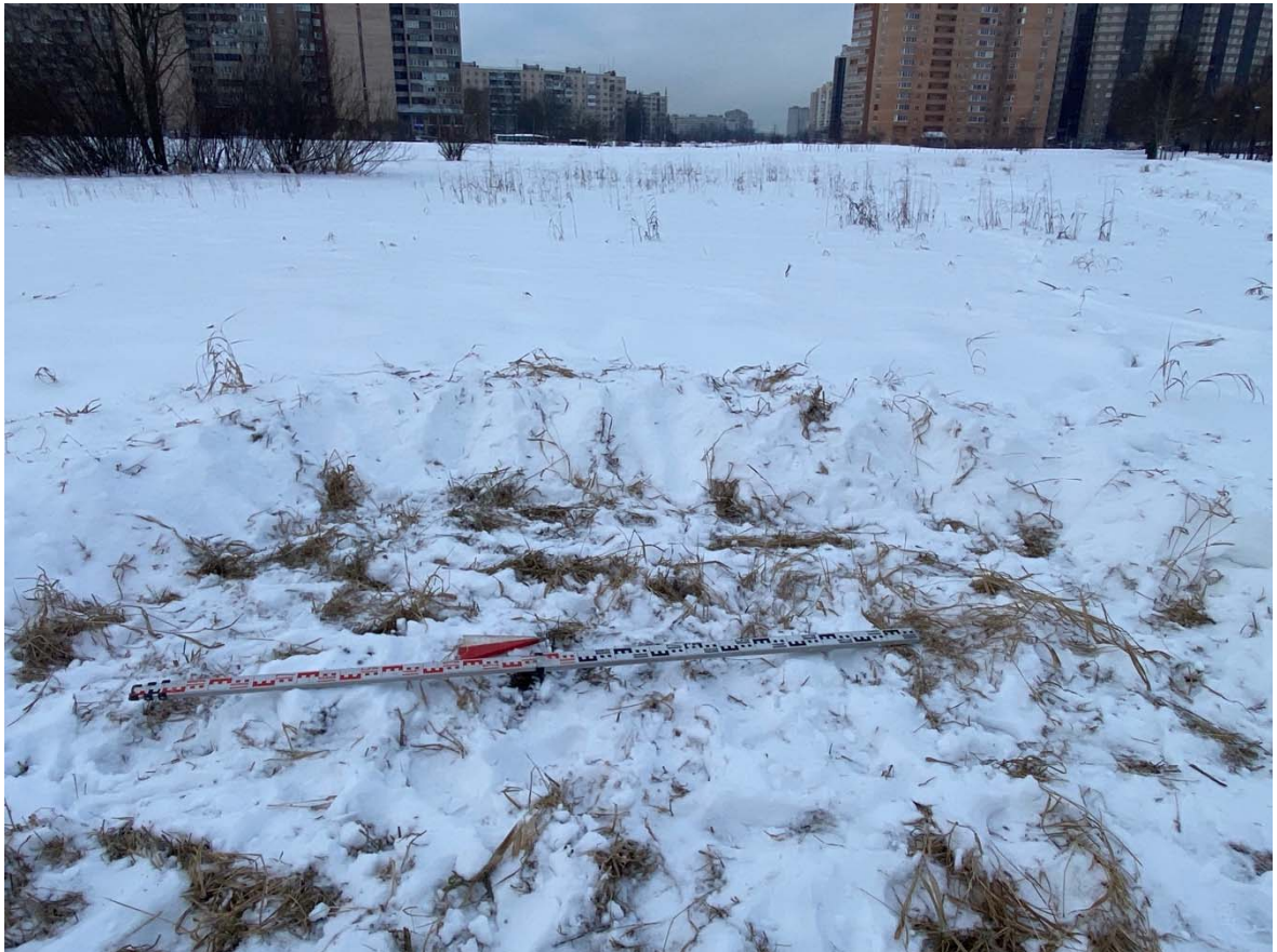
Рис. 38. Выполнение проектно-изыскательских работ по реконструкции водовода по адресу: г. Санкт-Петербург, Фрунзенский район, выход с Фрунзенской НС до Белградской ул. Поверхность на месте заложения Шурфа №2. Вид с востока
