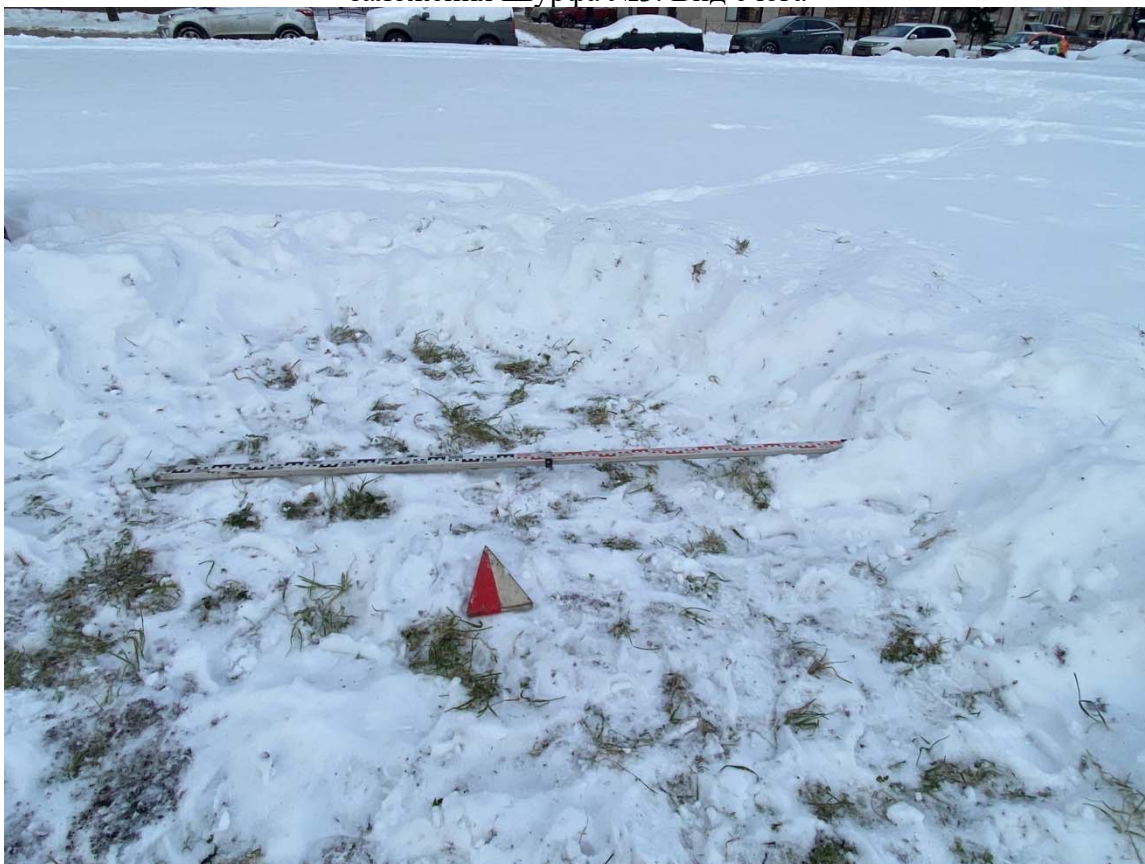
Рис. 43. Выполнение проектно-изыскательских работ по реконструкции водовода по адресу: г. Санкт-Петербург, Фрунзенский район, выход с Фрунзенской НС до Белградской ул. Поверхность на месте заложения Шурфа №3. Вид с юга
