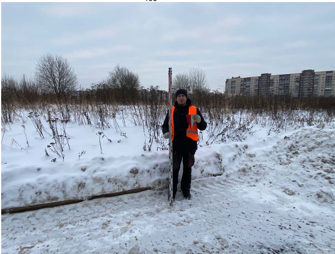
Рис. 30. Выполнение проектно-изыскательских работ по реконструкции водовода по адресу: г. Санкт-Петербург, Фрунзенский район, выход с Фрунзенской НС до Белградской ул. Photo 10. Общий вид территории обследования. Вид с севера
