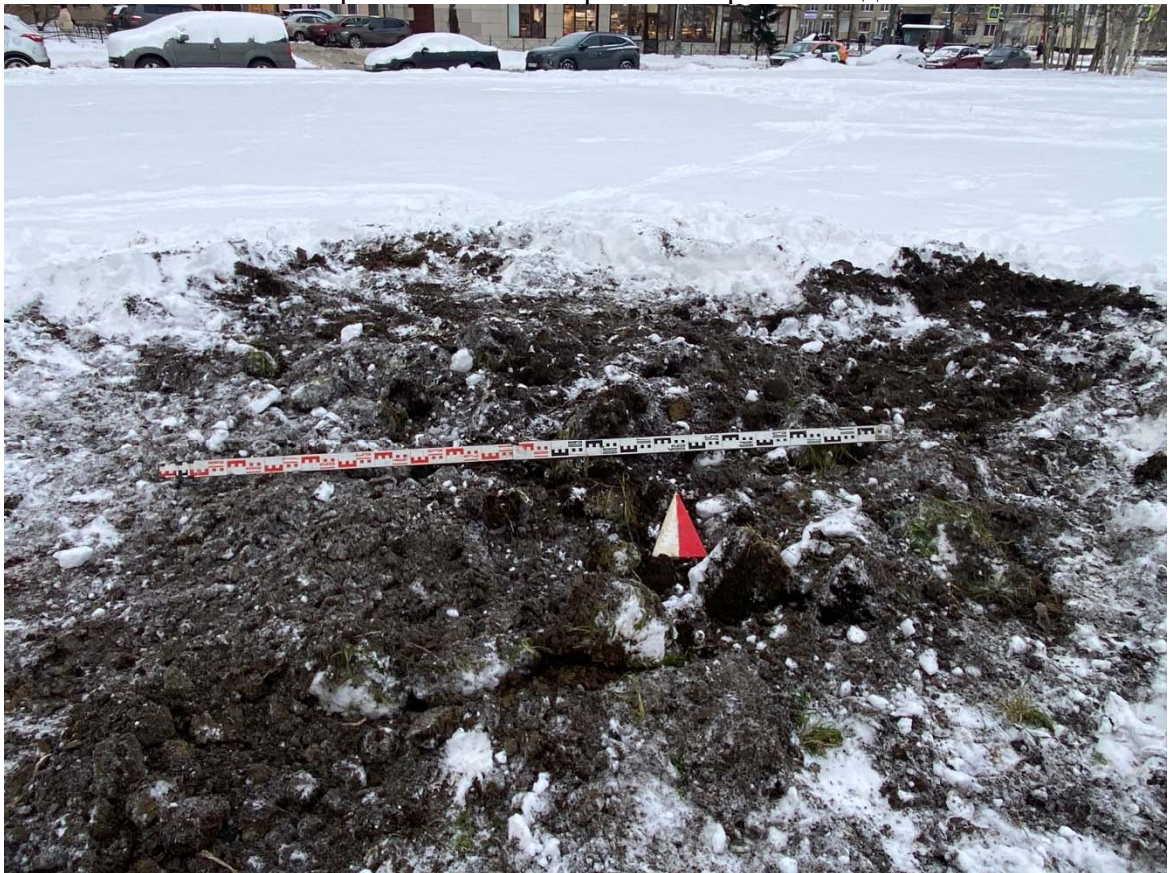
Рис. 47. Выполнение проектно-изыскательских работ по реконструкции водовода по адресу: г. Санкт-Петербург, Фрунзенский район, выход с Фрунзенской НС до Белградской ул. Шурф №3. Рекультивация. Вид с юга
