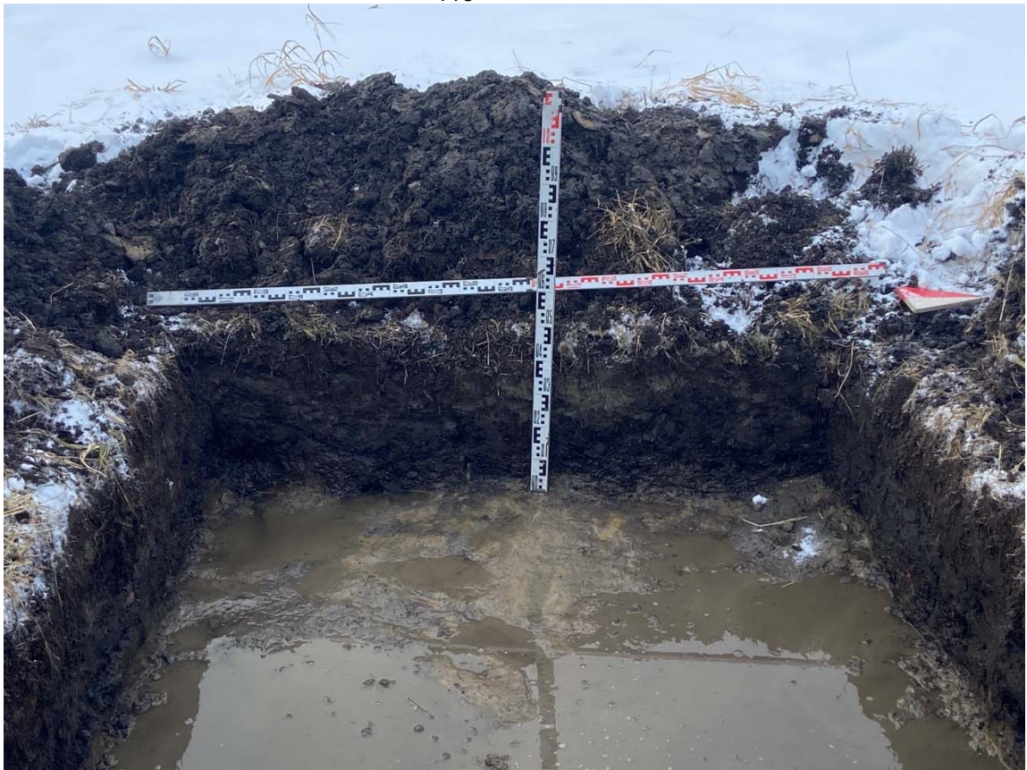
Рис. 40. Выполнение проектно-изыскательских работ по реконструкции водовода по адресу: г. Санкт-Петербург, Фрунзенский район, выход с Фрунзенской НС до Белградской ул. Шурф №2. Западная стенка. Вид с востока
