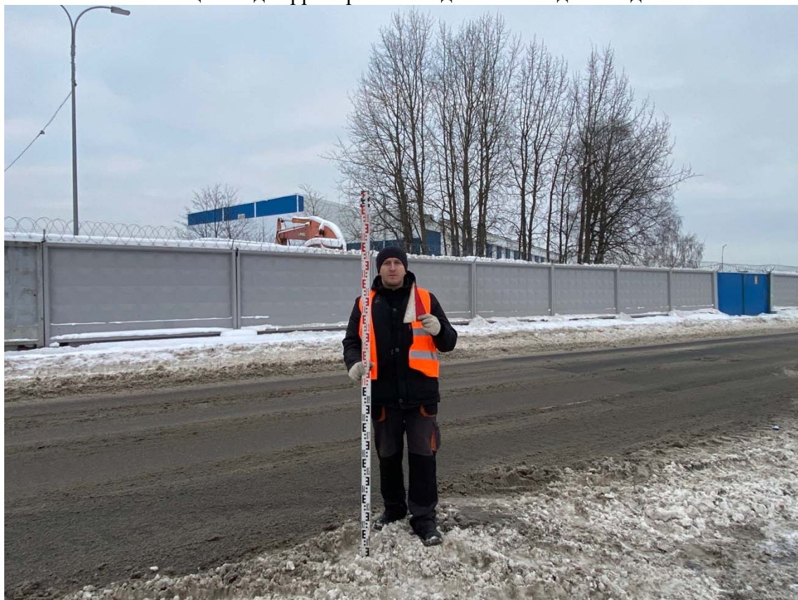
Рис. 29. Выполнение проектно-изыскательских работ по реконструкции водовода по адресу: г. Санкт-Петербург, Фрунзенский район, выход с Фрунзенской НС до Белградской ул. Photo 10. Общий вид территории обследования. Вид с юга
