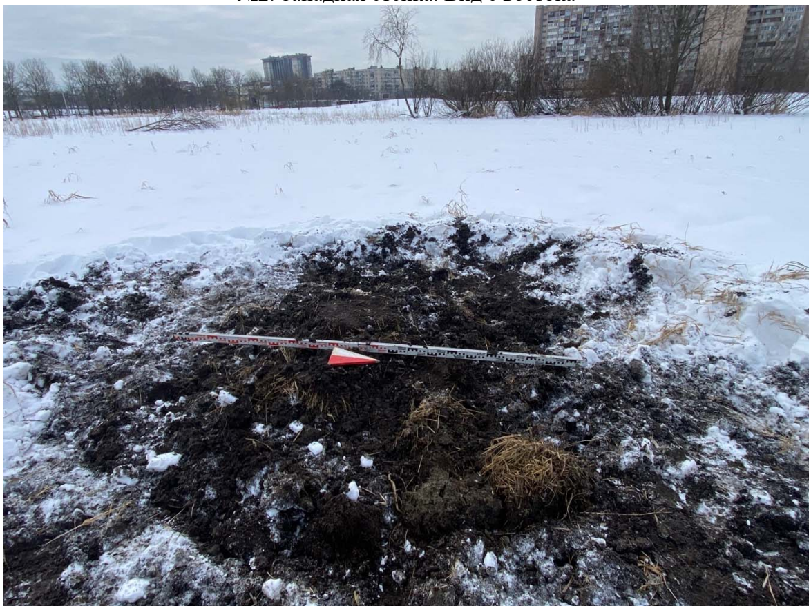
Рис. 41. Выполнение проектно-изыскательских работ по реконструкции водовода по адресу: г. Санкт-Петербург, Фрунзенский район, выход с Фрунзенской НС до Белградской ул. Шурф №2. Рекультивация. Вид с востока
