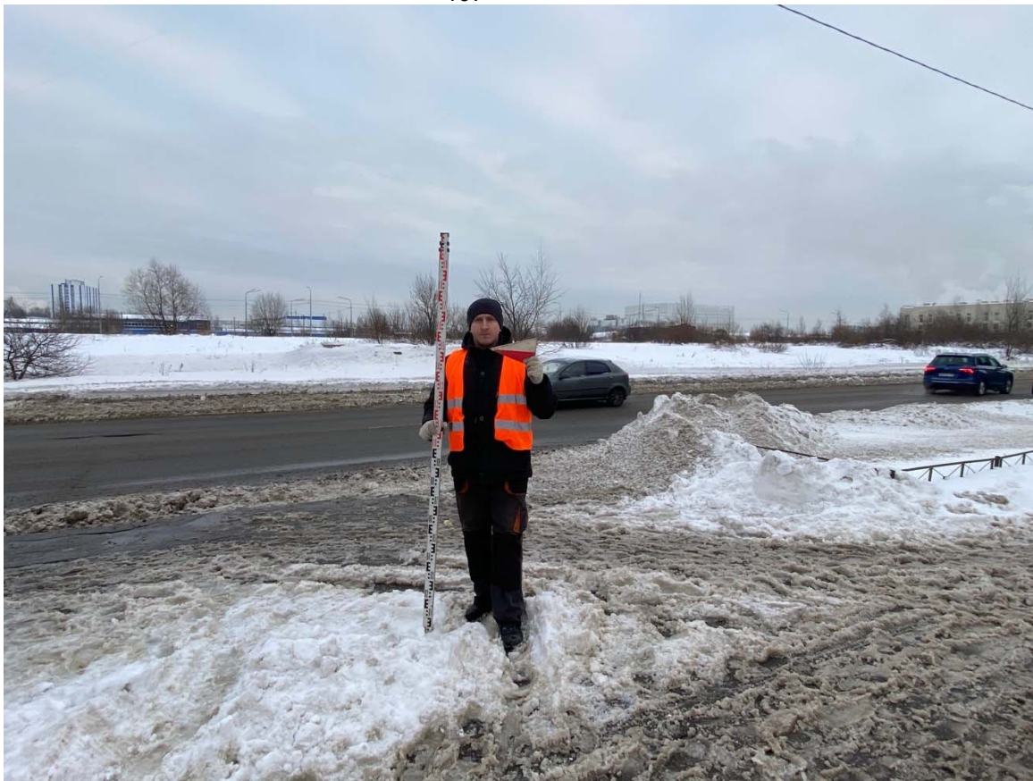
Рис. 28. Выполнение проектно-изыскательских работ по реконструкции водовода по адресу: г. Санкт-Петербург, Фрунзенский район, выход с Фрунзенской НС до Белградской ул. Photo 9. Общий вид территории обследования. Вид с запада
