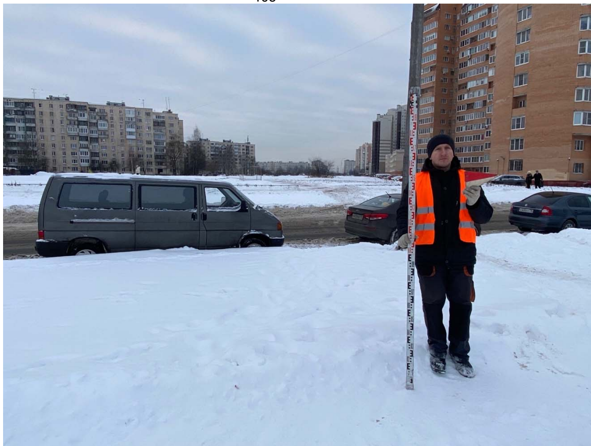
Рис. 24. Выполнение проектно-изыскательских работ по реконструкции водовода по адресу: г. Санкт-Петербург, Фрунзенский район, выход с Фрунзенской НС до Белградской ул. Photo 7. Общий вид территории обследования. Вид с востока
