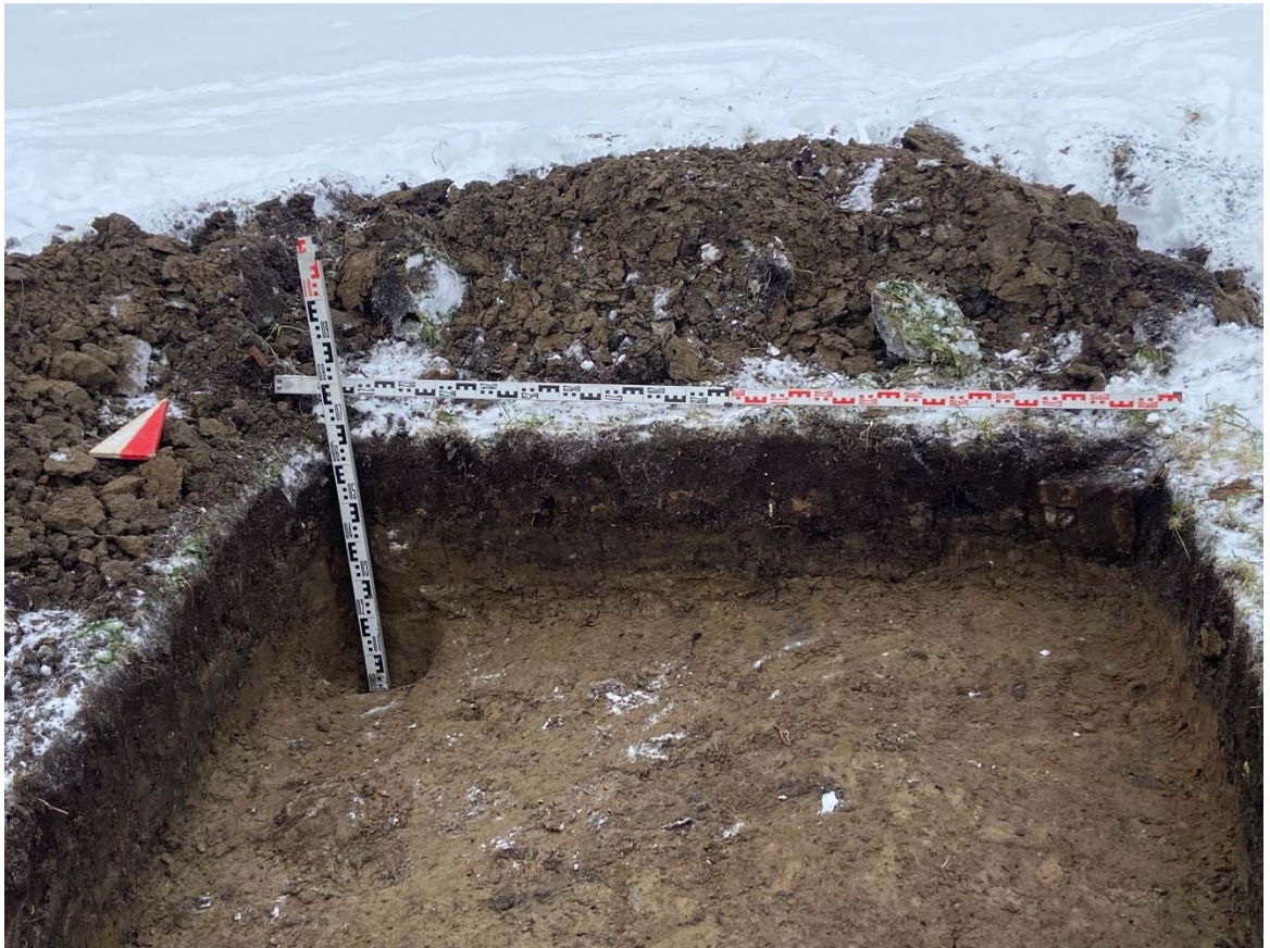
Рис. 46. Выполнение проектно-изыскательских работ по реконструкции водовода по адресу: г. Санкт-Петербург, Фрунзенский район, выход с Фрунзенской НС до Белградской ул. Шурф №3. Северная стенка. Контрольный прокоп. Вид с юга
