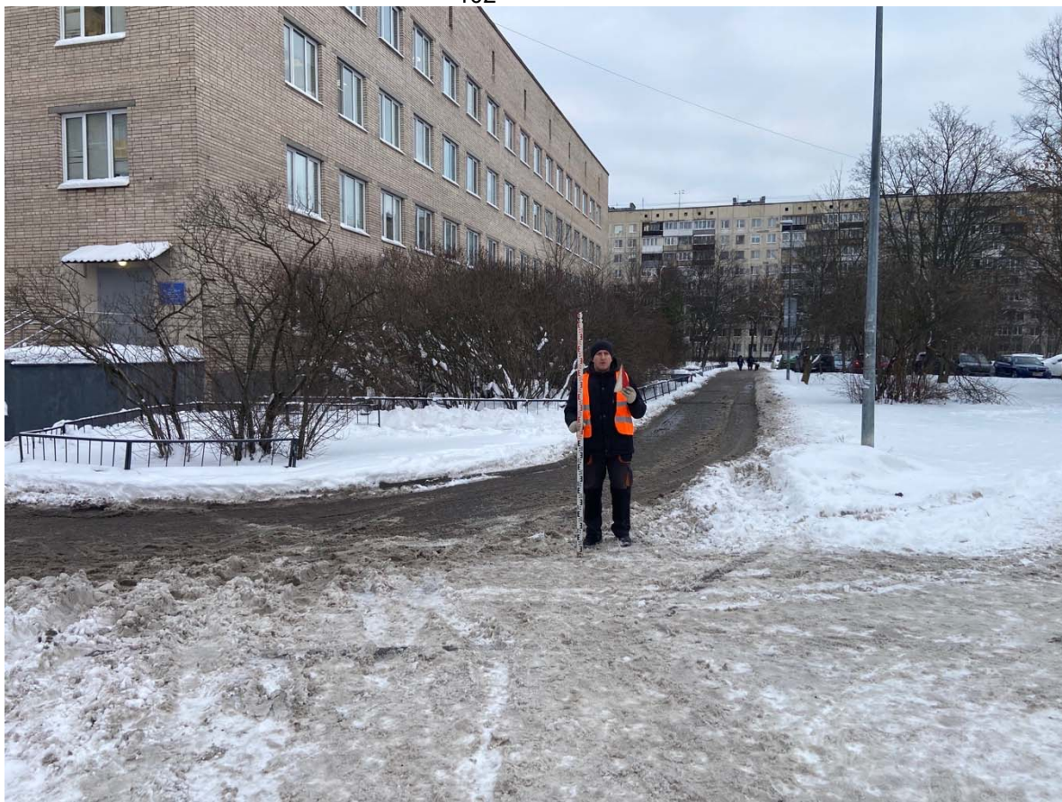
Рис. 18. Выполнение проектно-изыскательских работ по реконструкции водовода по адресу: г. Санкт-Петербург, Фрунзенский район, выход с Фрунзенской НС до Белградской ул. Photo 4. Общий вид территории обследования. Вид с юга
