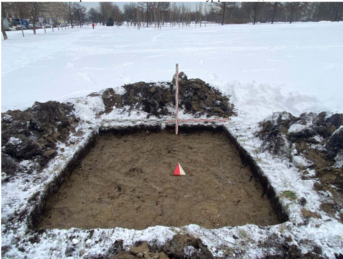
Рис. 33. Выполнение проектно-изыскательских работ по реконструкции водовода по адресу: г. Санкт-Петербург, Фрунзенский район, выход с Фрунзенской НС до Белградской ул. Шурф №1. Зачистка дна шурфа по материке. Вид с юга
