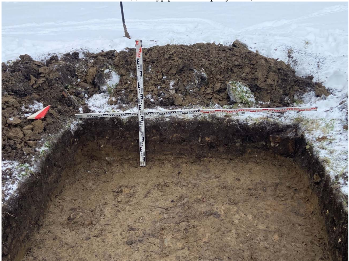
Рис. 45. Выполнение проектно-изыскательских работ по реконструкции водовода по адресу: г. Санкт-Петербург, Фрунзенский район, выход с Фрунзенской НС до Белградской ул. Шурф №3. Северная стенка. Вид с юга
