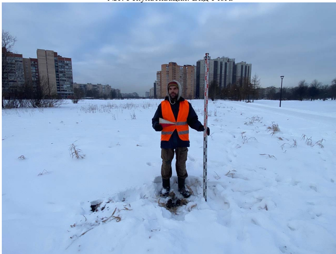
Рис. 37. Выполнение проектно-изыскательских работ по реконструкции водовода по адресу: г. Санкт-Петербург, Фрунзенский район, выход с Фрунзенской НС до Белградской ул. Место заложения Шурфа №2. Вид с востока
