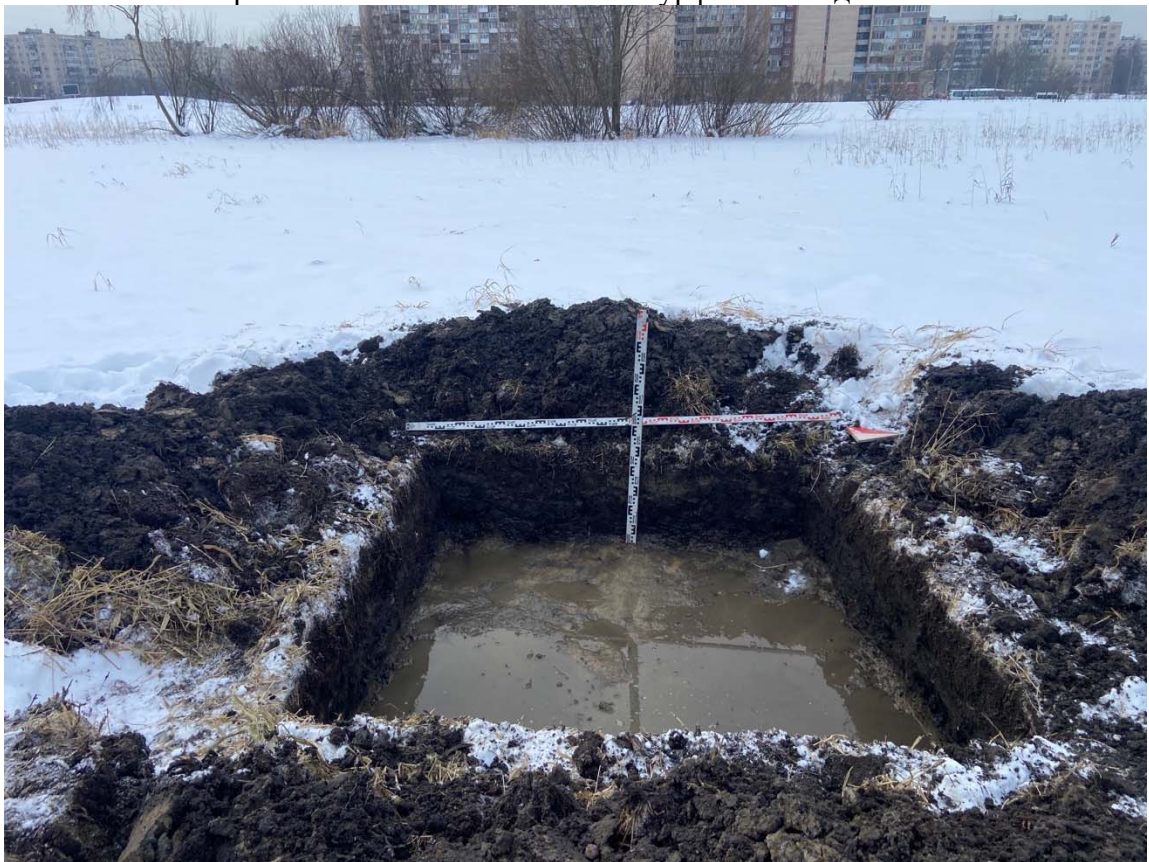
Рис. 39. Выполнение проектно-изыскательских работ по реконструкции водовода по адресу: г. Санкт-Петербург, Фрунзенский район, выход с Фрунзенской НС до Белградской ул. Шурф №2. Зачистка дна шурфа по матерiku. Вид с востока
