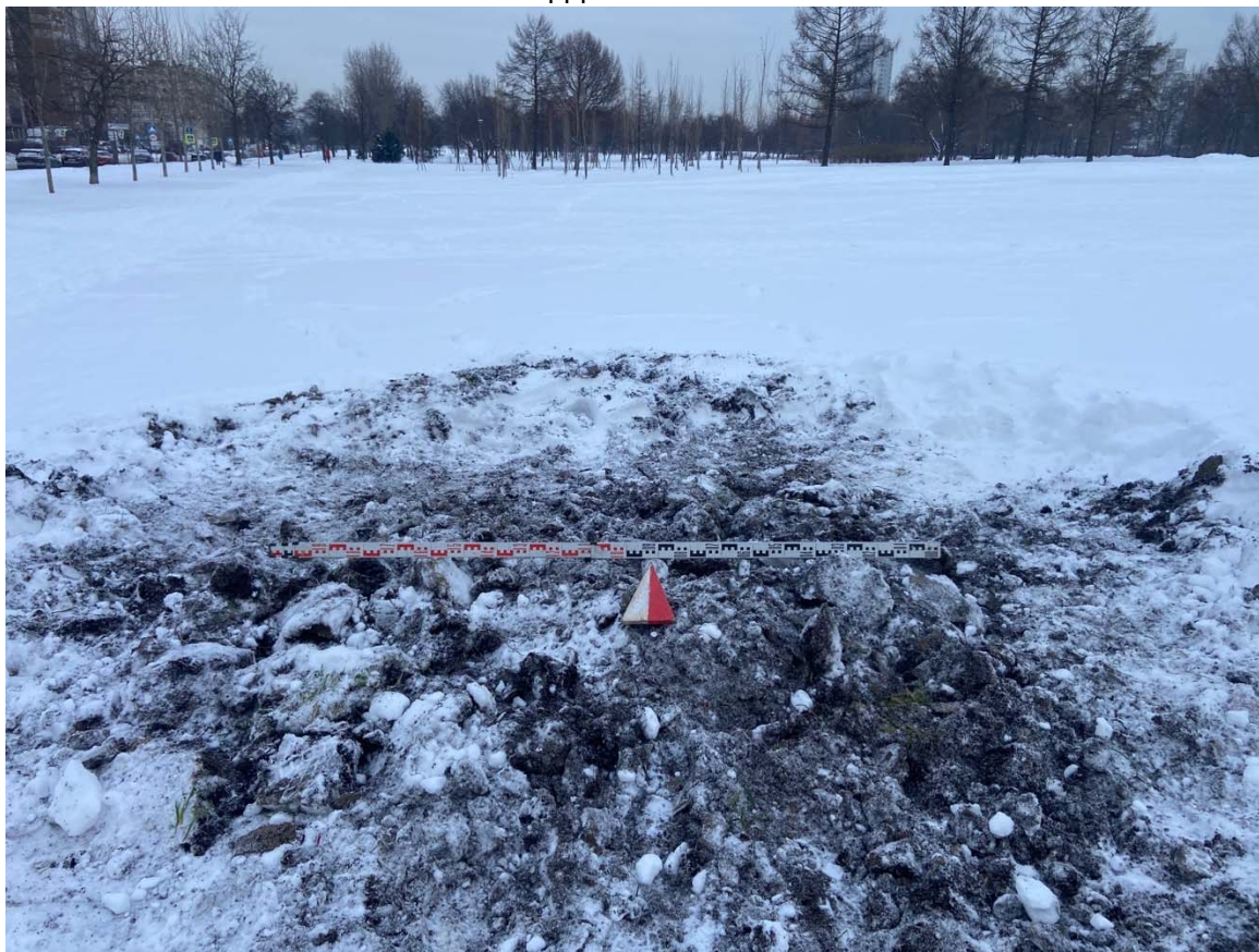
Рис. 36. Выполнение проектно-изыскательских работ по реконструкции водовода по адресу: г. Санкт-Петербург, Фрунзенский район, выход с Фрунзенской НС до Белградской ул. Шурф №1. Рекультивация. Вид с юга
