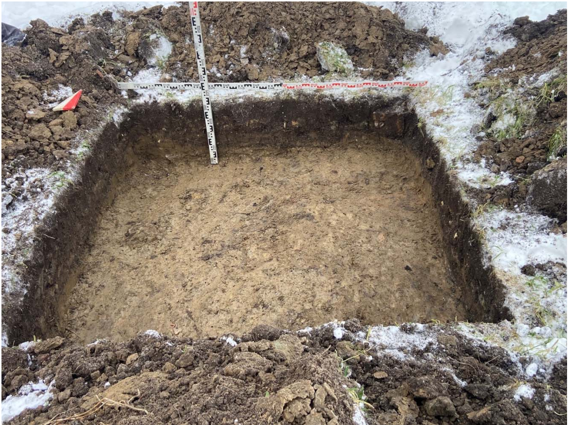
Рис. 44. Выполнение проектно-изыскательских работ по реконструкции водовода по адресу: г. Санкт-Петербург, Фрунзенский район, выход с Фрунзенской НС до Белградской ул. Шурф №3. Зачистка дна шурфа по матерiku. Вид с юга
