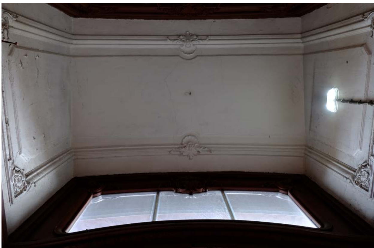
40. Кирочная улица, дом 24, литера А. «Дом Ю.Бака». Парадная лестница № 2. Тамбур. Оформление потолка.
