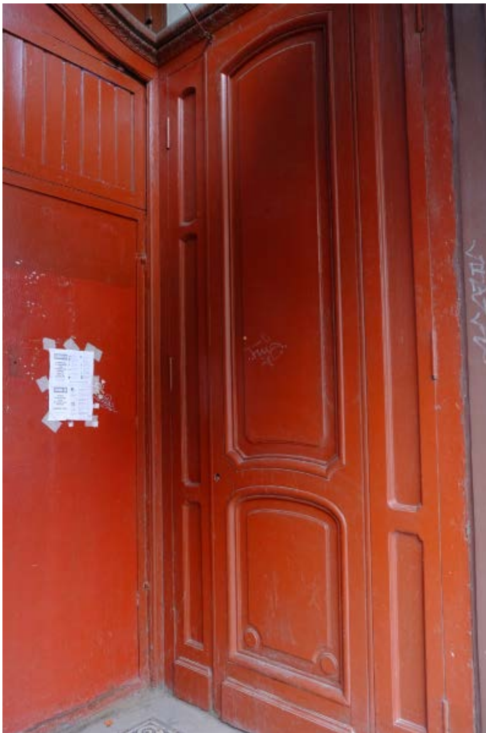
38. Кирочная улица, дом 24, литера А. «Дом Ю.Бака». Парадная лестница № 2. Тамбур. Правая боковая панель.
