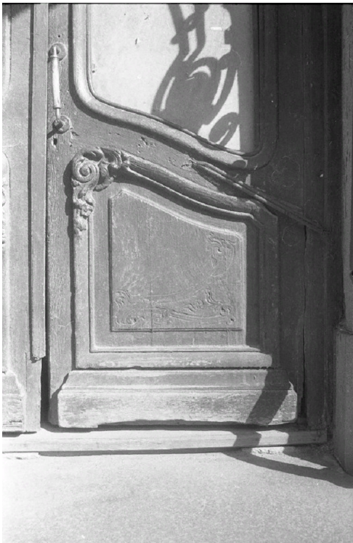
49. Входная дверь. До 1998. Источник: www.protect812.com
