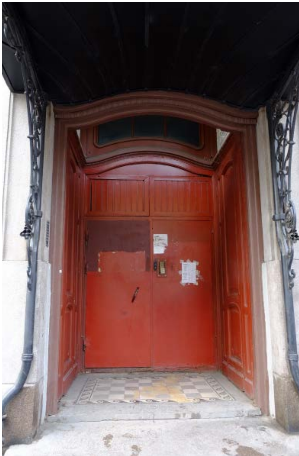
32. Кировская улица, дом 24, литера А. «Дом Ю.Бака». Парадная лестница № 2. Дверное заполнение.
