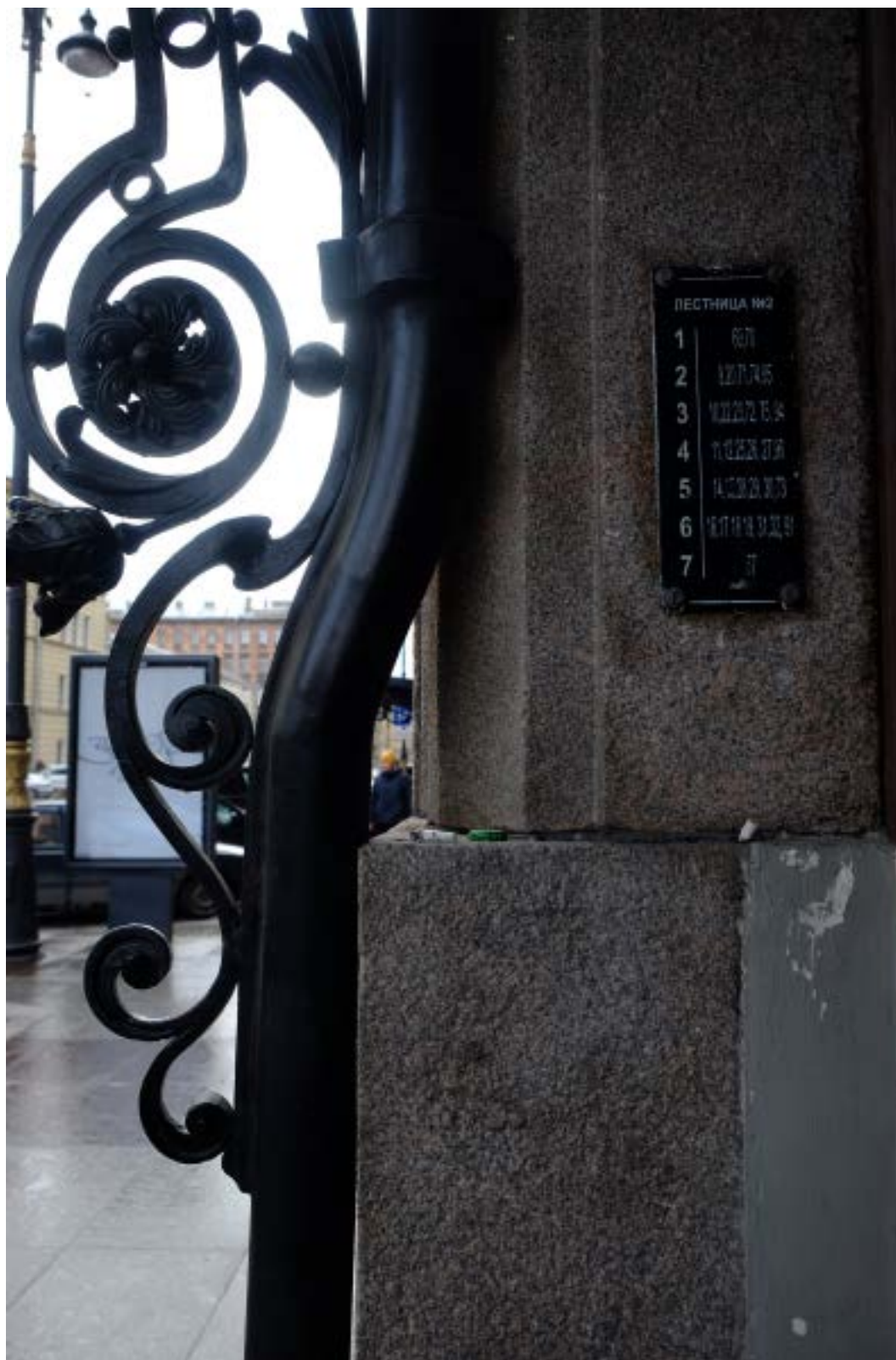
31. Кирочная улица, дом 24, литера А. «Дом Ю.Бака». Парадная лестница № 2. Откос с фрагментом кронштейна.
