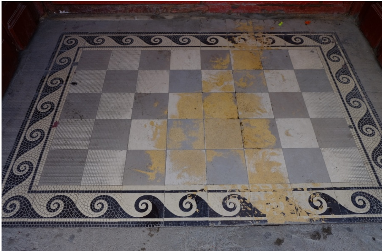
42. Кирочная улица, дом 24, литера А. «Дом Ю.Бака». Парадная лестница № 2. Тамбур. Напольная плитка.
