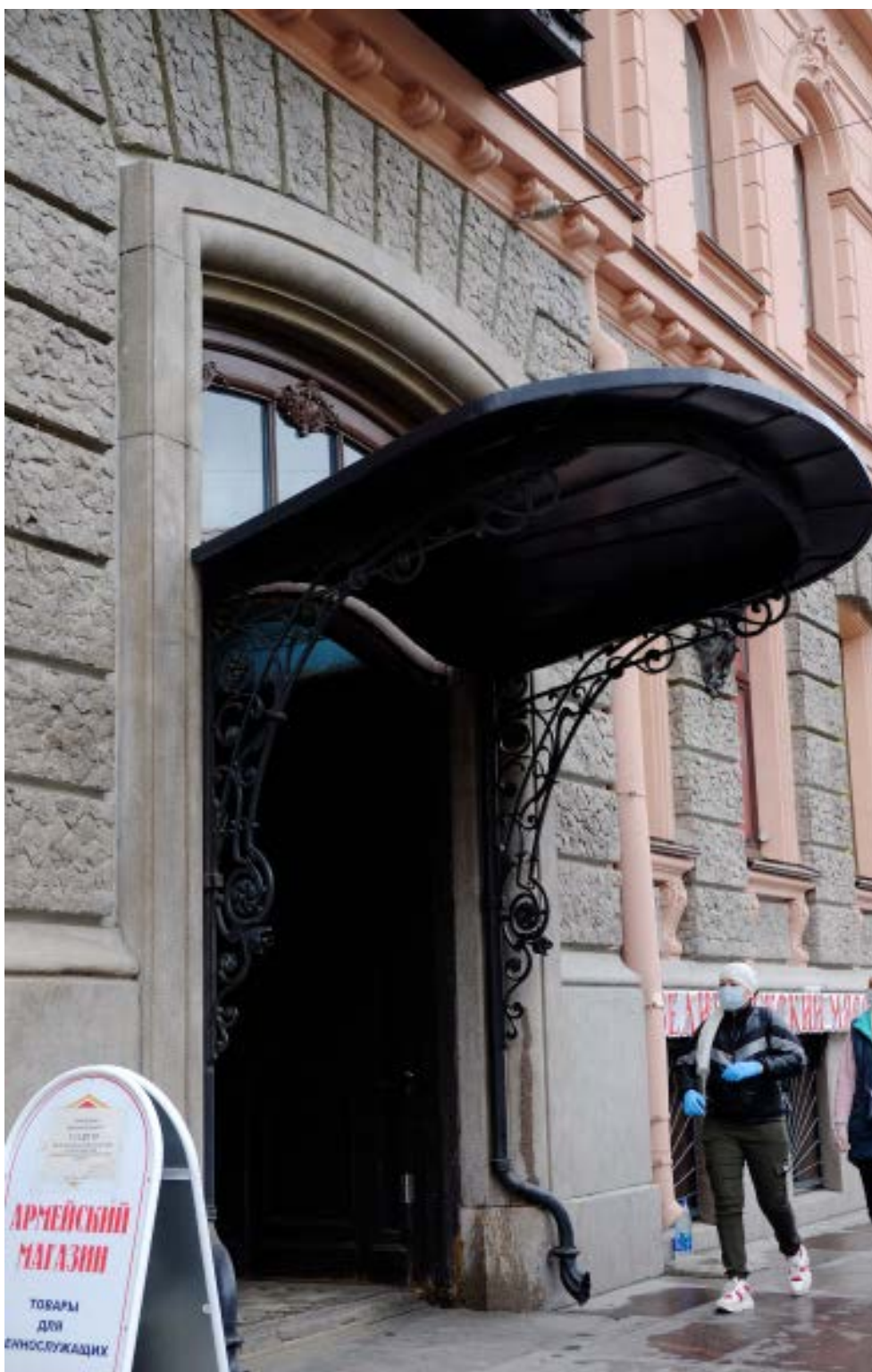
5. Кирочная улица, дом 24, литера А. «Дом Ю.Бака». Лицевой фасад. Козырек парадной лестницы № 1.
