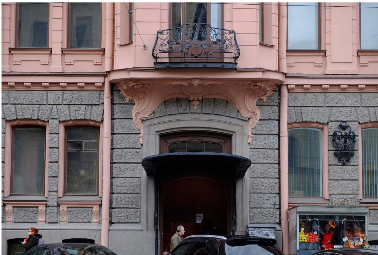
3. Кирочная улица, дом 24, литера А. «Дом Ю.Бака». Лицевой фасад. Входная группа парадной № 2.
