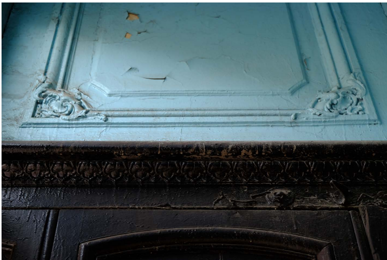
8. Кирочная улица, дом 24, литера А. «Дом Ю.Бака». Тамбур парадной лестницы № 1. Карниз над боковыми панелями тамбура.
