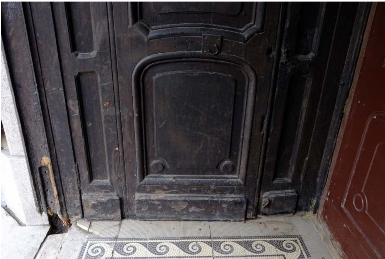
12. Кирочная улица, дом 24, литера А. «Дом Ю.Бака». Тамбур парадной лестницы № 1. Левая боковая панель. Нижняя часть.
