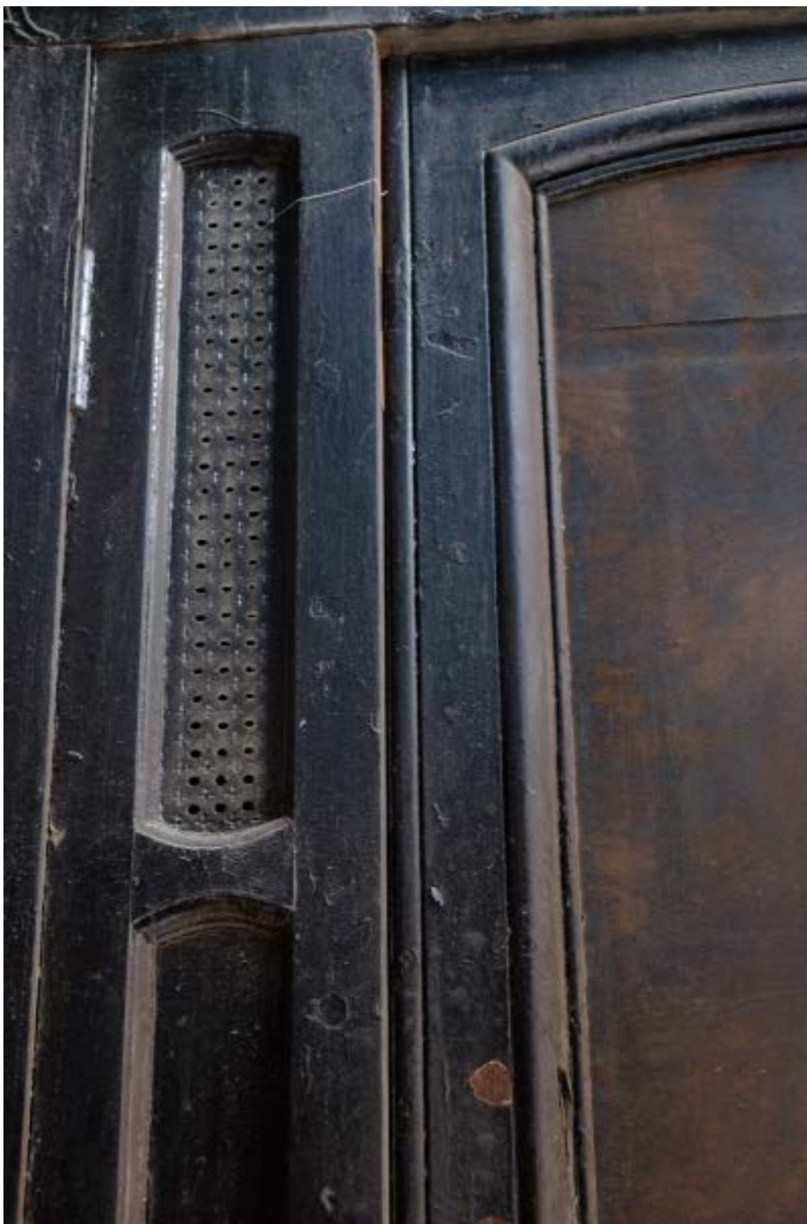
13. Кирочная улица, дом 24, литера А. «Дом Ю.Бака». Тамбур парадной лестницы № 1. Продухи в боковой панели.
