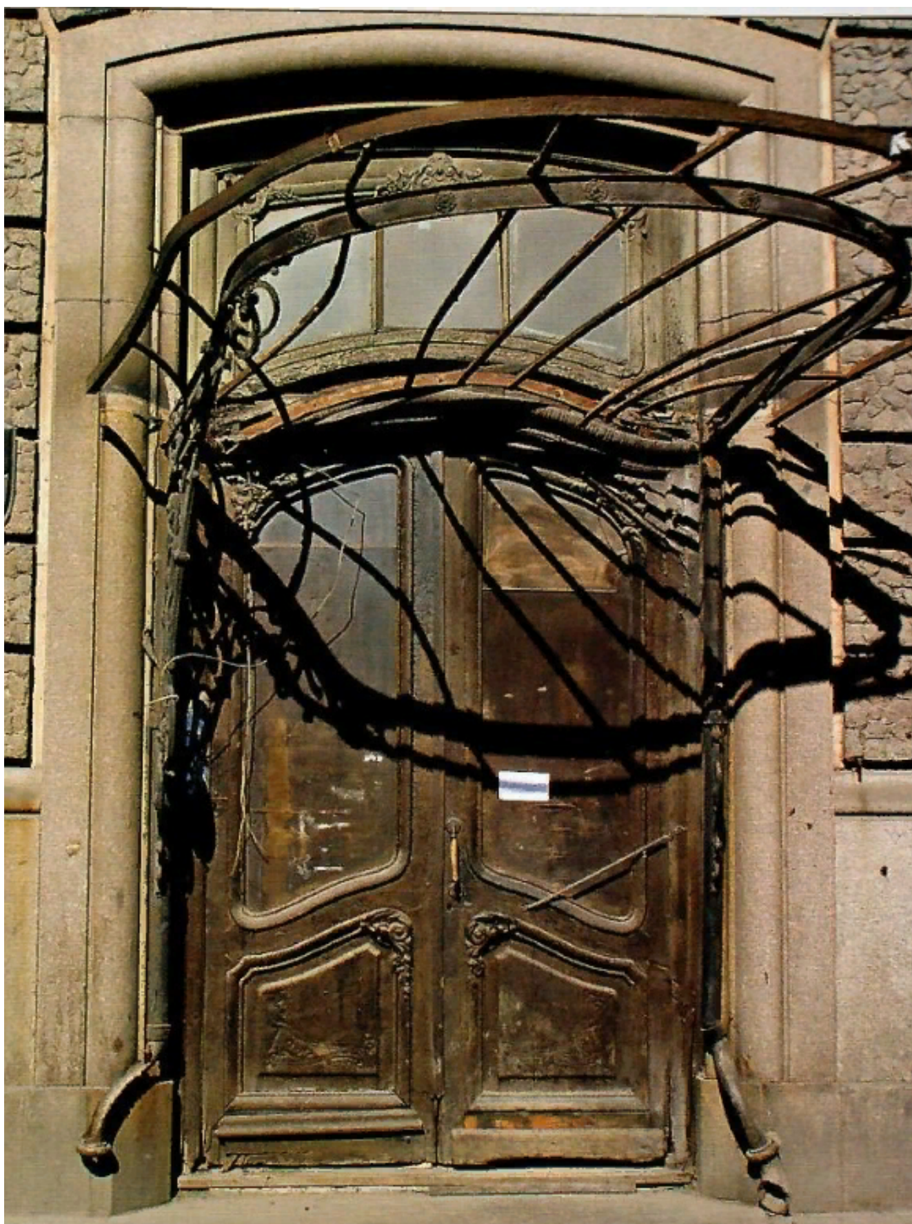
53. Дверные заполнения 1-й парадной. До 2006. Источник: официальная группа "Дома Бака". URL: https://vk.com/kiroch24?w=wall-58250597_9539
