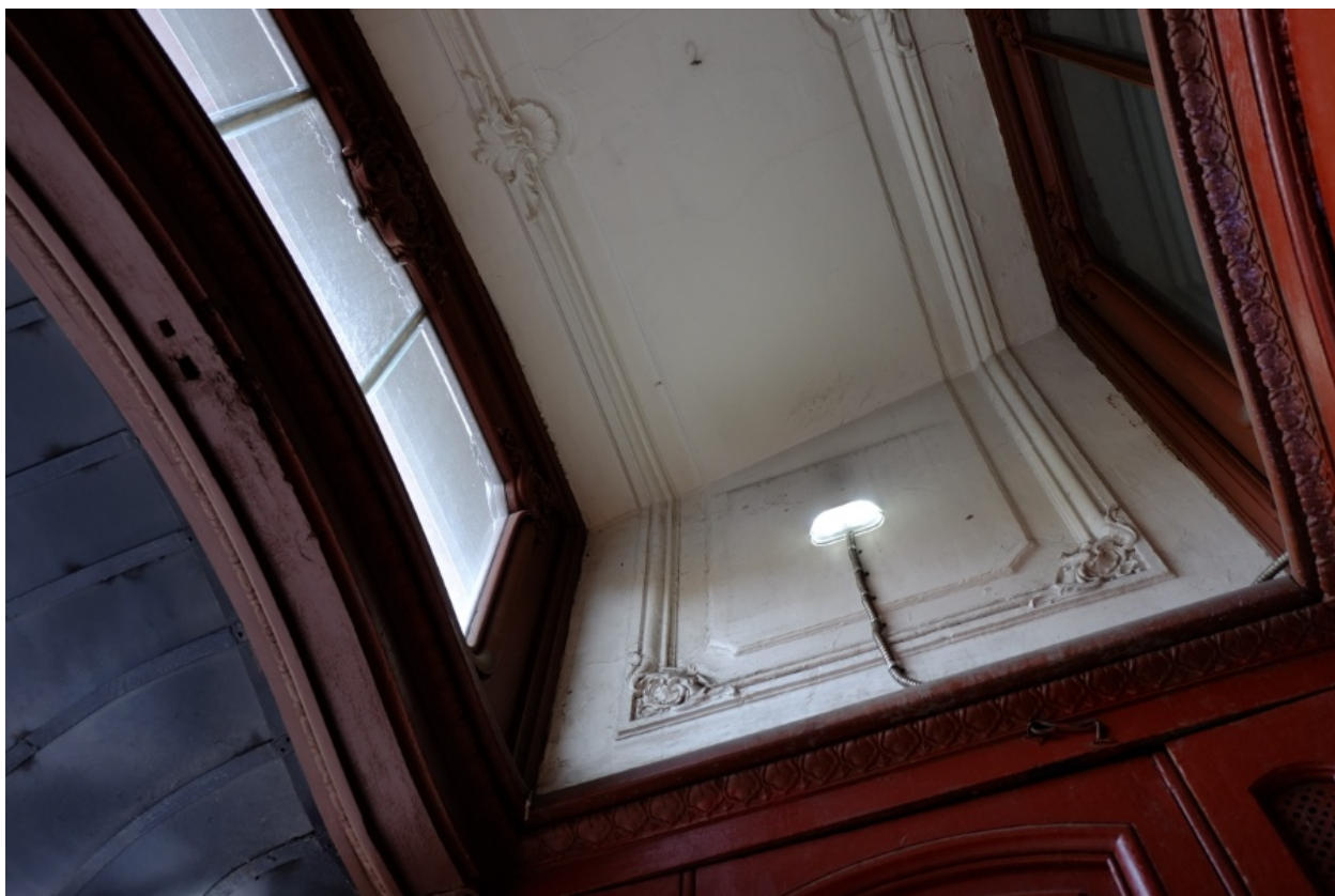
41. Кирочная улица, дом 24, литера А. «Дом Ю.Бака». Парадная лестница № 2. Тамбур парадной № 2.
