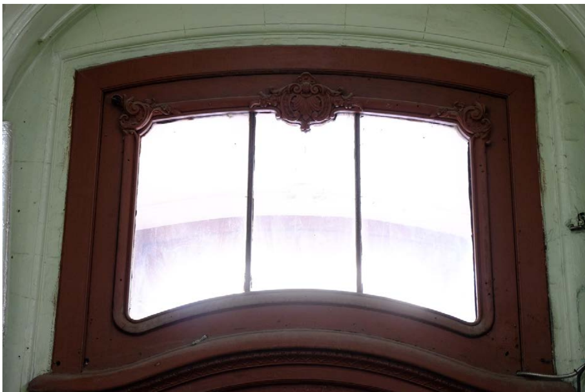
47. Кировная улица, дом 24, литера А. «Дом Ю.Бака». Парадная лестница № 2. Фрамуга. Вид с лестницы.
