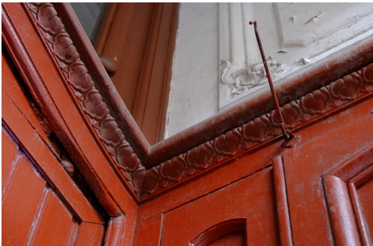
45. Кирочная улица, дом 24, литера А. «Дом Ю.Бака». Парадная лестница № 2. Тамбур. Карниз.
