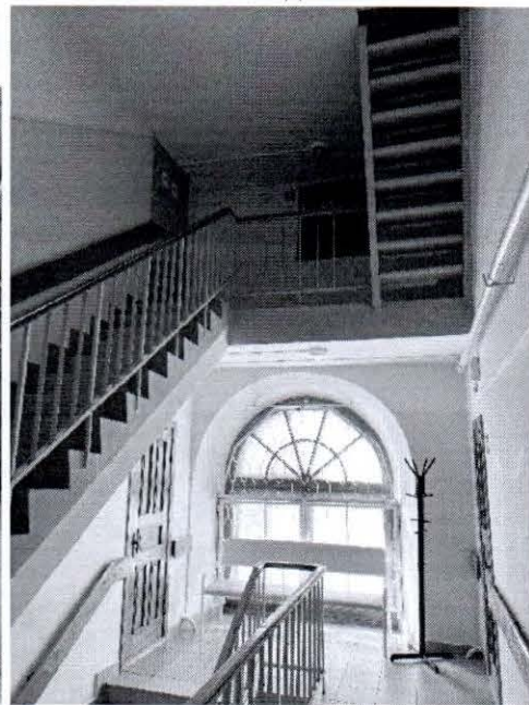
9. Двухмаршевая лестница в южной части здания.
