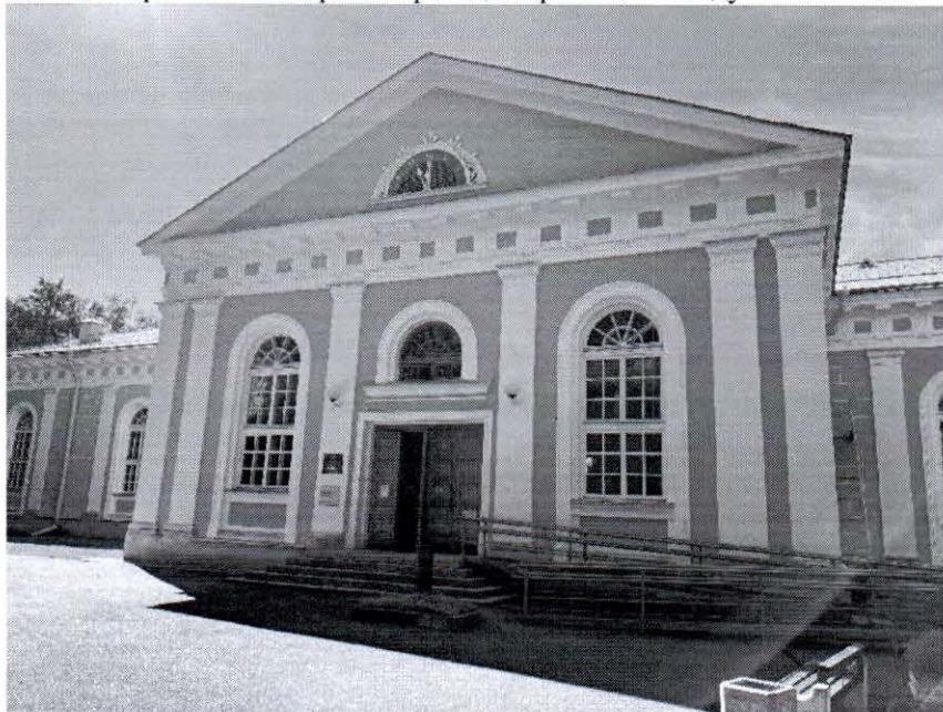
5. Вид на ризалит северного фасада. Крыльцо. Пандус.
