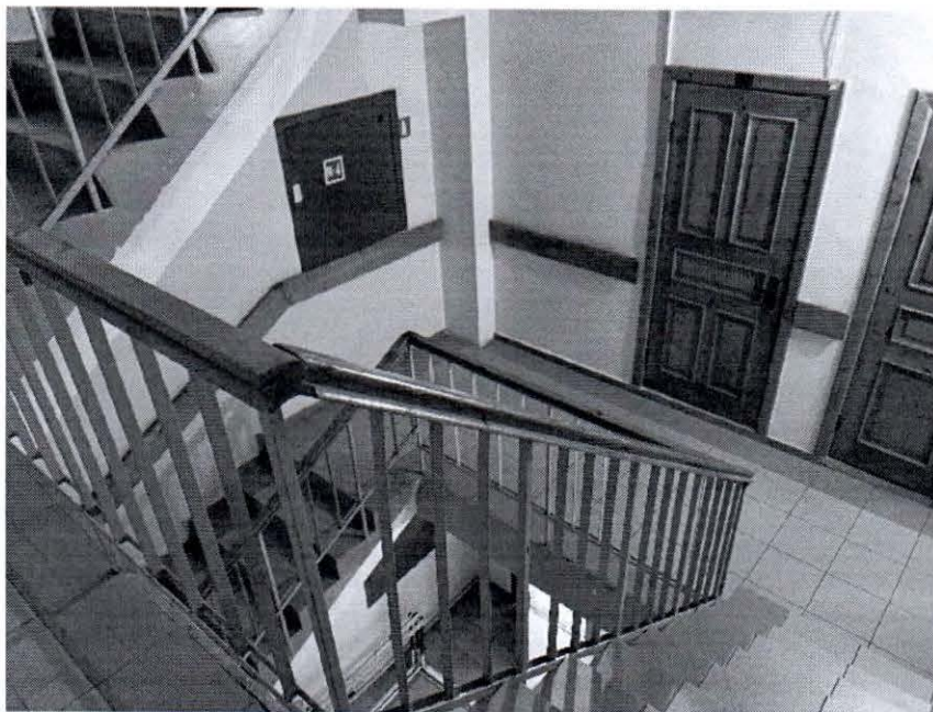
8. Трехмаршевая лестница в западной части здания.
