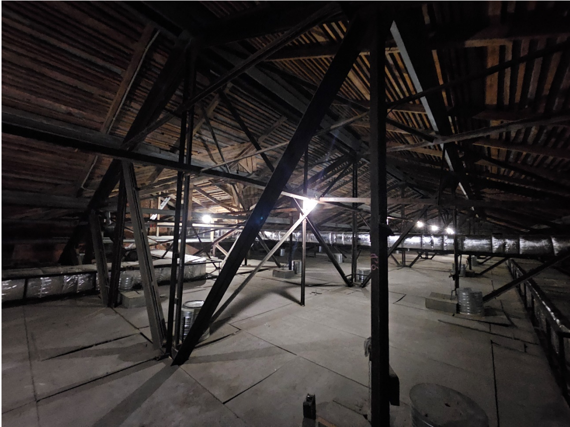
37. Объект культурного наследия регионального значения «Экзерциргауз лейб-гвардии Волынского полка», расположенный по адресу: Санкт-Петербург, город Ломоносов, Манежная улица, дом 3, литера А. Общий вид металлической стропильной системы крыши в уровне чердака.
