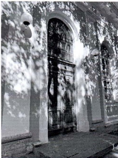
6. Восточный фасад. Крыльцо.
