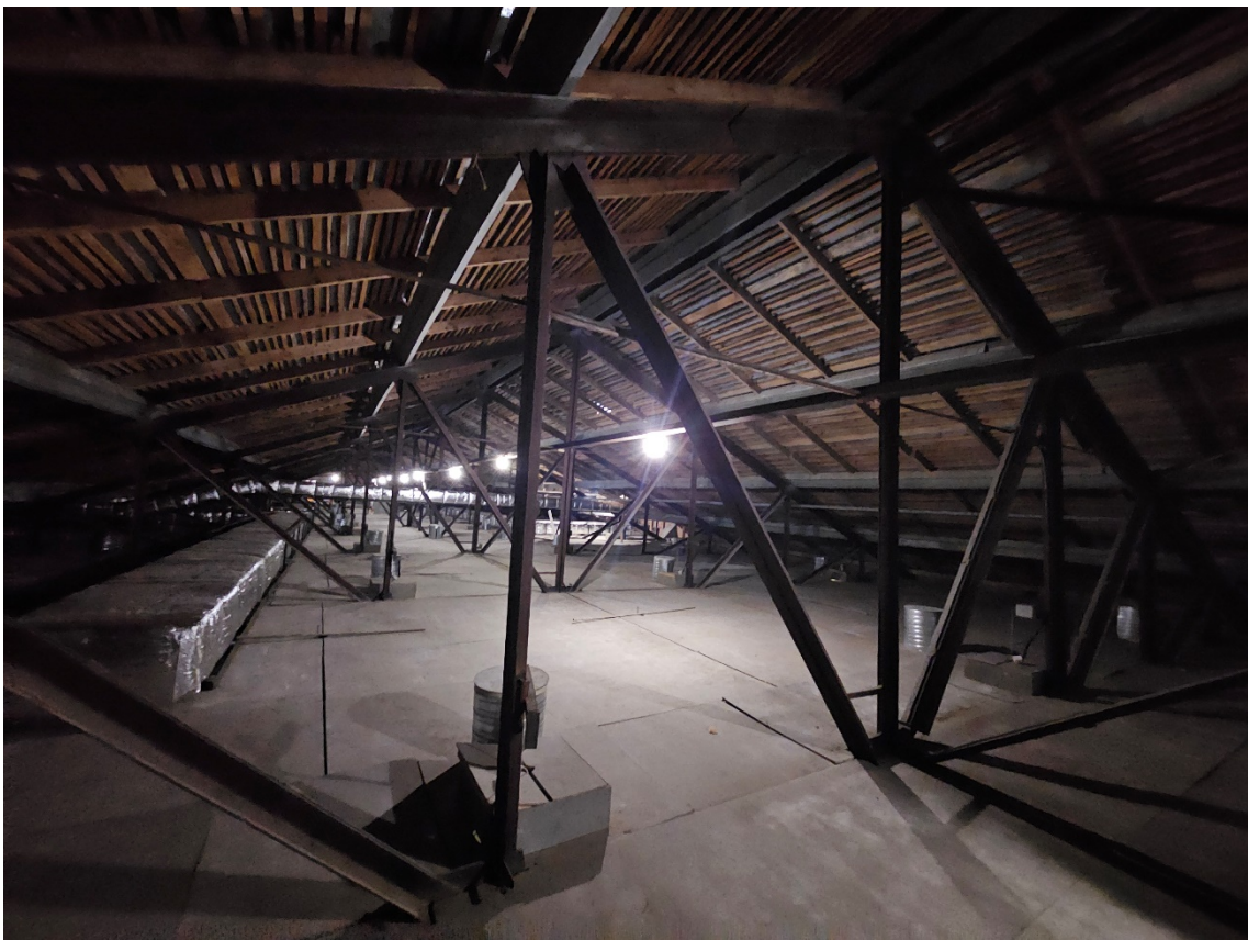
38. Объект культурного наследия регионального значения «Экзерциргауз лейб-гвардии Волынского полка», расположенный по адресу: Санкт-Петербург, город Ломоносов, Манежная улица, дом 3, литера А. Общий вид металлической стропильной системы крыши в уровне чердака.
