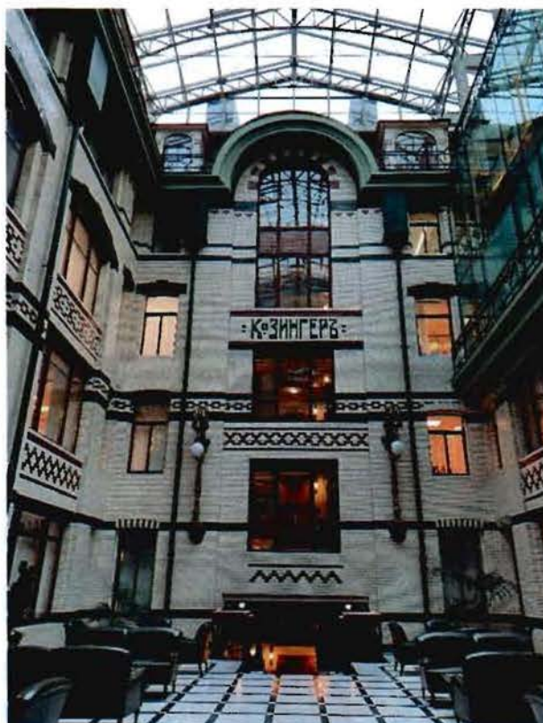
2. Общий вид на атриум объекта культурного наследия.
