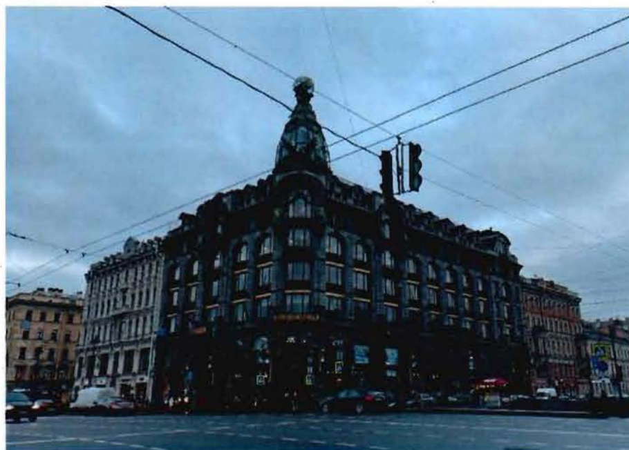
1. Общий вид на объект культурного наследия.
