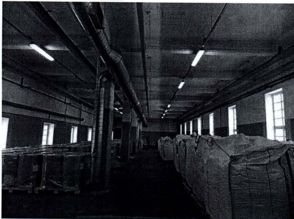
5. Помещение 4-го этажа. Колонны.
