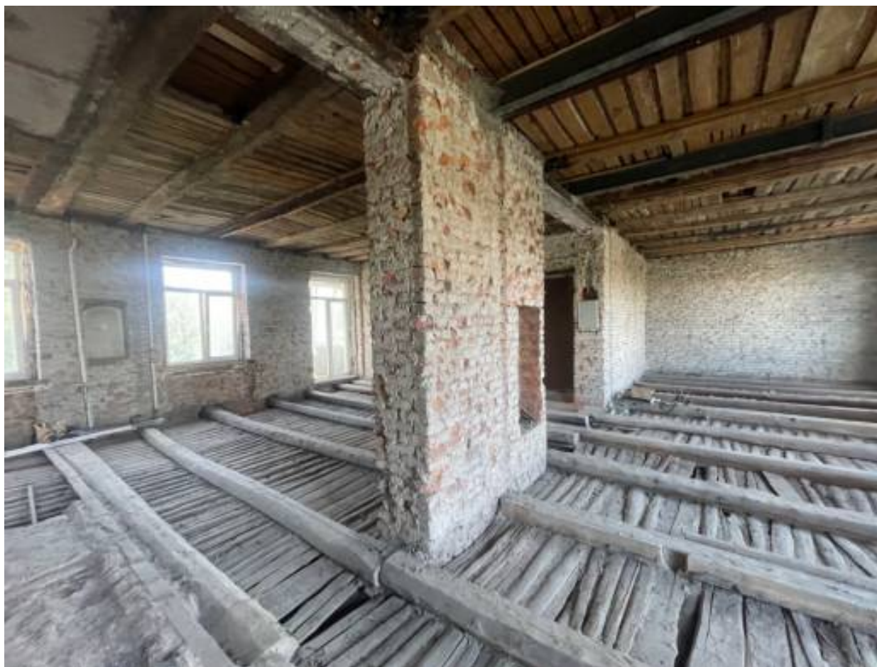
9. Общий вид помещений.
