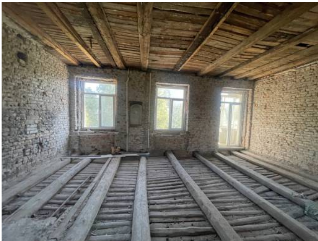
10. Помещения со стороны дворового фасада.
