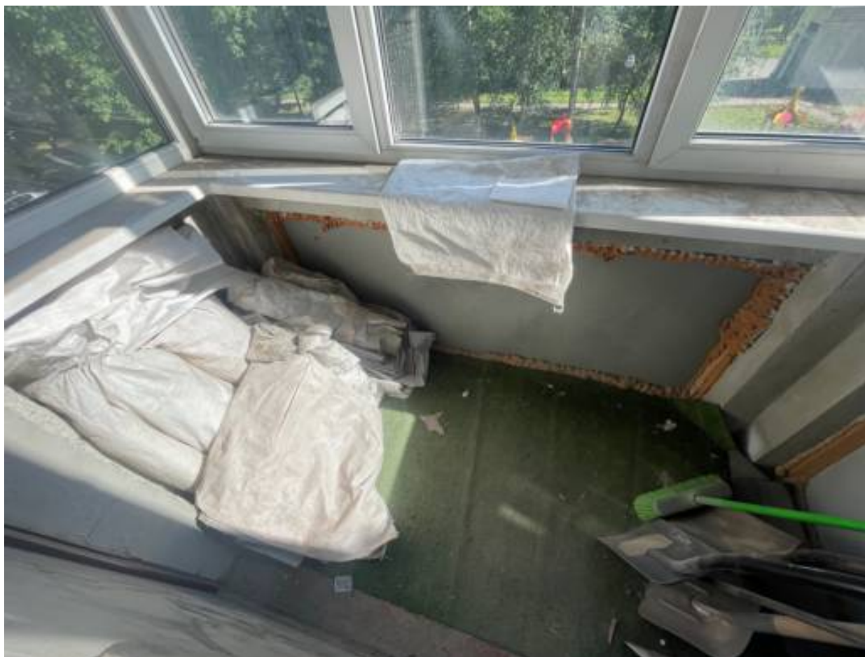
13. Балкон со стороны дворового фасада.
