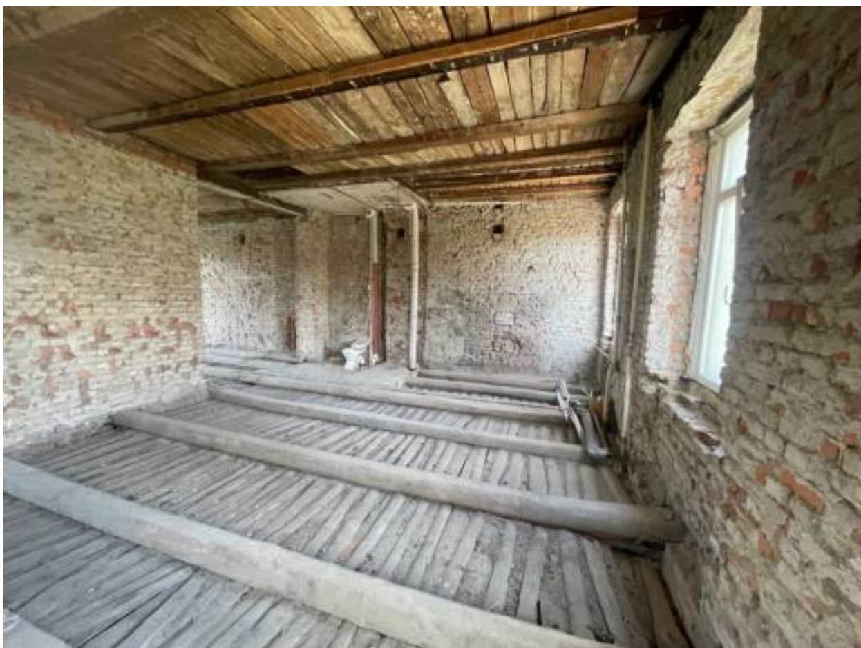
14. Помещение со стороны дворового фасада.
