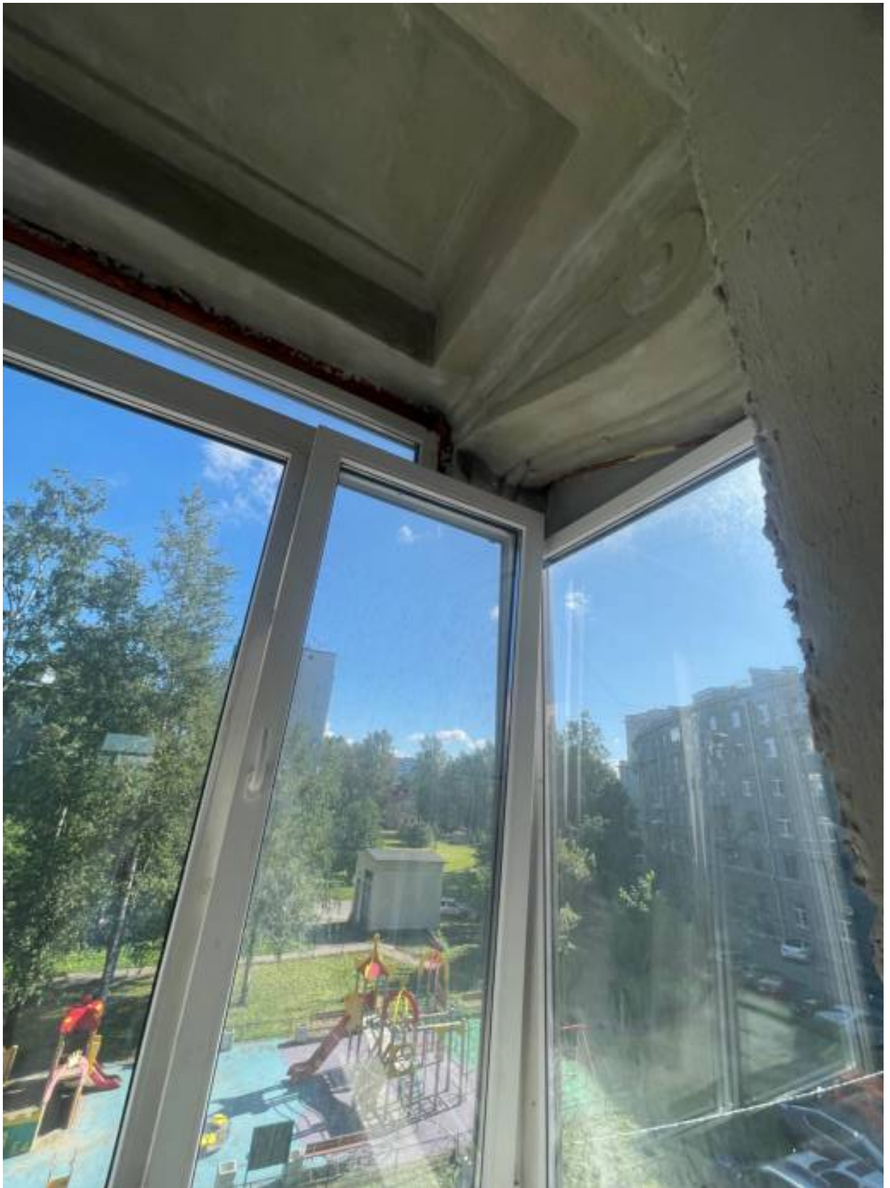
12. Балкон со стороны дворового фасада.
