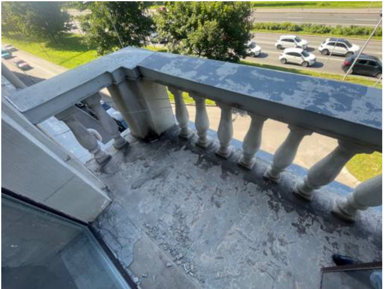
8. Балкон со стороны лицевого фасада.
