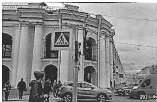
Фото 2. Фасад Невской и Садовой линии
