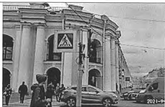
Фото 2. Фасад Невской и Садовой линии
