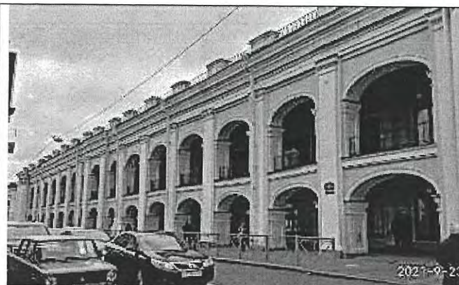
Фото 3. Фасад Садовой линии
