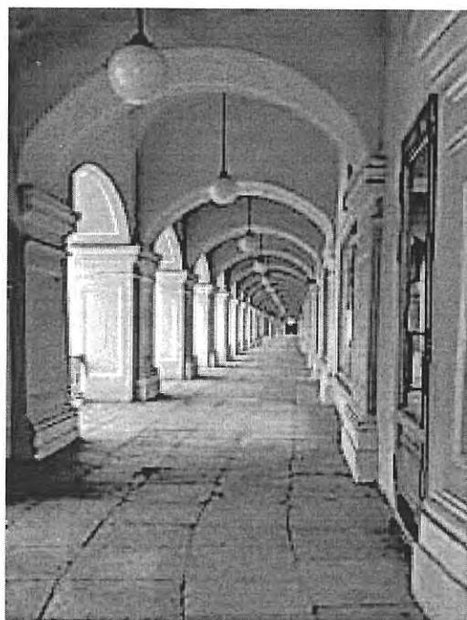
Фото 7. Крытая арочная галерея Садовой линии 1 этажа
