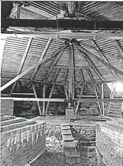
Фото 19-20. Чердачные помещения и стропильная система
