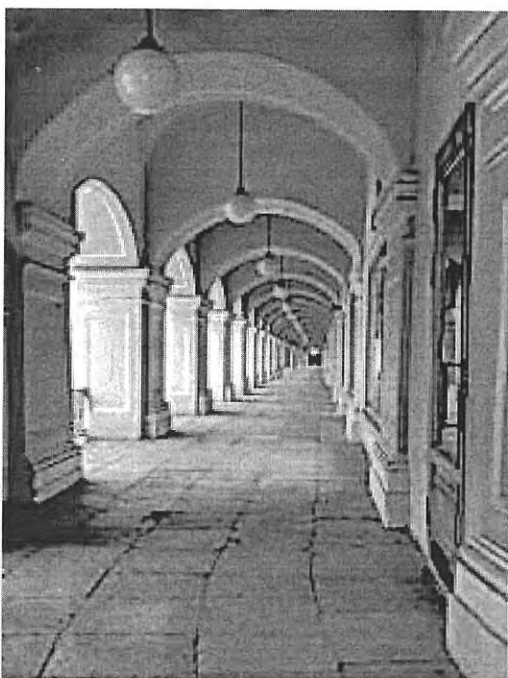
Фото 7. Крытая арочная галерея Садовой линии 1 этажа
