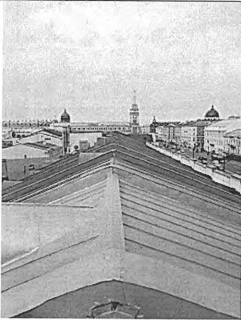
Фото 15. Кровля по Невской линии
