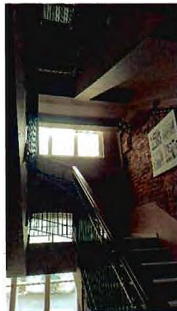
7. Лестница. (Невский пр-кт, дом 35, лит. В)
