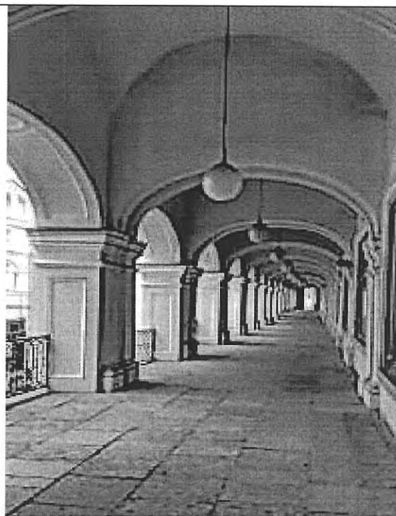
Фото 8. Крытая арочная галерея Ломоносовской линии 2 этажа
