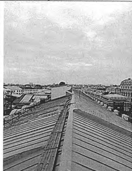
Фото 18. Кровля по Перинной линии
