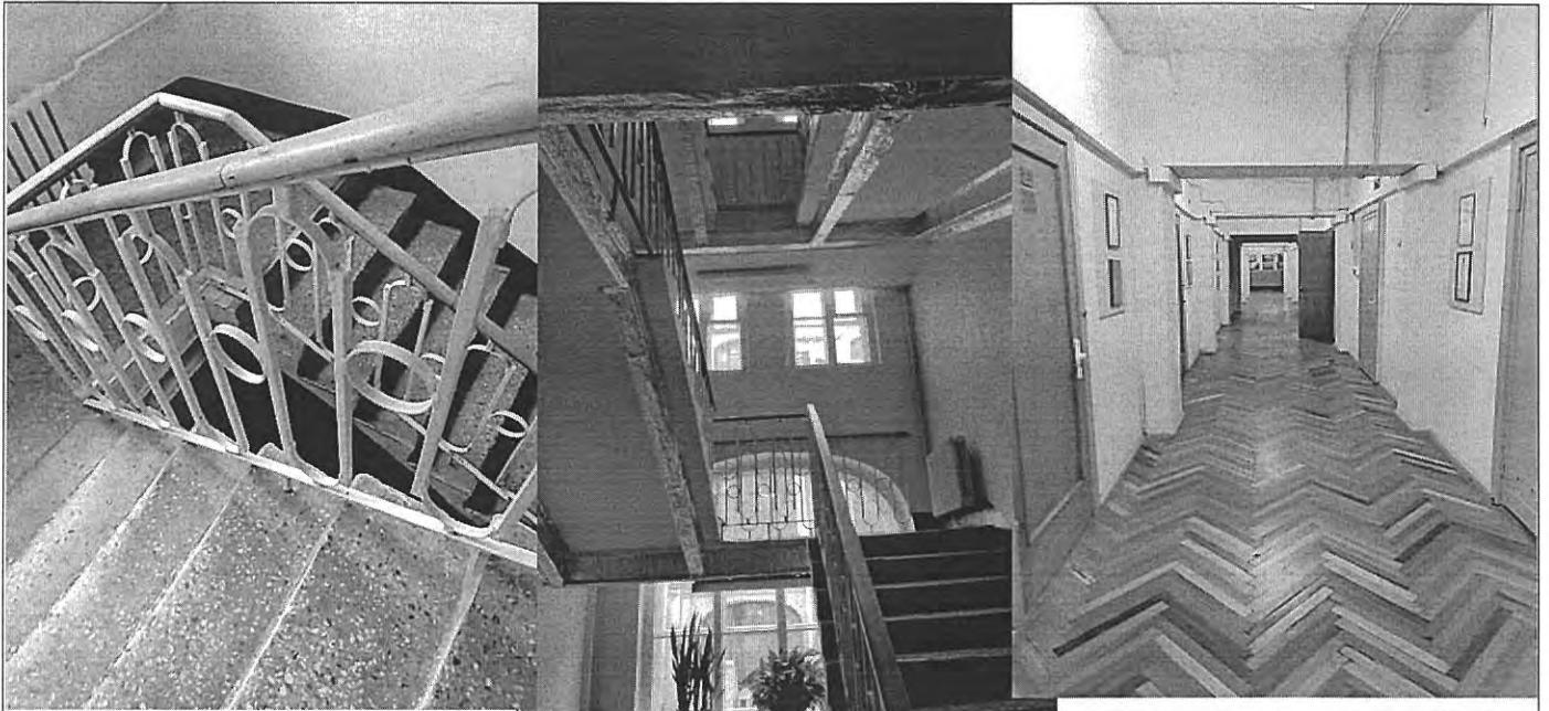
Фото 25-27. Лестница и коридор в дворовом корпусе
