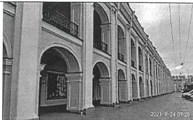
Фото 4. Фасад Садовой линии
