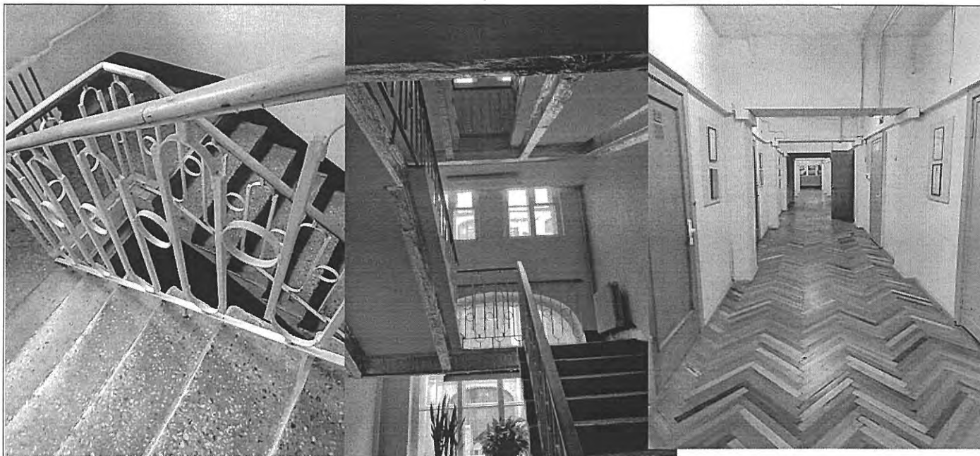
Фото 25-27. Лестница и коридор в дворовом корпусе
