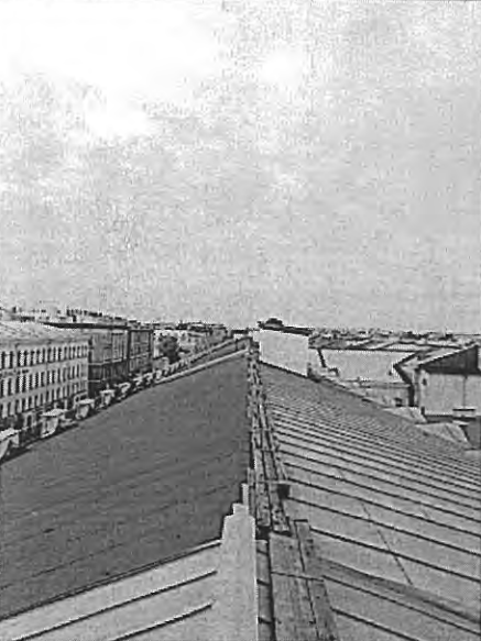
Фото 17. Кровля по Садовой линии
