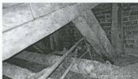
Вид деревянных конструкций кровли чердака
