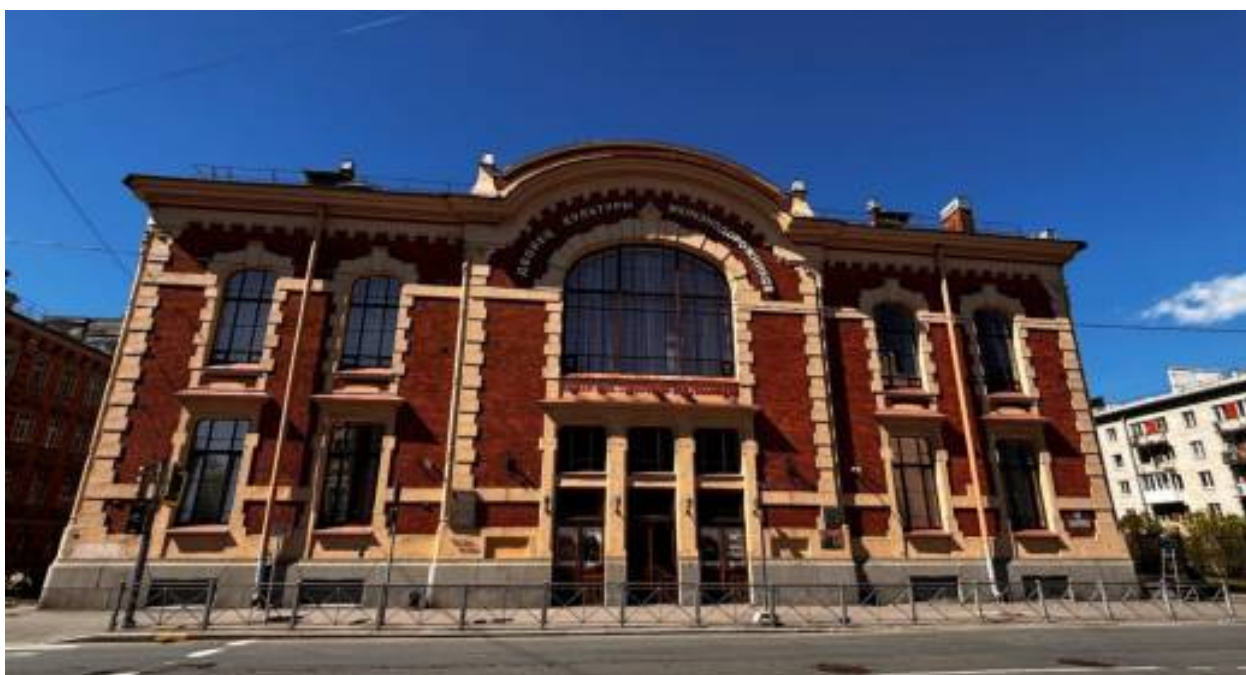
Фото 2. Лицевой фасад, выходящий на Тамбовскую ул.
