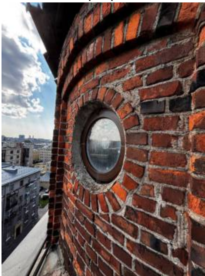
Фото 14. Фрагмент лицевой кладки башни обсерватории.
