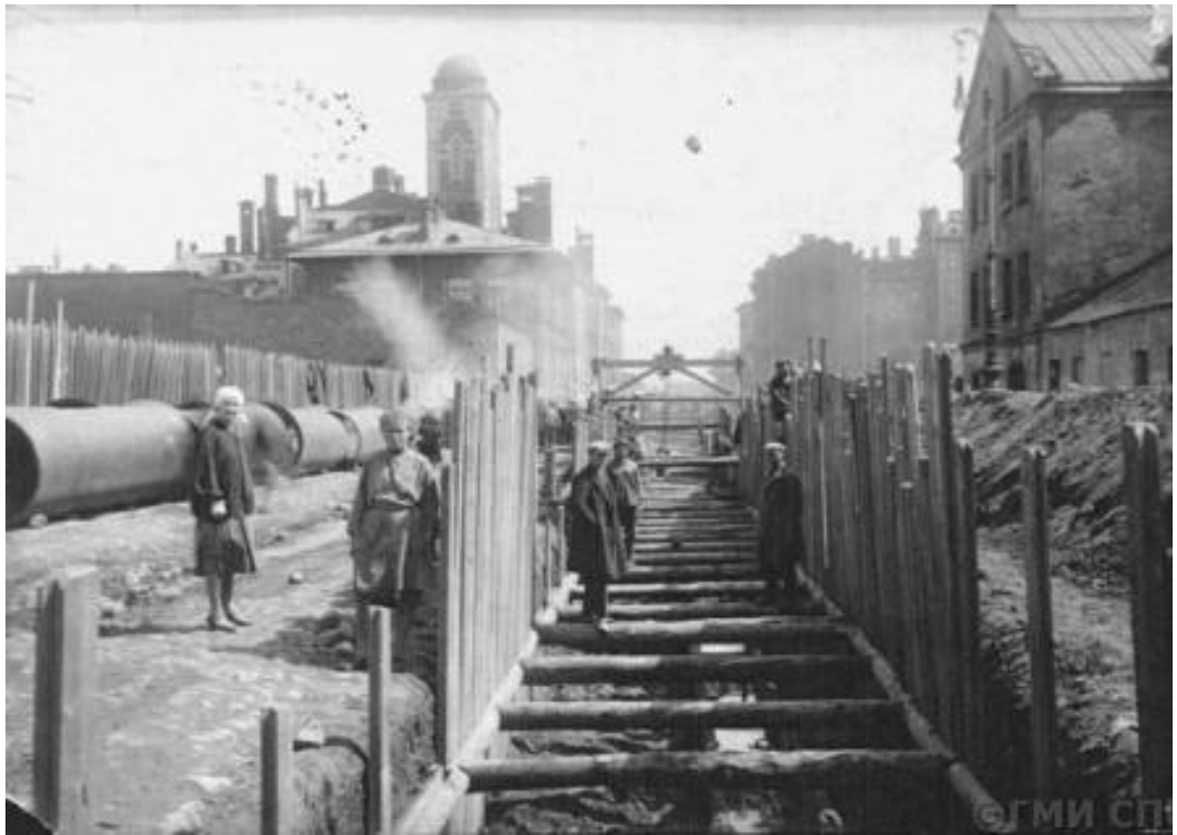
Илл. 47. Прилуцкая улица. Прокладка канализационных труб. Перспективный вид от Лиговского проспекта в сторону Тамбовской улицы; слева видна обсерватория Лиговского народного дома (Народный дом С. В. Паниной). 1931 г. // https://goskatalog.ru/portal/#/collections?id=34746408 (Номер в Госкаталоге: 34545880. Номер по КП (ГИК): ГМИ СПб 232949. Инвентарный номер: ГМИ СПб Инв.№-П-А-2919 ф)
