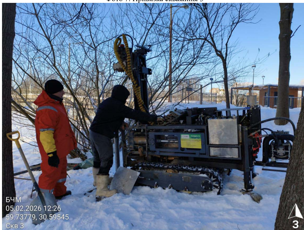
Фото 8. Бурение скважины 3
