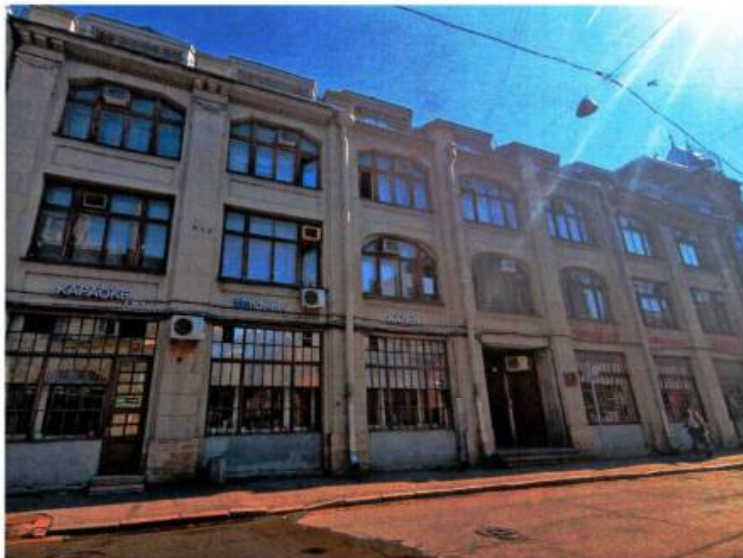
1. Лицевой фасад объекта культурного наследия.
