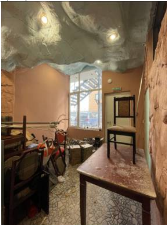
Фото № 61. Объект ресторан «Куракина Дача», расположенный по адресу г. Санкт-Петербург, ул. Леснозаводская, д. 1, литера А.
