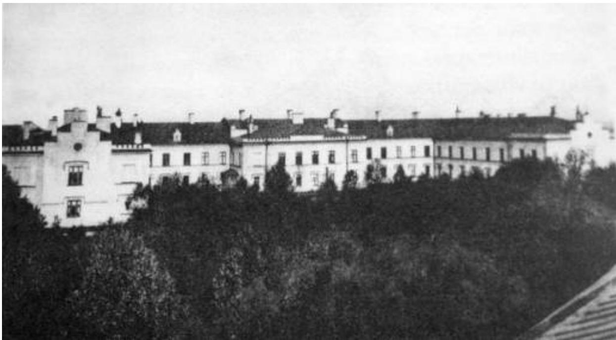
8.Главное каменное здание. Фото 1886 г.
