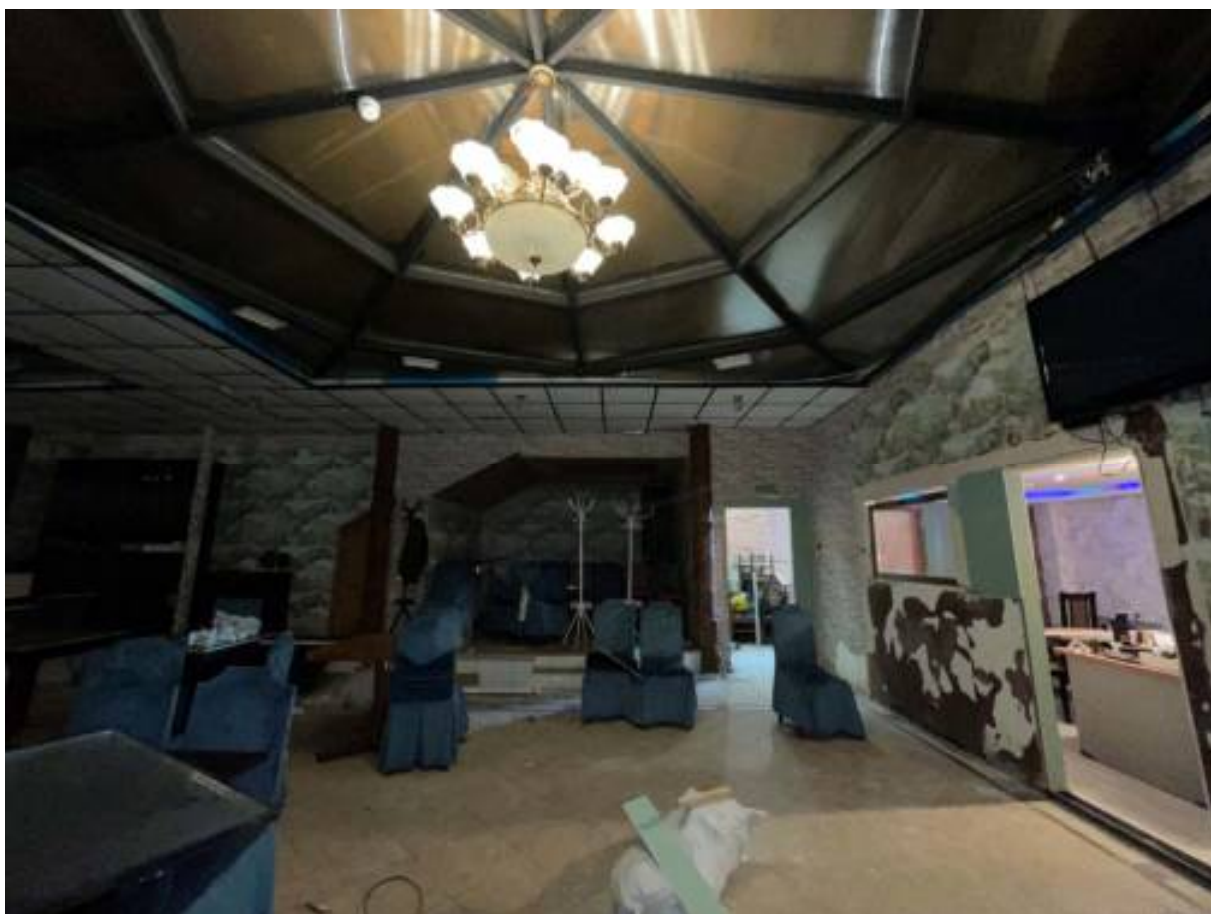
Фото № 54. Объект ресторан «Куракина Дача», расположенный по адресу г. Санкт-Петербург, ул. Леснозаводская, д. 1, литера А.
