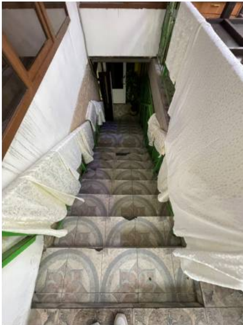
Фото № 74. Объект ресторан «Куракина Дача», расположенный по адресу г. Санкт-Петербург, ул. Леснозаводская, д. 1, литера А.
