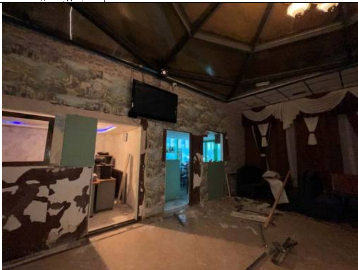
Фото № 55. Объект ресторан «Куракина Дача», расположенный по адресу г. Санкт-Петербург, ул. Леснозаводская, д. 1, литера А.
