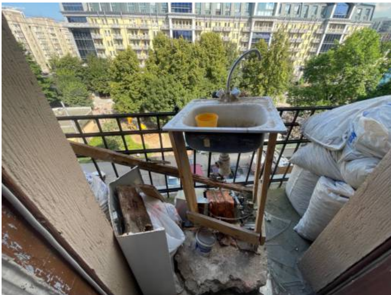
12.Общий вид балкона.
