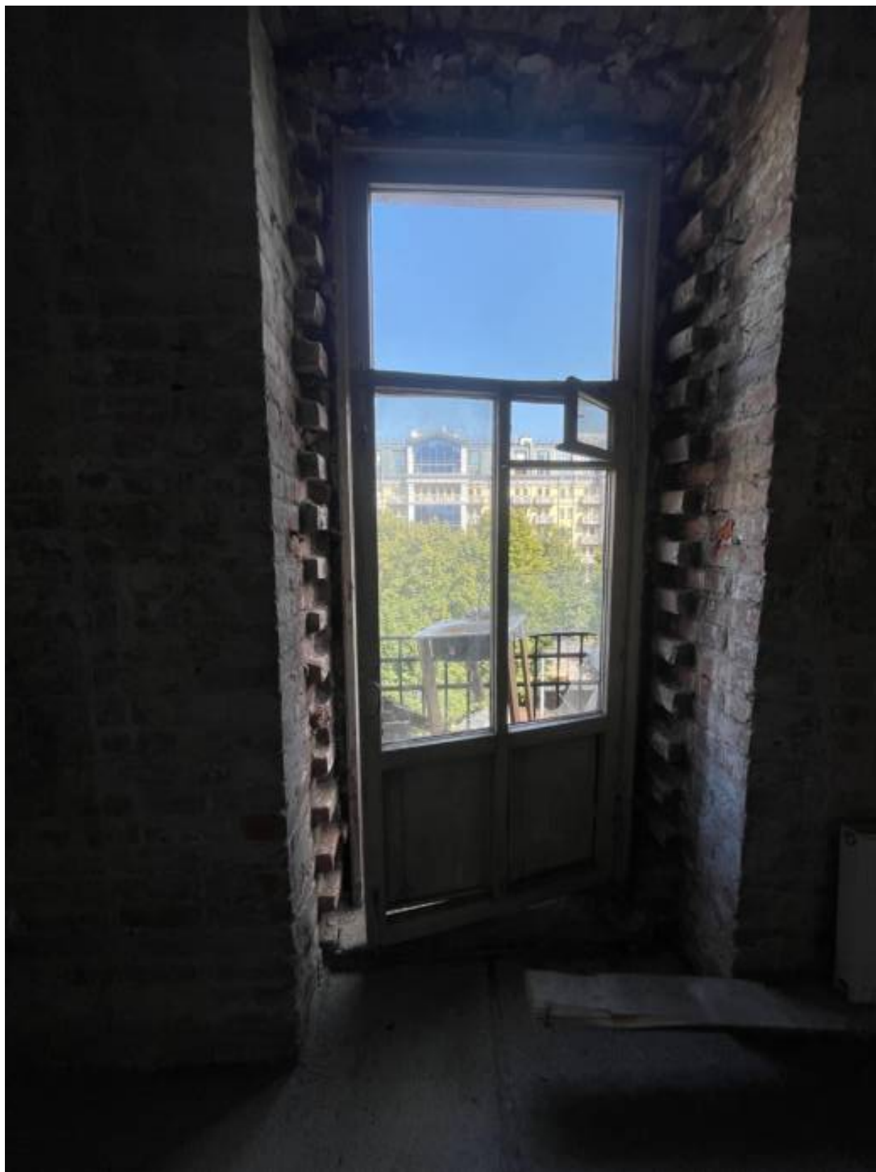
11.Балконное дверное заполнение.
