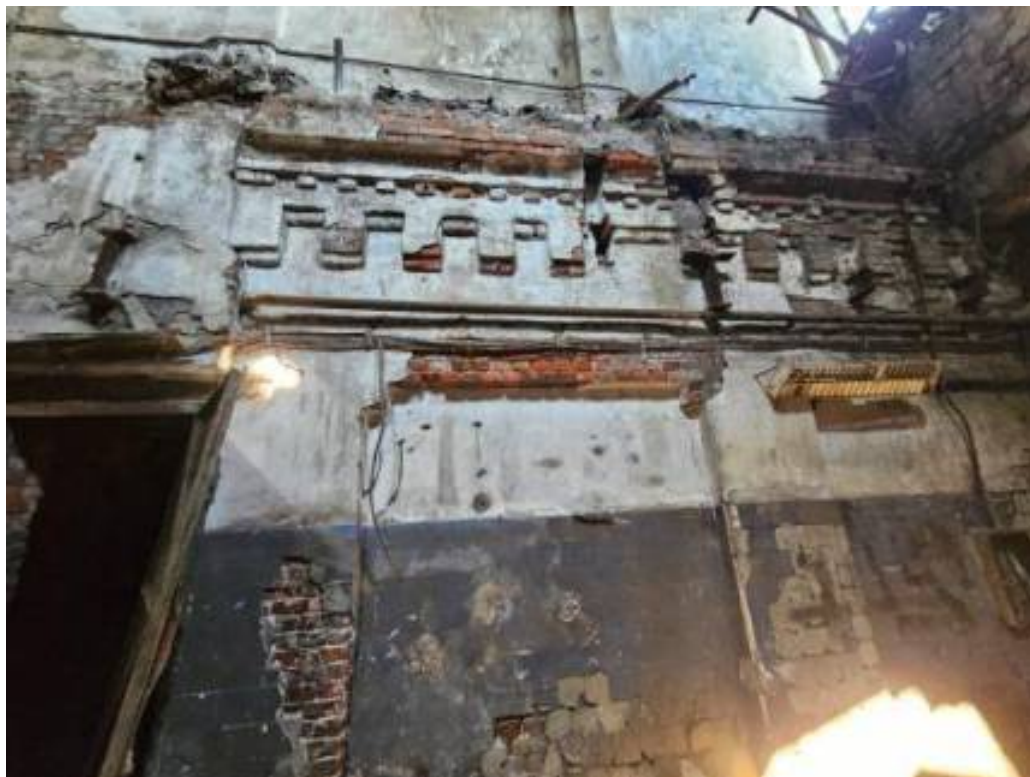
32. Фрагмент основания дымовой трубы.
