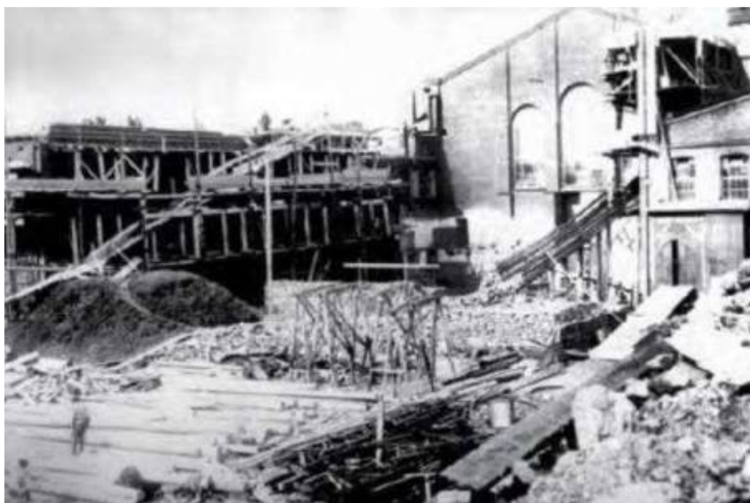
Илл. 12. Строительство электростанции. 1897–1898 гг. https://pastvu.com/
