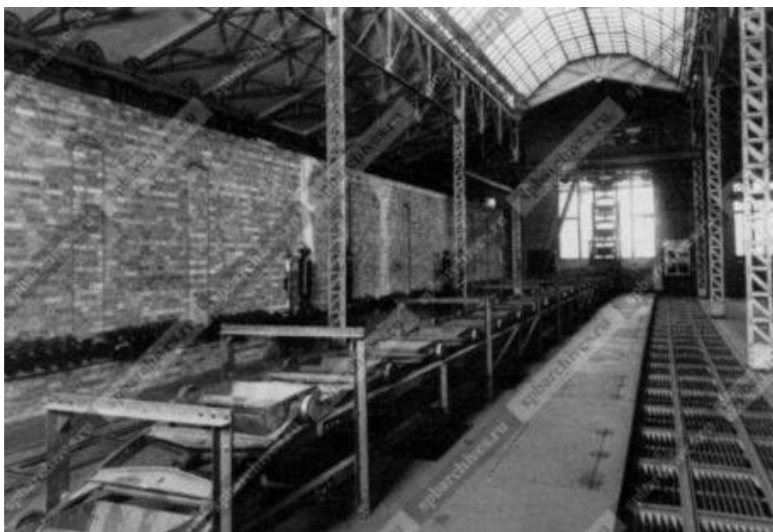
Илл. 18. Механическая подача угля на электростанции «Общества электрического освещения 1886 г.». 1911 г. ЦГА КФФД СПб. Шифр: Е 8658
