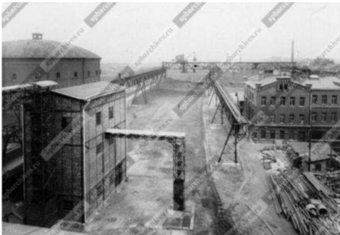
Илл. 19. Двор электростанции «Общества электрического освещения 1886 г.». 1911 г. ЦГА КФФД СПб. Шифр: Е 8662
